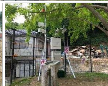
土石流警報装置設置状況
