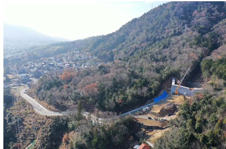
砂防堰堤施工状況①
