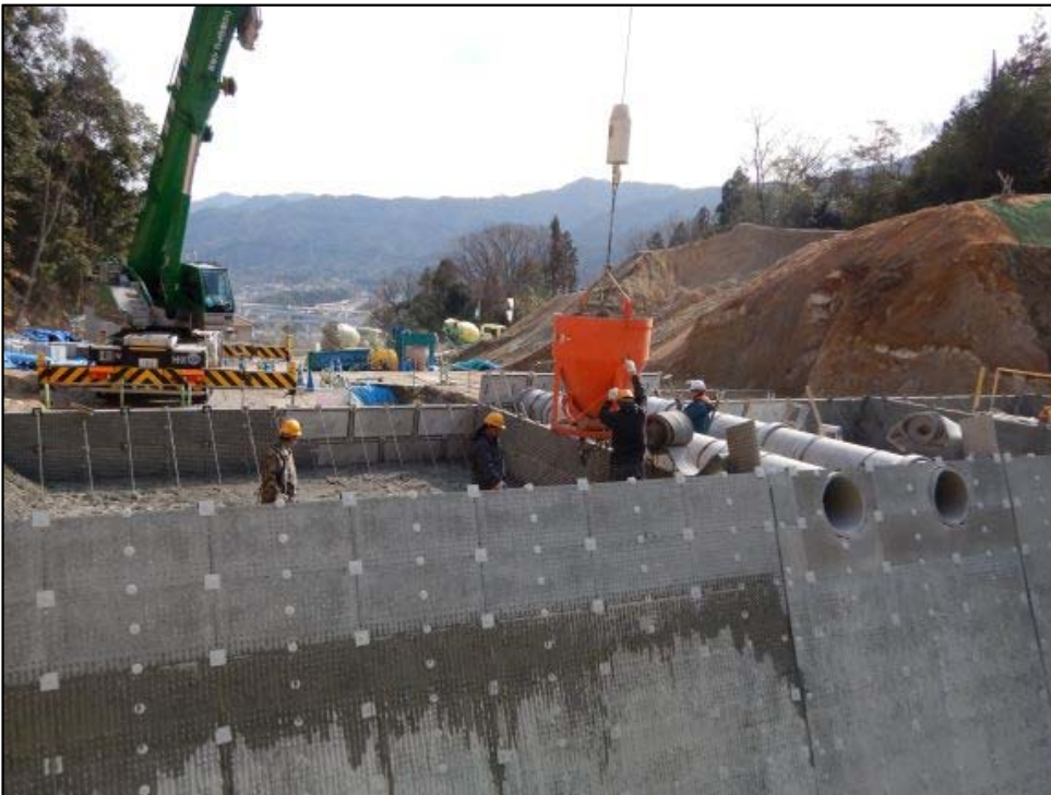
コンクリート打設状況①
