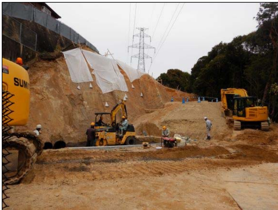
施工状況①
