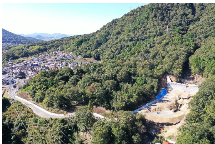
砂防堰堤施工状況①
