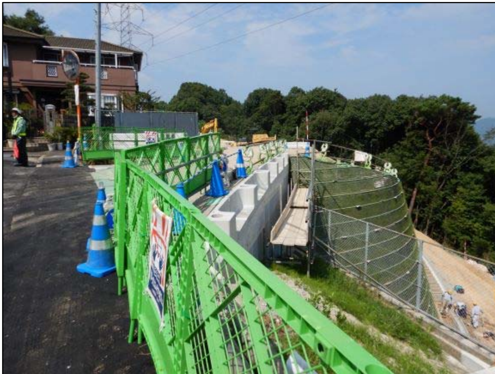
施工状況①
