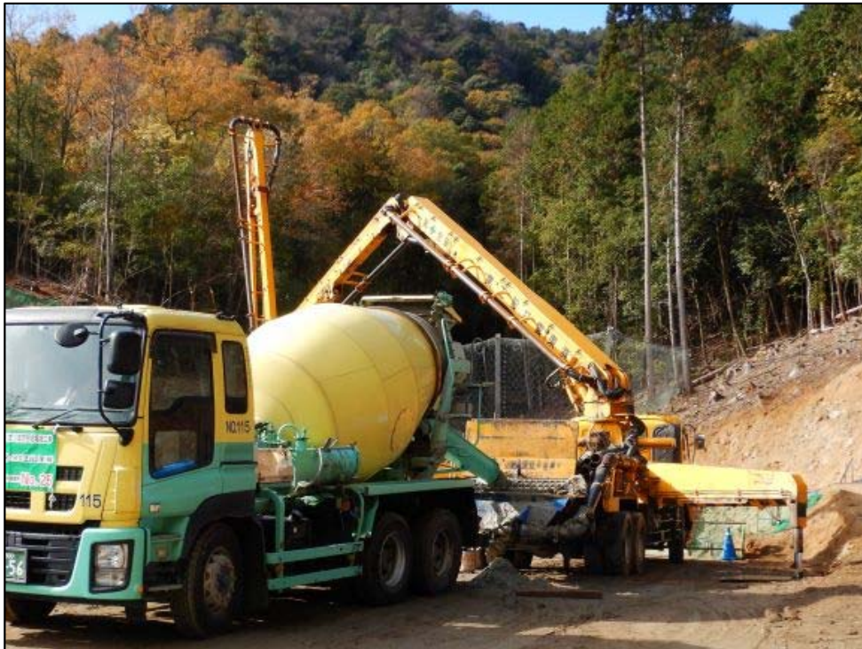
コンクリート打設状況①
