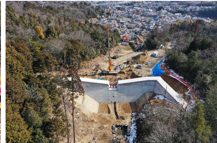
砂防堰堤施工状況③
