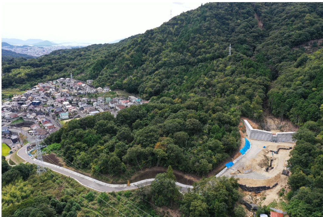
砂防堰堤施工状況①
