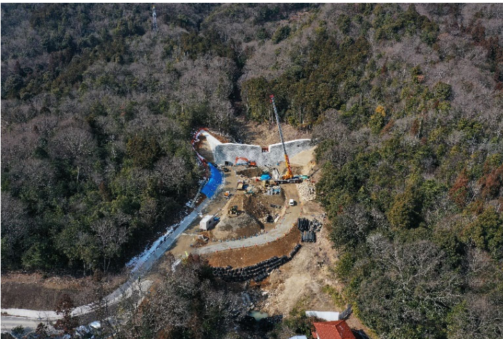
砂防堰堤施工状況①
