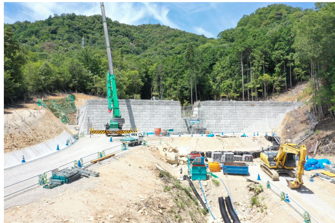
砂防堰堤施工状況①
