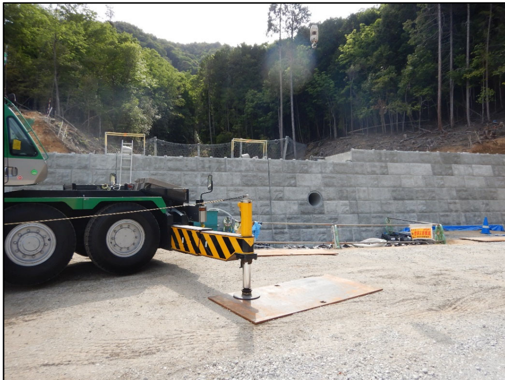
コンクリート打設状況①
