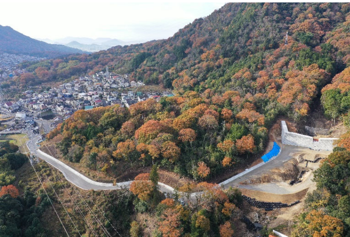
砂防堰堤施工状況①
