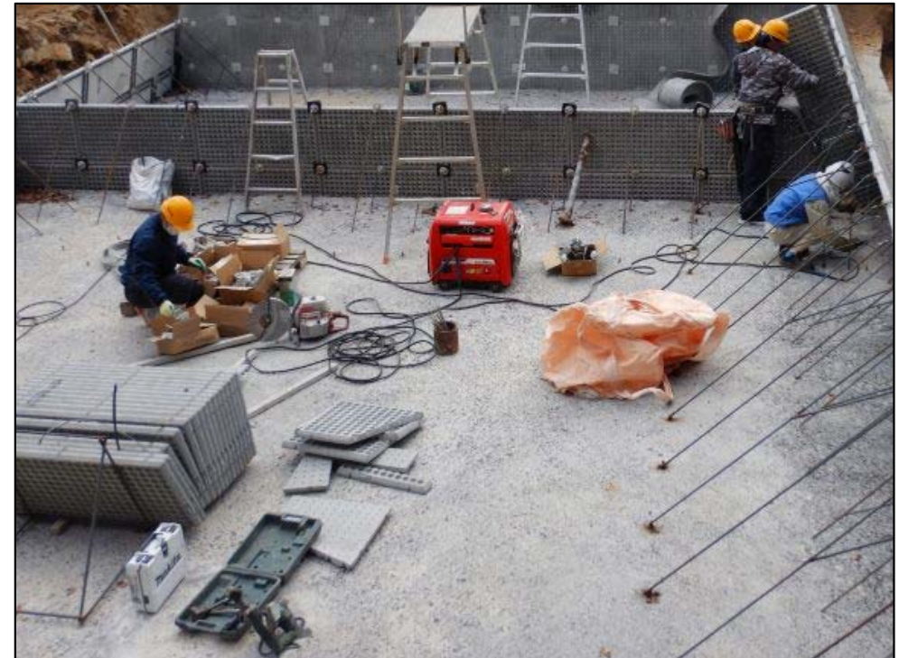
砂防堰堤施工状況
