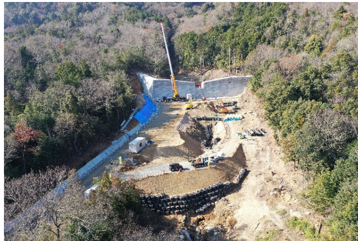
砂防堰堤施工状況②
