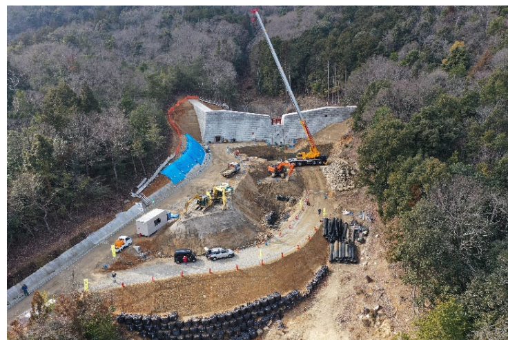
砂防堰堤施工状況①
