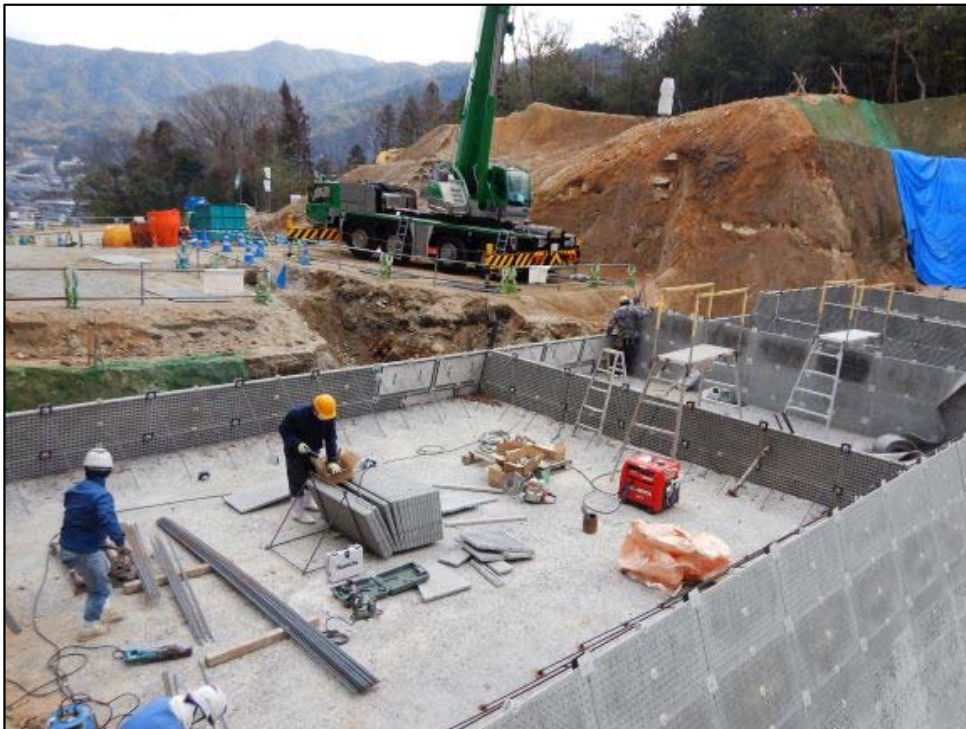
砂防堰堤施工状況
