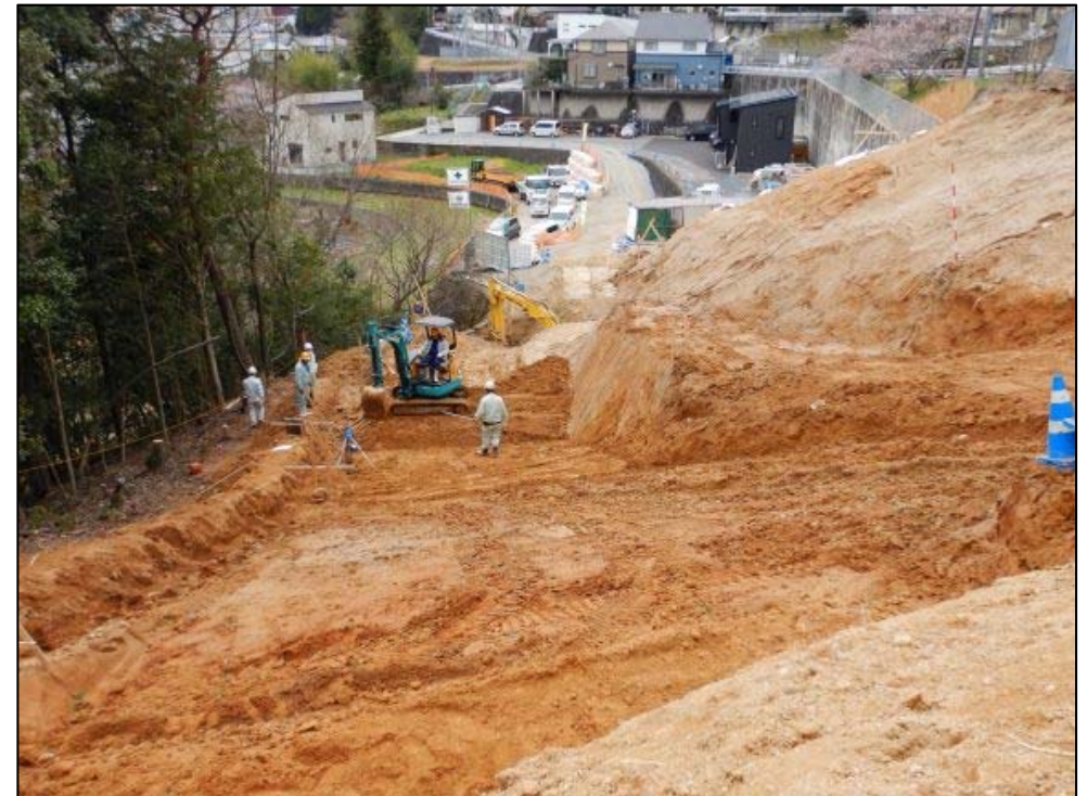
施工状況②
