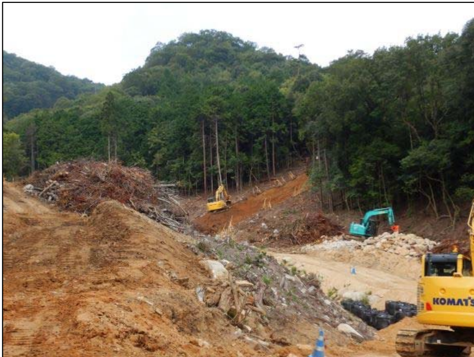
工事用道路施工状況 (堰堤側)
