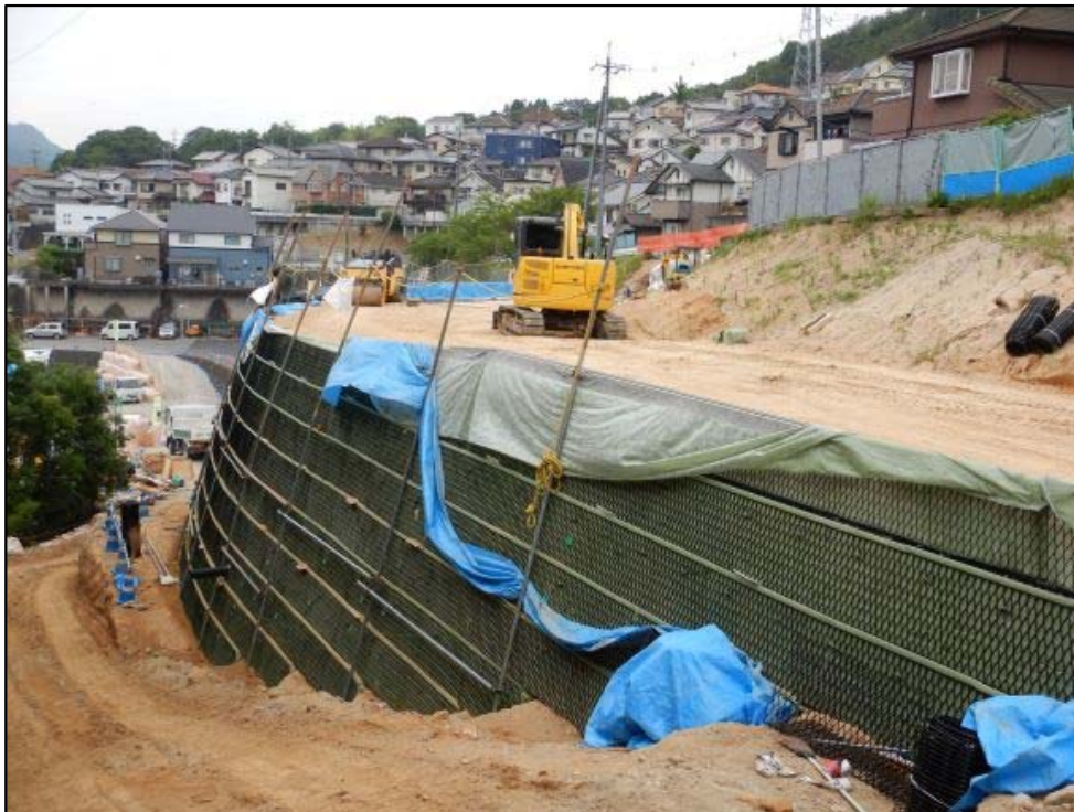
施工状況①
