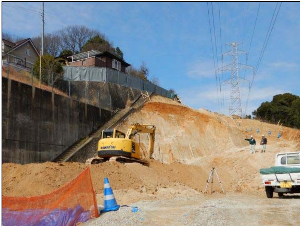
施工状況①
