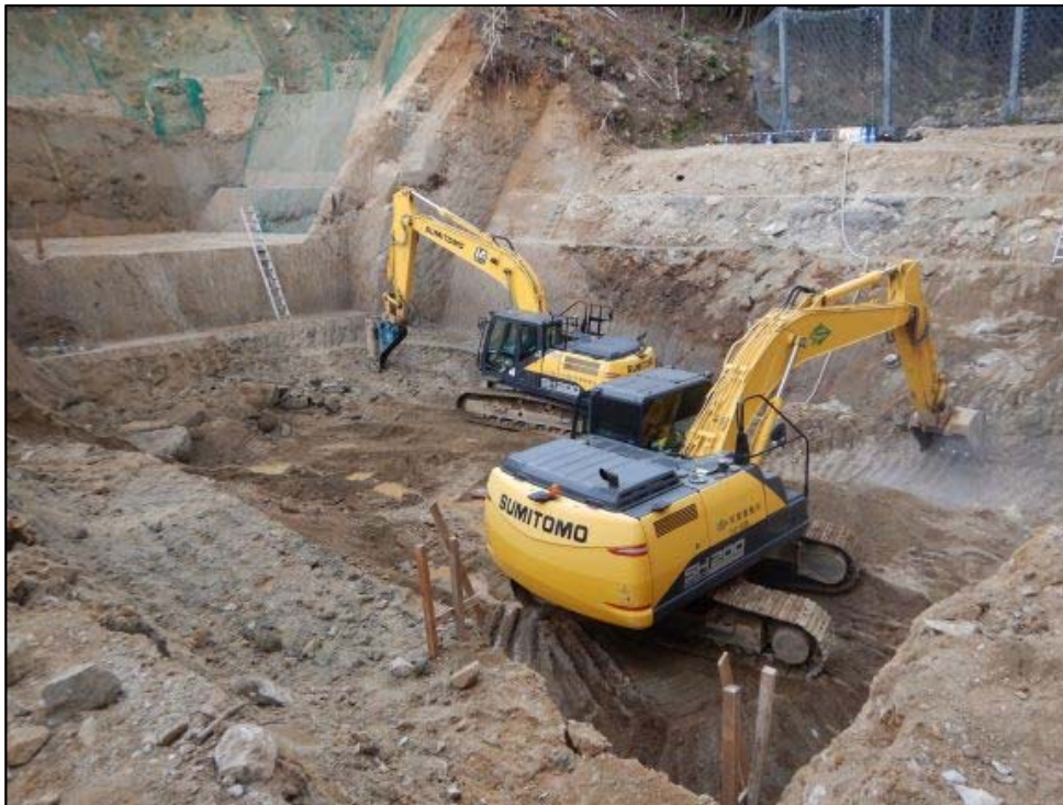
掘削作業状況
