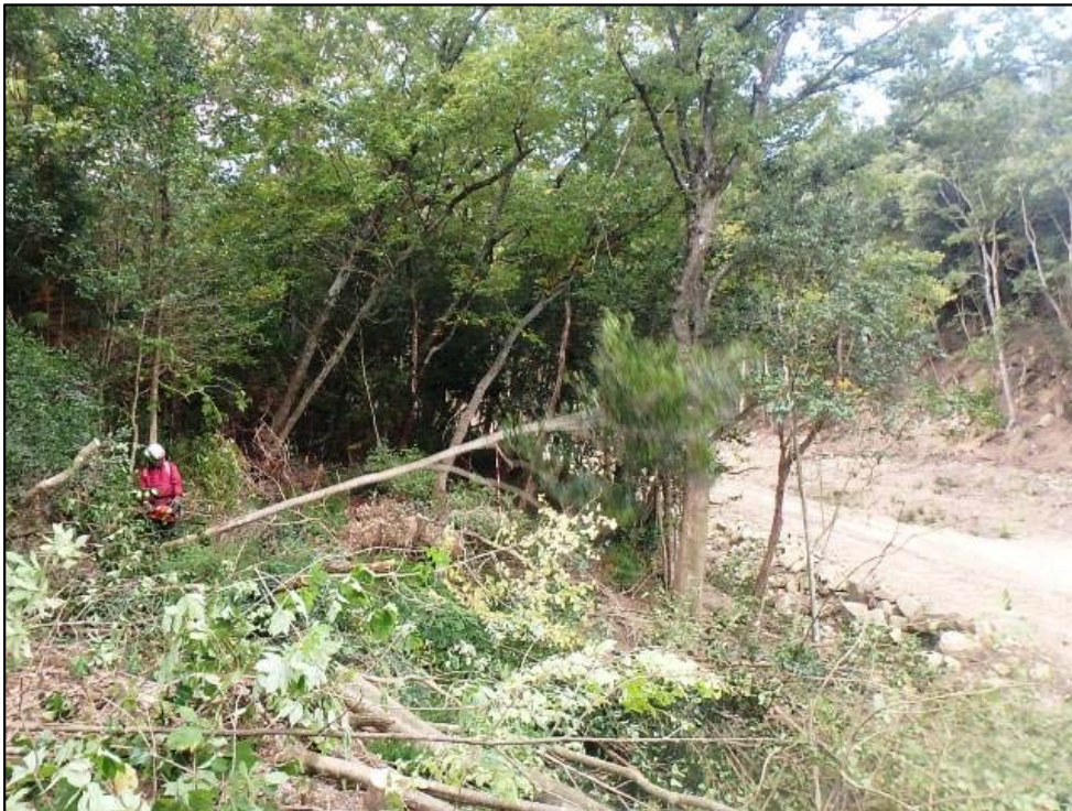
伐採作業状況
