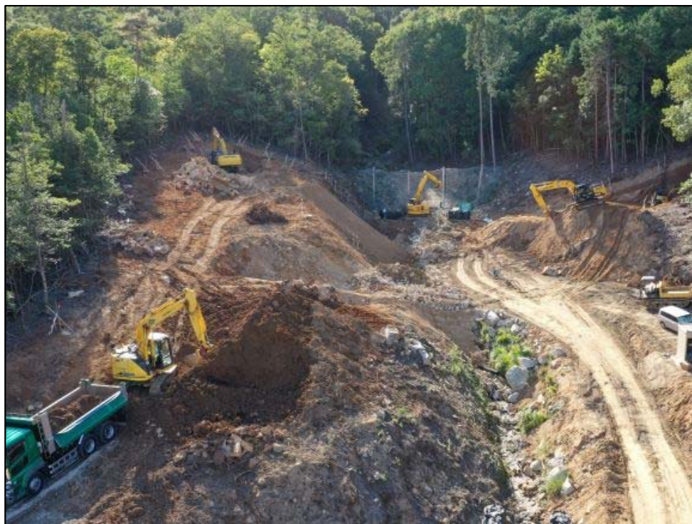
掘削作業状況
