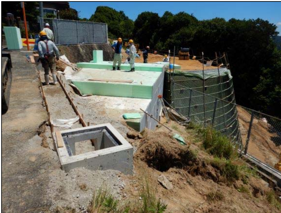
施工状況①
