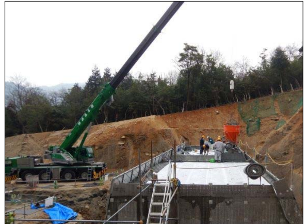
コンクリート打設状況②
