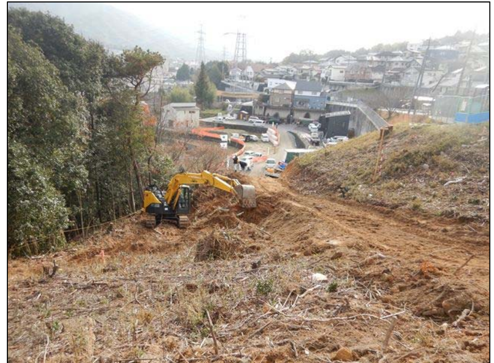
工事用道路施工状況
