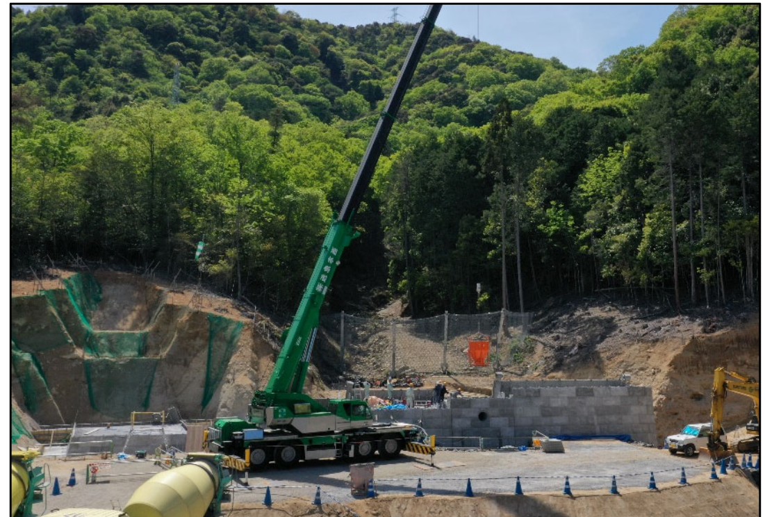
コンクリート打設状況②
