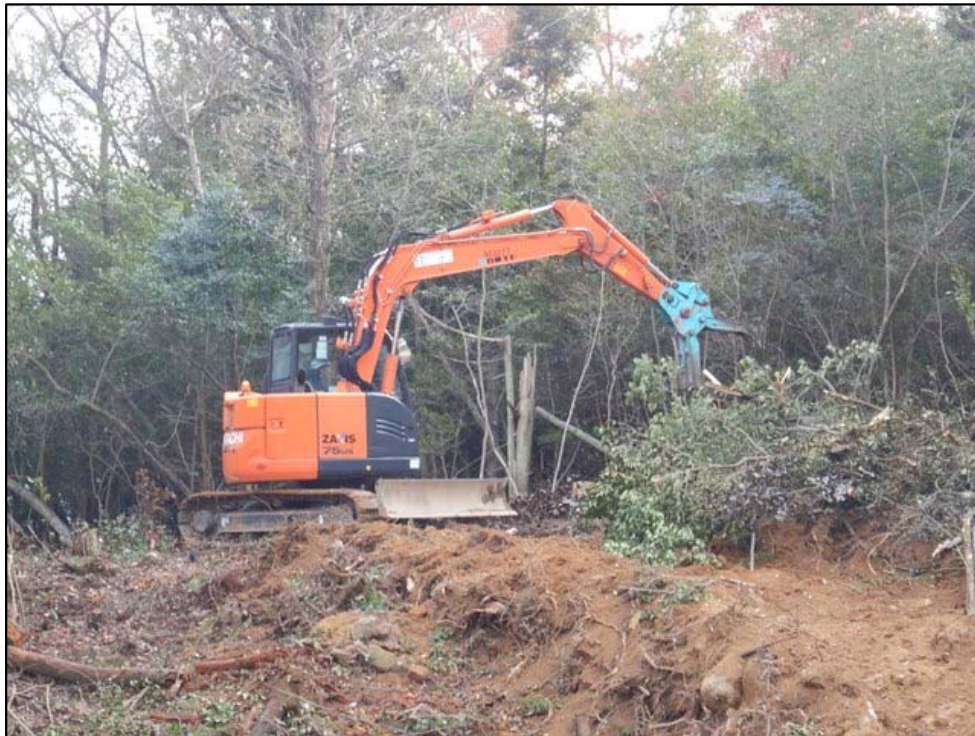
伐採木集積作業 (堰堤箇所)
