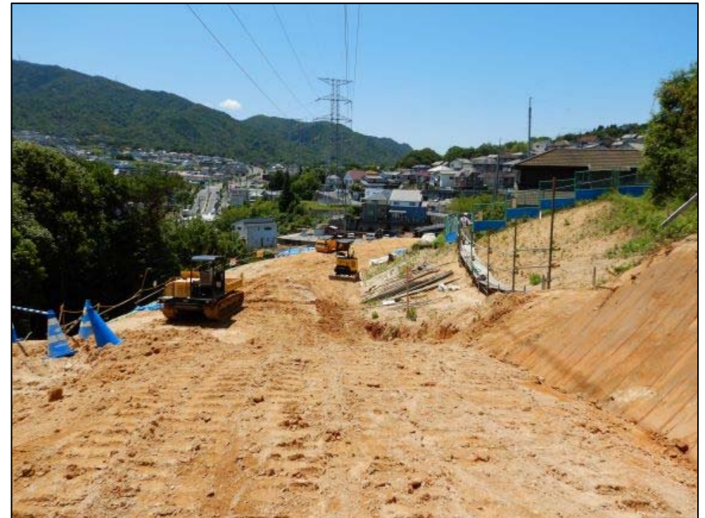
施工状況②
