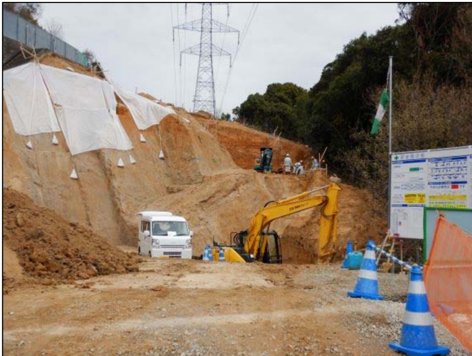
施工状況①
