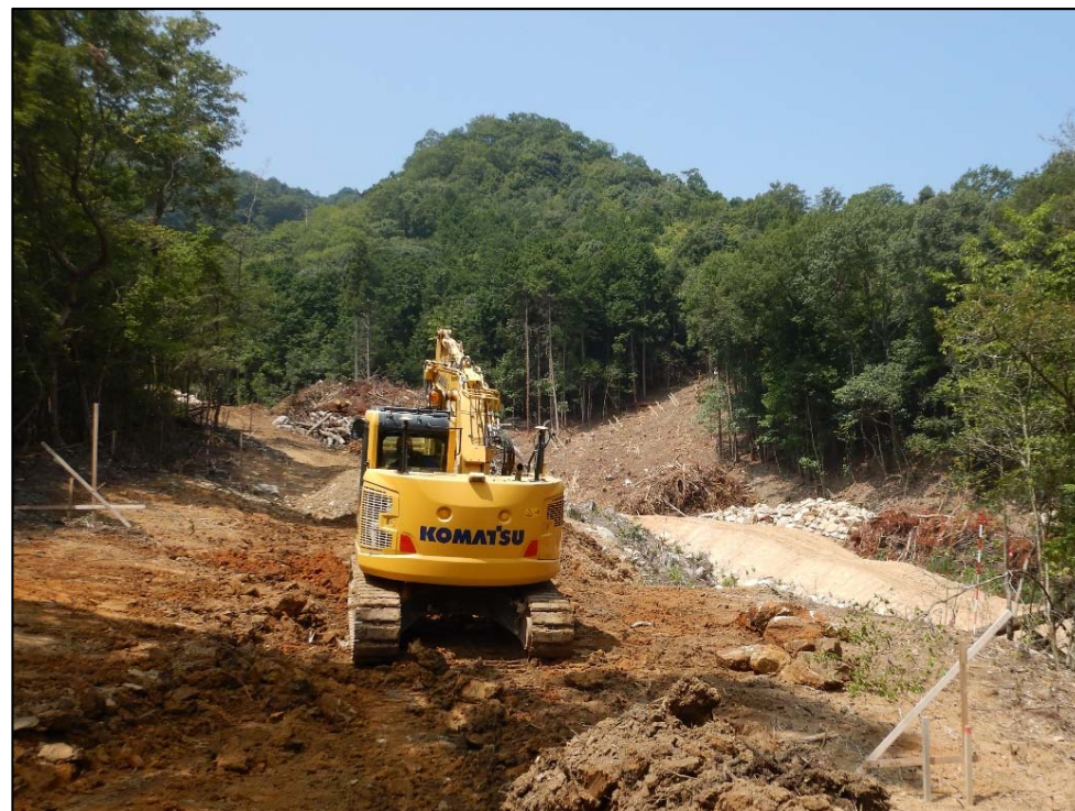
施工状況② (堰堤側)
