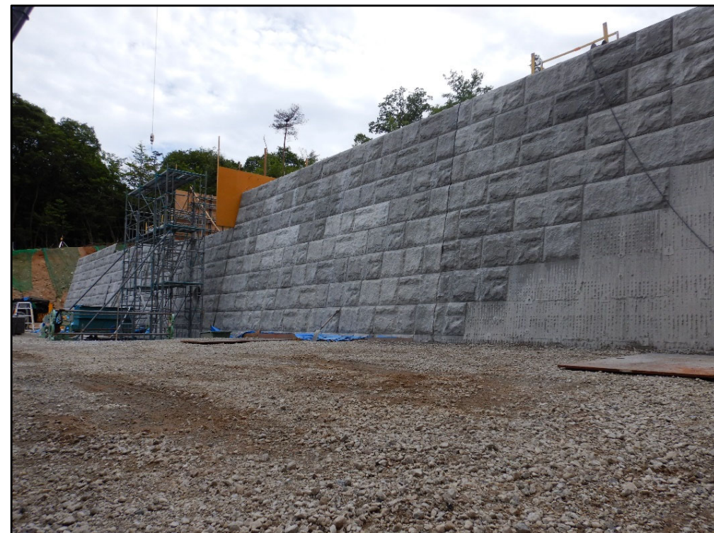
砂防堰堤施工状況②
