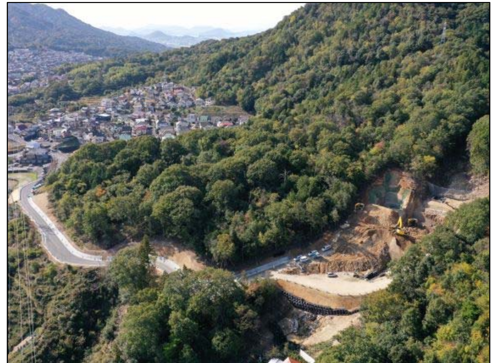
工事用道路施工状況
