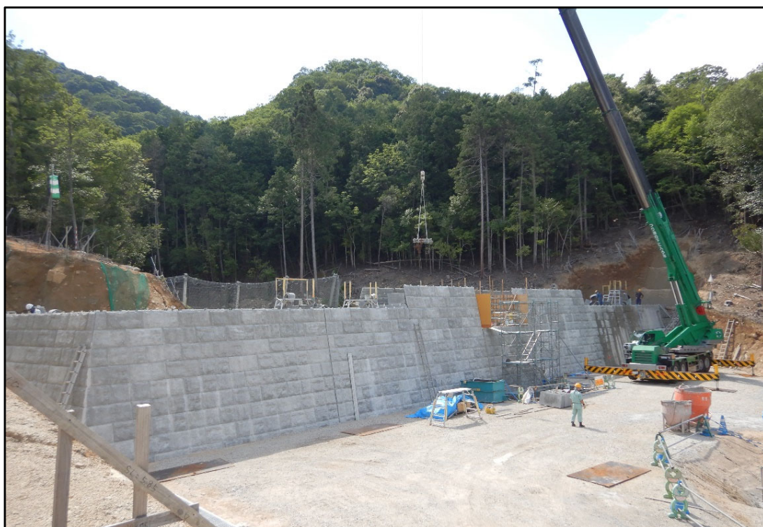
砂防堰堤施工状況①
