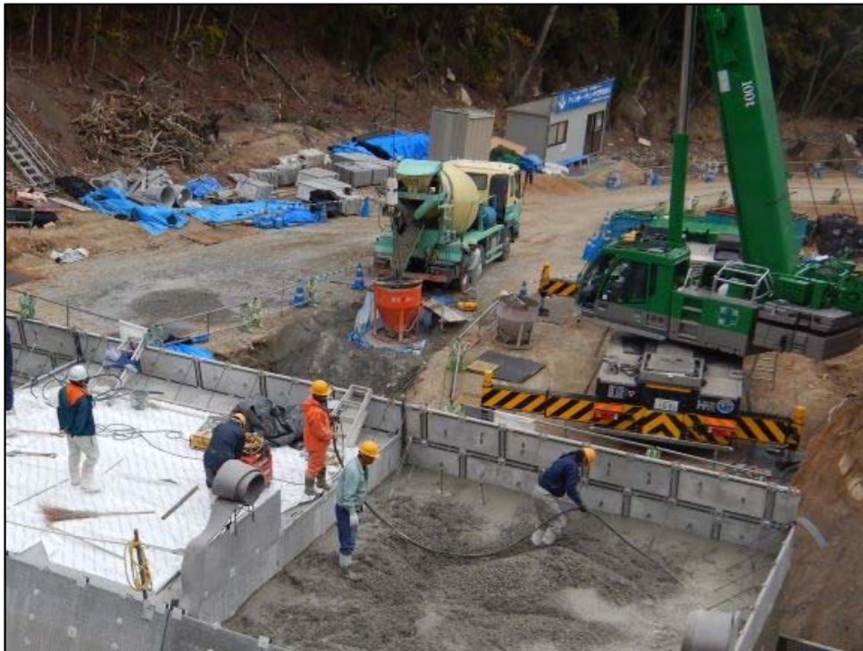
コンクリート打設状況①
