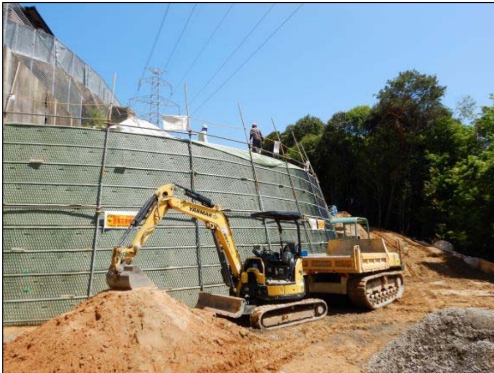
施工状況①
