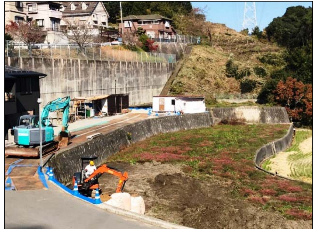
進入路施工状況
