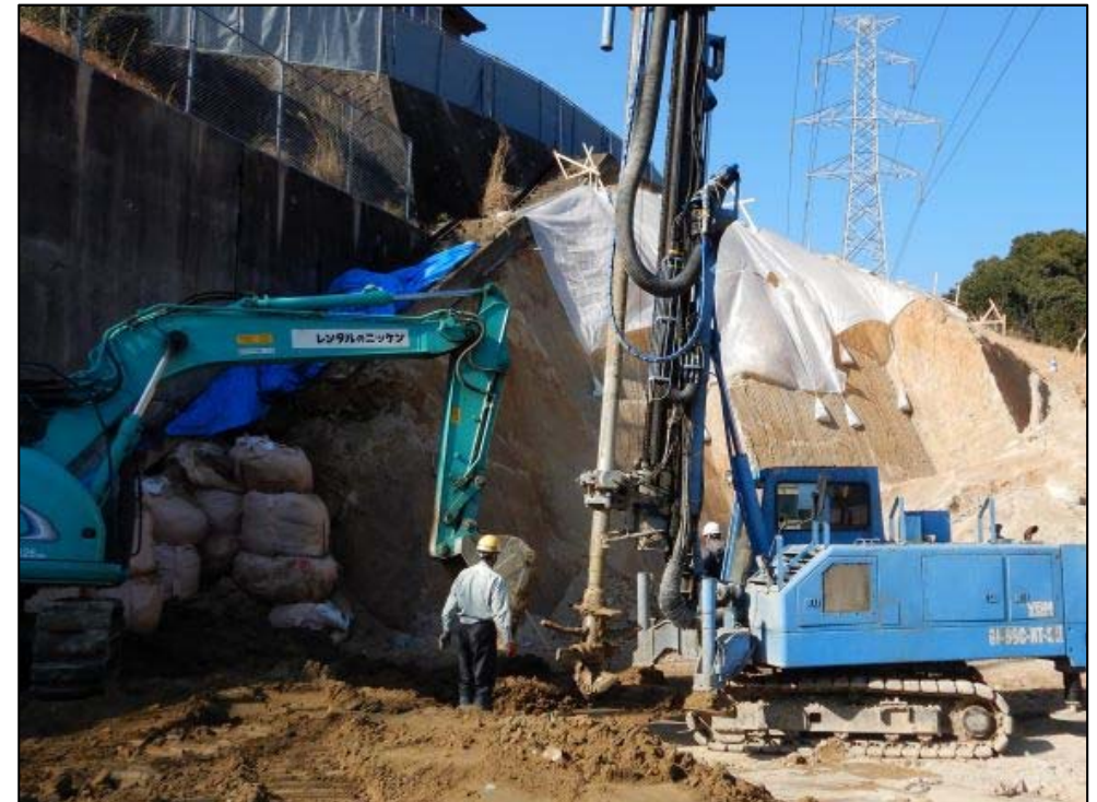
地盤改良施工状況②
