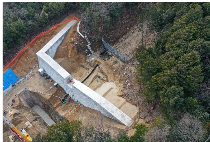
砂防堰堤施工状況②
