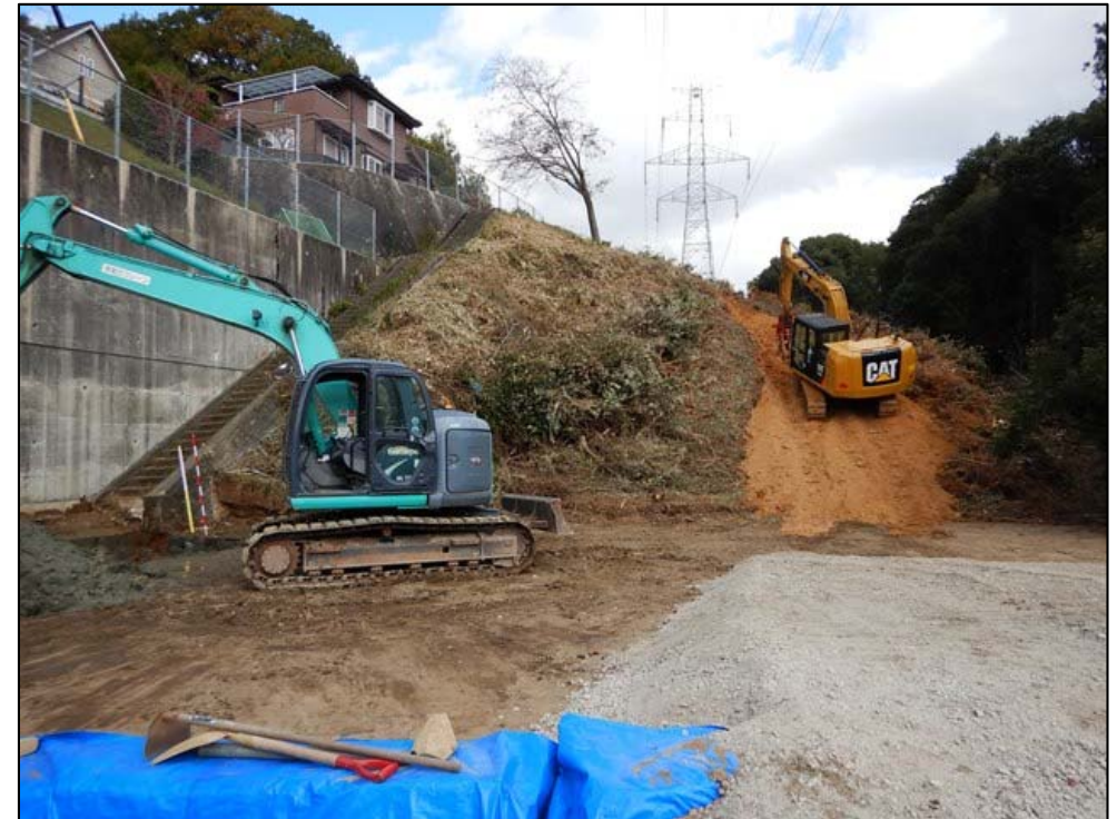
進入路施工状況
