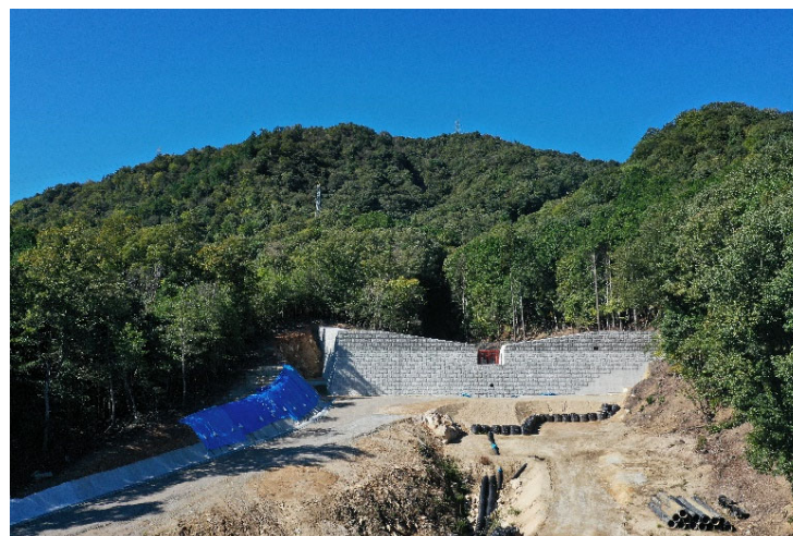
砂防堰堤施工状況②
