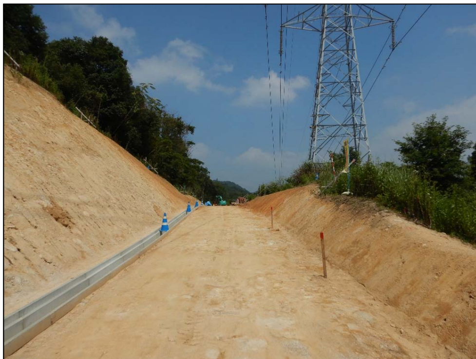
施工状況①
