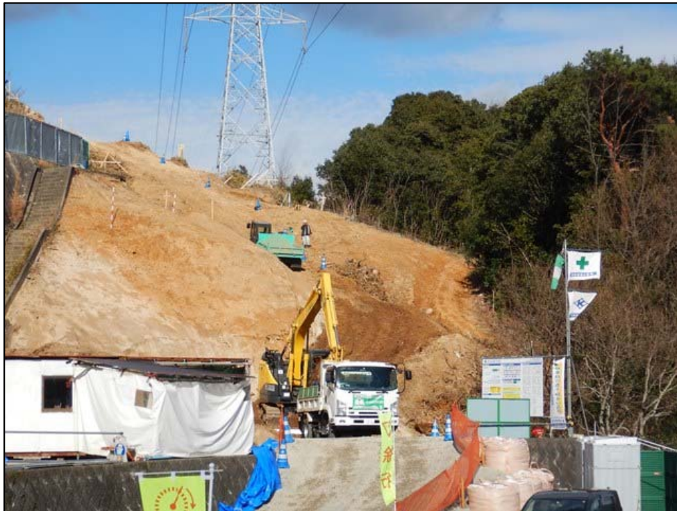
施工状況①
