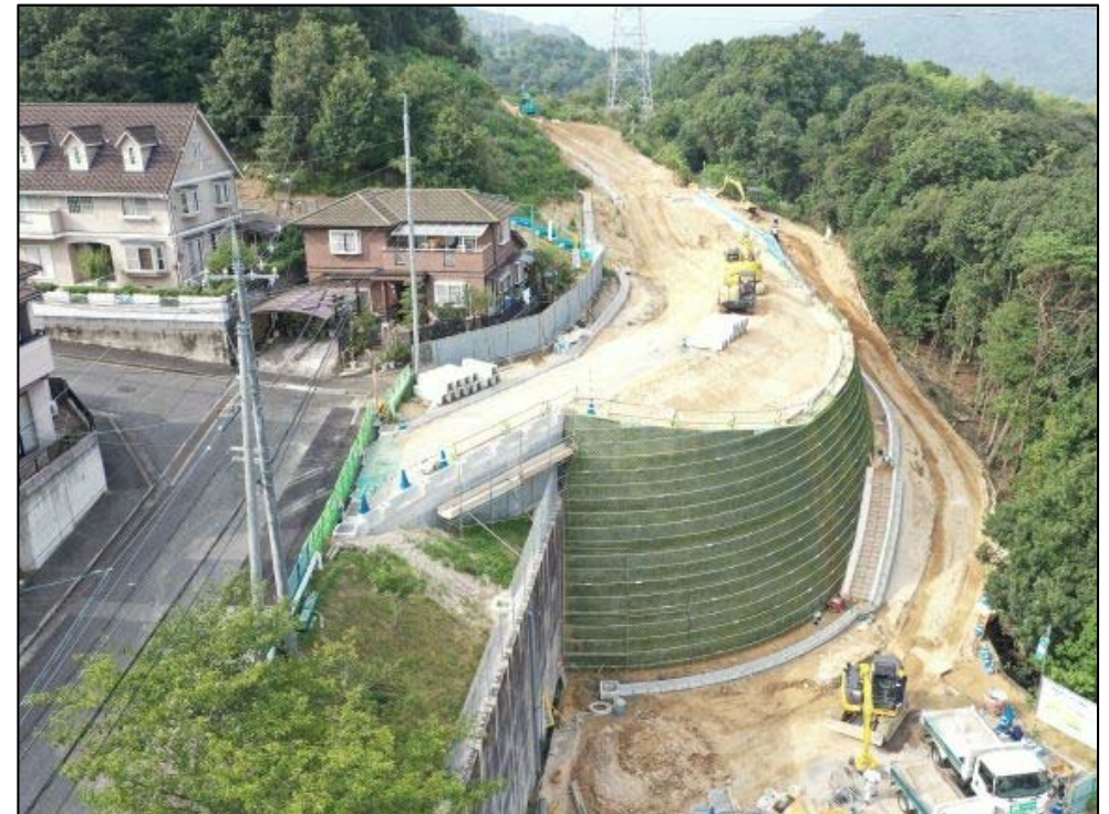
施工状況②
