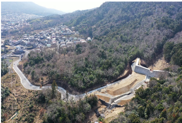
砂防堰堤施工状況①
