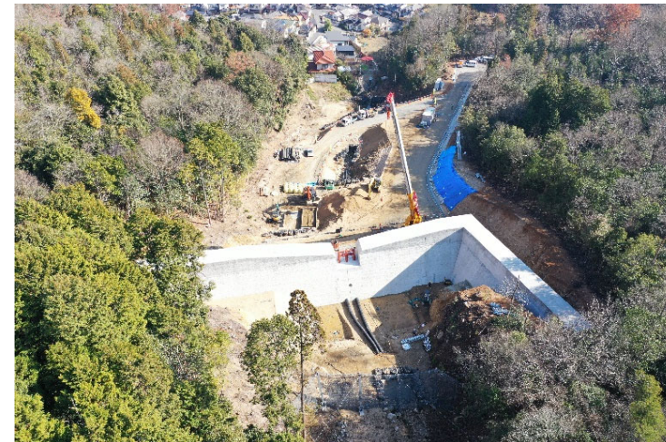
砂防堰堤施工状況③
