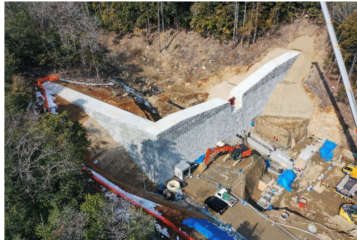
砂防堰堤施工状況②
