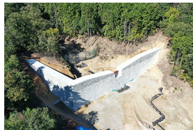
砂防堰堤施工状況③
