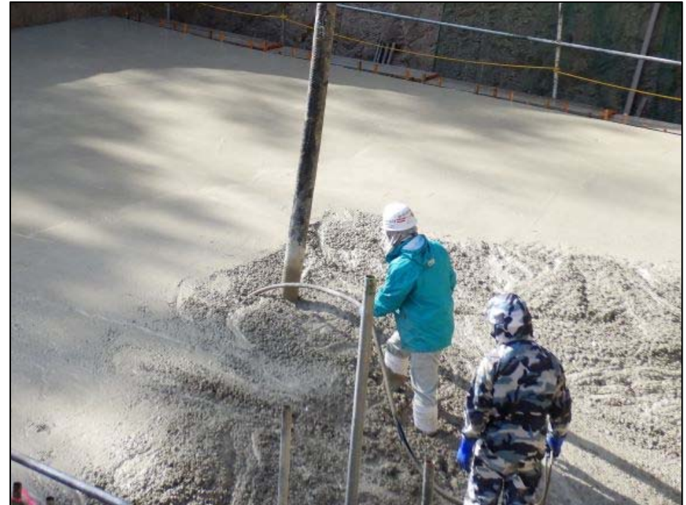
コンクリート打設状況②
