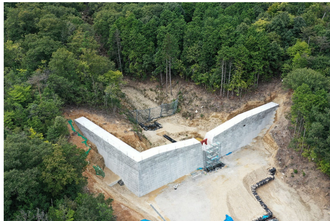
砂防堰堤施工状況②
