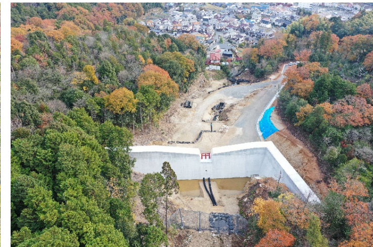
砂防堰堤施工状況③
