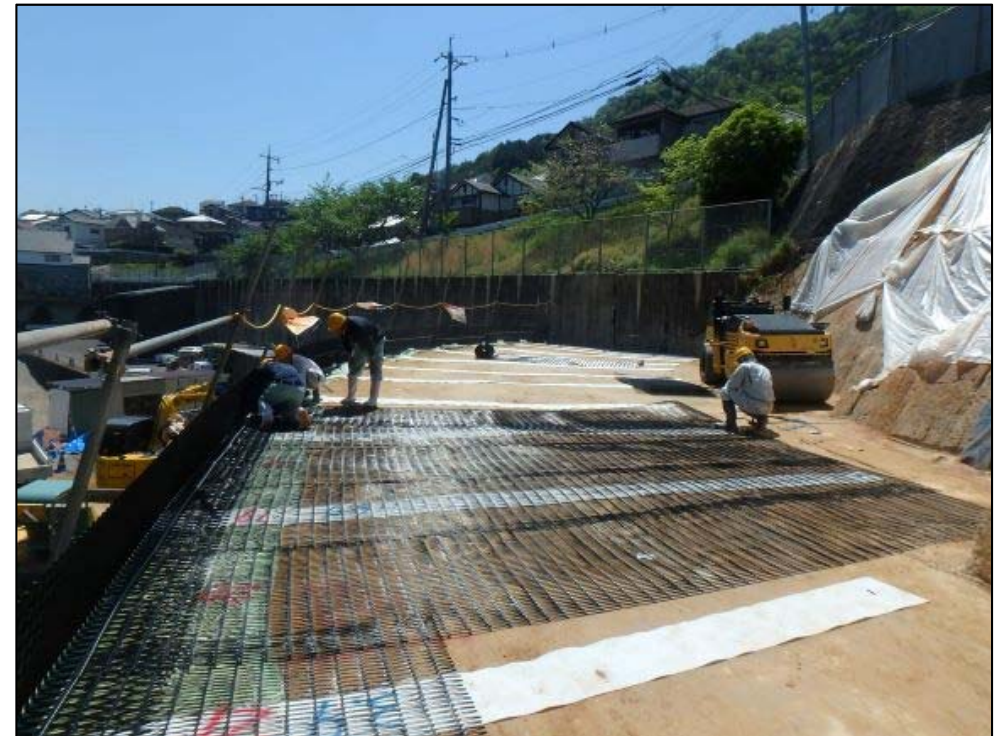
施工状況②
