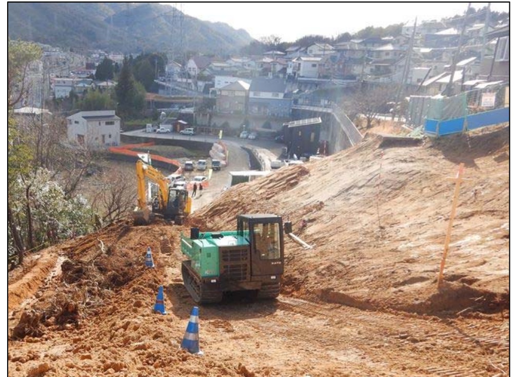
施工状況②
