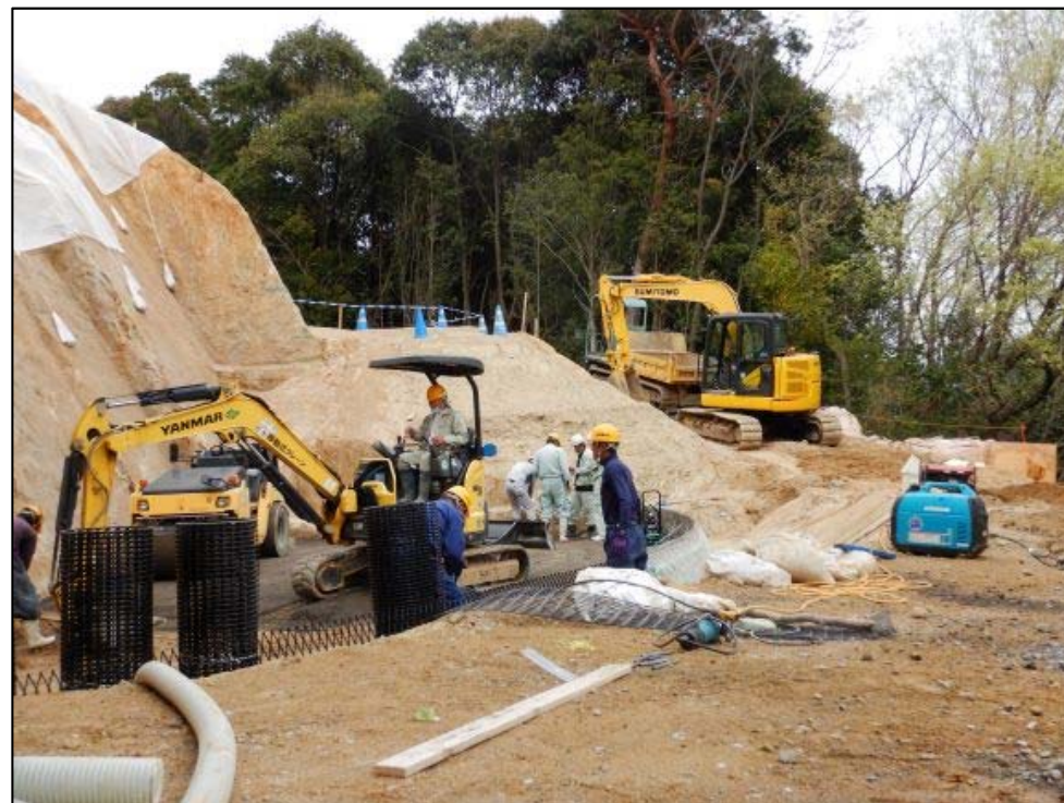
施工状況②
