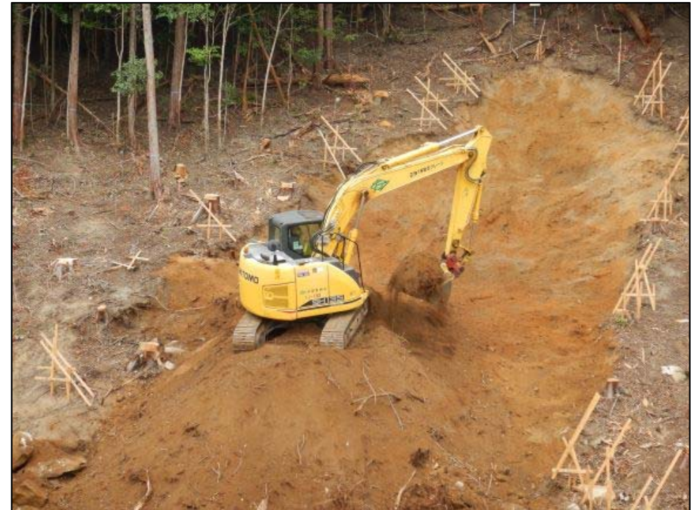
掘削作業状況
