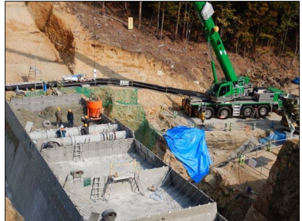
コンクリート打設状況②
