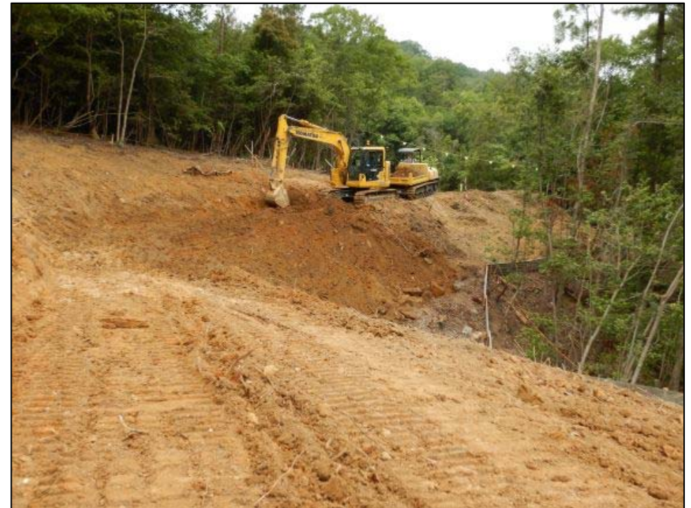
施工状況②
