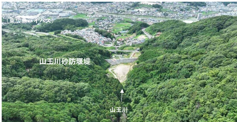
【施工状況（上空より）】
