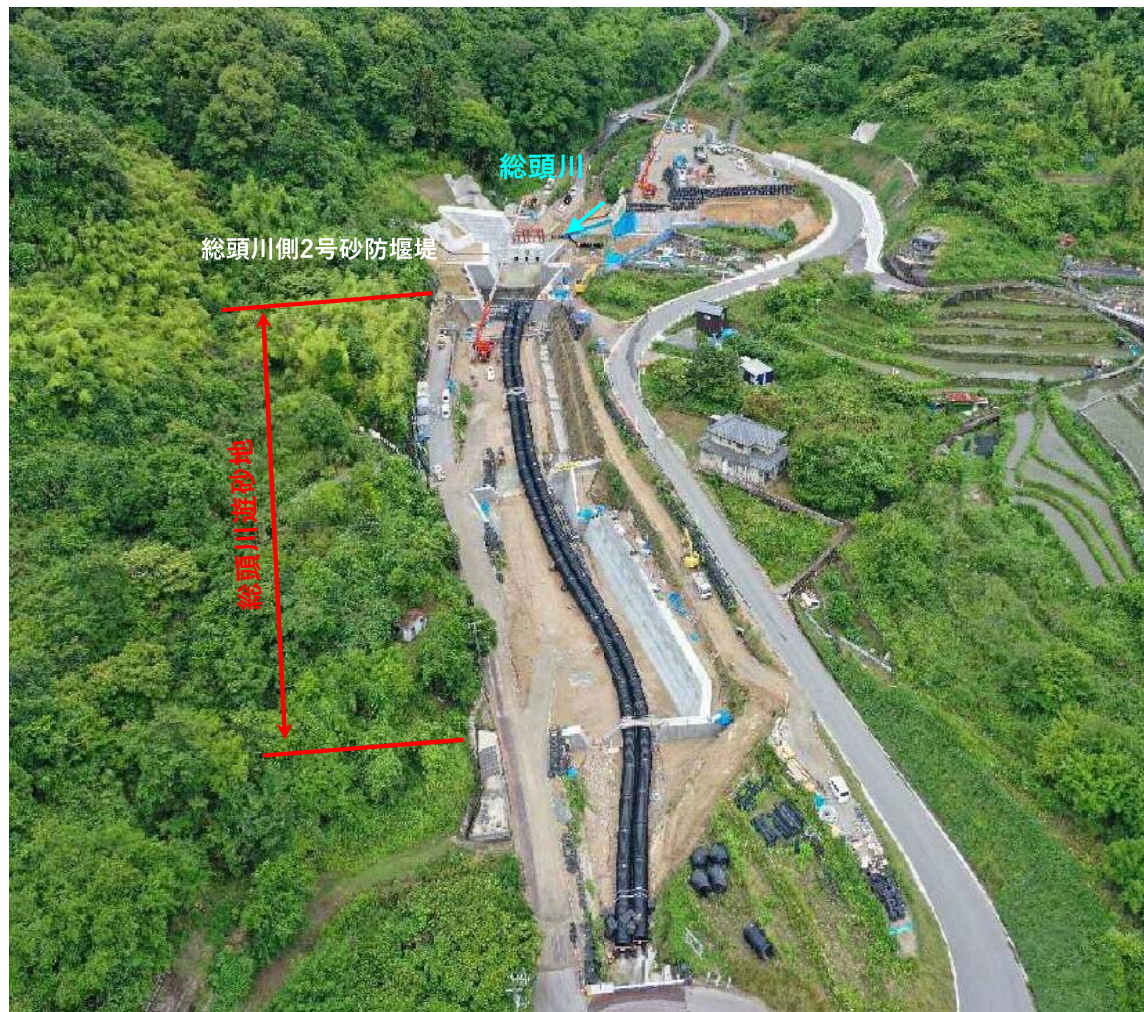
【施工状況(下流から上流を望む)】
