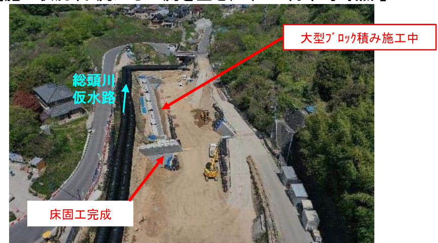
【大型ブロック積施工状況（上流から下流を望む）】
