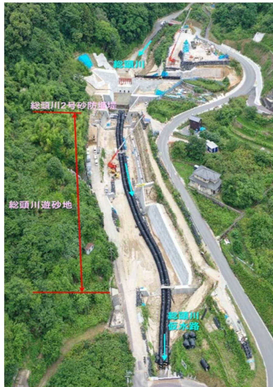
【施工状況(下流から上流を望む)】
