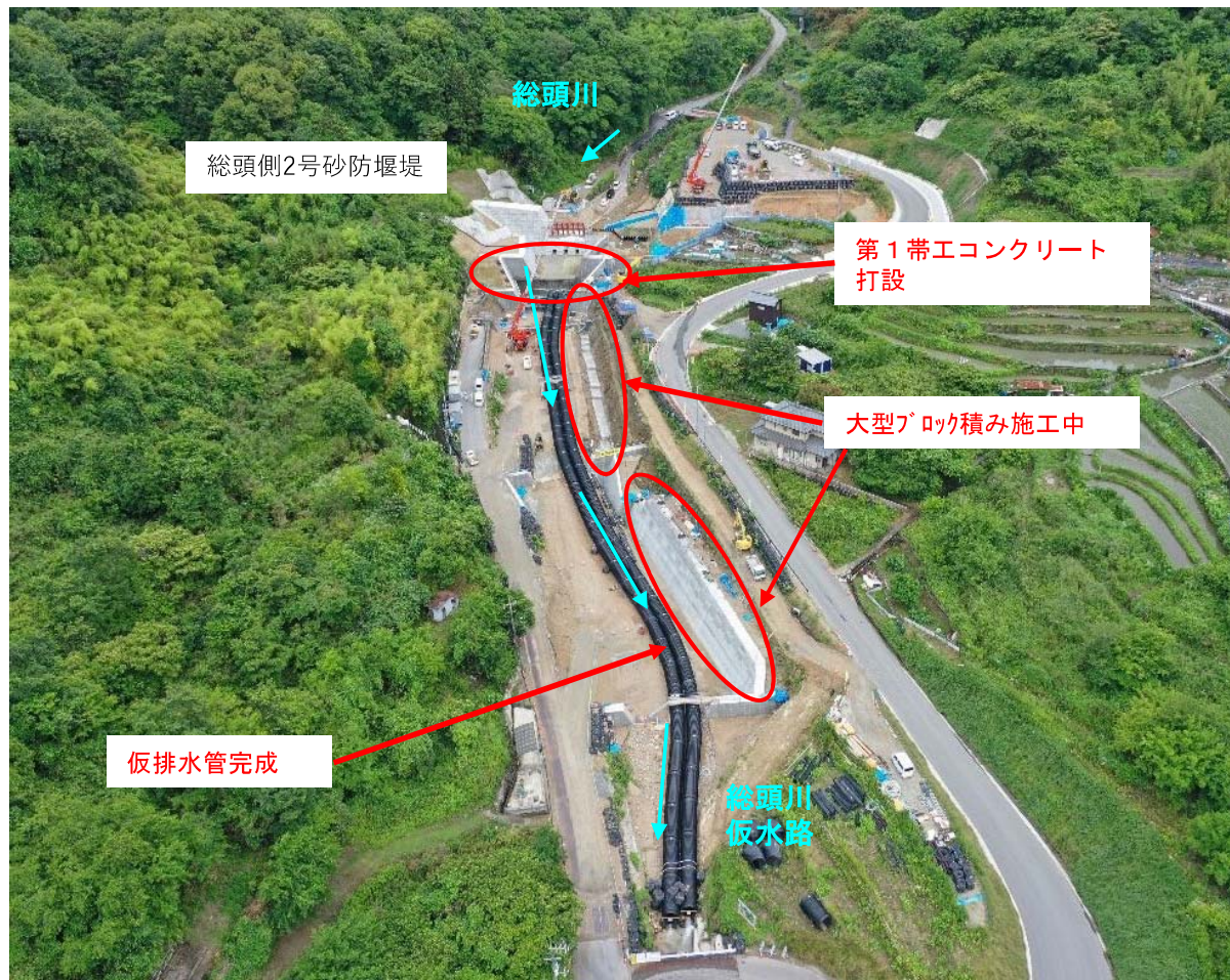
【施工状況(下流から上流を望む) (R6. 6月末時点)】
