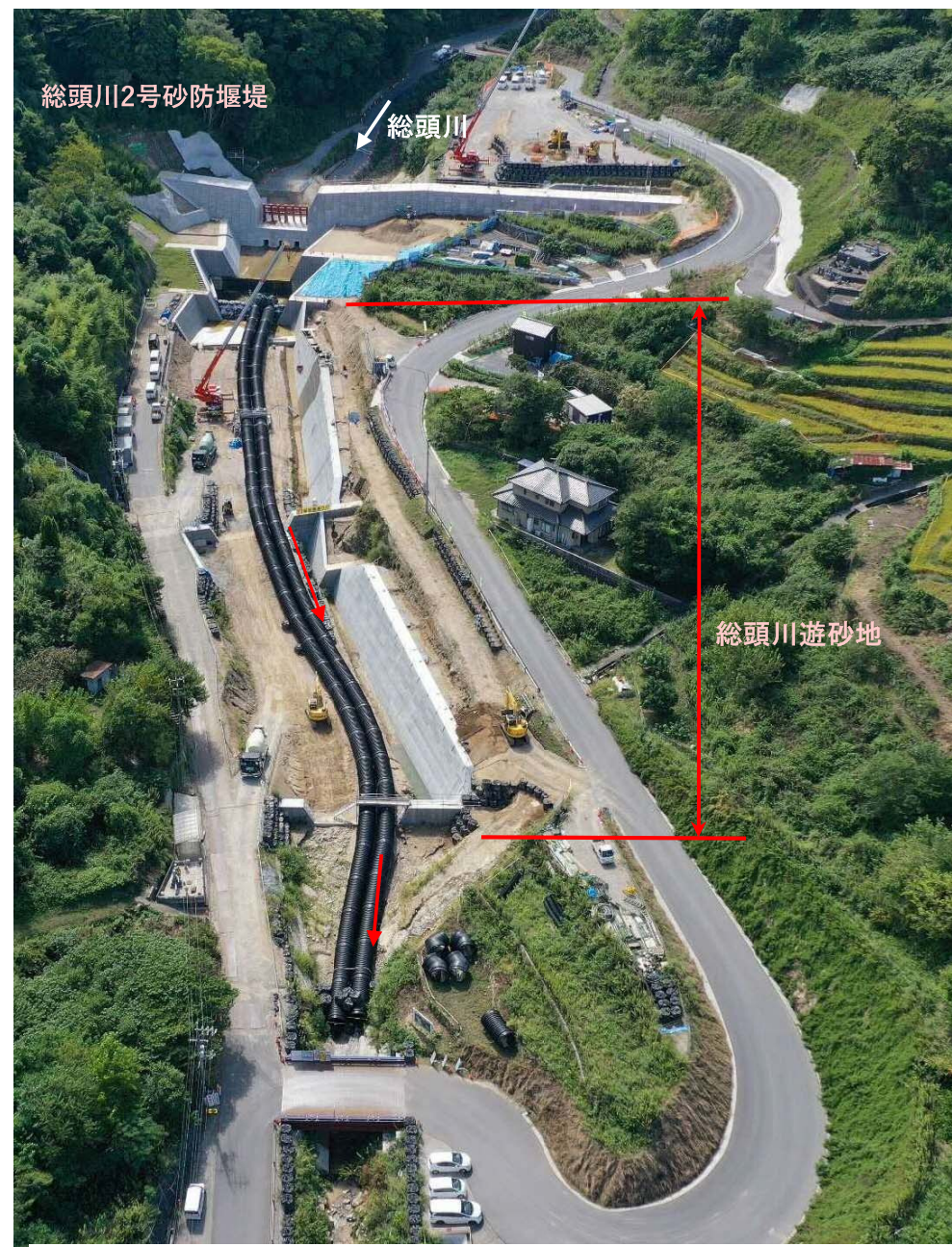
【施工状況(下流から上流を望む)】
