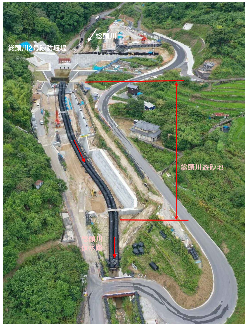
【施工状況(下流から上流を望む)】
