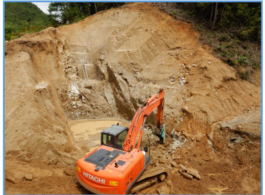
砂防堰堤の本体掘削状況②
