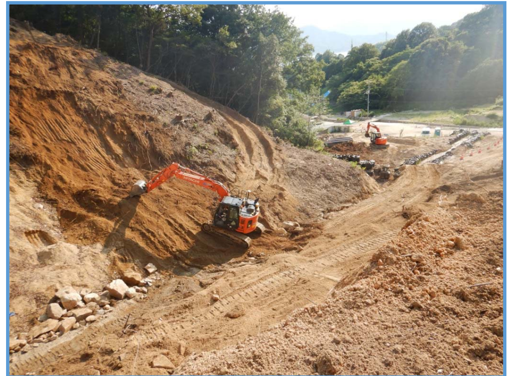
砂防堰堤の本体掘削状況②
