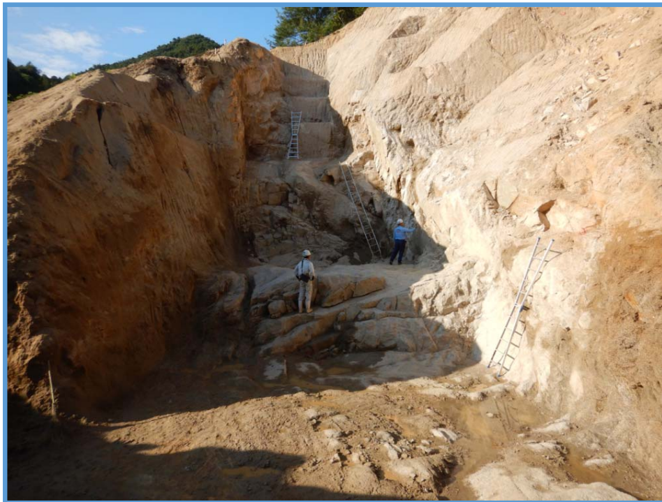
砂防堰堤の本体掘削状況①
