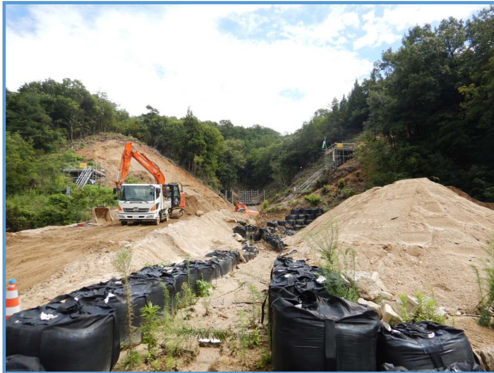
砂防堰堤の本体掘削状況①
