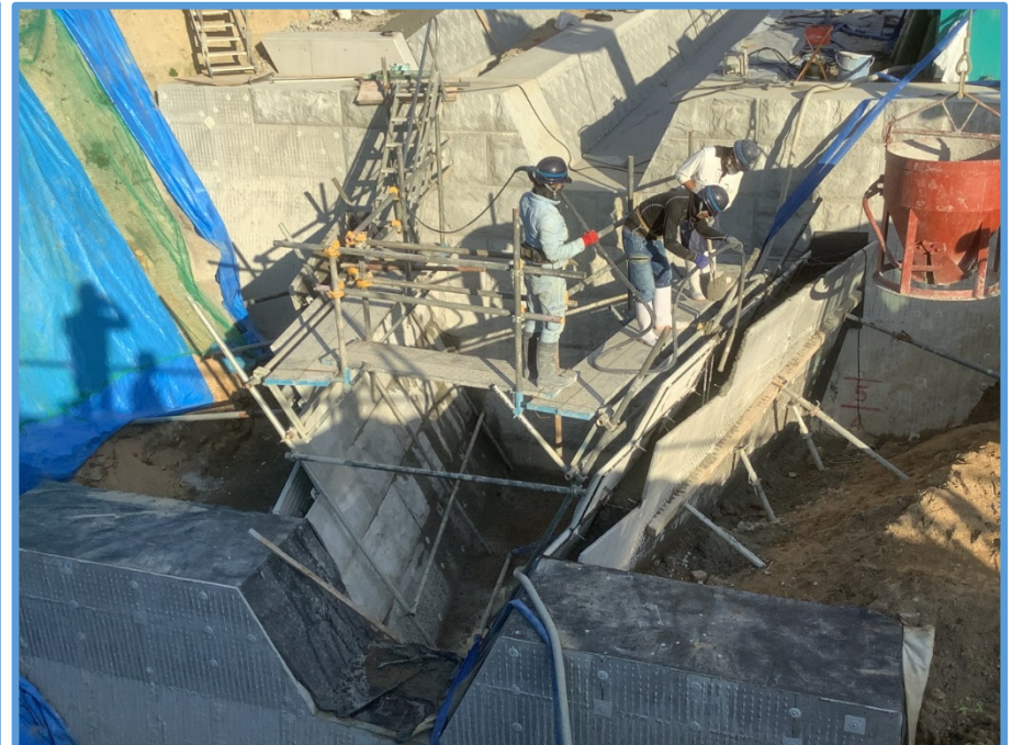
側壁工の施工状況
