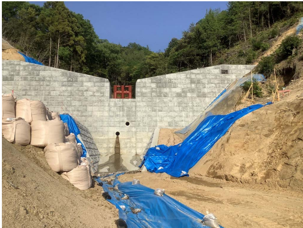
砂防堰堤の埋戻し施工状況
