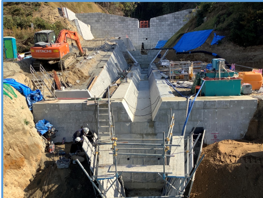
側壁工の施工状況
