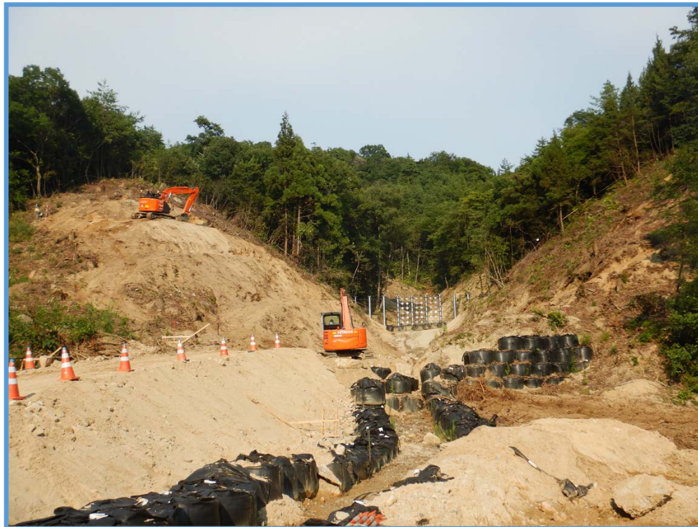
砂防堰堤の本体掘削状況①
