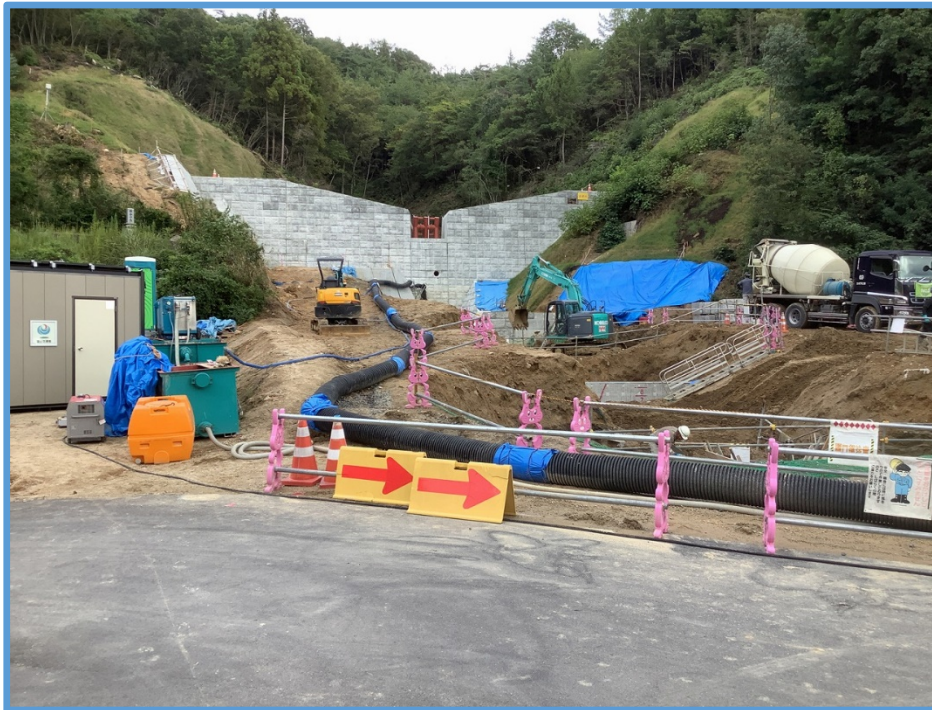
床止の施工状況
