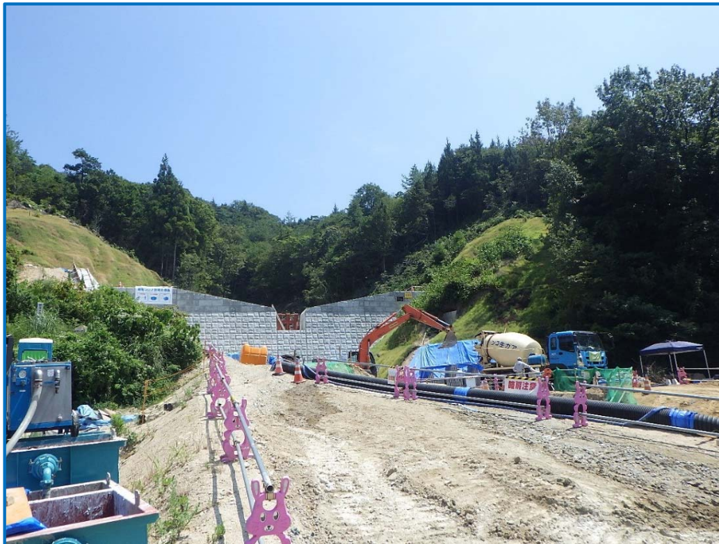
垂直壁の施工状況
