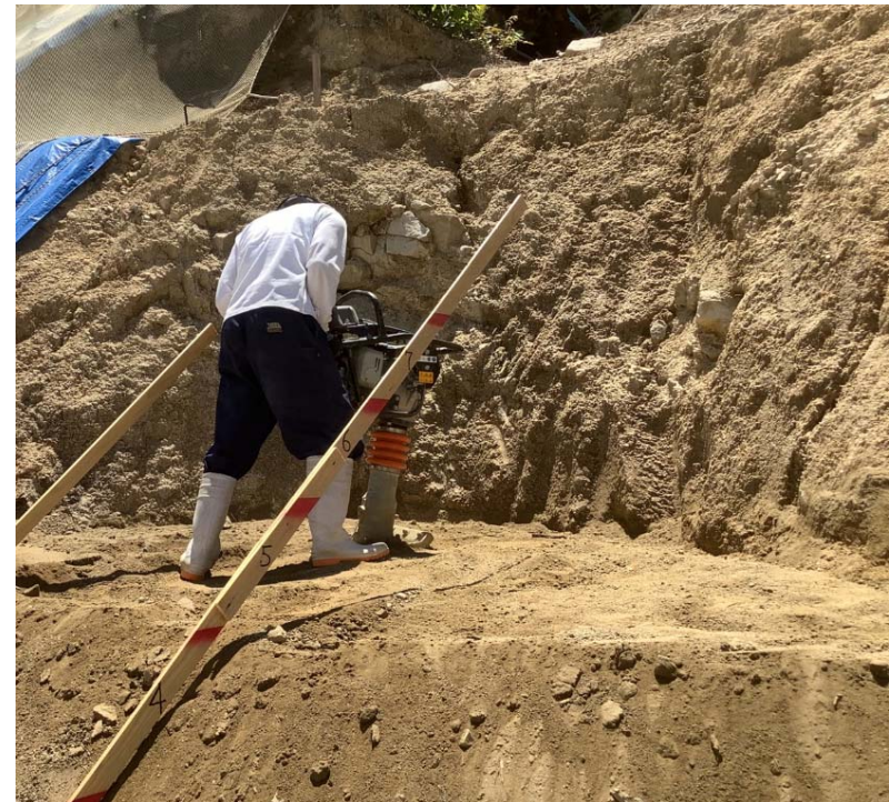
砂防堰堤の埋戻し施工状況
