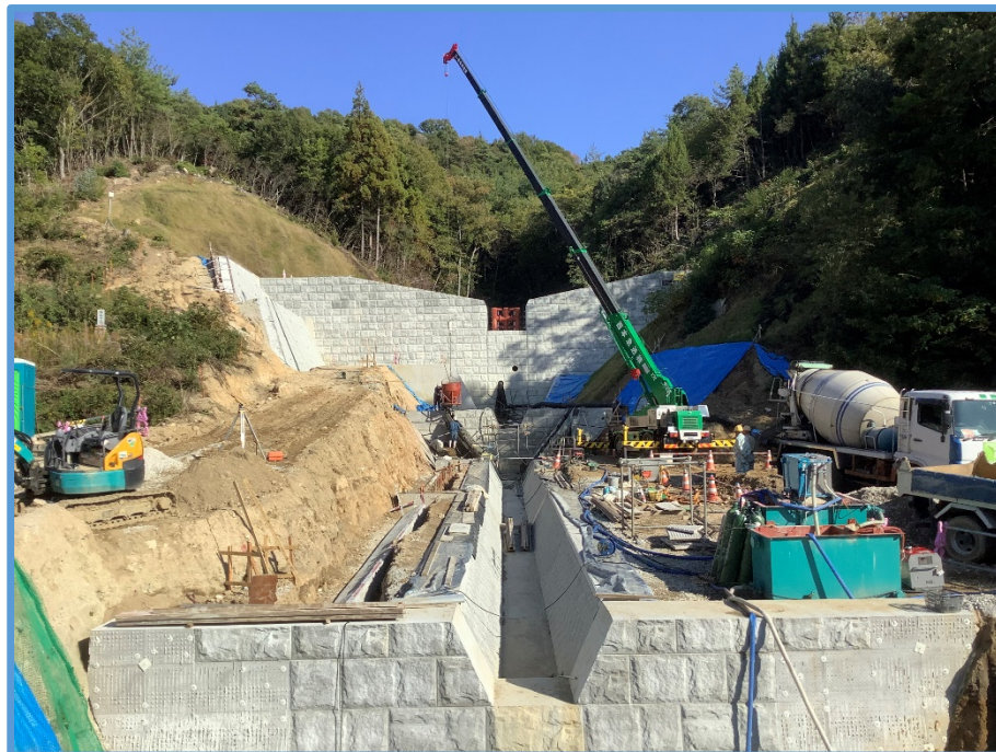
2号垂直壁の施工状況
