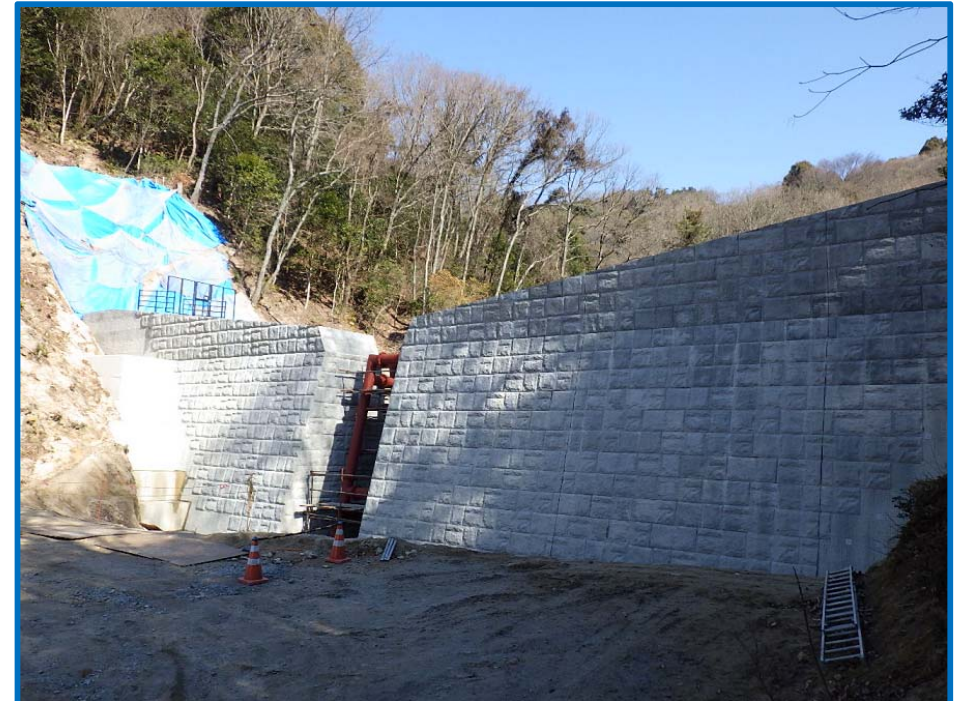
砂防堰堤本体のスリット（鋼製枠） 設置完了
