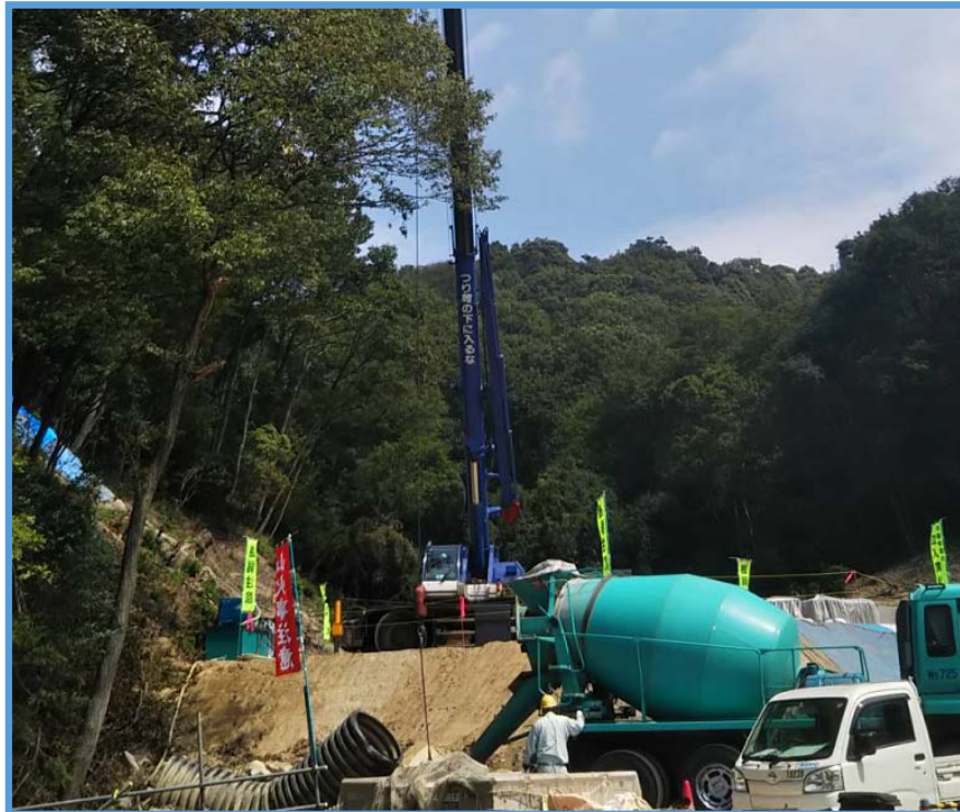
砂防堰堤本体のコンクリート打設状況
