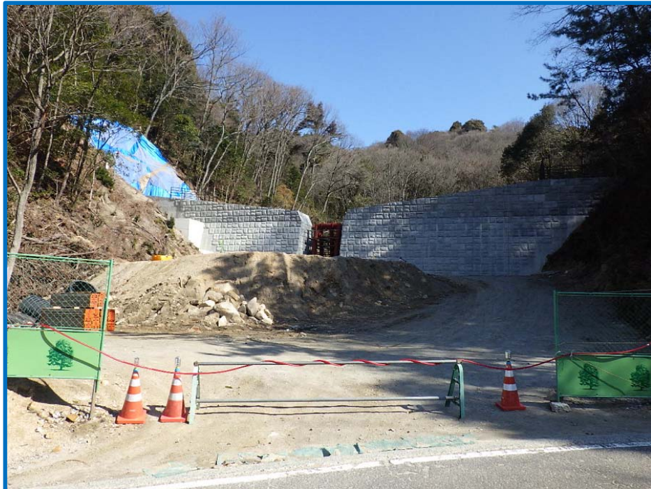
砂防堰堤本体のスリット（鋼製枠） 設置完了
