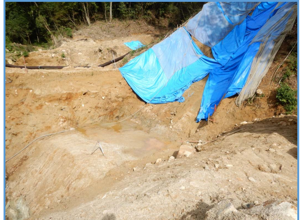
砂防堰堤の本体掘削状況
