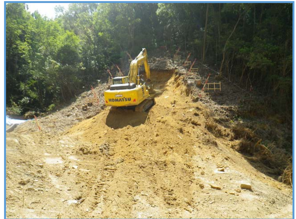
砂防堰堤の本体掘削状況②
