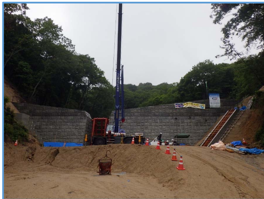
砂防堰堤の階段工実施状況
