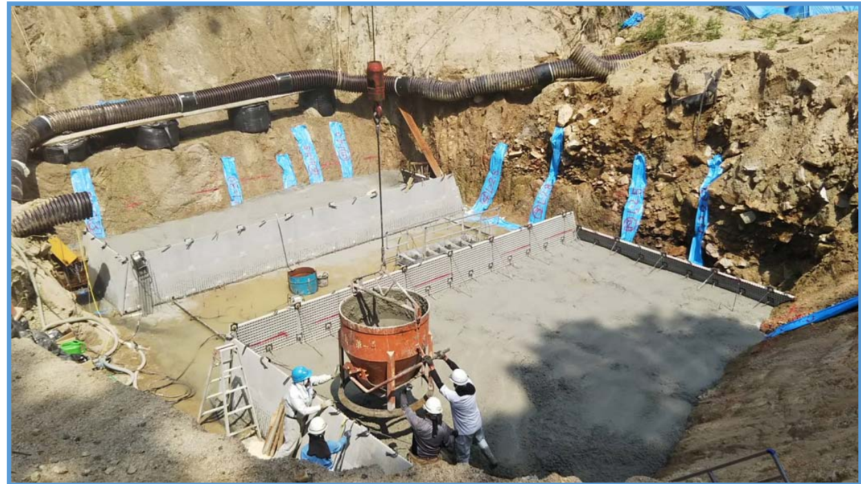
砂防堰堤本体のコンクリート打設状況
