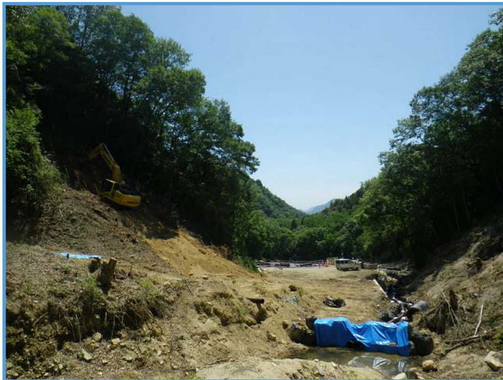
砂防堰堤の本体掘削状況①
