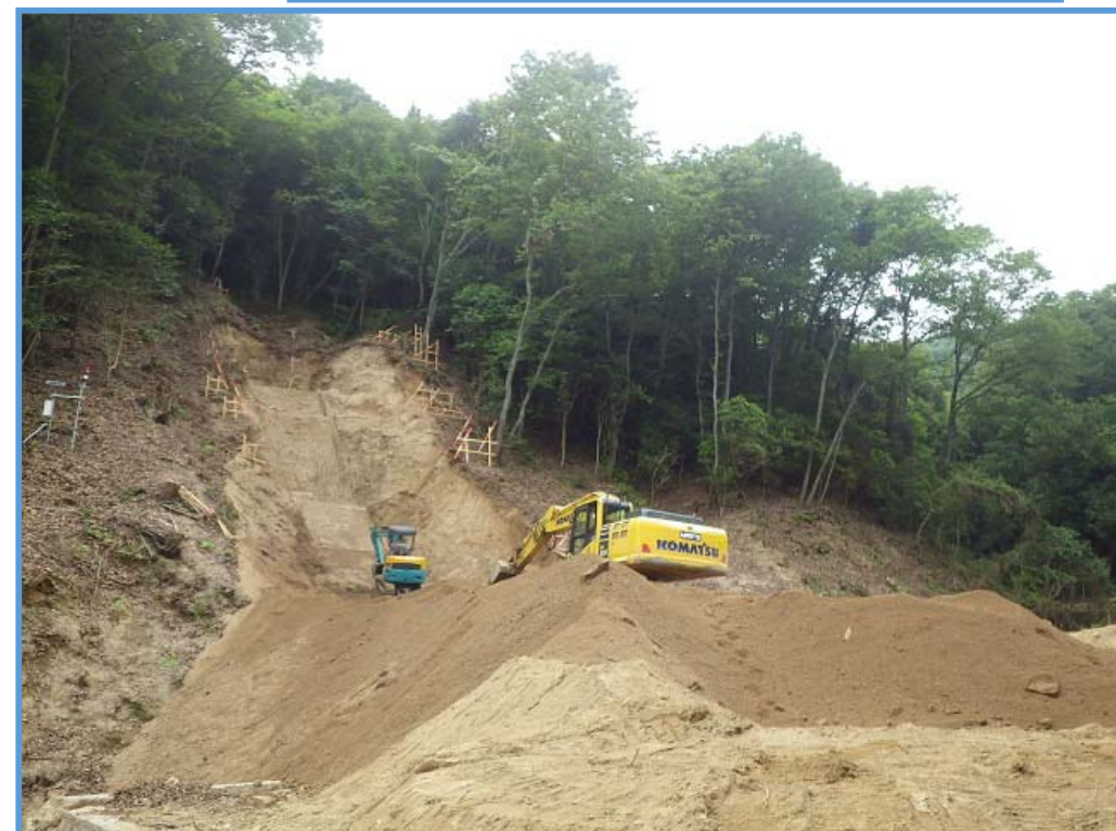
砂防堰堤の本体掘削状況②
