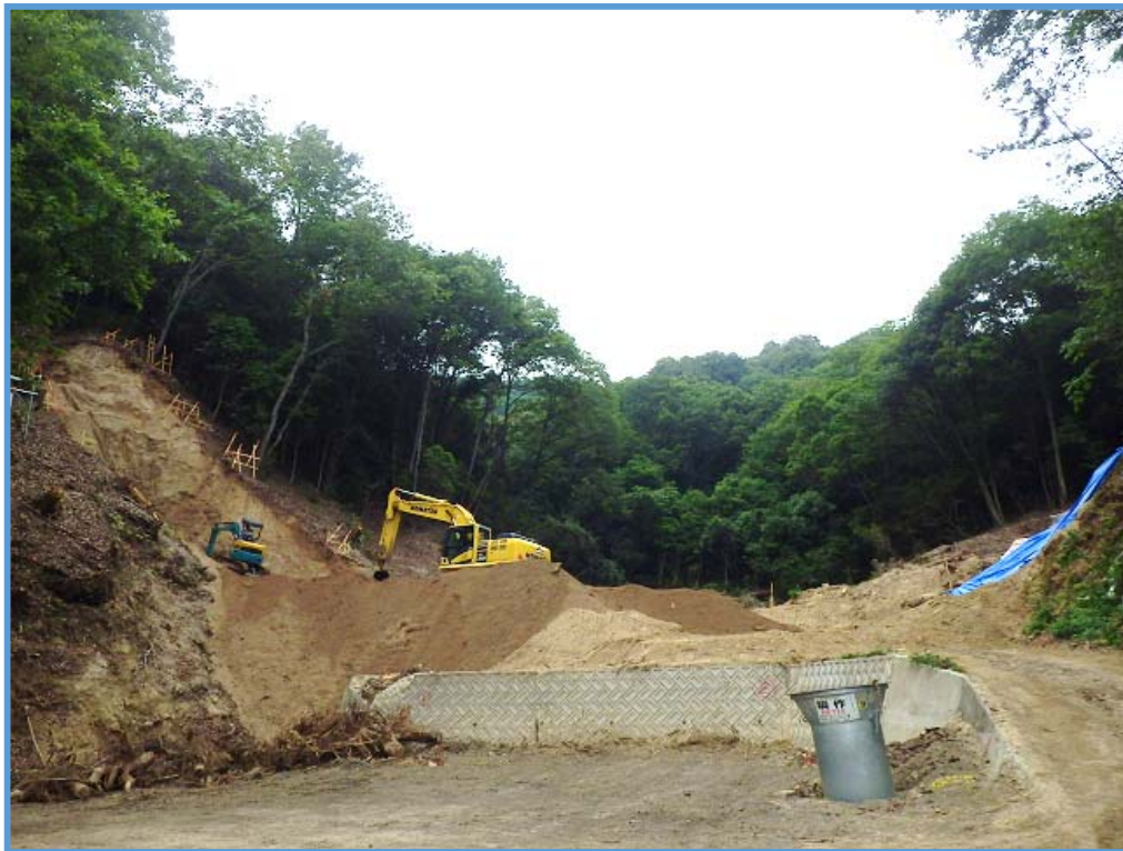
砂防堰堤の本体掘削状況①
