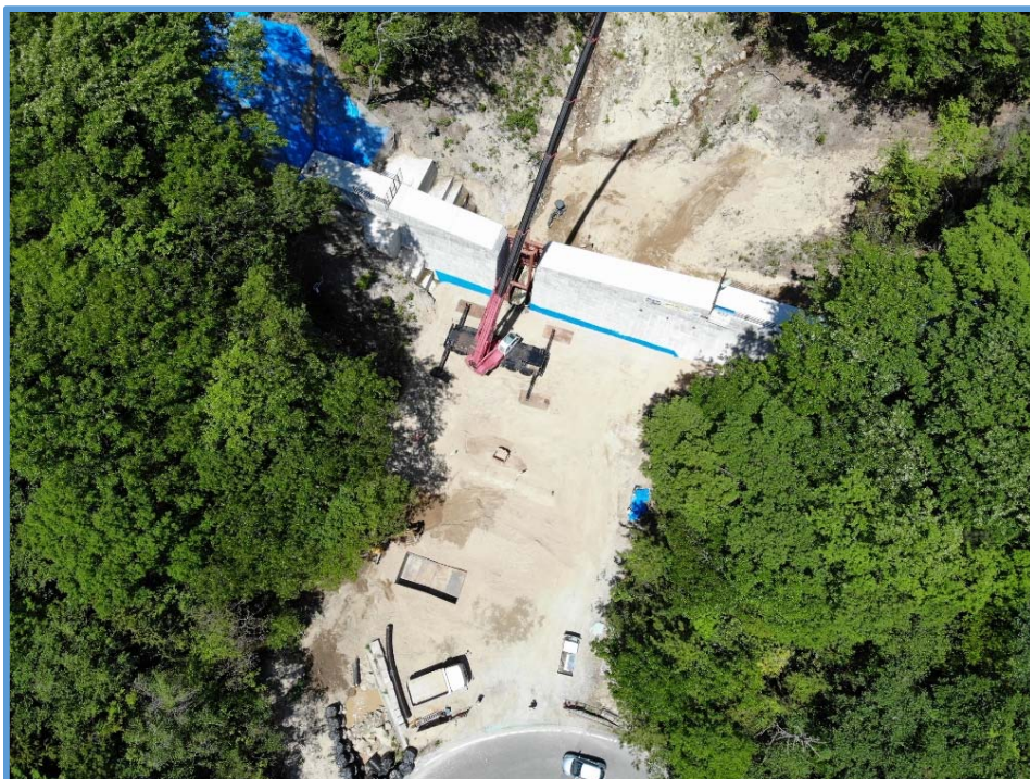
砂防堰堤の埋戻し実施状況
