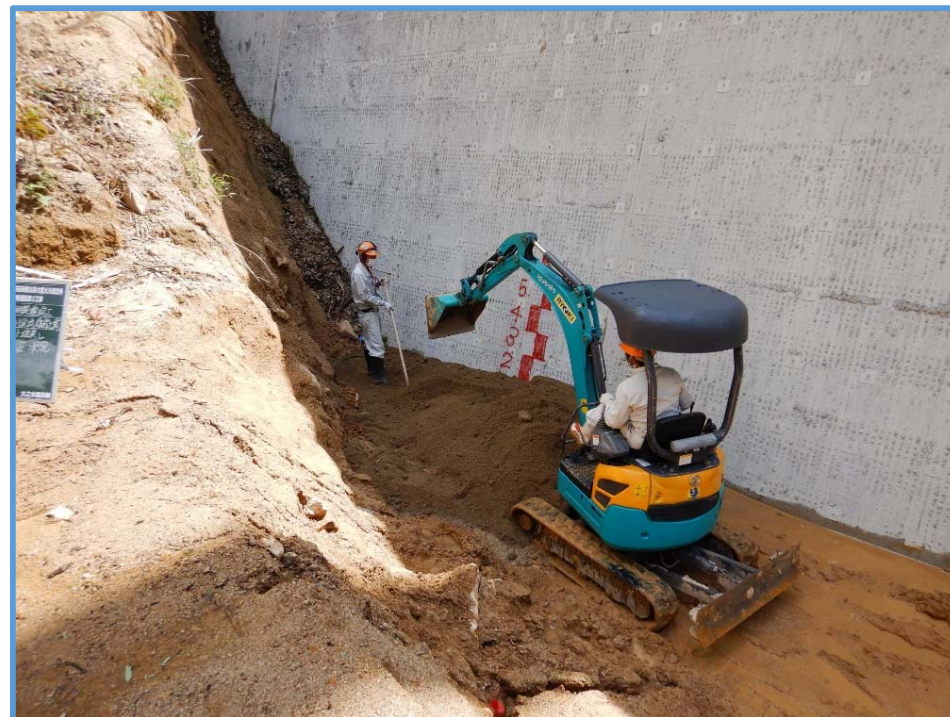
砂防堰堤の埋戻し実施状況
