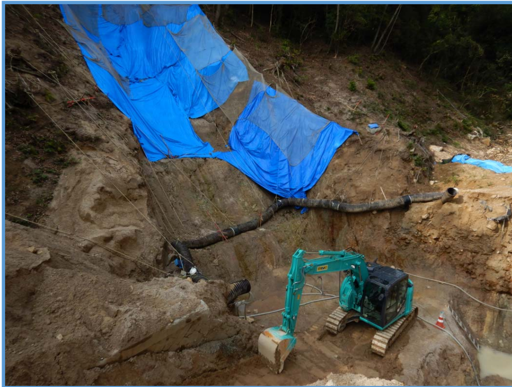
砂防堰堤の本体掘削状況
