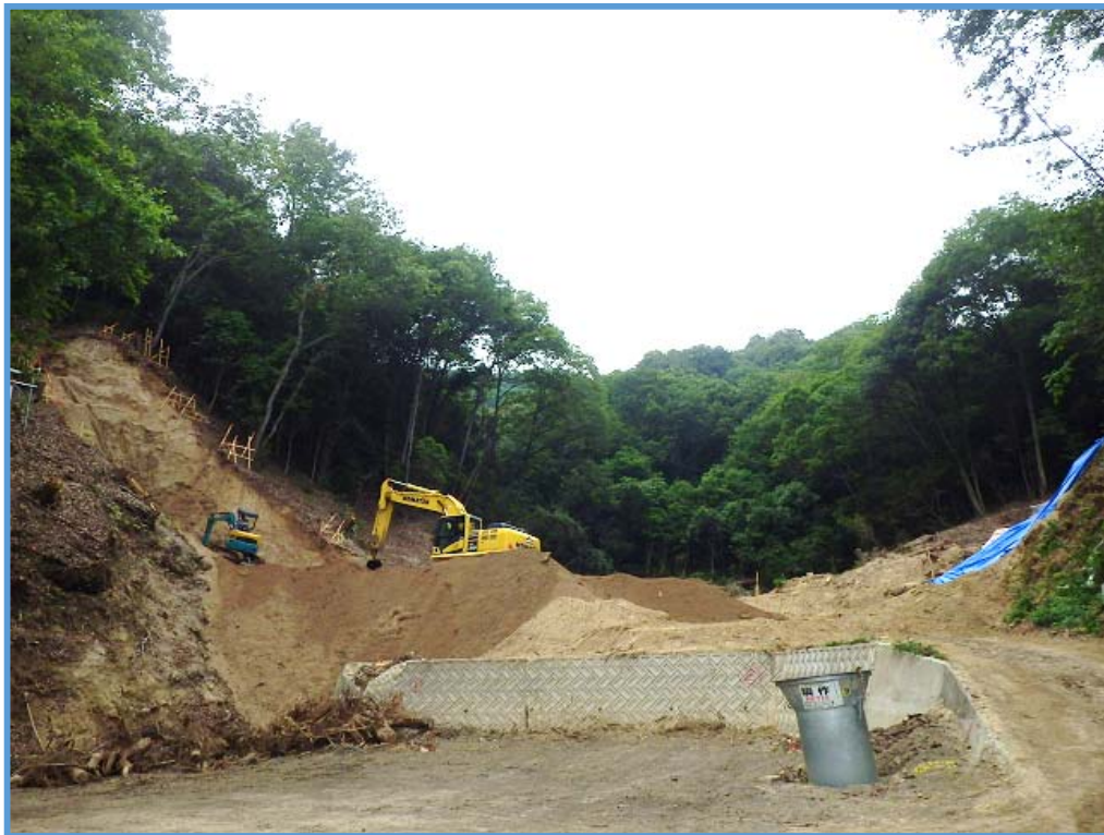
砂防堰堤の本体掘削状況①
