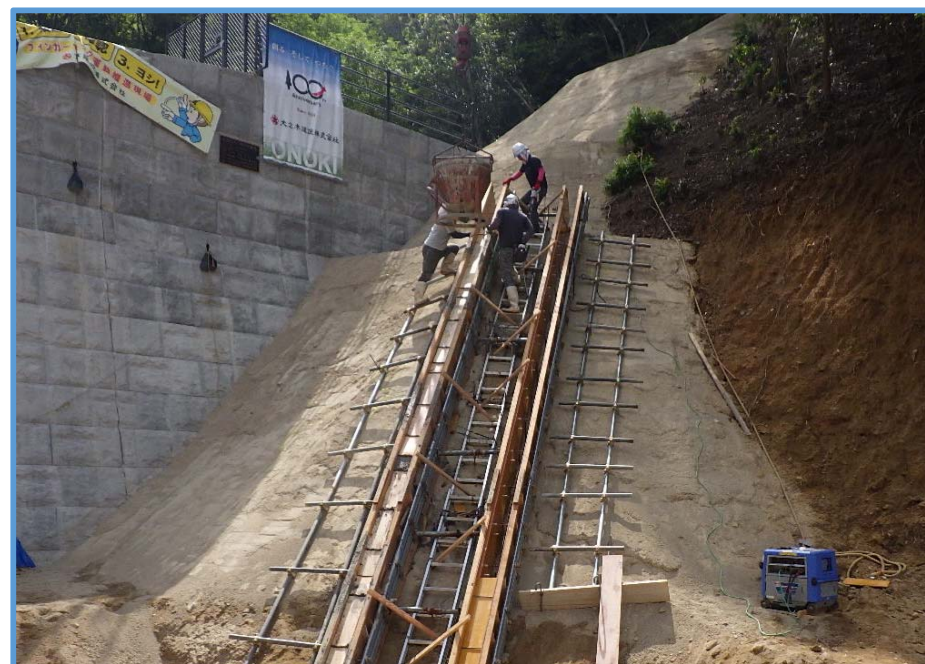
砂防堰堤の階段工実施状況
