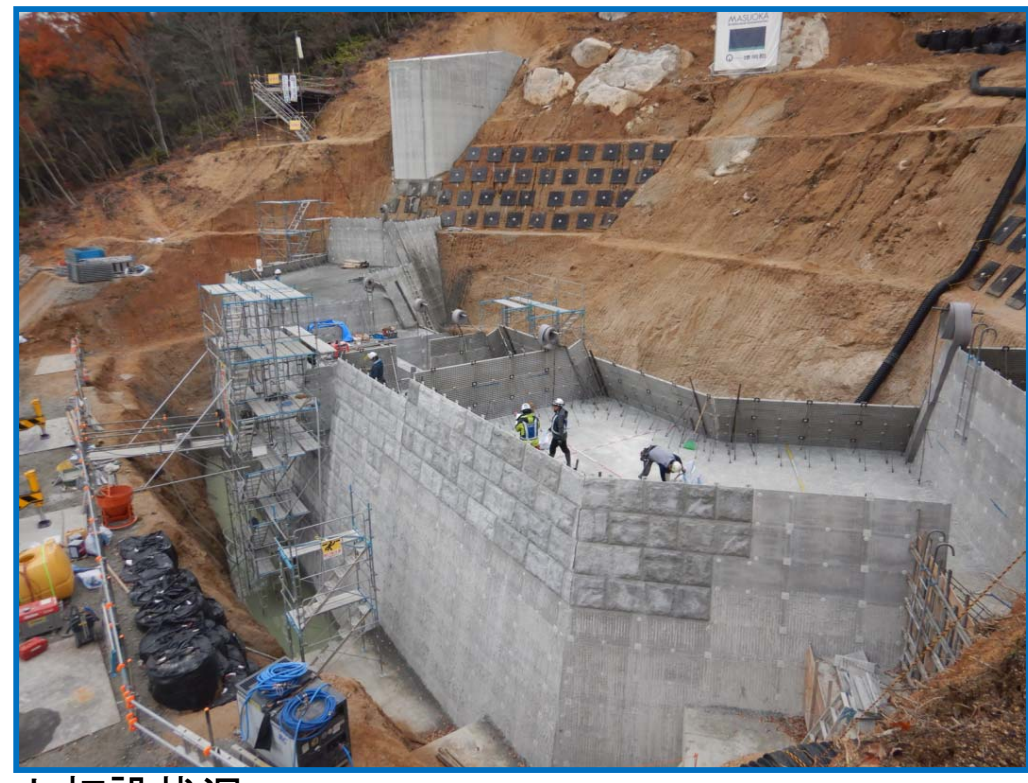
砂防堰堤のコンクリート打設状況
