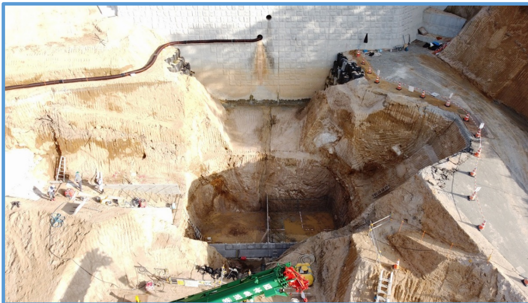
第1垂直壁の施工状況
