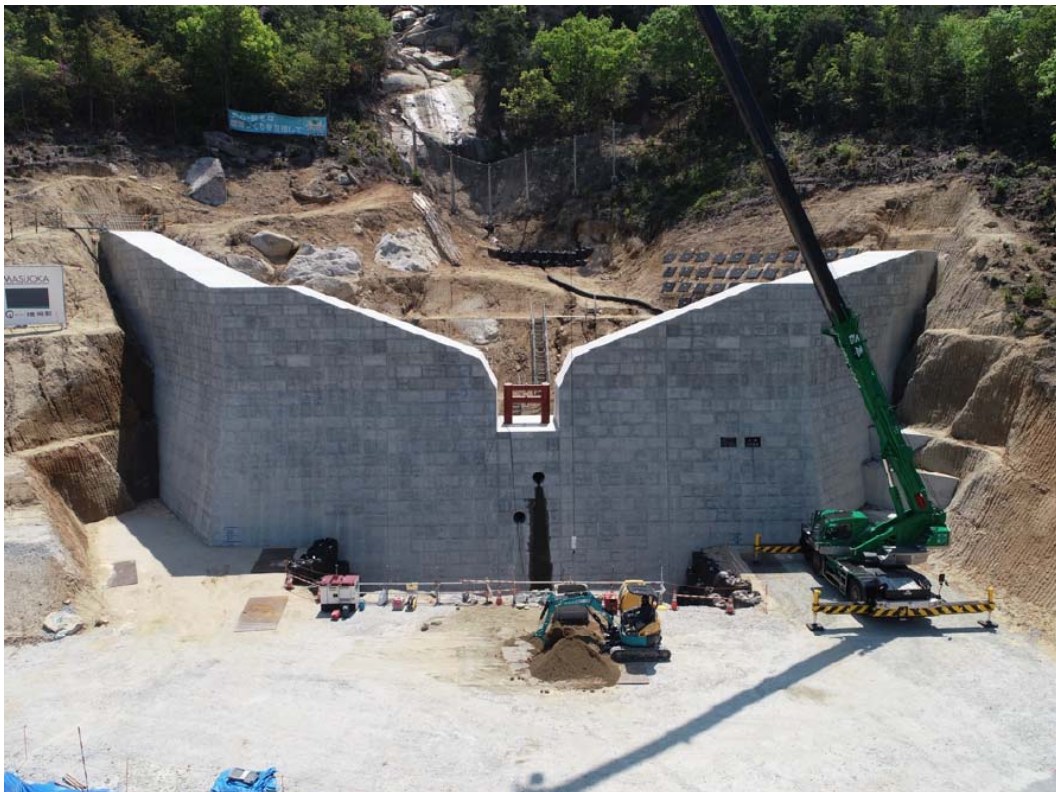
砂防堰堤の埋戻し施工状況
