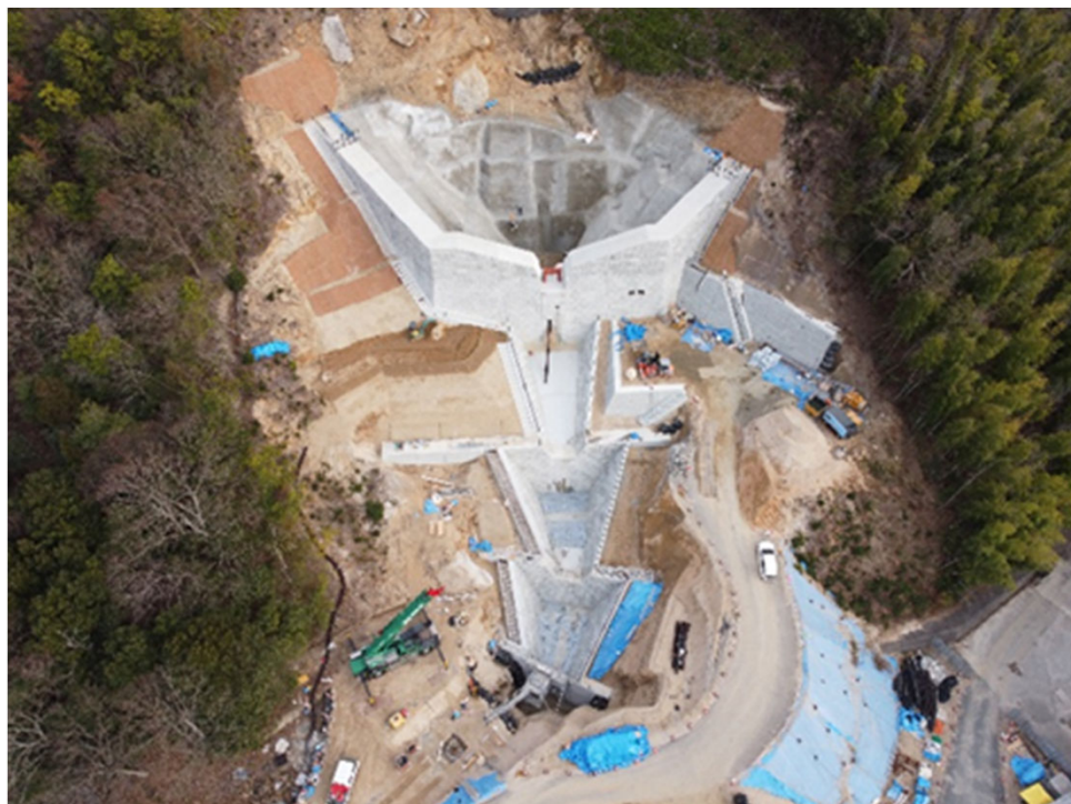
法面工、階段工実施状況
