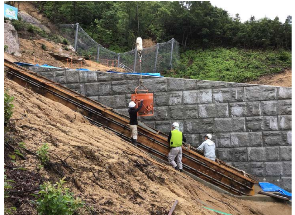
砂防堰堤の階段工施工状況
