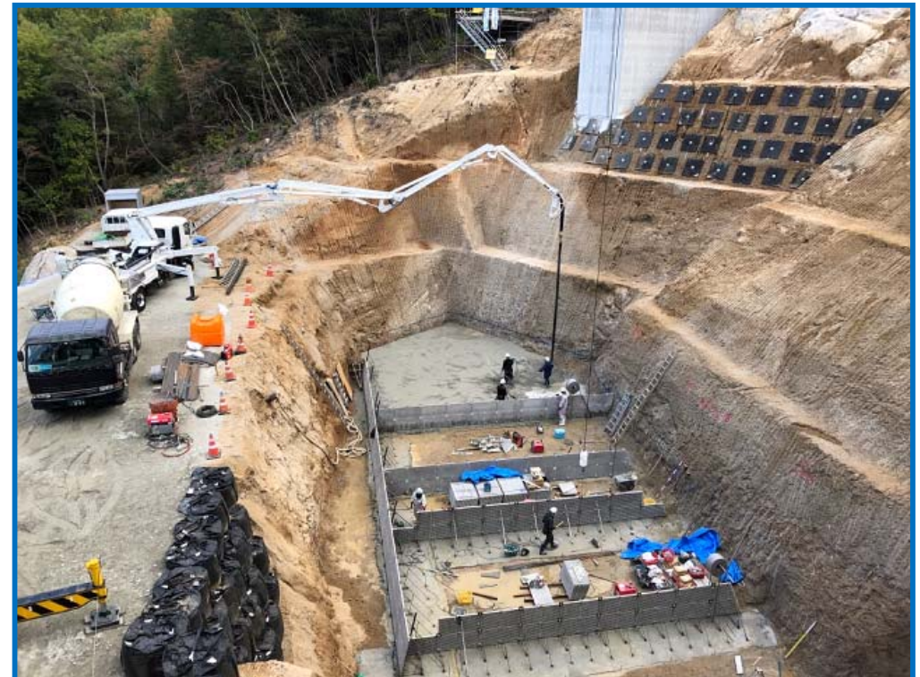
砂防堰堤のコンクリート打設状況
