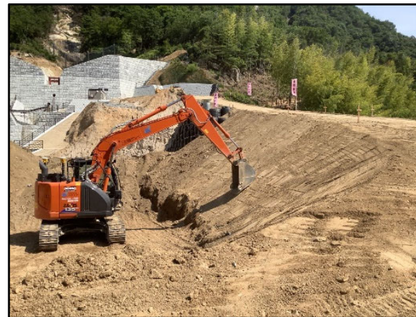
管理用道路施工状況
