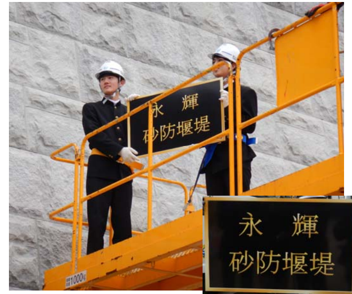
天応中学校で命名頂いた堰堤銘板を設置
