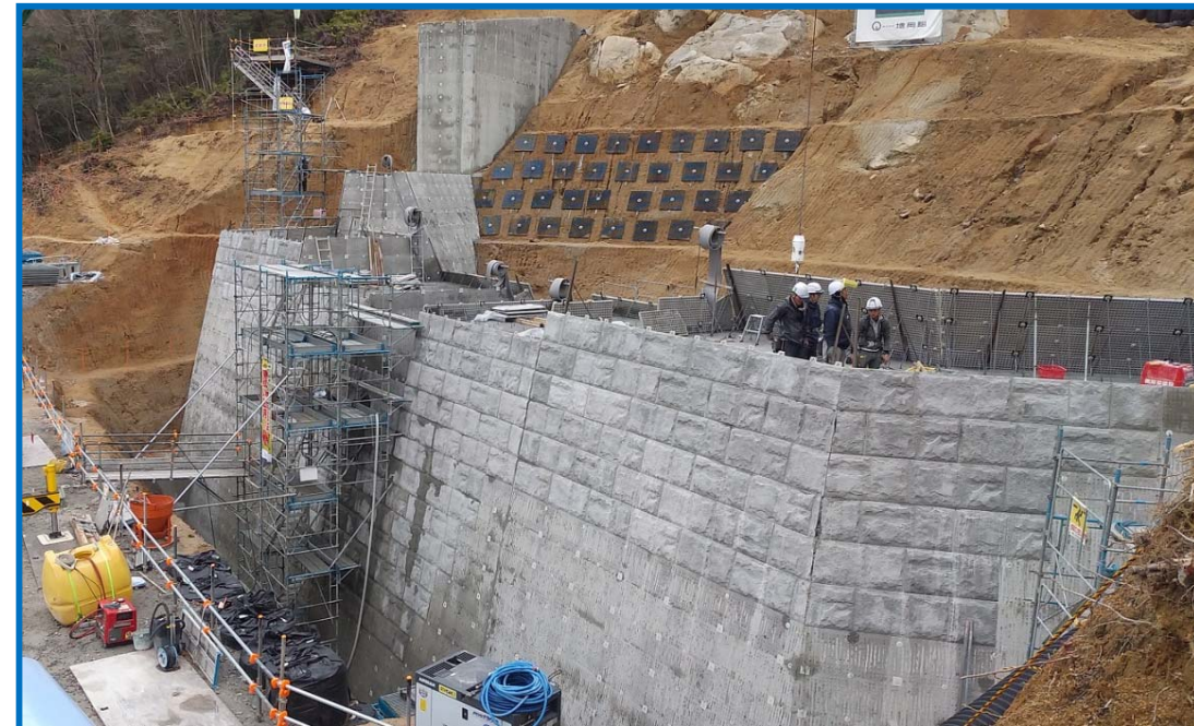
砂防堰堤のコンクリート打設状況
