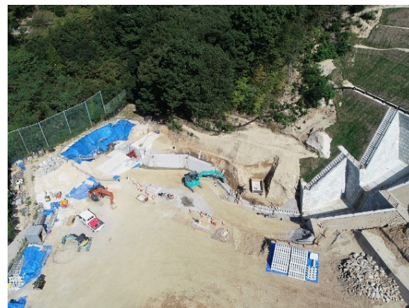
92隣e施工状況
