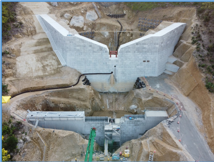
第1垂直壁のコンクリート打設状況
