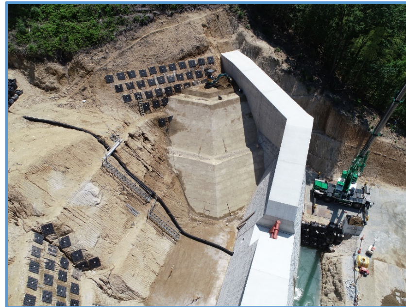
砂防堰堤の埋戻し施工状況
