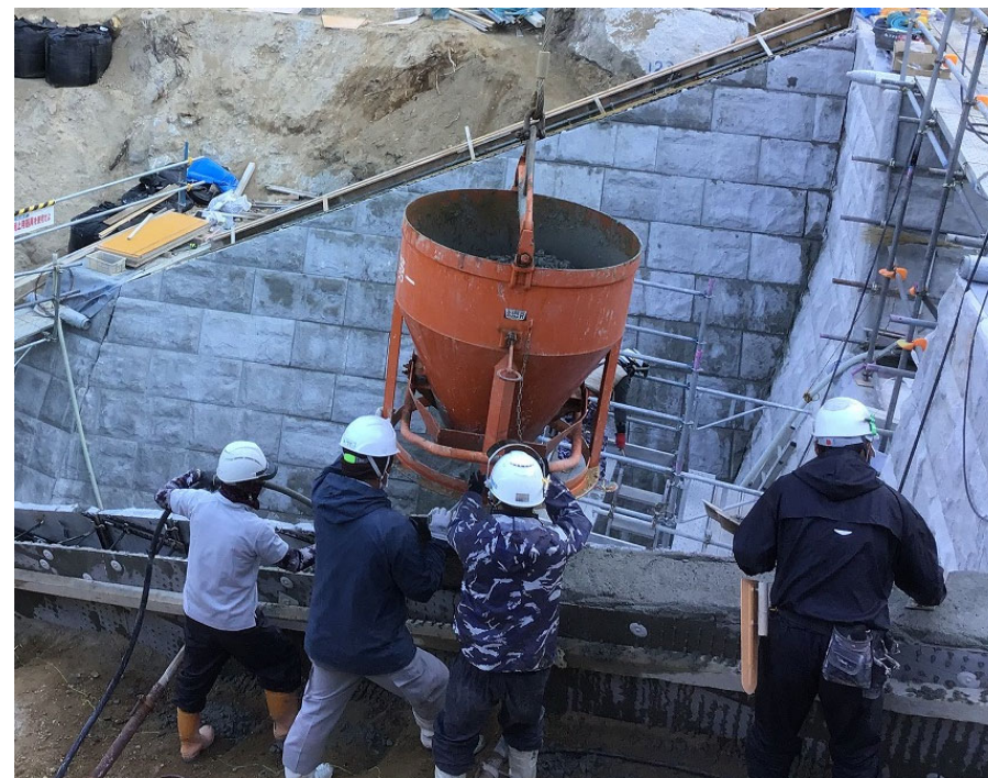
側壁工のコンクリート打設状況
