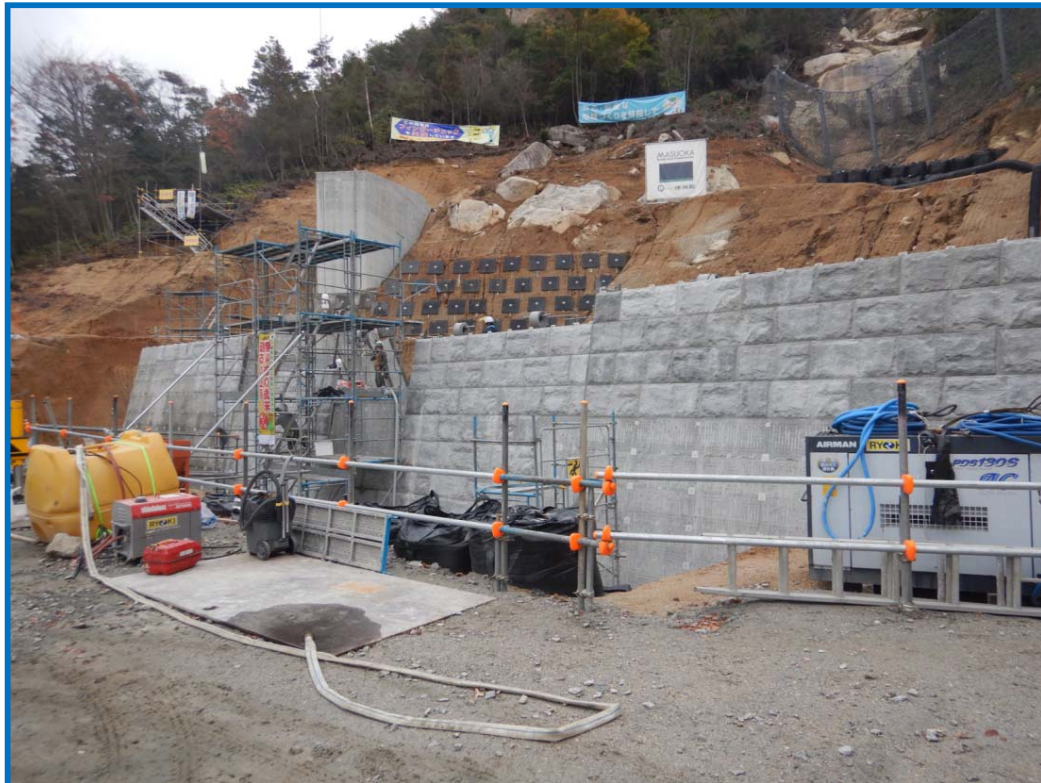
砂防堰堤のコンクリート打設状況
