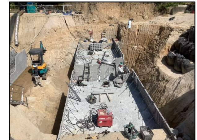
流木捕捉工施工状況
