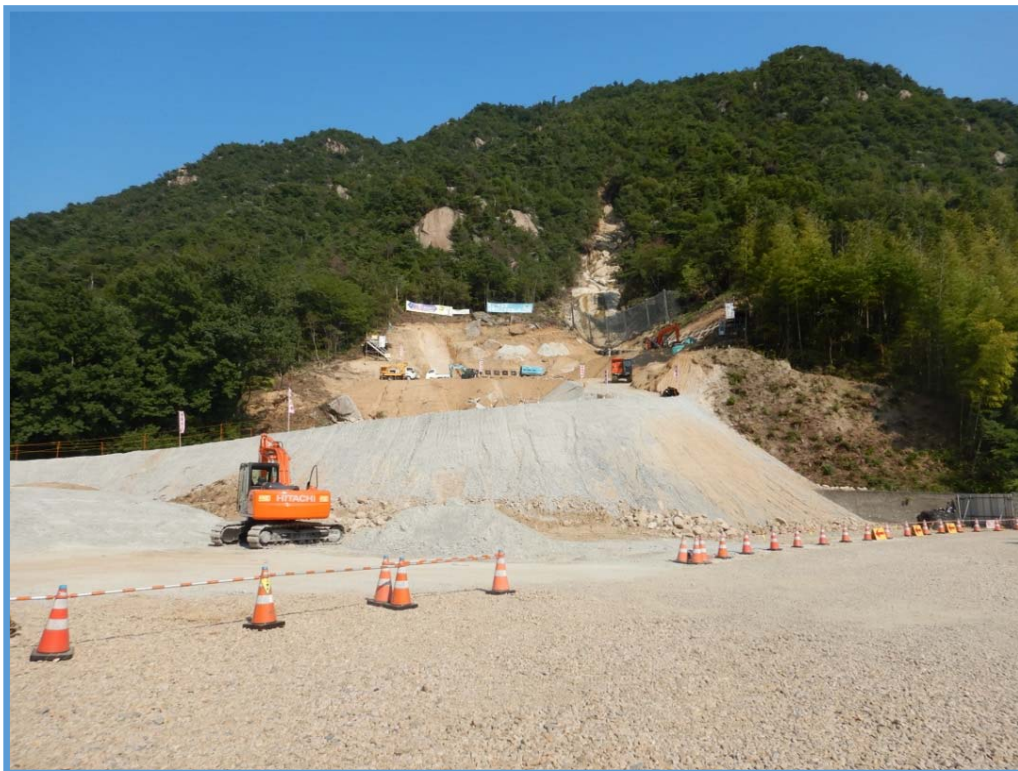
砂防堰堤の本体掘削状況 ①
