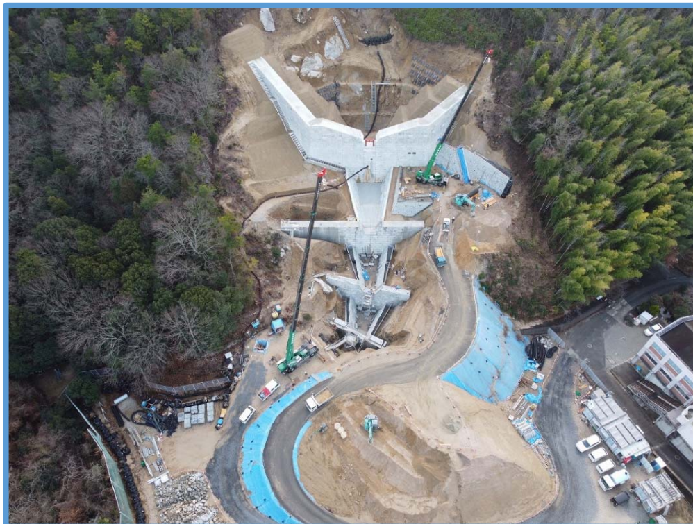
第3垂直壁、側壁工の型枠設置状況
