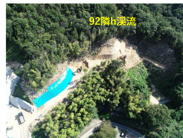
92隣h施工状況
