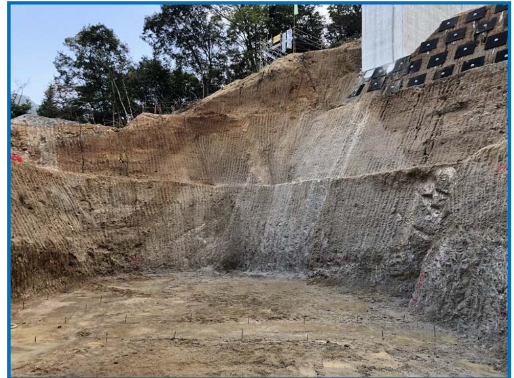
砂防堰堤の本体掘削（2次）状況
