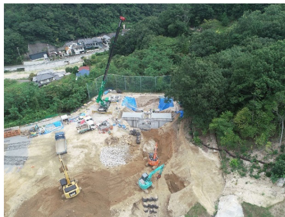
流木捕捉工施工状況（92隣e）
