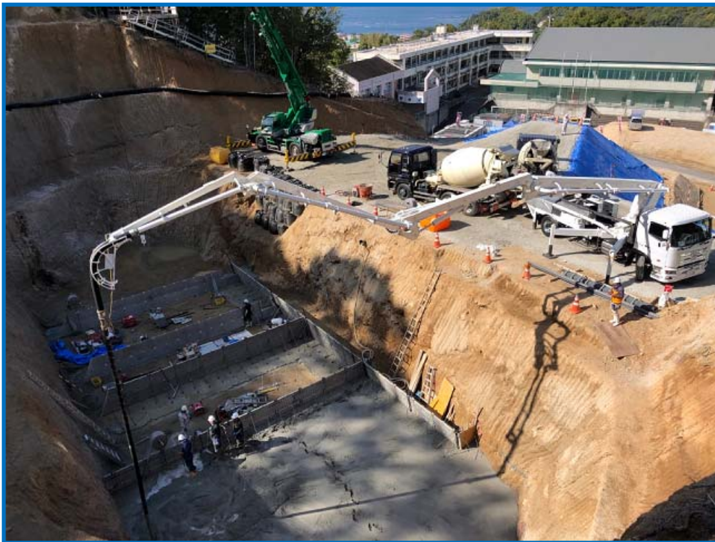
砂防堰堤のコンクリート打設状況
