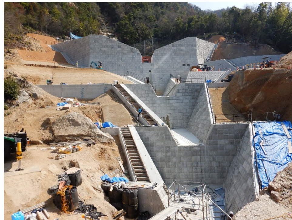
法面工、階段工実施状況
