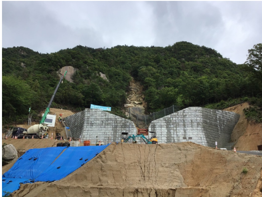
砂防堰堤の階段工施工状況
