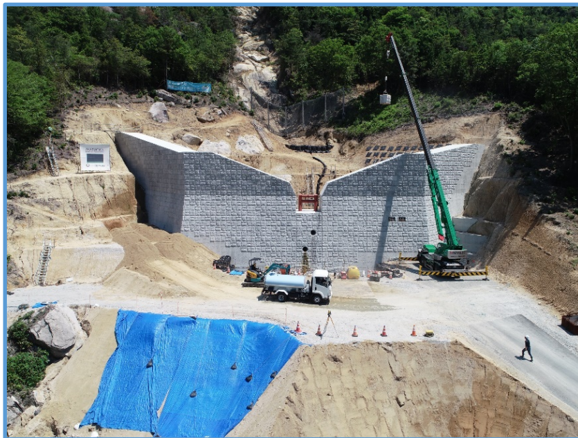
砂防堰堤の埋戻し施工状況
