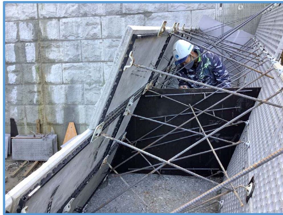
第3垂直壁、側壁工の型枠設置状況
