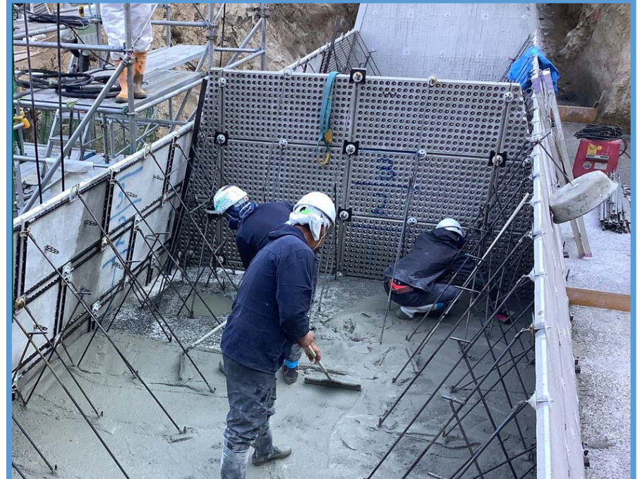
第1垂直壁のコンクリート打設状況
