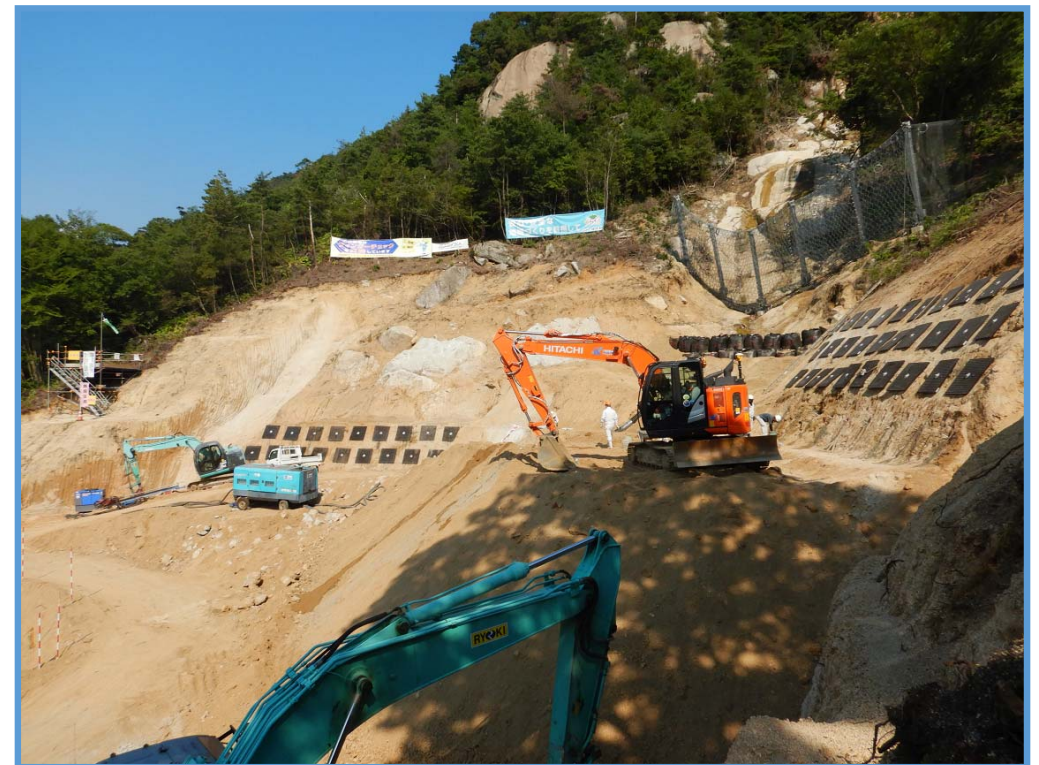
砂防堰堤の本体掘削状況 ②
