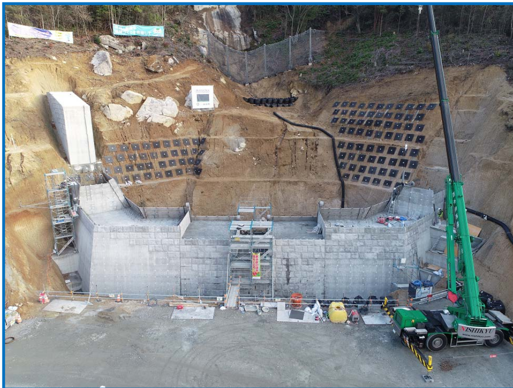
砂防堰堤のコンクリート打設状況
