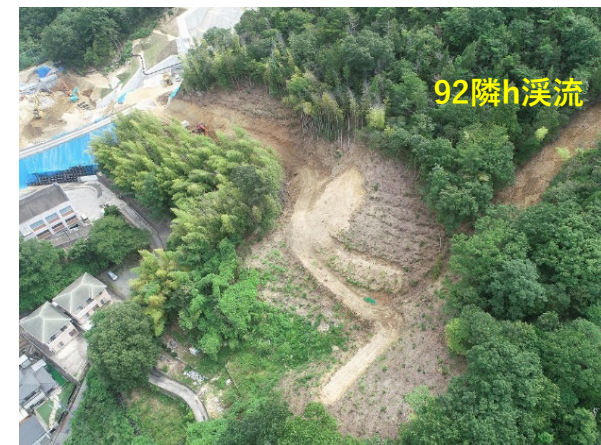
92隣h施工状況
