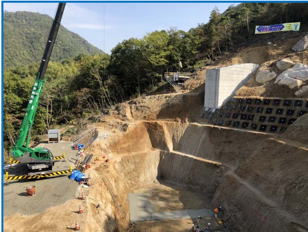
砂防堰堤の本体掘削（2次）状況
