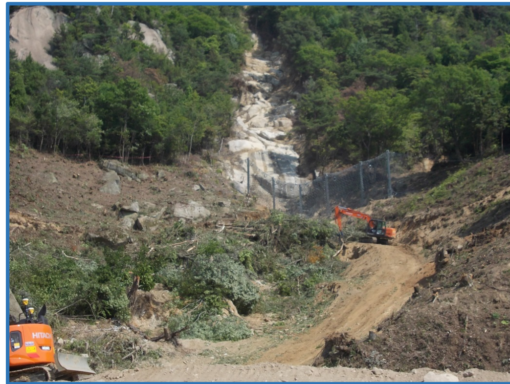
伐木・伐採 実施状況 (砂防堰堤付近)
