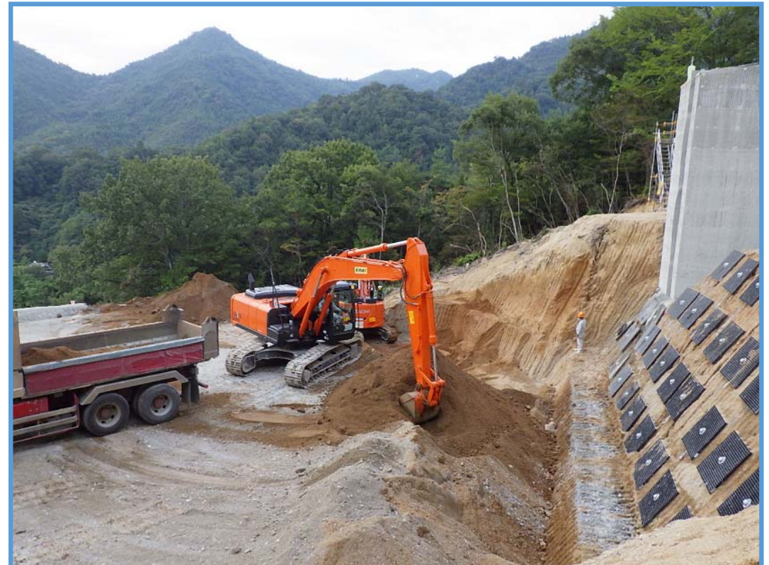
砂防堰堤の掘削状況
