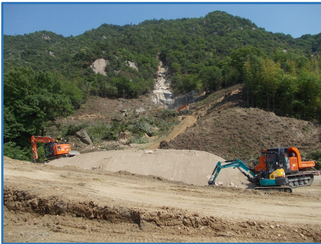
伐木・伐採 実施状況 (全体)
