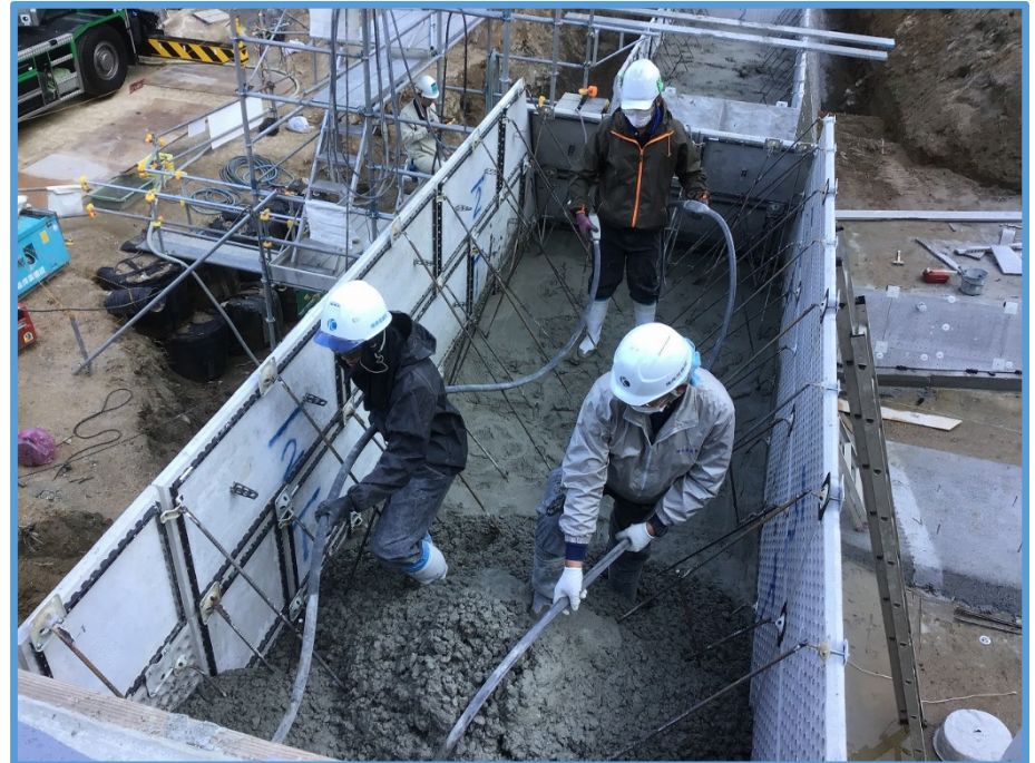
第1垂直壁のコンクリート打設状況
