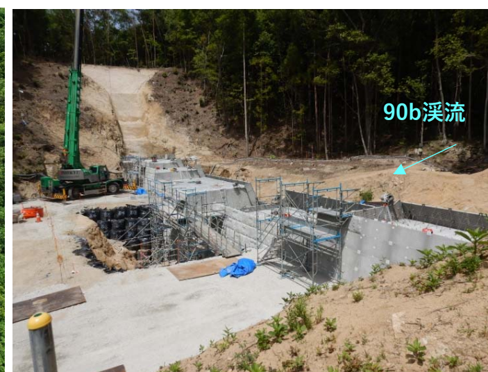
【コンクリート打設状況】
