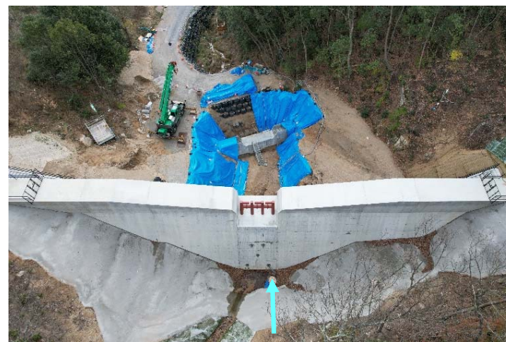
【前庭保護工の施工状況】
