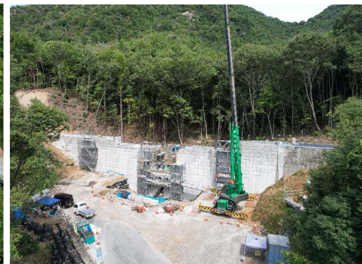
【コンクリート打設状況】
