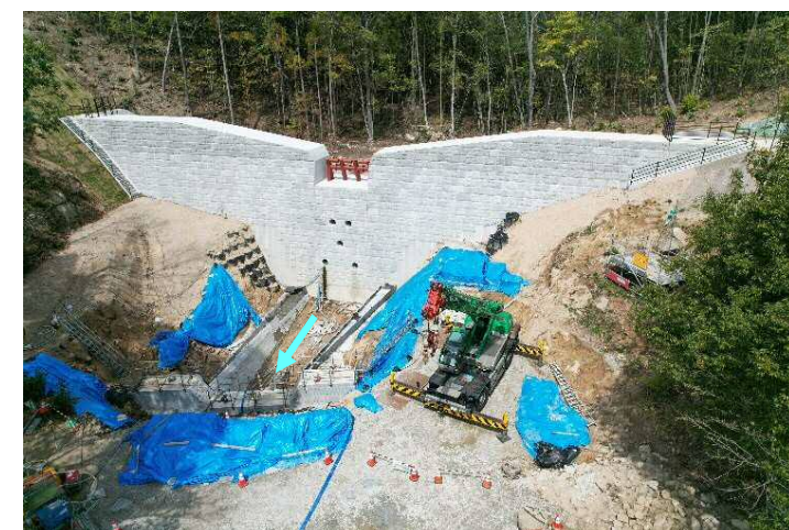
【前庭保護工の施工状況】
