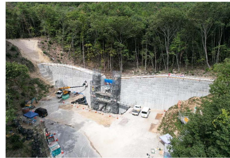
【鋼製スリット設置状況】
