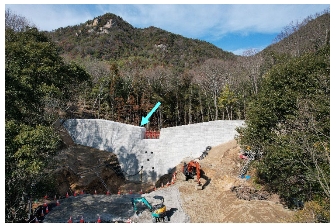
【前庭保護工の施工状況】
