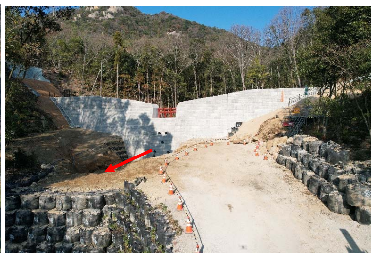
【前庭保護工の施工状況】
