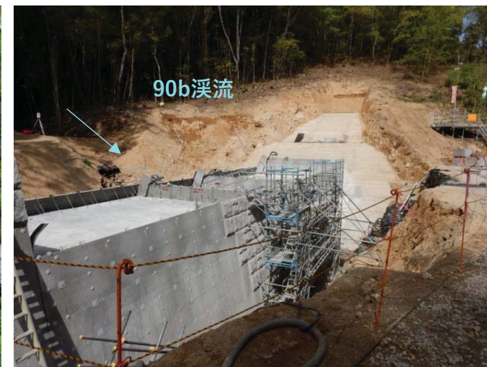
【コンクリート打設状況】
