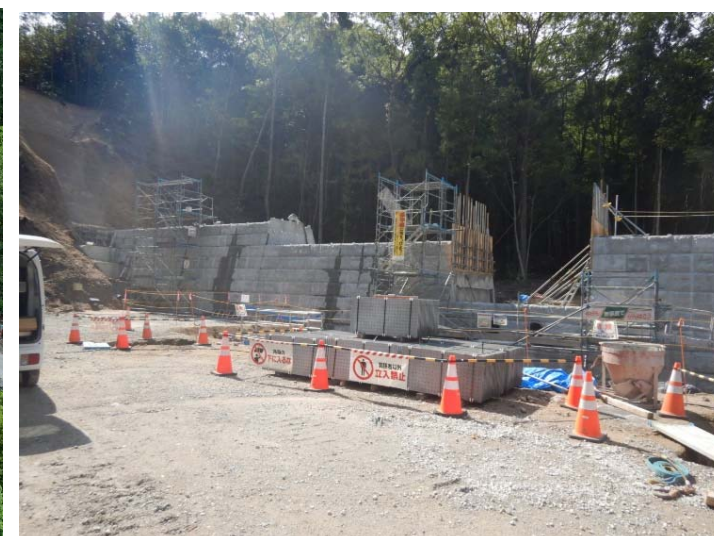
【コンクリート打設状況】
