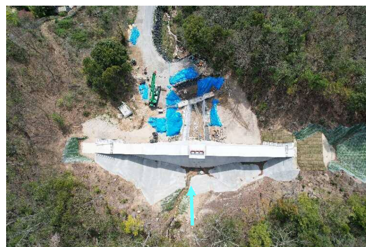
【前庭保護工の施工状況】
