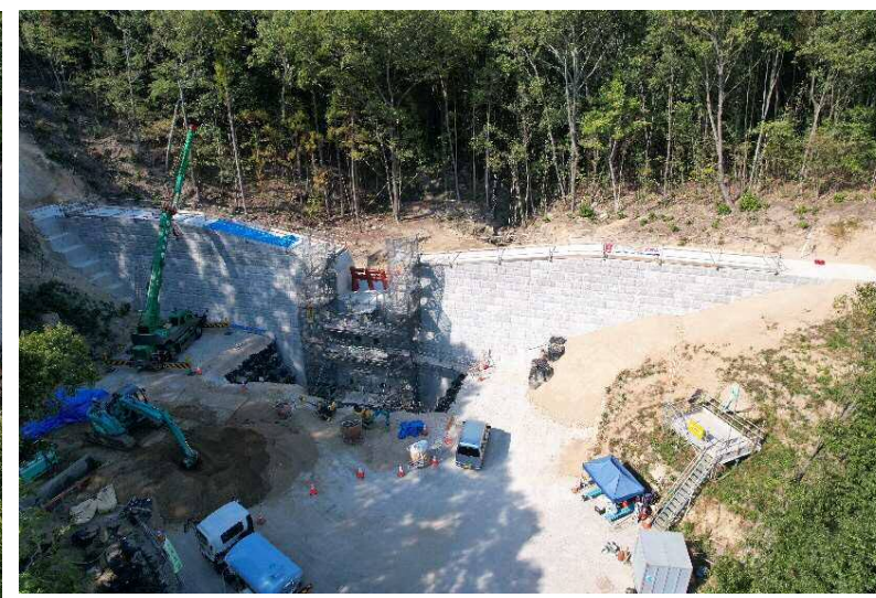
【砂防堰堤本体の埋め戻し状況】
