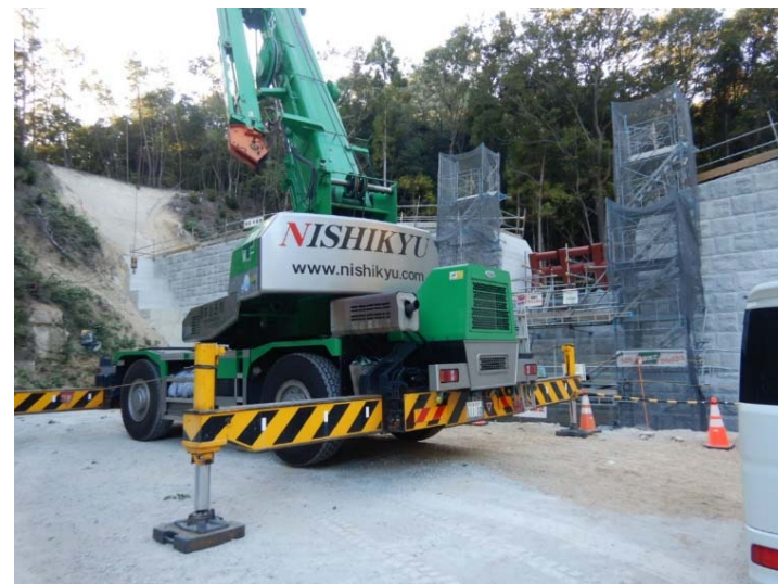
【鋼製スリット設置状況】
