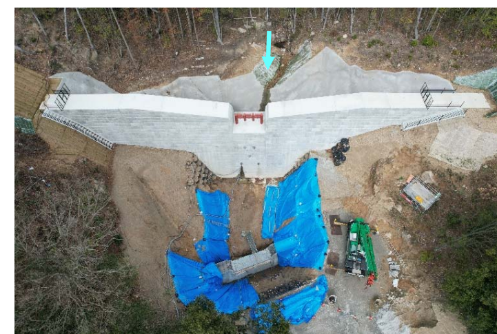
【前庭保護工の施工状況】
