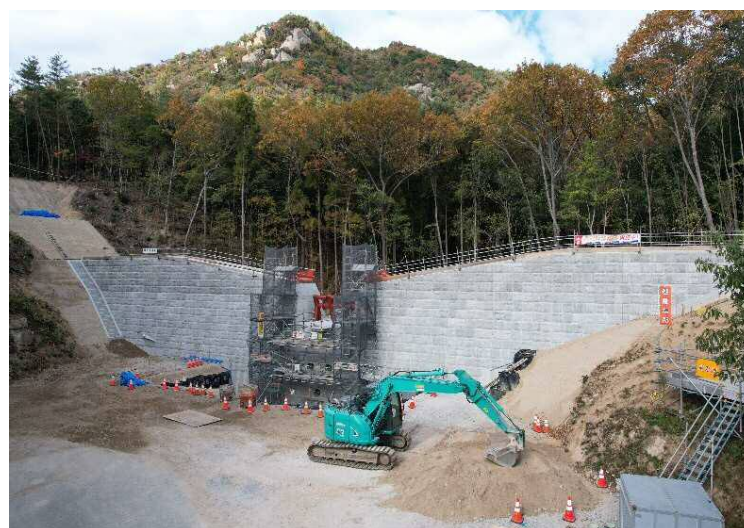
【砂防堰堤本体の埋め戻し状況】
