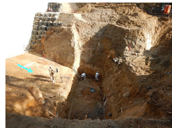
【前庭保護工の施工状況】
