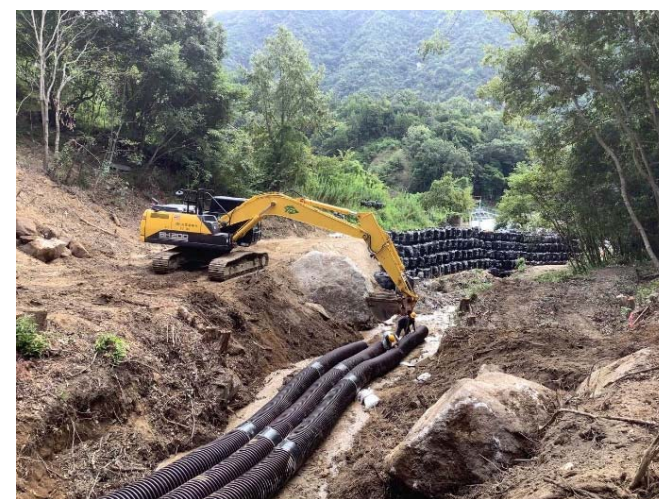
工事用道路の施工状況
