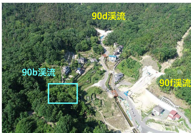
【砂防堰堤全景（90b,90d,90f溪流）】
