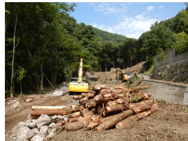
伐採の施工状況
