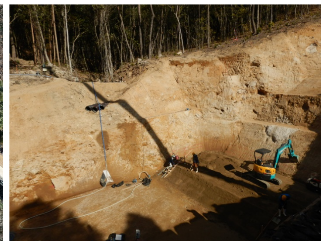
【置換え工実施状況】
