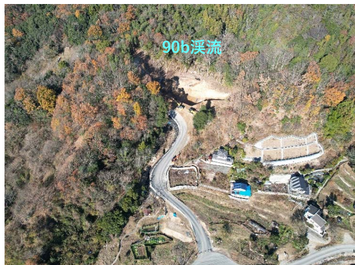
【下流より砂防堰堤整備箇所を望む】
