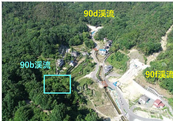
【砂防堰堤全景 (90b,90d,90f溪流)】
