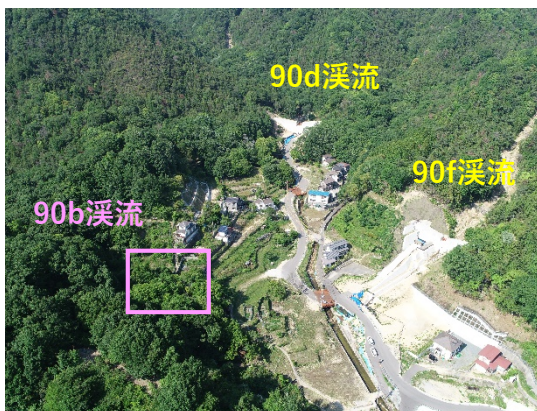
砂防堰堤全景（90b、90d、90f溪流）
