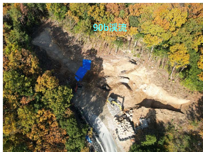
【下流より砂防堰堤整備箇所を望む】
