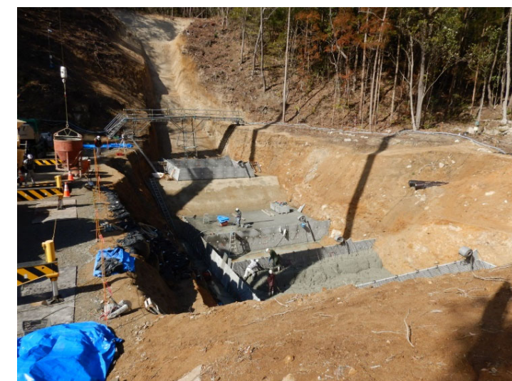
【コンクリート打設状況】
