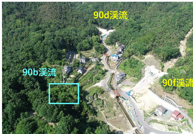
【砂防堰堤全景 (90b,90d,90f溪流)】
