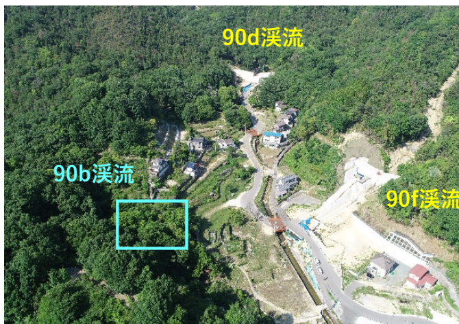
【砂防堰堤全景（90b,90d,90f溪流）】
