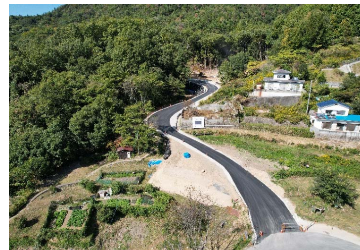
工事用道路の施工状況
