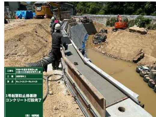
左岸下流側ブロック天端・仮締切施工中)
