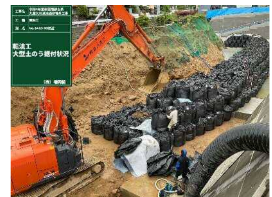
左岸下流側ブロック天端・仮締切施工中)
