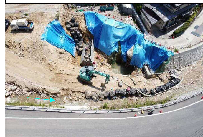
1号床固工、1号垂直壁、1号帯工施工中
