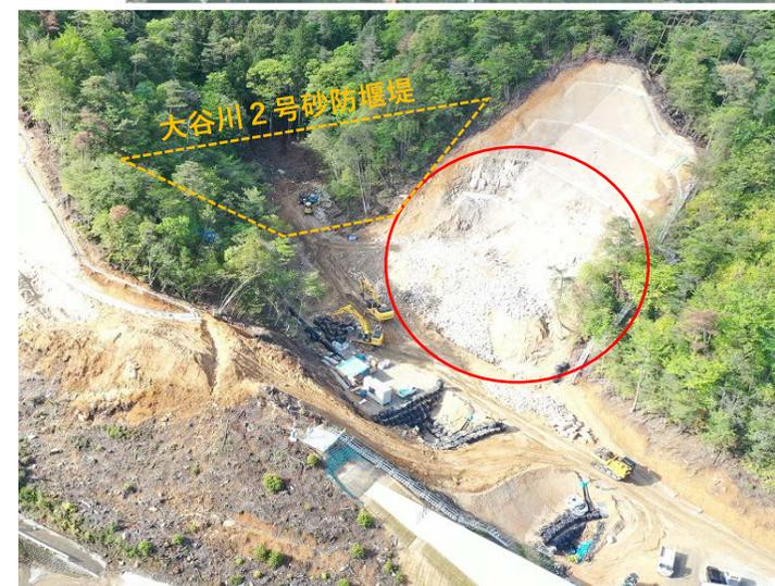
管理用道路（法面掘削）施工状況
