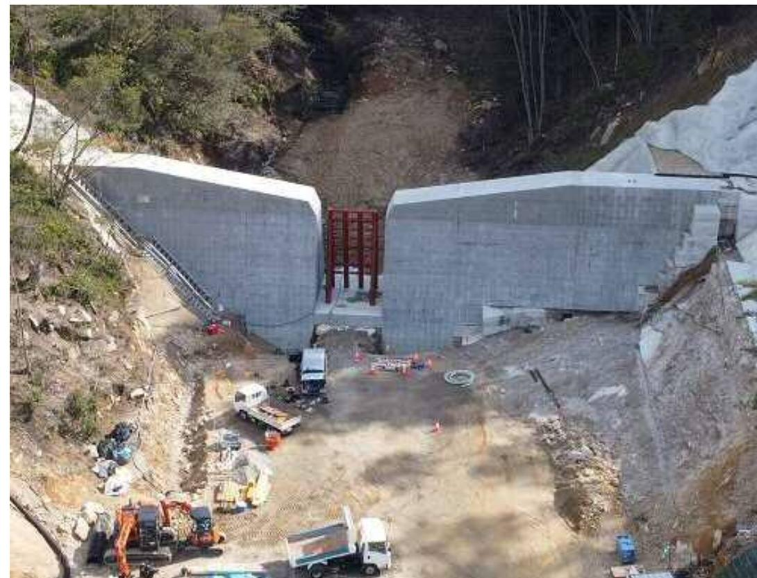
【大谷川 2号砂防堰堤・鋼製スリット完成】
