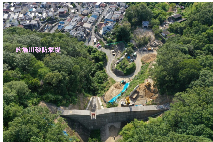
砂防堰堤全景（上流側より）
