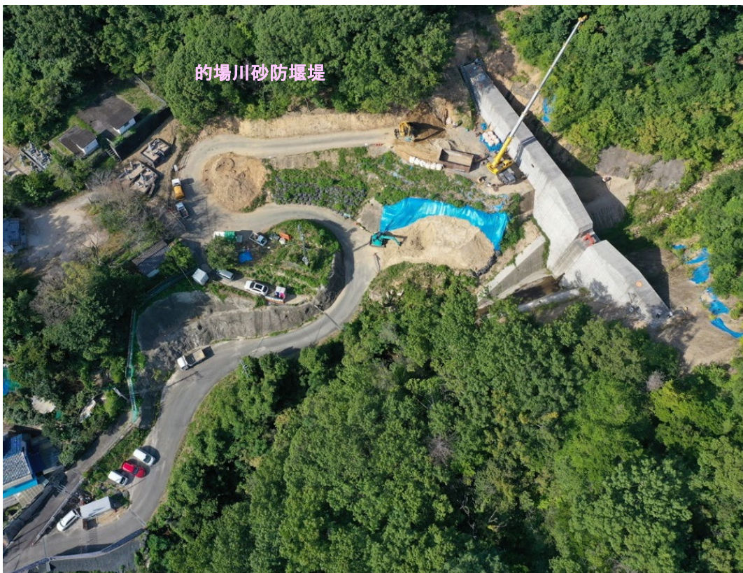
砂防堰堤全景（下流側より）
