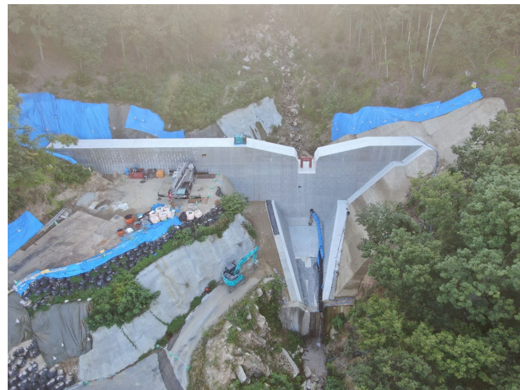
前庭保護工施工状況
