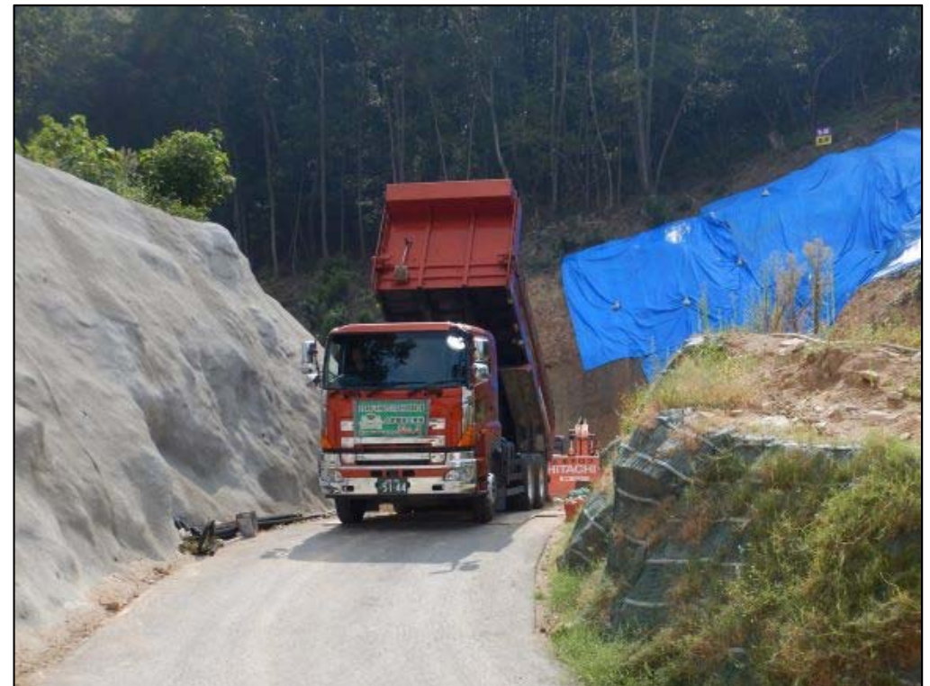
ソイルセメント搬入状況
