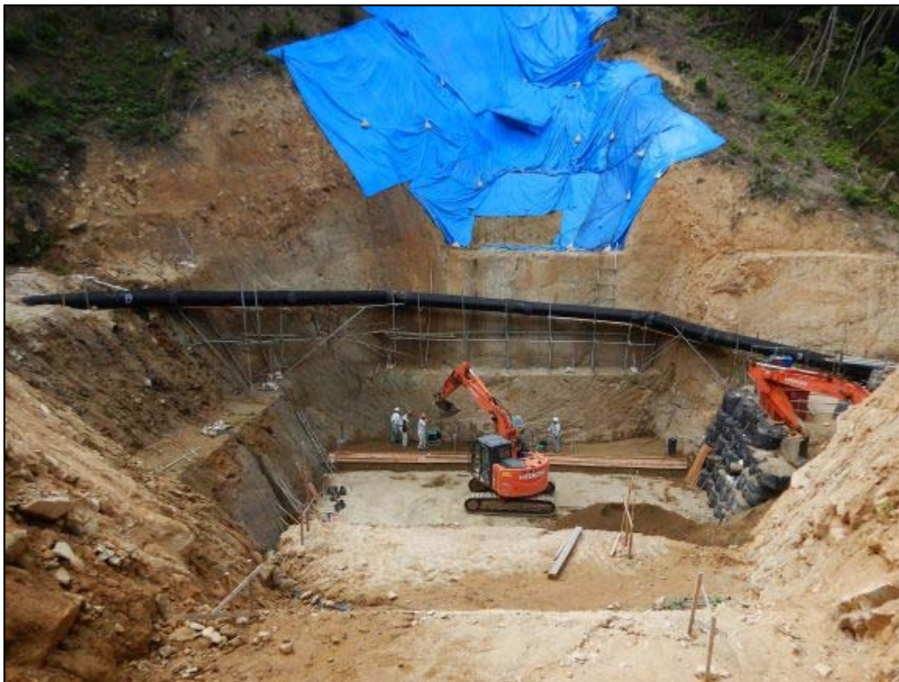
基礎部施工状況
