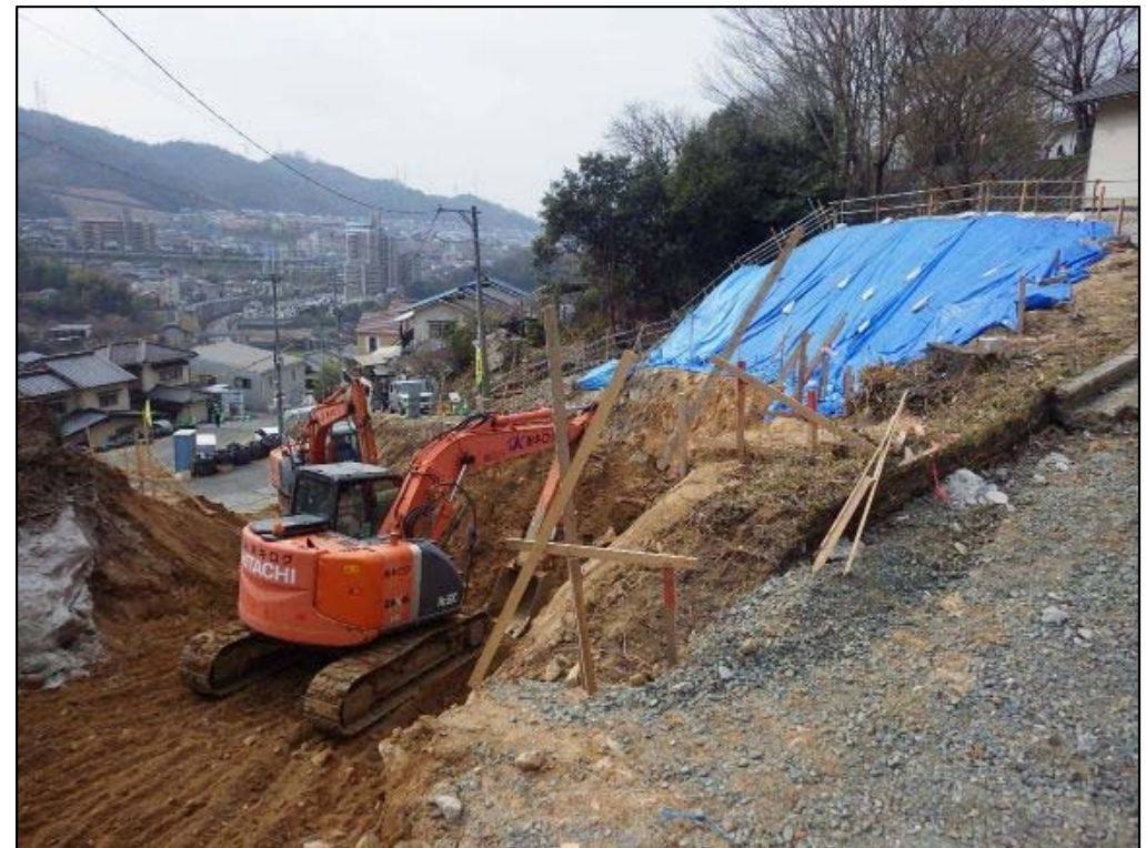
施工状況②
