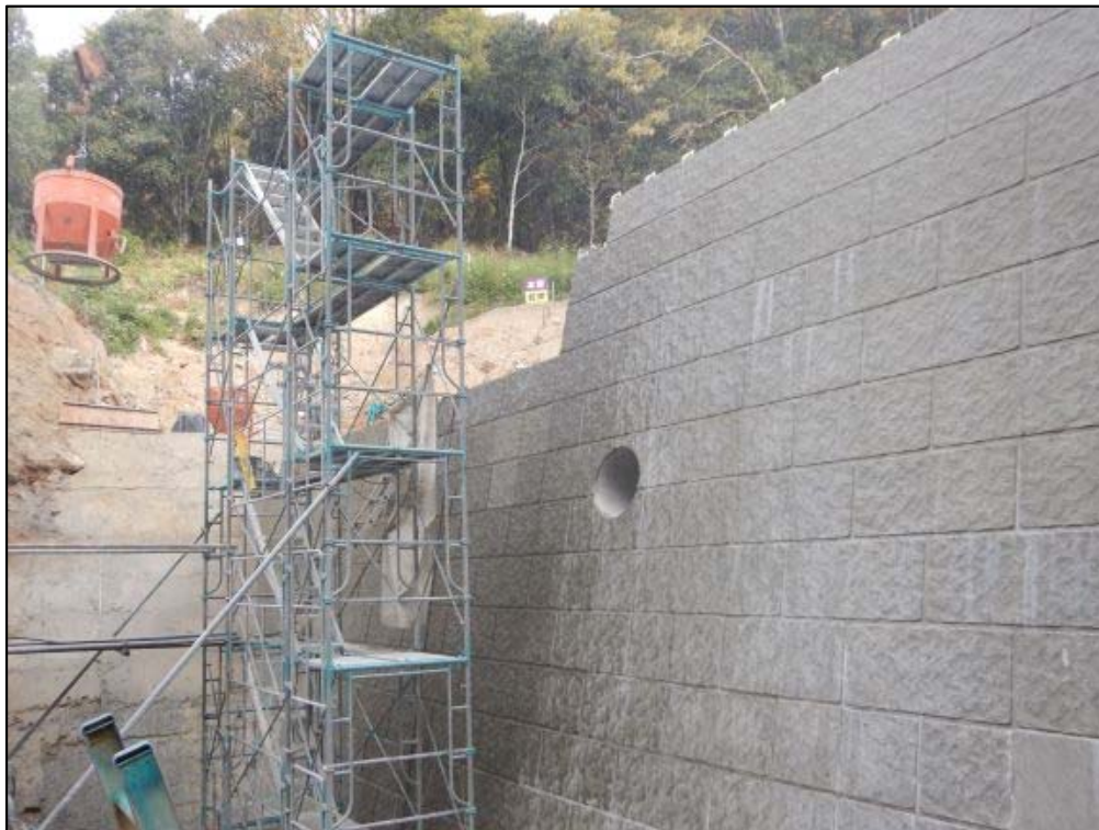
コンクリート打設状況①
