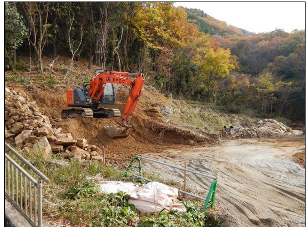
施工状況②
