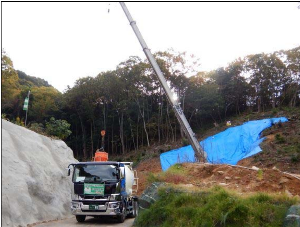
コンクリート打設状況①
