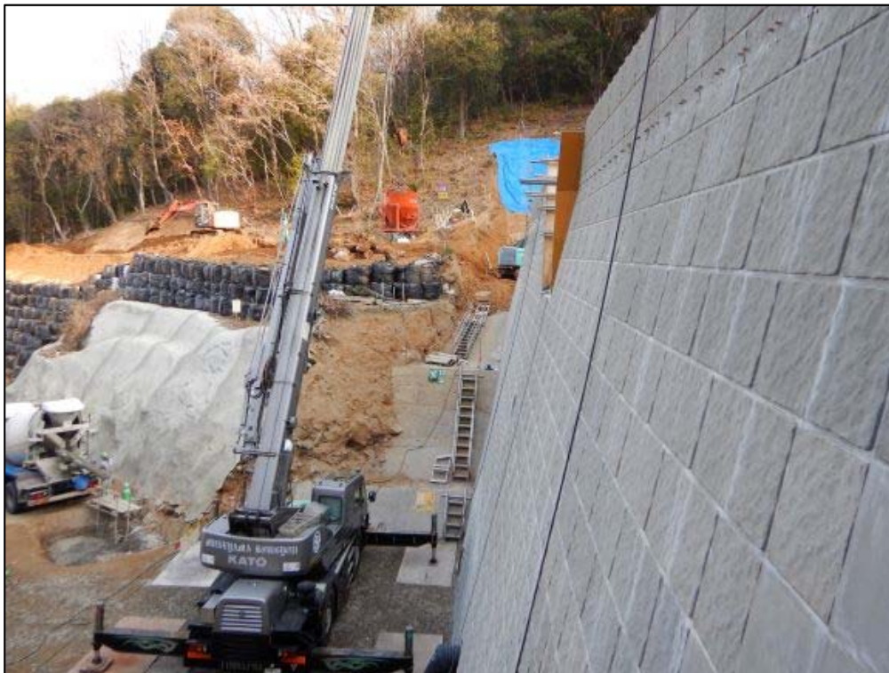
コンクリート打設状況①
