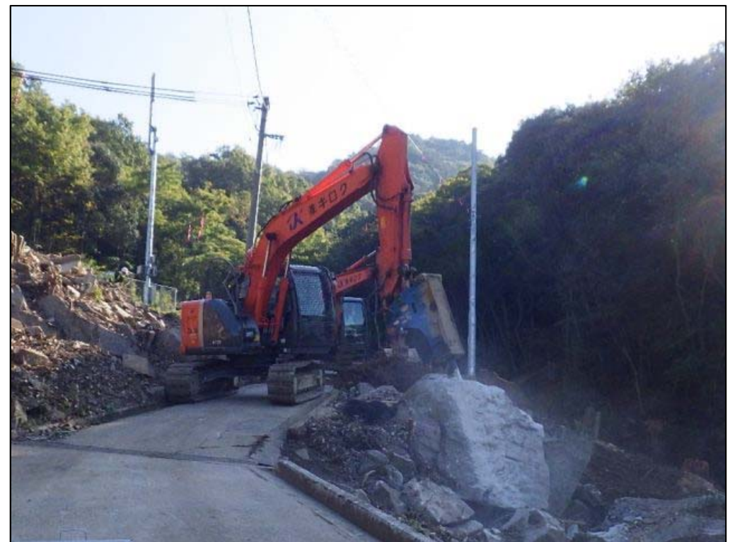
施工状況②
