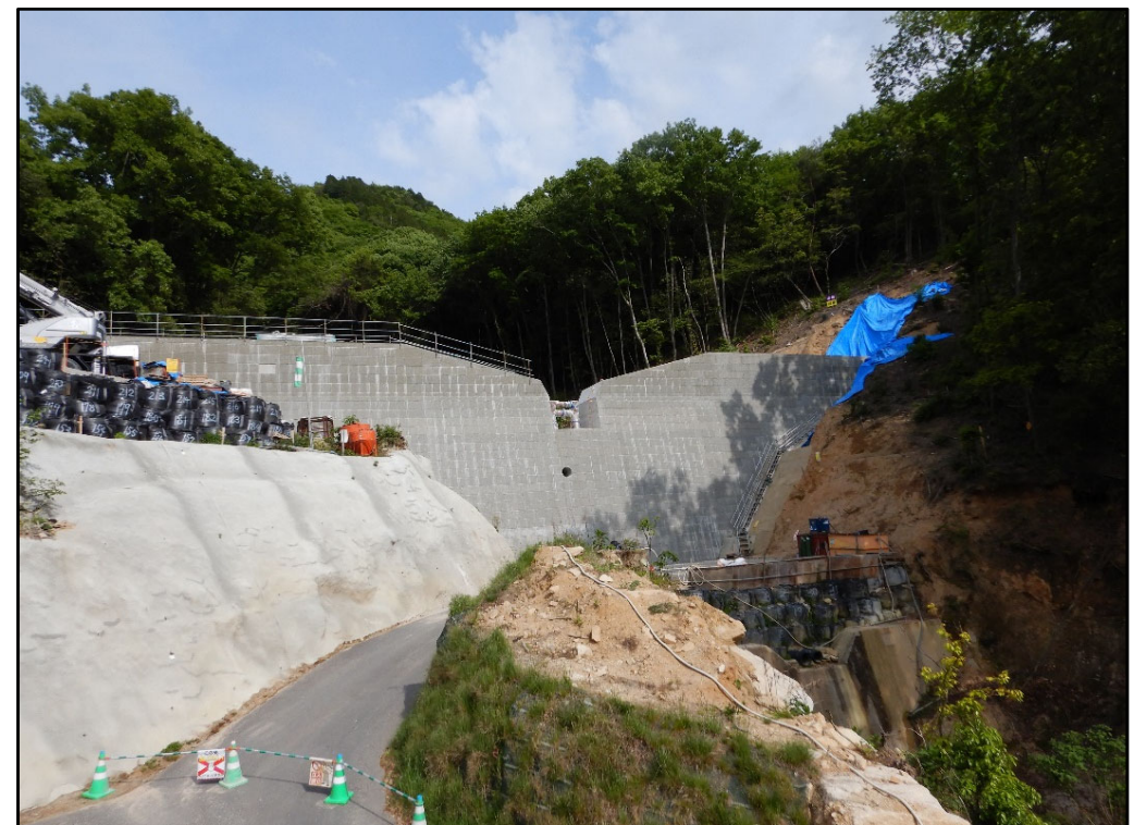
施工状況②
