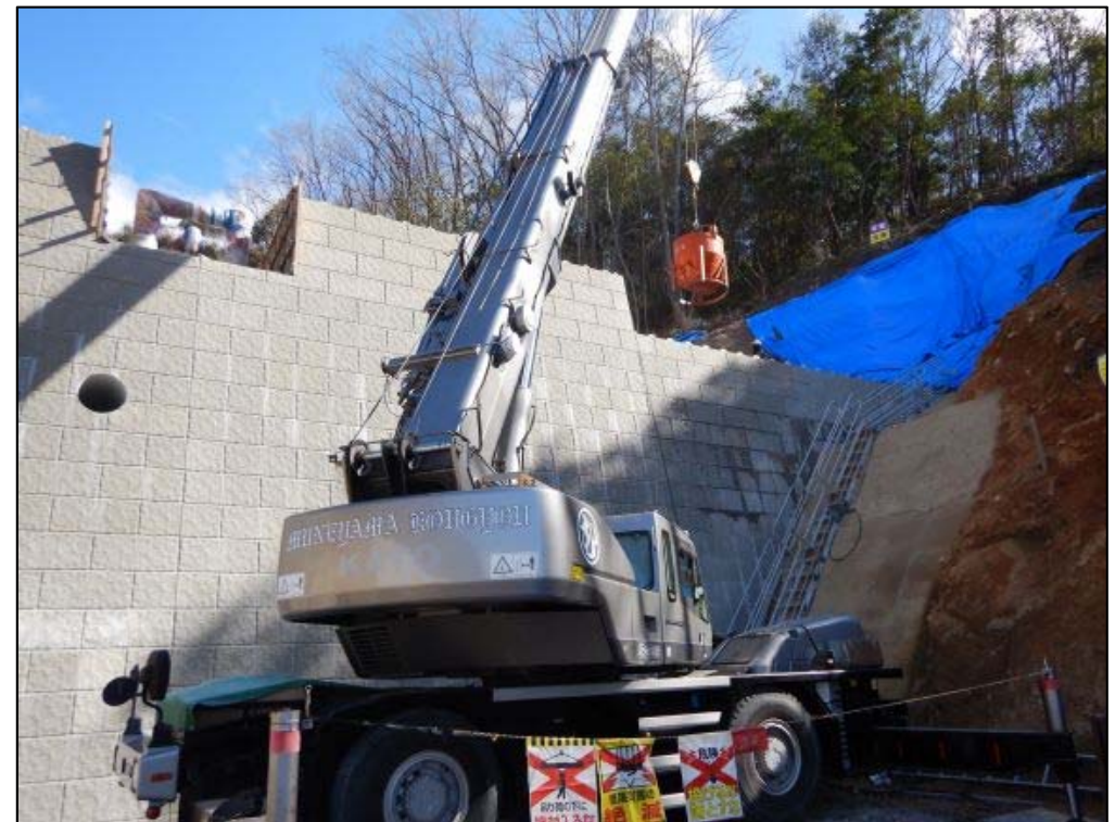
コンクリート打設状況
