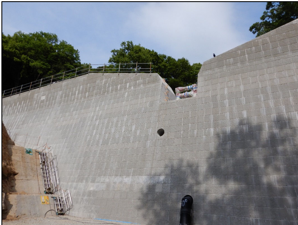
施工状況①
