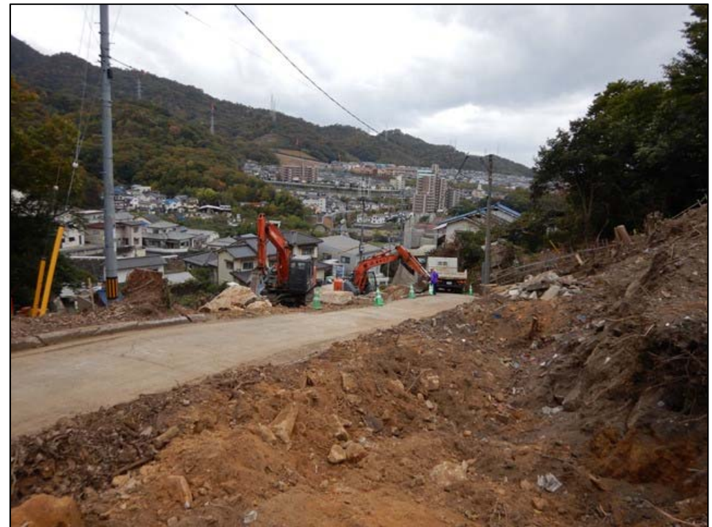
施工状況②
