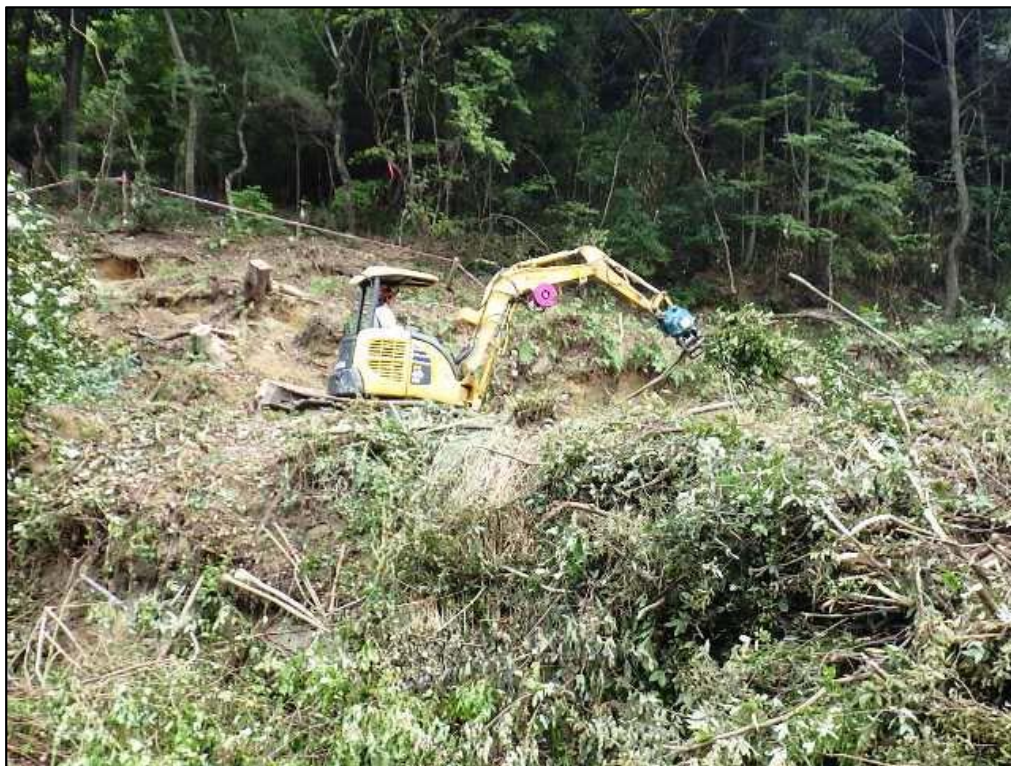
伐採作業状況①
