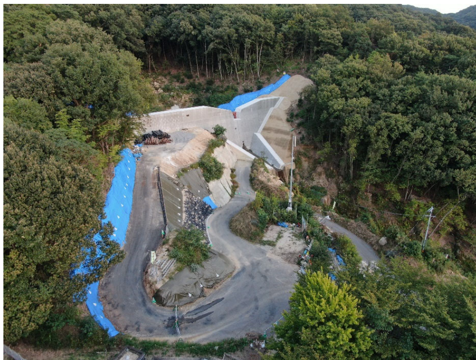
砂防堰堤全景（下流側より）
