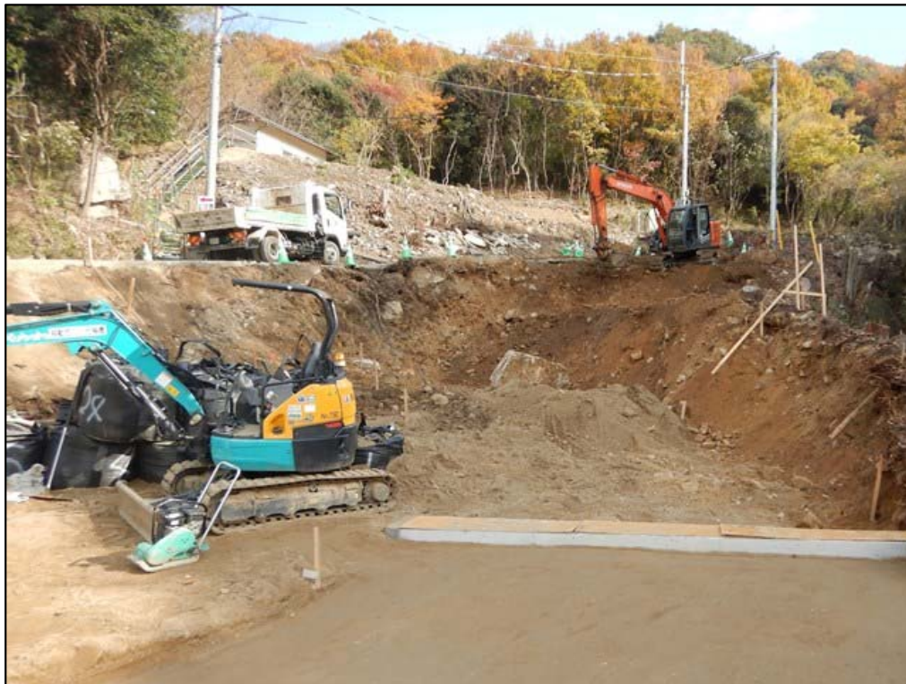
施工状況①
