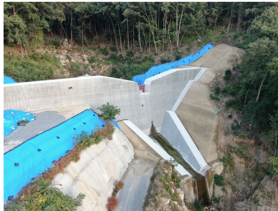
砂防堰堤（下流側より）
