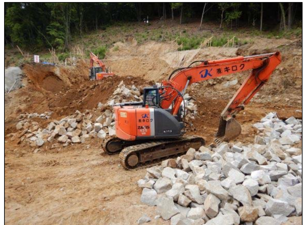
掘削作業状況②
