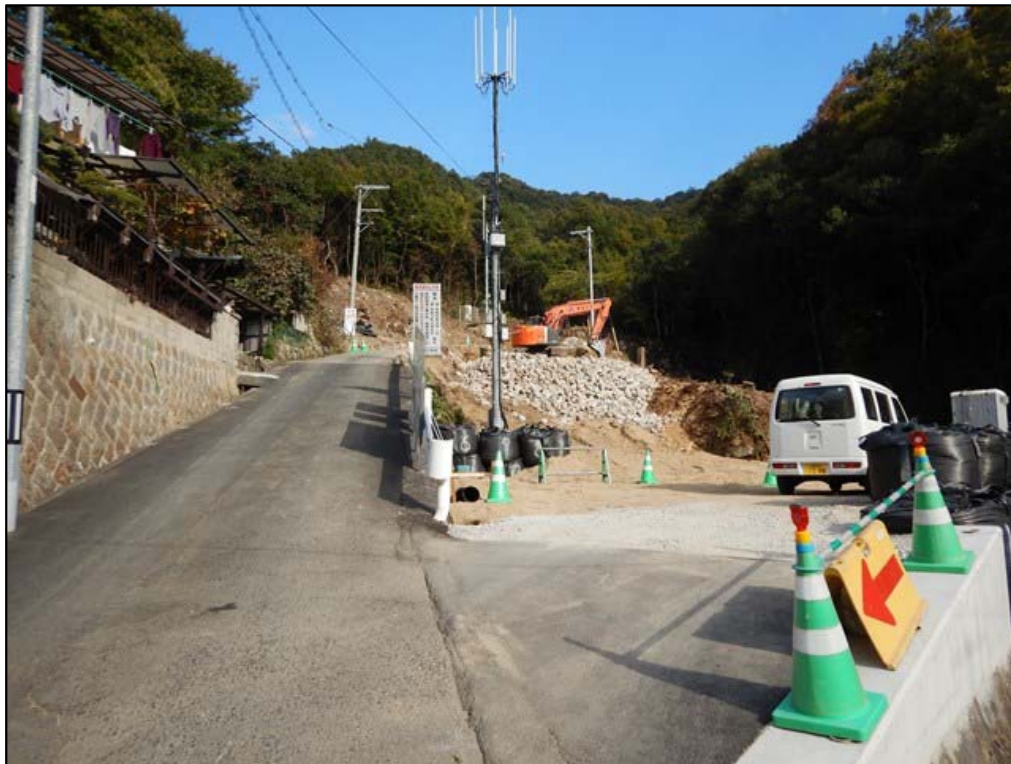
施工状況①
