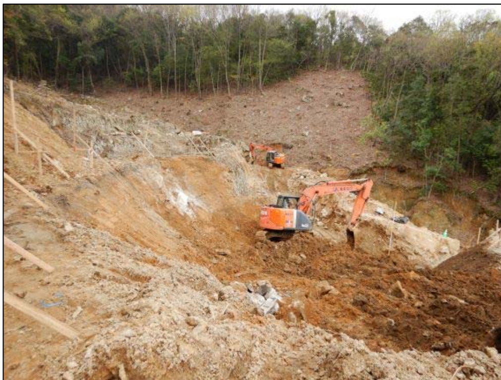
施工状況①
