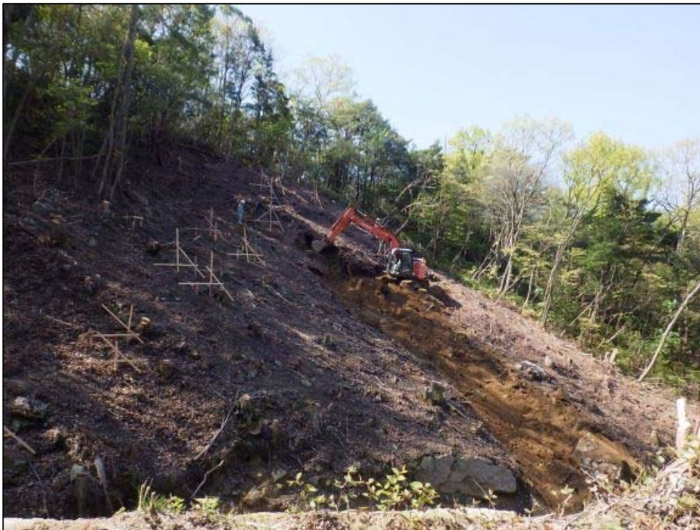
掘削作業状況
