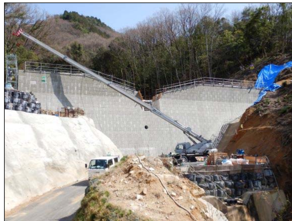
施工状況②
