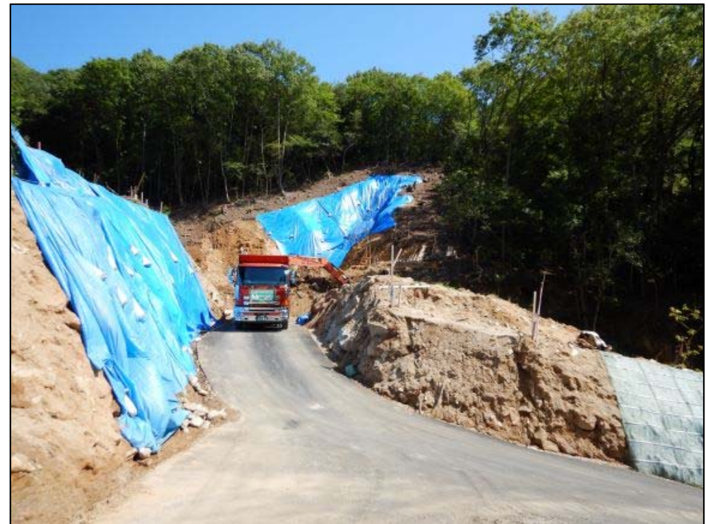
掘削土砂搬出状況
