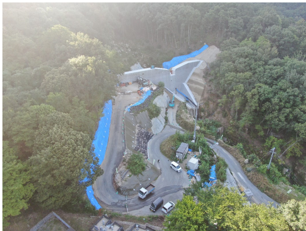
砂防堰堤全景
