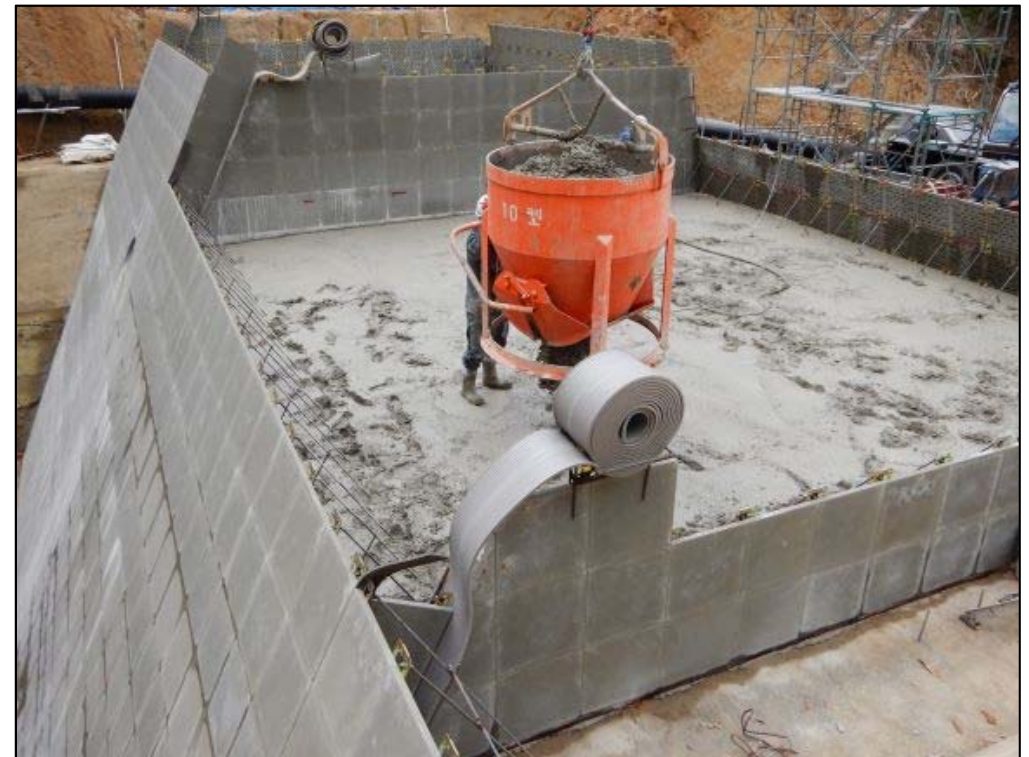
コンクリート打設状況②
