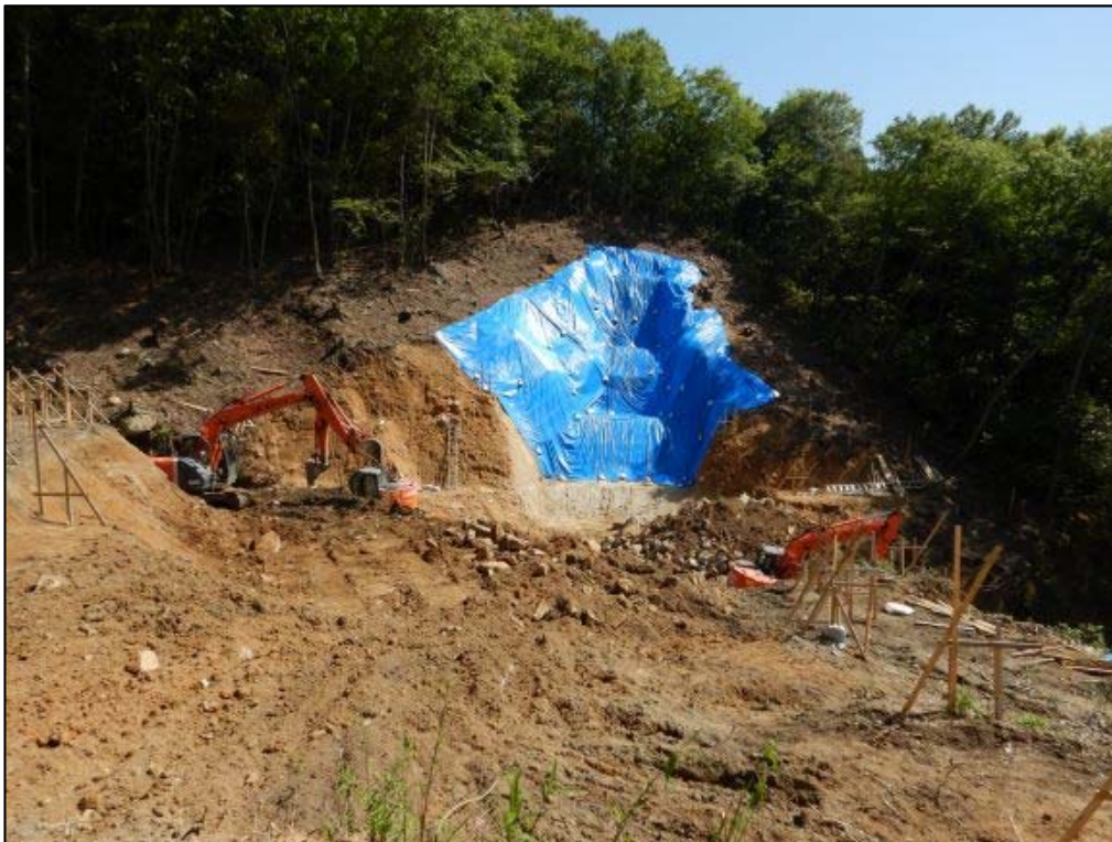
掘削作業状況
