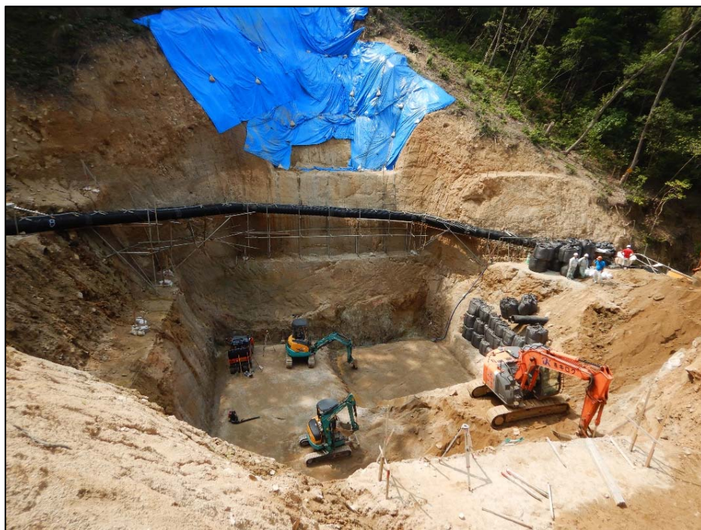
掘削作業状況
