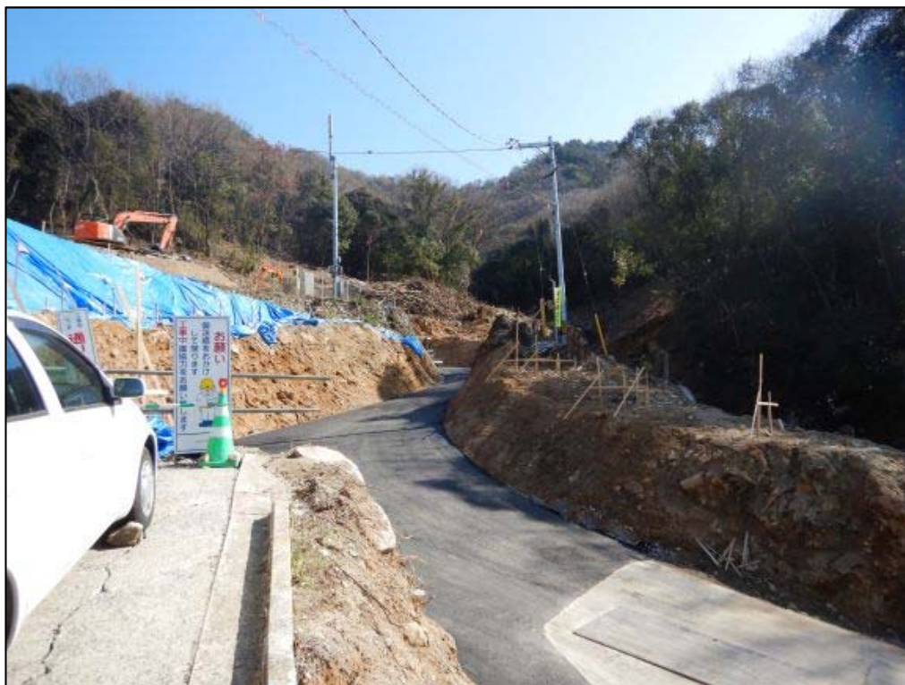
施工状況①
