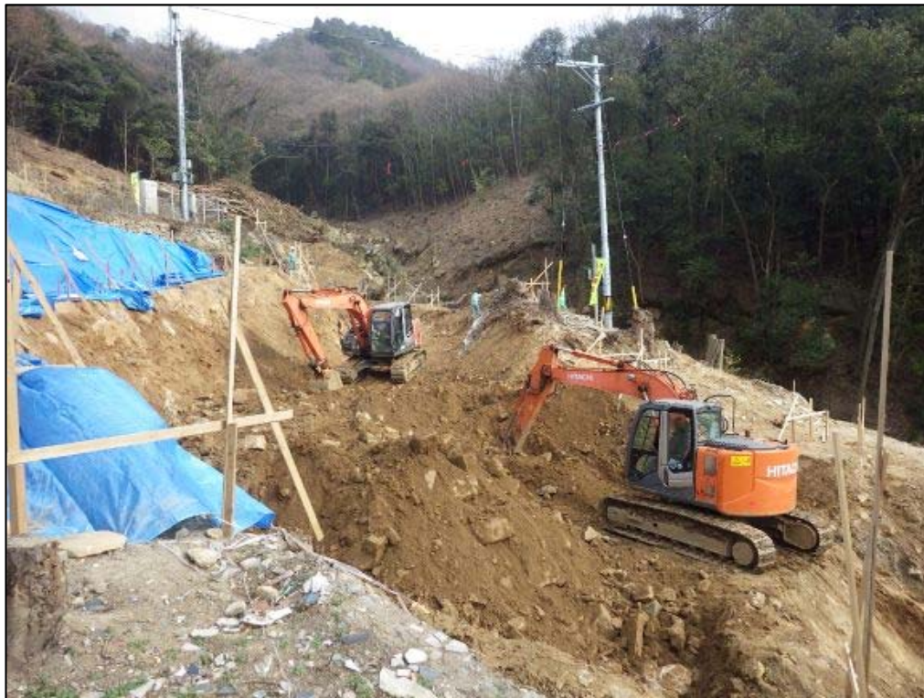
施工状況①
