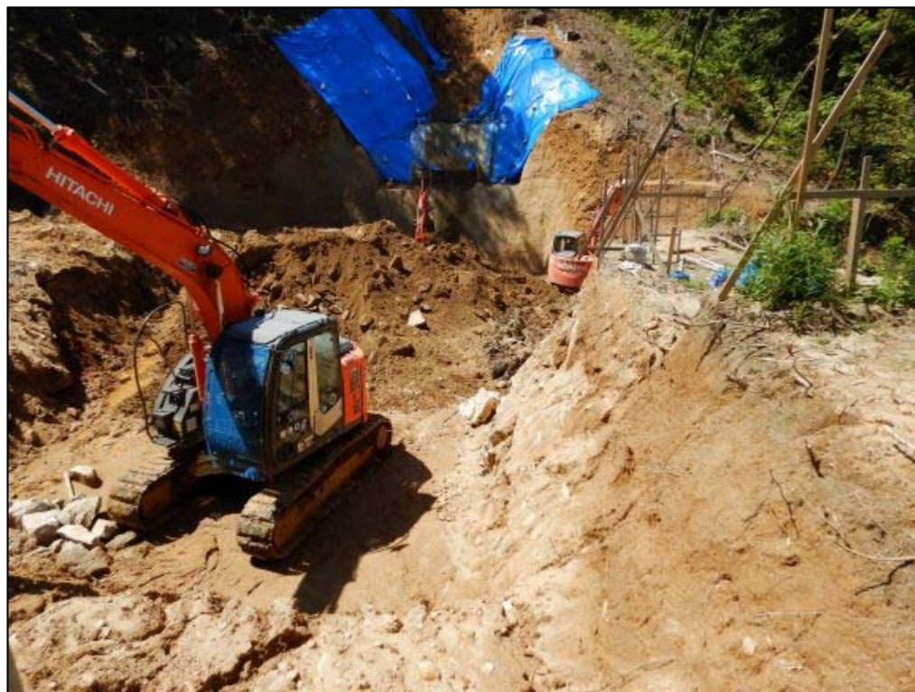
掘削作業状況①
