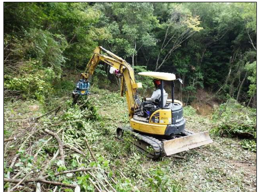
伐採作業状況②
