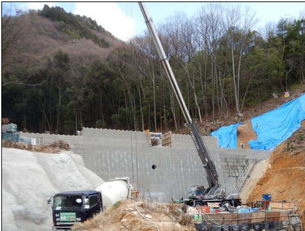
砂防堰堤施工状況
