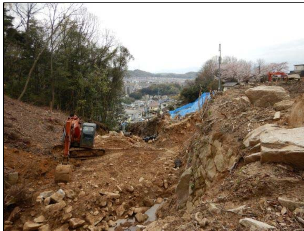
施工状況②
