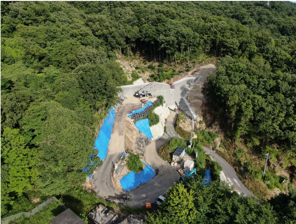
砂防堰堤全景
