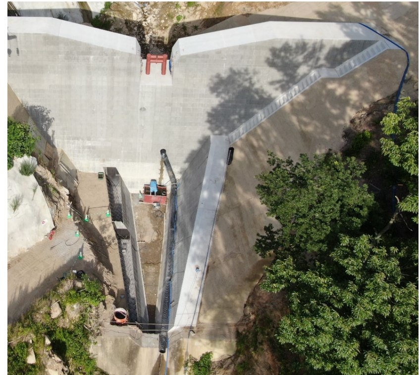
前庭保護工施工状況
