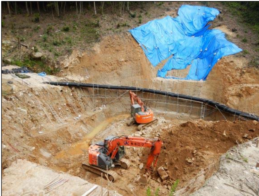
掘削作業状況
