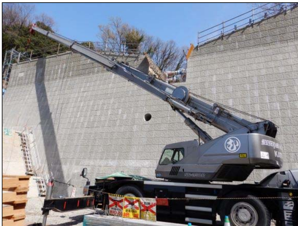
施工状況①
