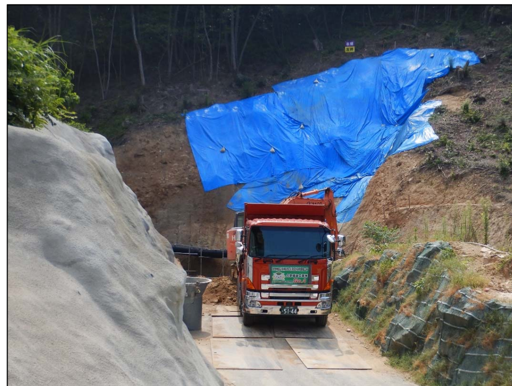
掘削土砂搬出状況
