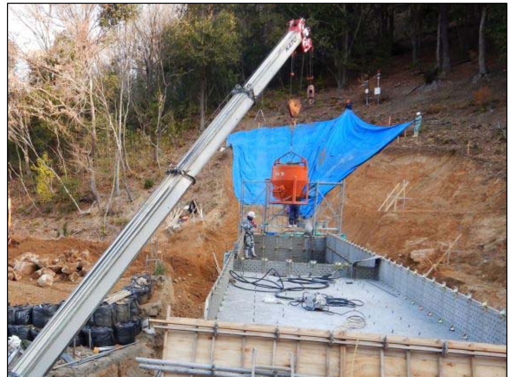
コンクリート打設状況②
