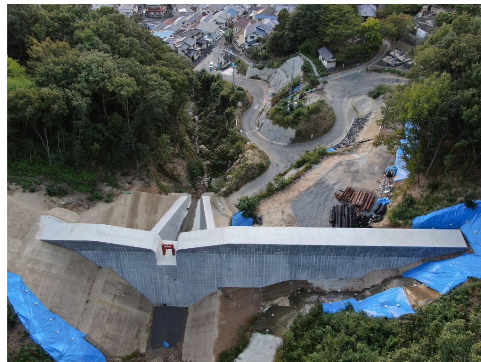
砂防堰堤全景（上流側より）
