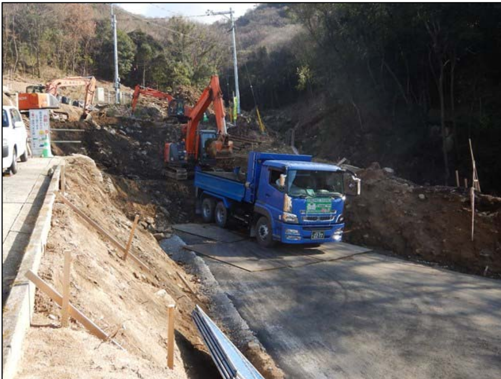
施工状況①
