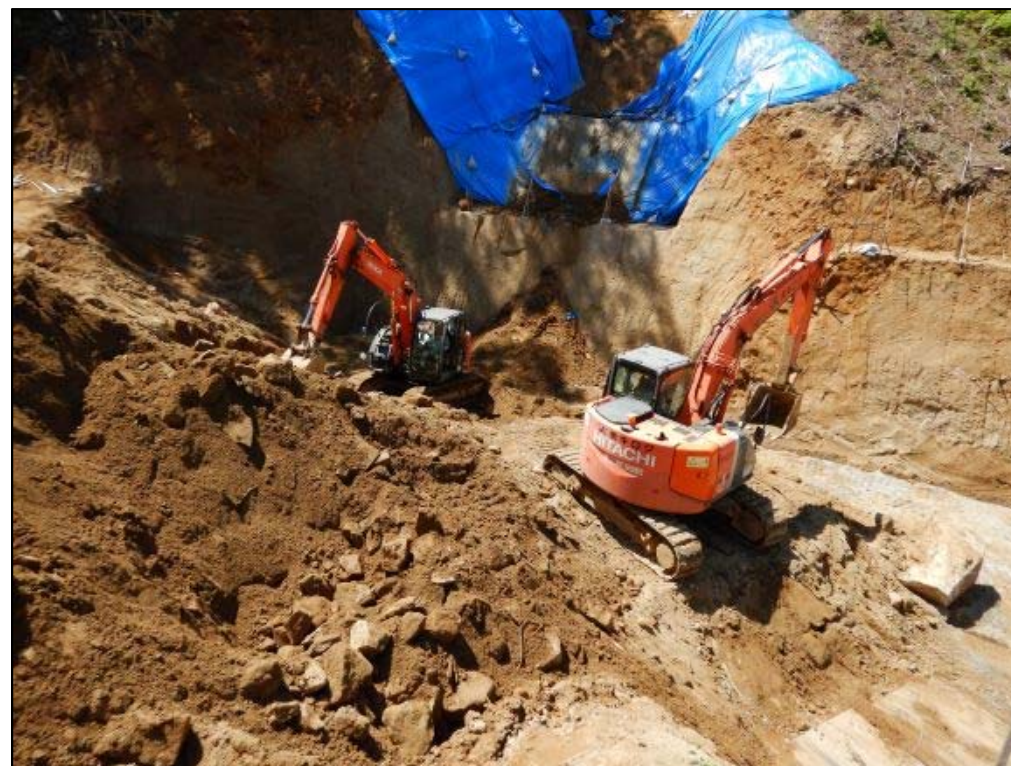
掘削作業状況②
