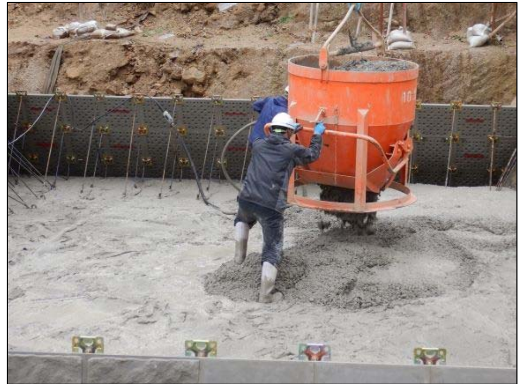
コンクリート打設状況②
