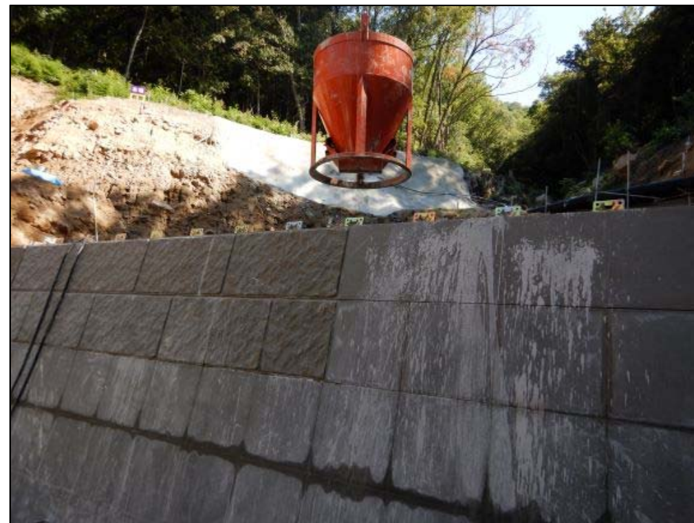
コンクリート打設状況②
