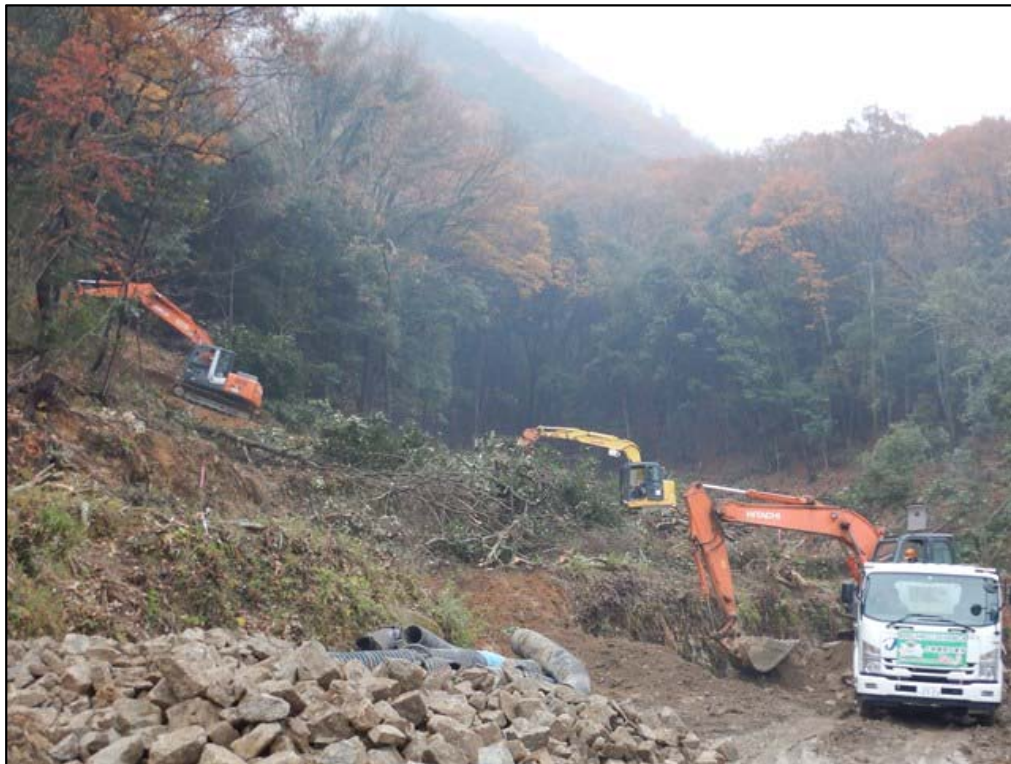
砂防堰堤箇所施工状況
