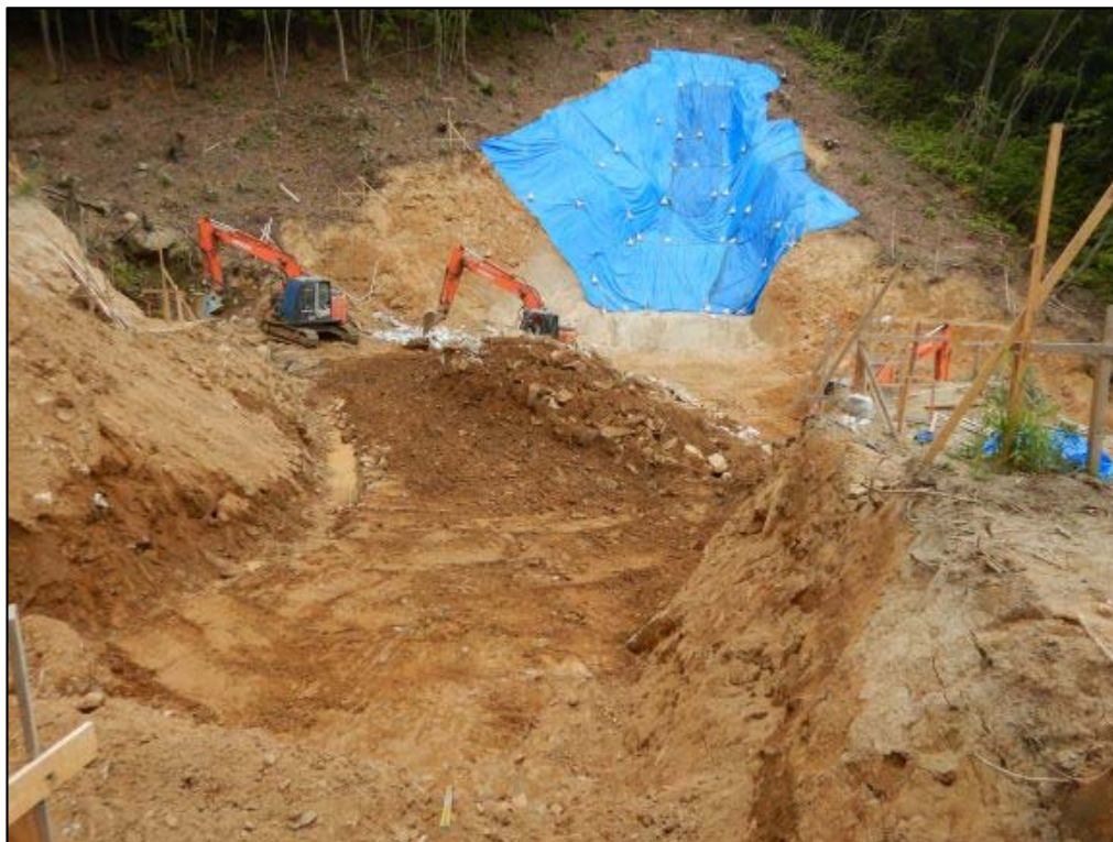
掘削作業状況①
