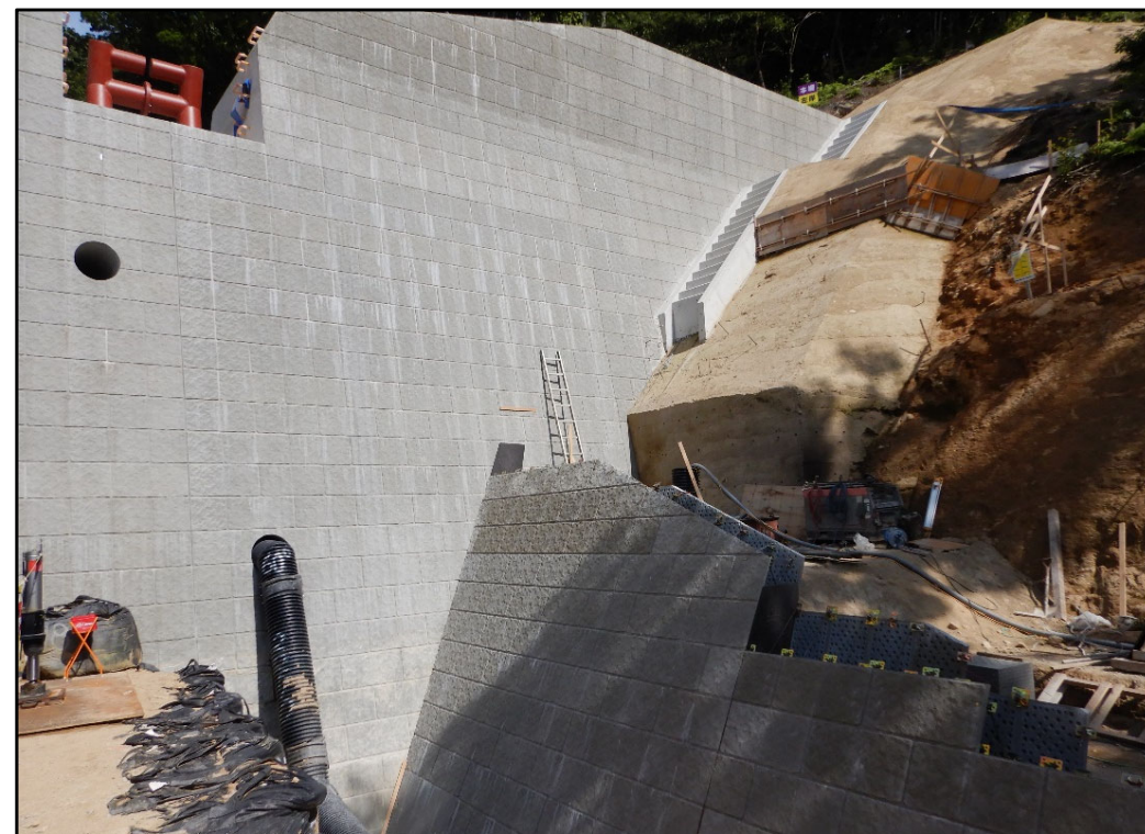
前庭保護工施工状況
