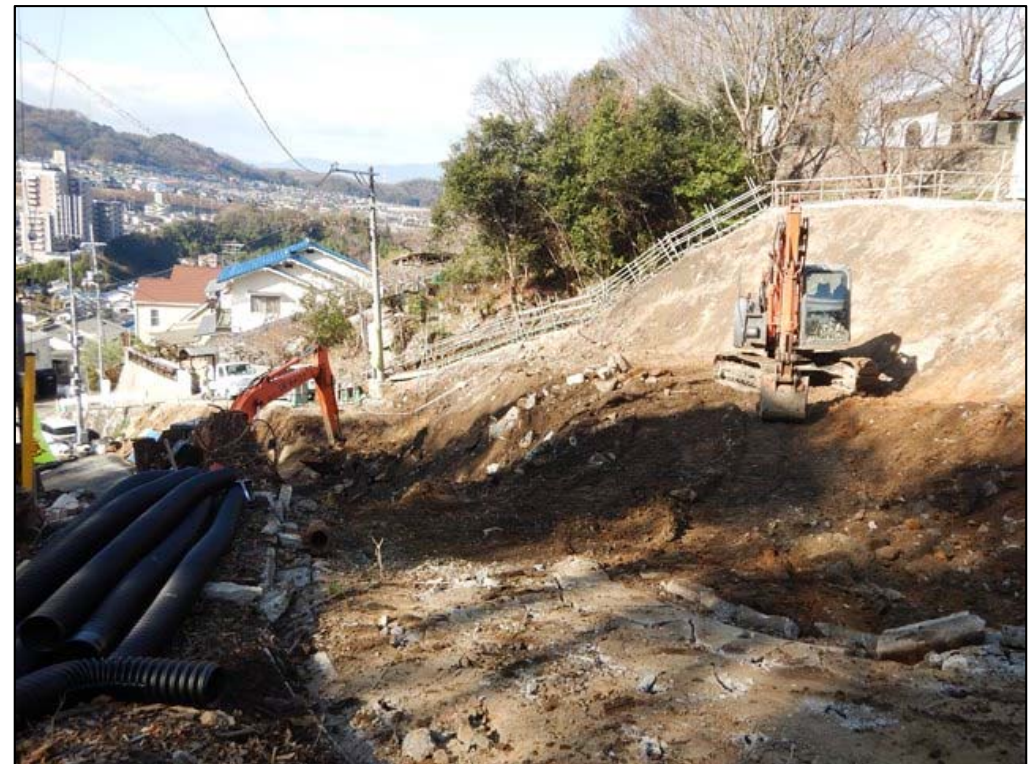
施工状況②
