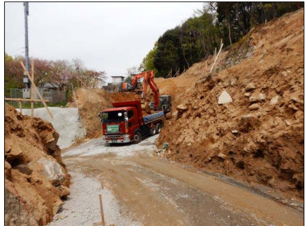
工事用道路施工状況
