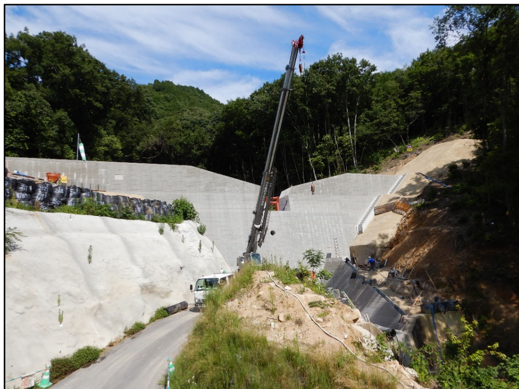
砂防堰堤全景
