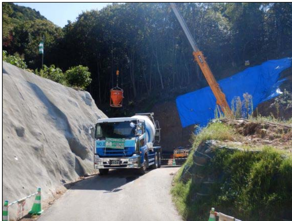
コンクリート打設状況①
