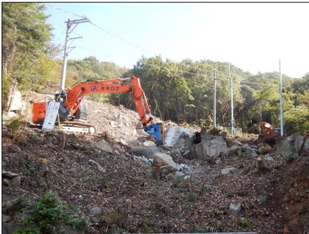
施工状況①
