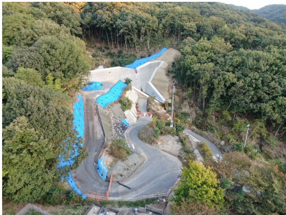
砂防堰堤全景（下流側より）
