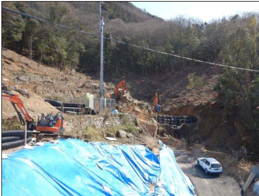
施工状況①
