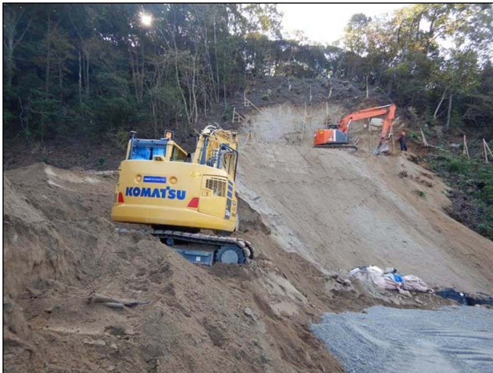
砂防堰堤の掘削状況
