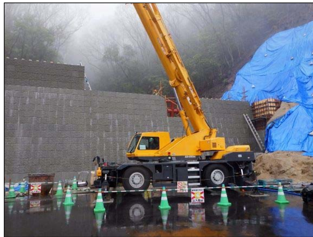
コンクリート打設状況②
