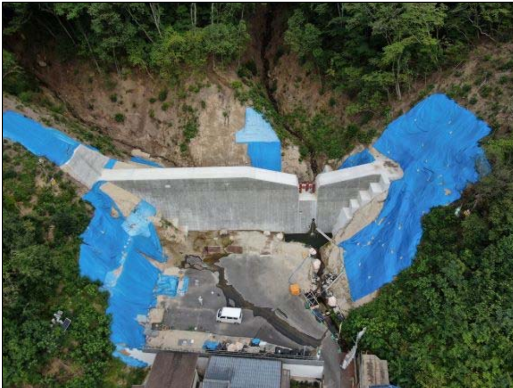
現地状況（下流側より）
