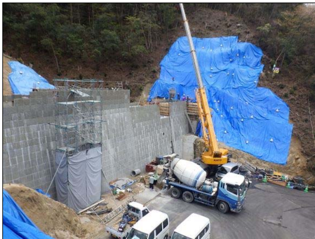
コンクリート打設状況①
