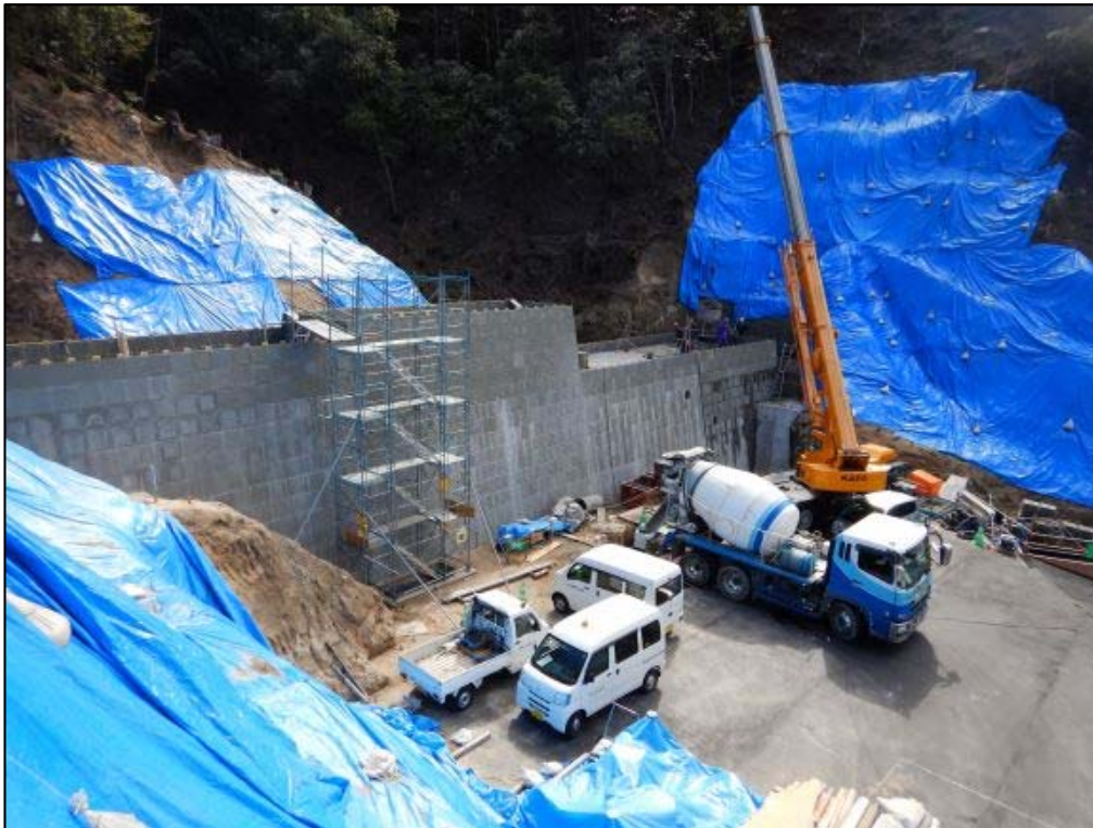
コンクリート打設状況①
