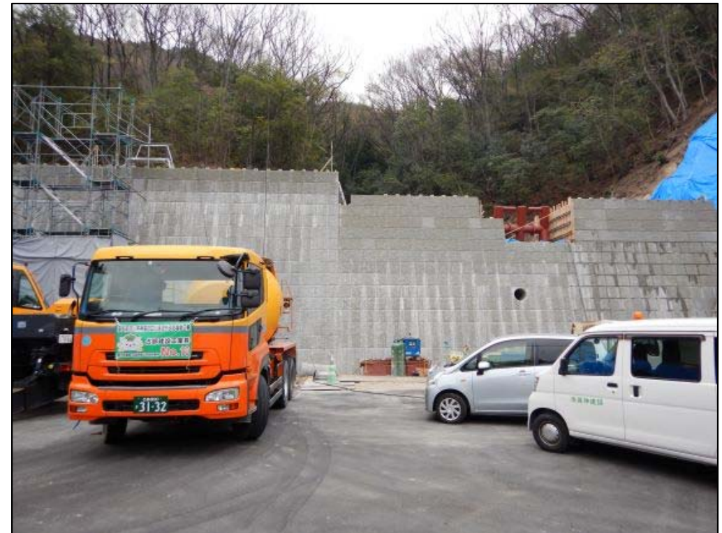
コンクリート打設状況②
