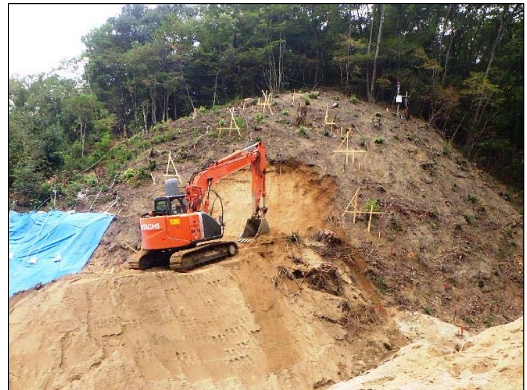
砂防堰堤の掘削状況②
