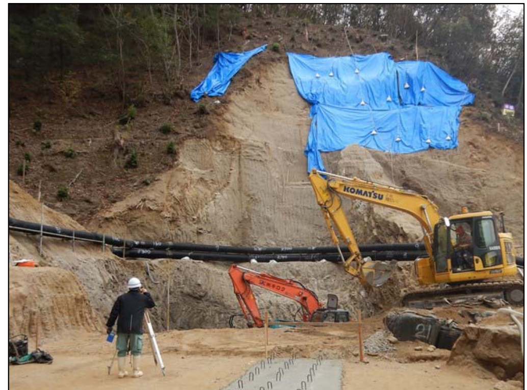
砂防堰堤の掘削状況②
