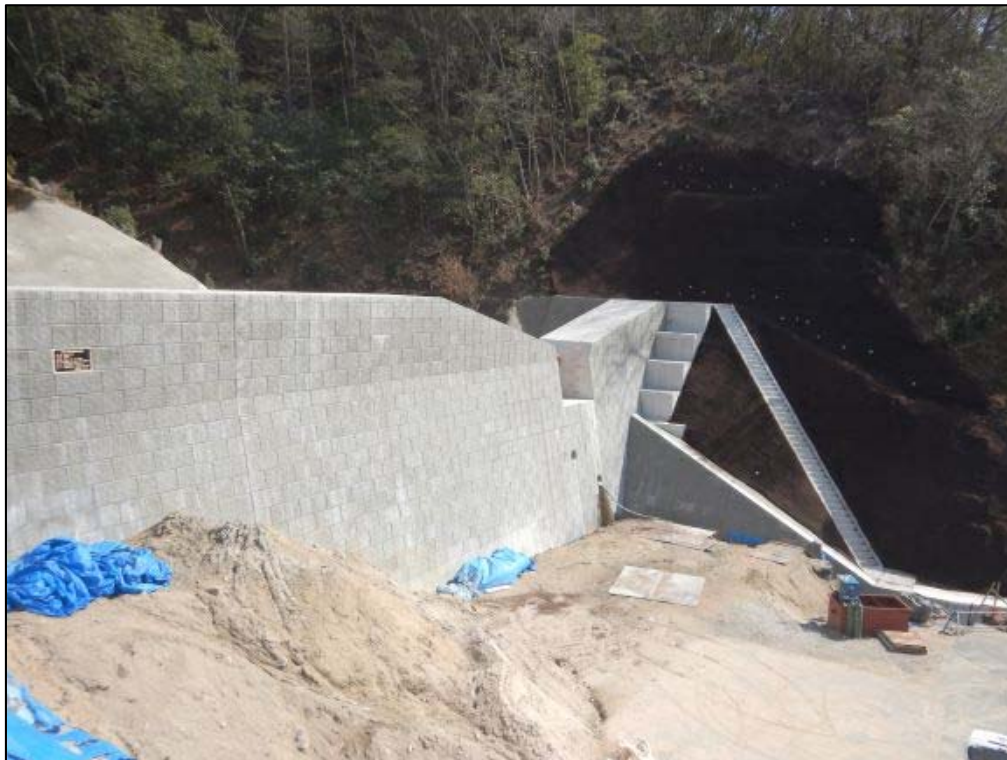
施工状況①
