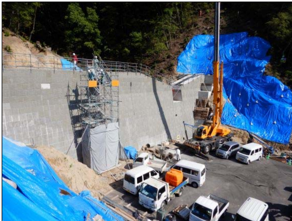
下流右岸側より
