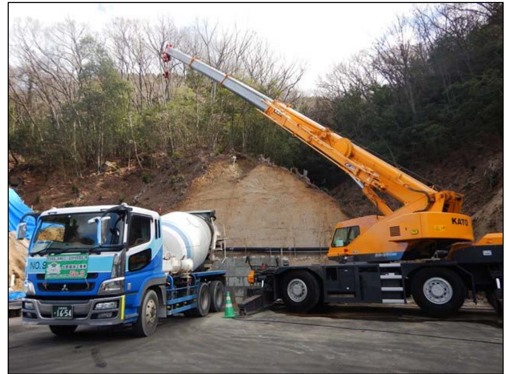
コンクリート打設状況②
