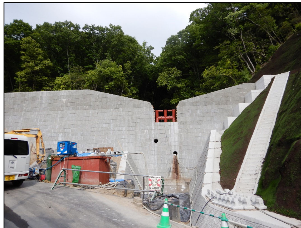
施工状況②
