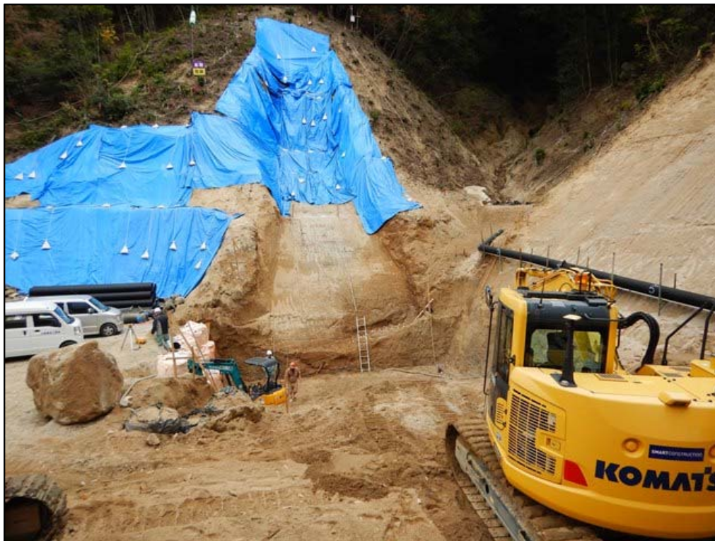
砂防堰堤の右岸掘削状況
