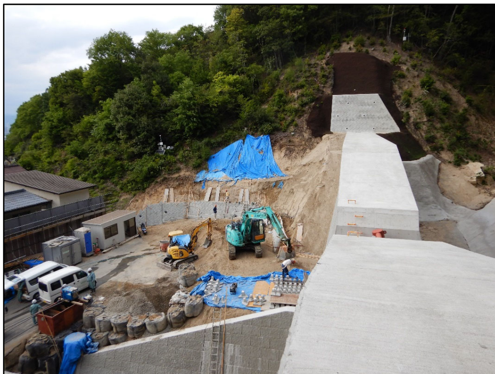
施工状況①
