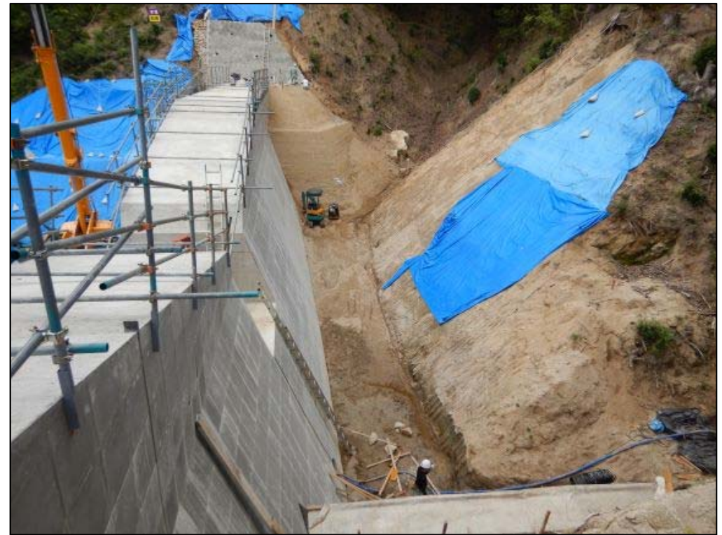
埋め戻し施工状況（右岸側）
