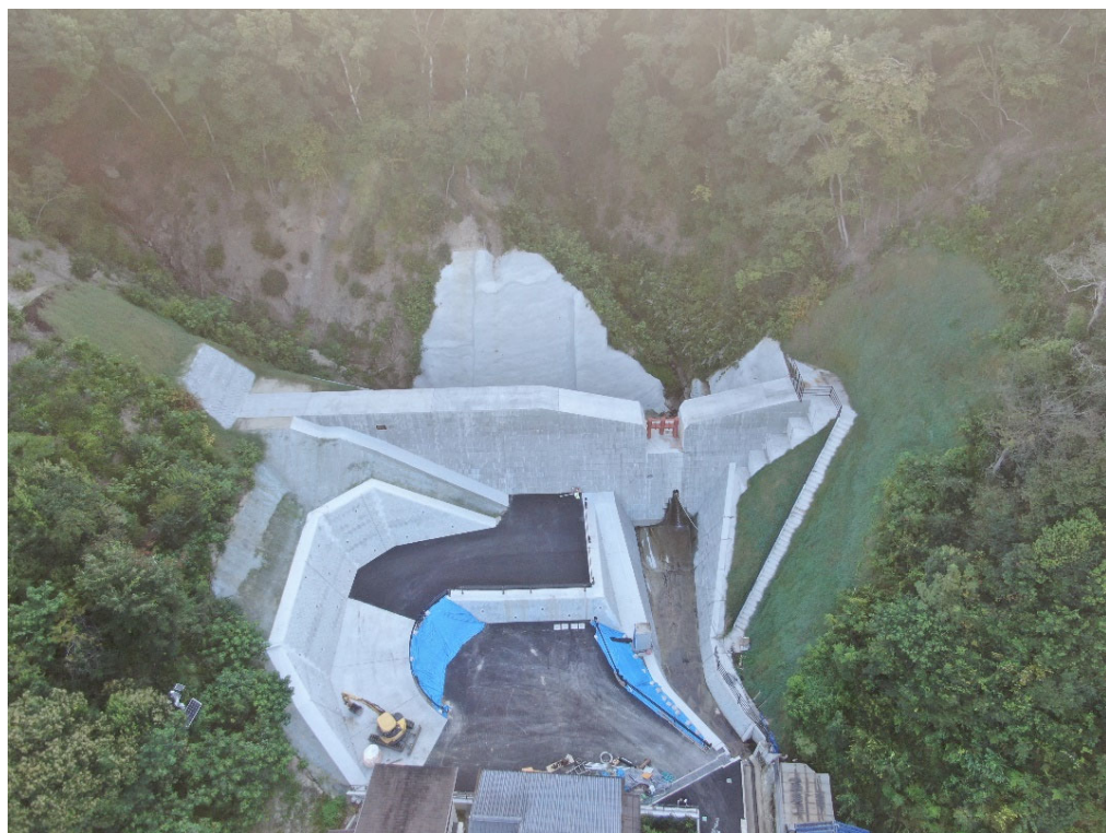
砂防堰堤全景（下流側より）
