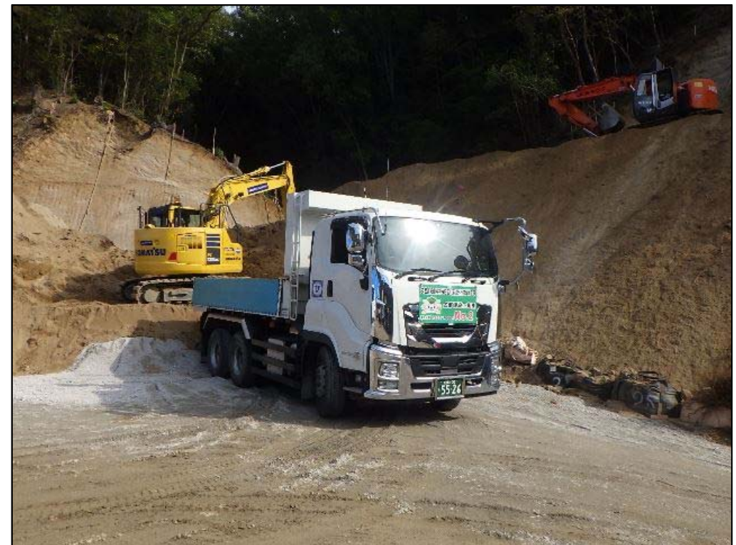
土砂搬出状況
