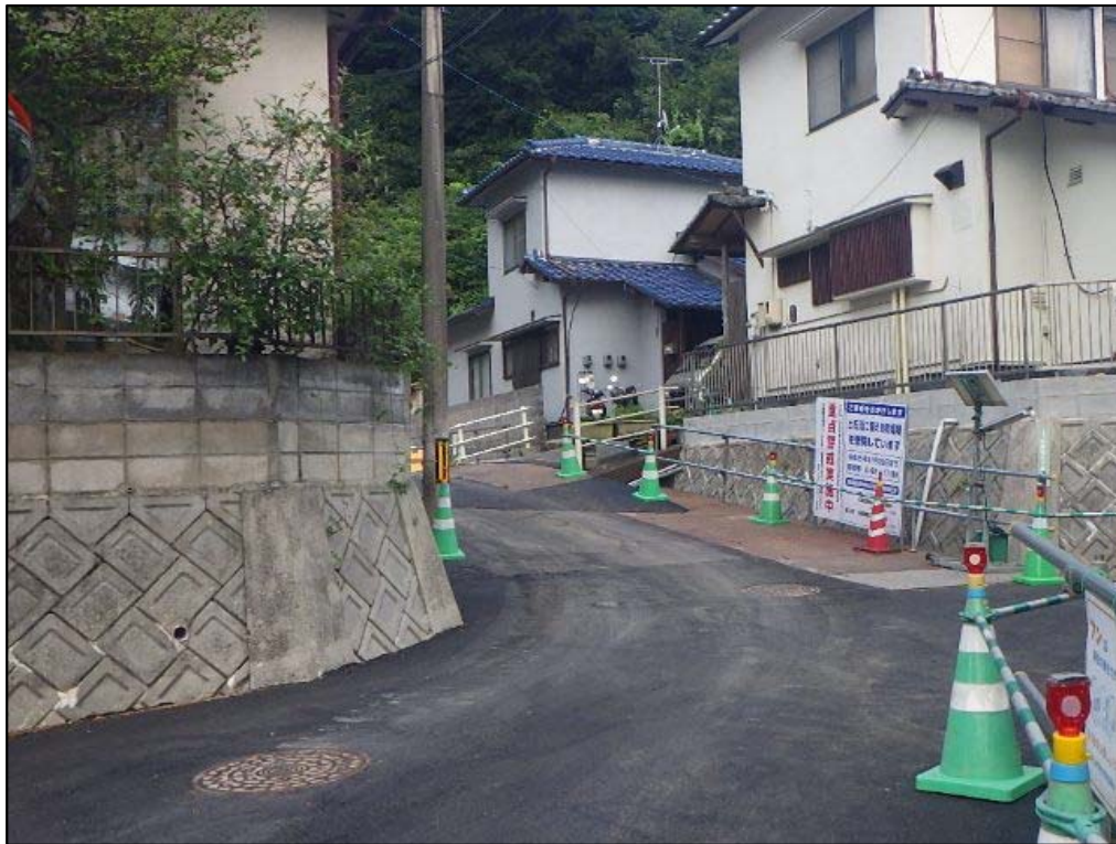
道路拡幅状況
