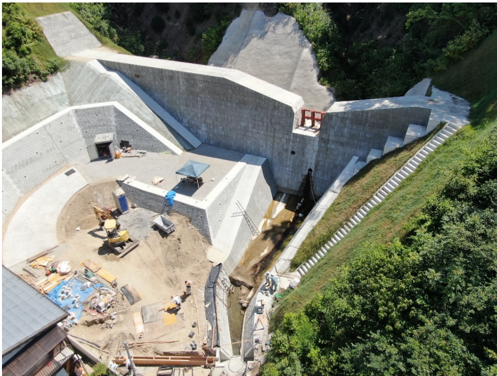
砂防堰堤全景
