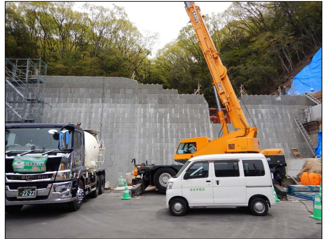
コンクリート打設状況②
