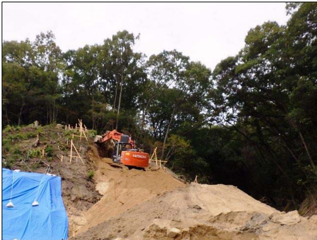
砂防堰堤の掘削状況①
