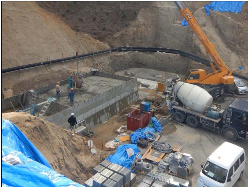
コンクリート打設状況①
