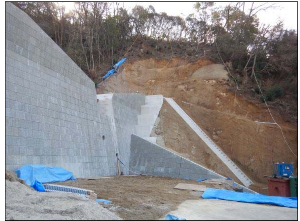
施工状況②
