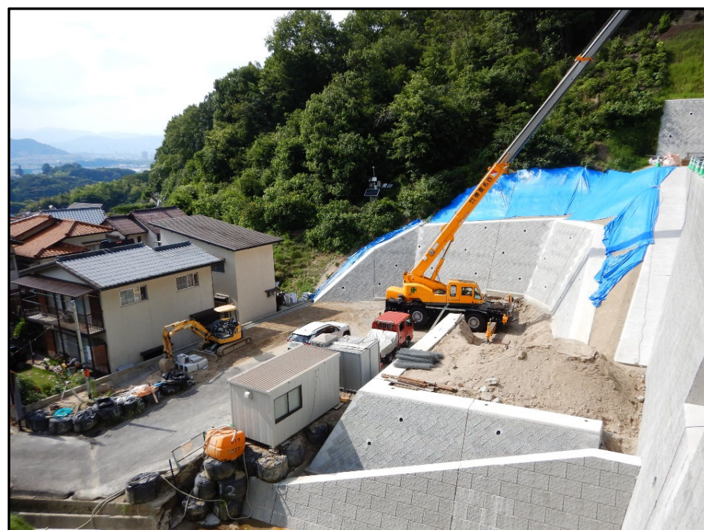
管理用道路施工状況
