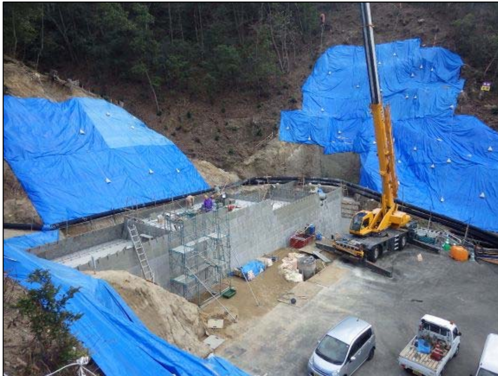
コンクリート打設状況①
