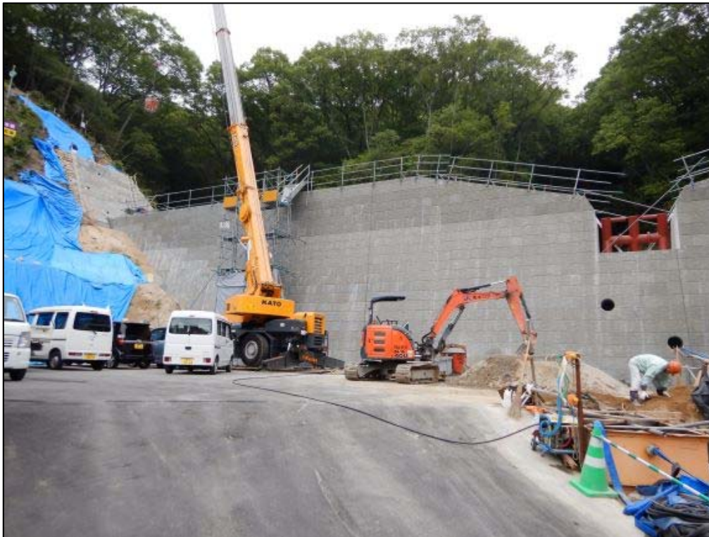
埋め戻し施工状況（下流側）
