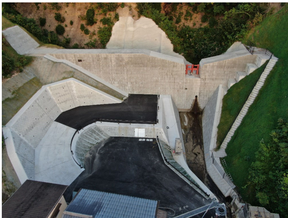
砂防堰堤全景（下流側より）
