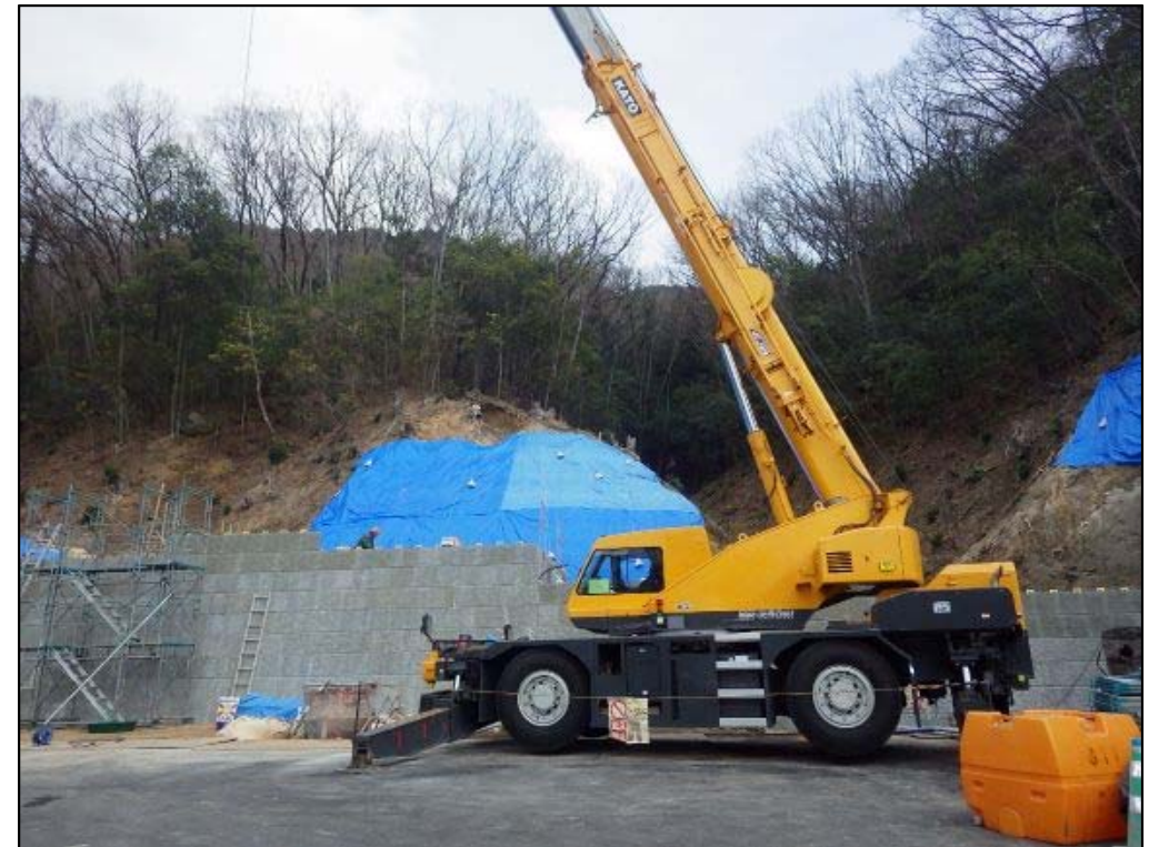
コンクリート打設状況②
