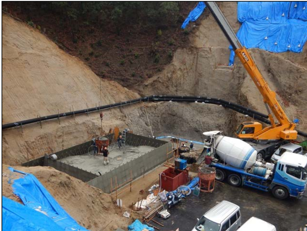
コンクリート打設状況①
