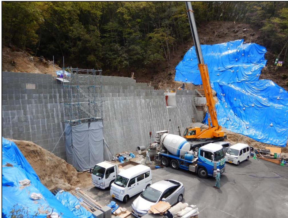
コンクリート打設状況①
