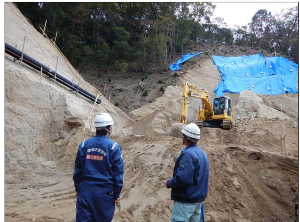
砂防堰堤の左岸掘削状況
