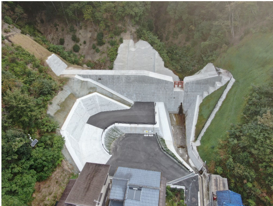
砂防堰堤全景（下流側より）
