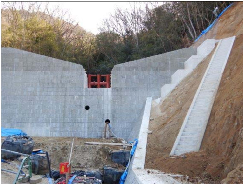
施工状況①
