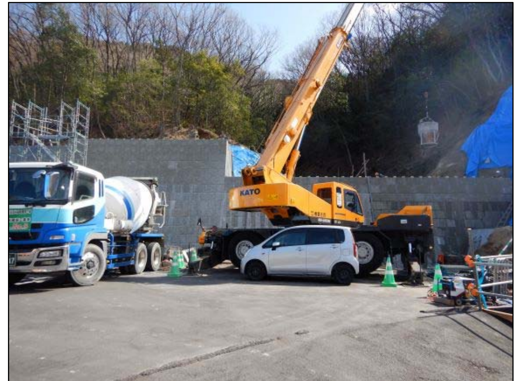
コンクリート打設状況②
