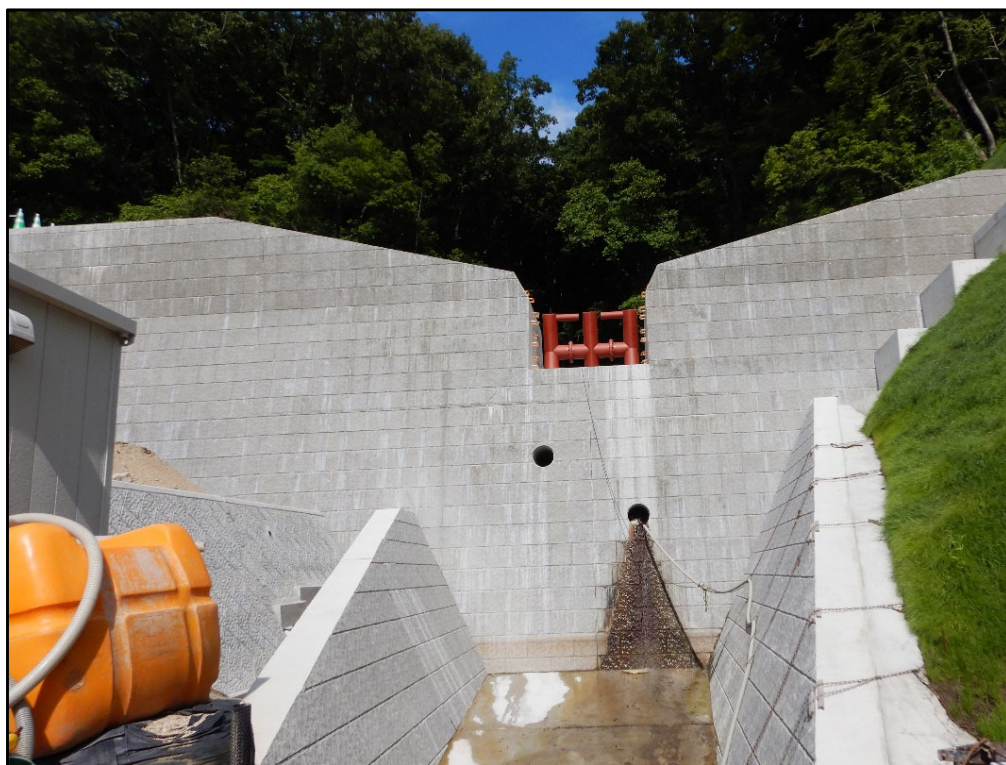
砂防堰堤全景
