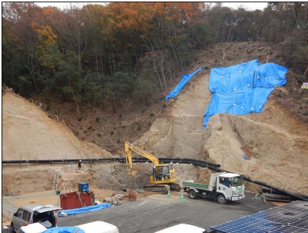
砂防堰堤の掘削状況①
