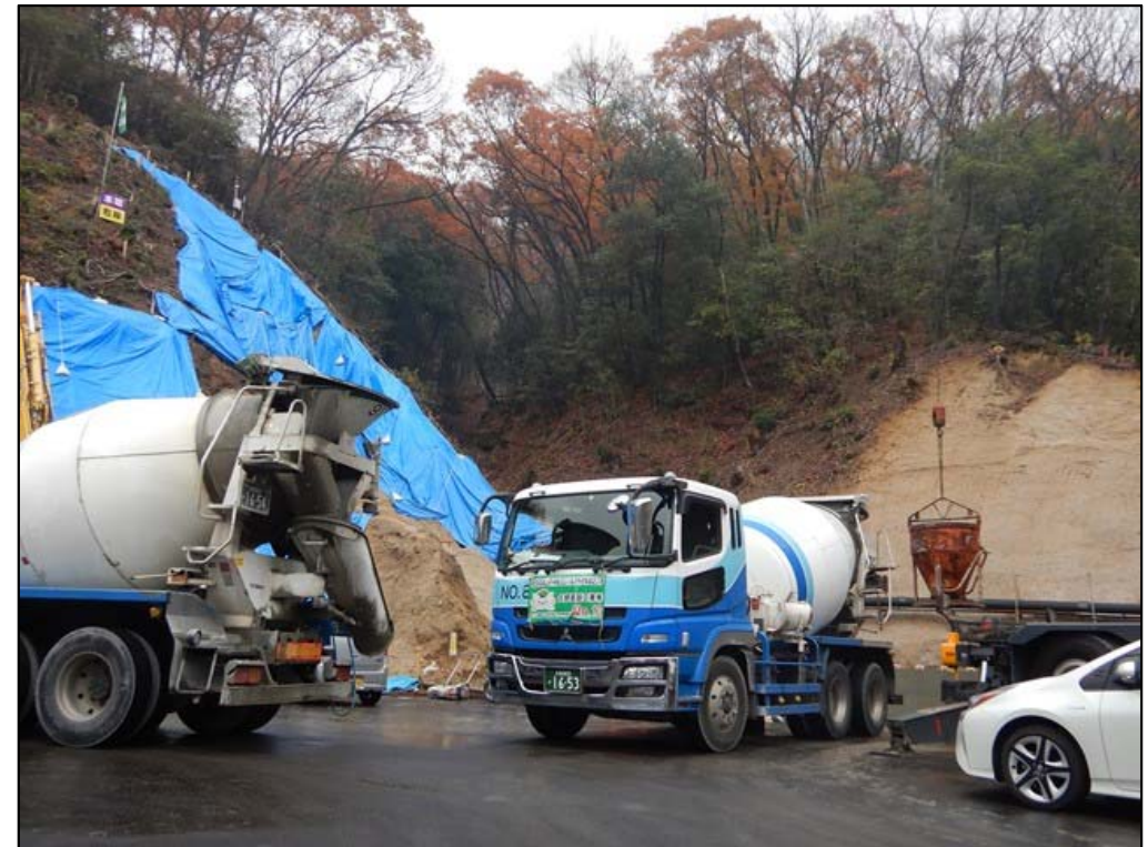
コンクリート打設状況②
