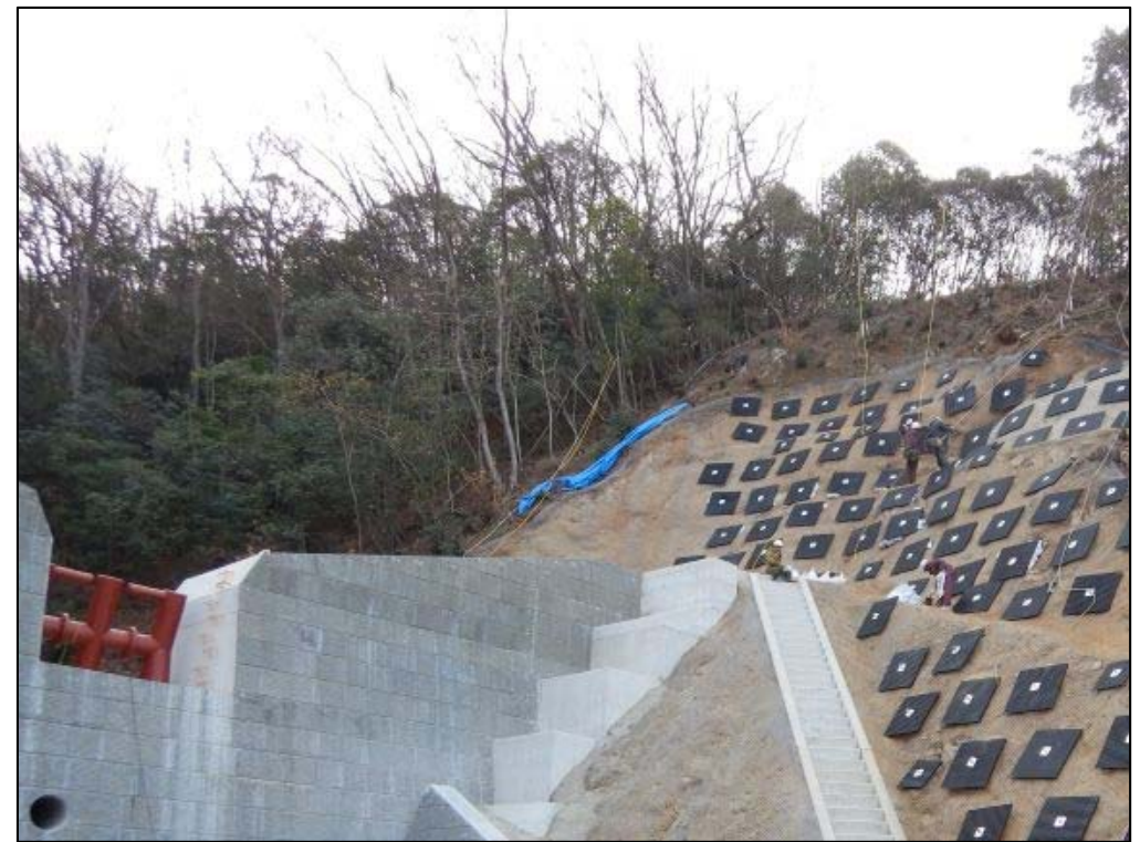
施工状況②
