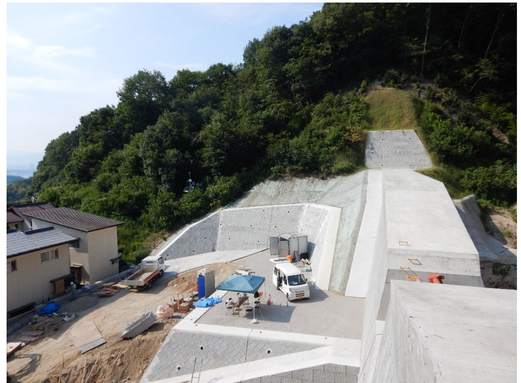
管理用道路施工状況
