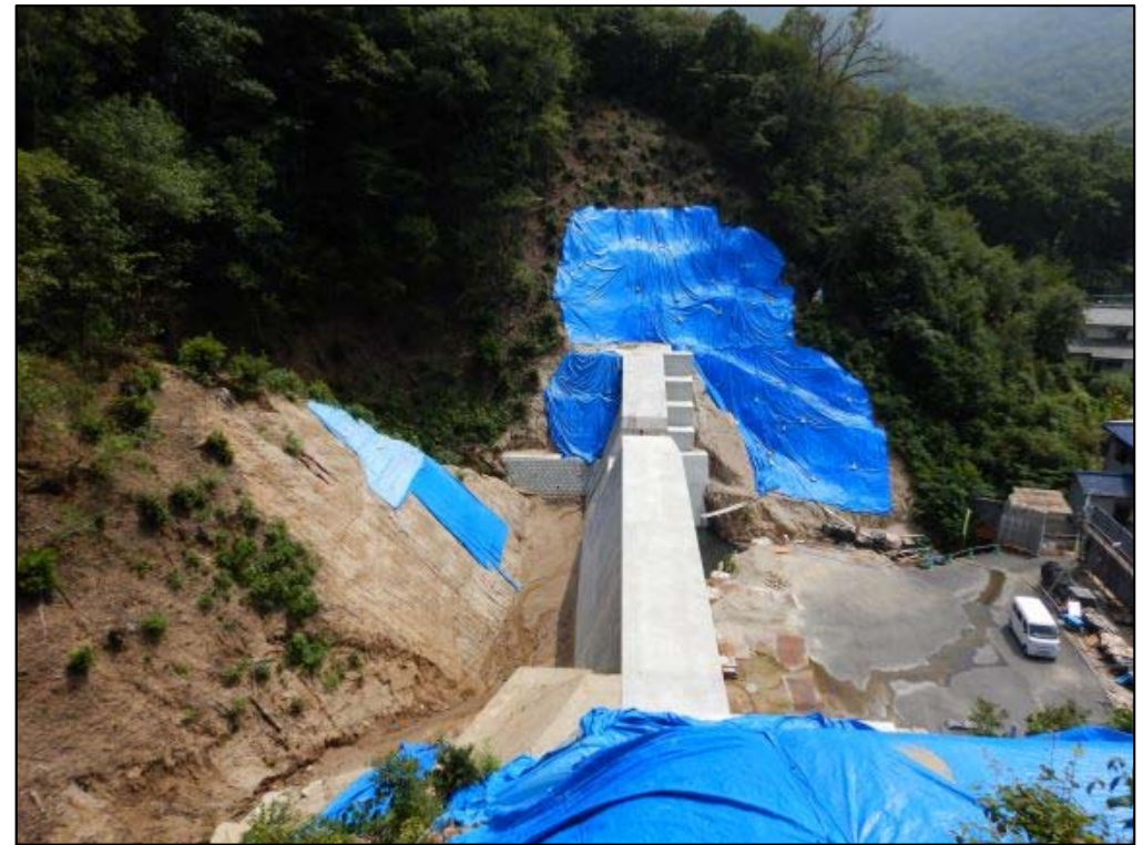
現地状況（右岸側より）
