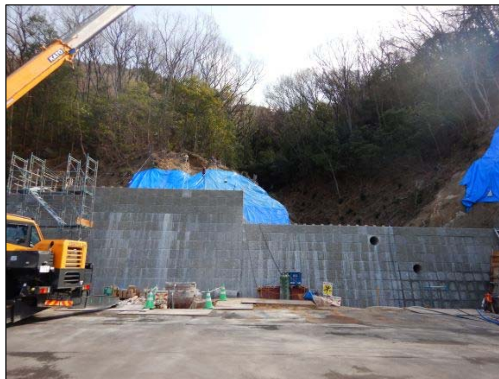
コンクリート打設状況②
