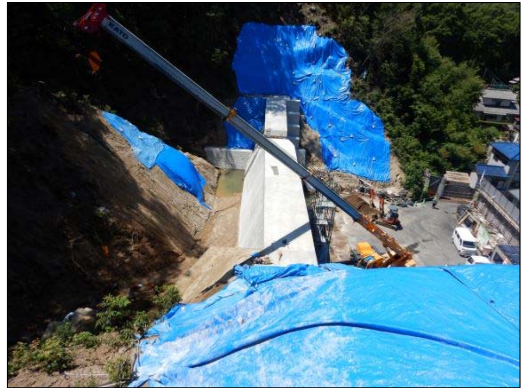
施工状況（右岸側より）
