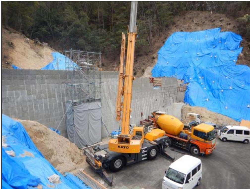
コンクリート打設状況①
