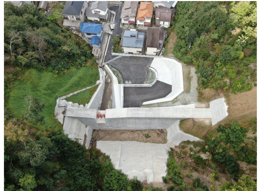
砂防堰堤全景（上流側より）
