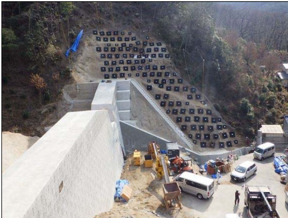
施工状況①
