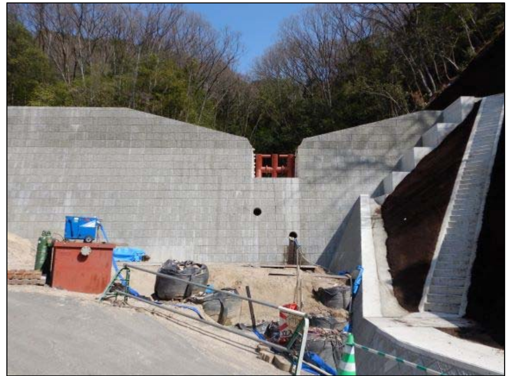
施工状況②
