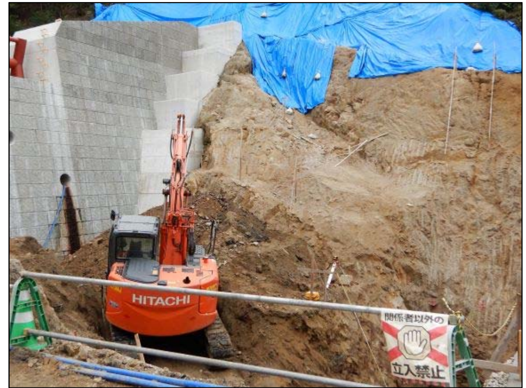
掘削作業状況②
