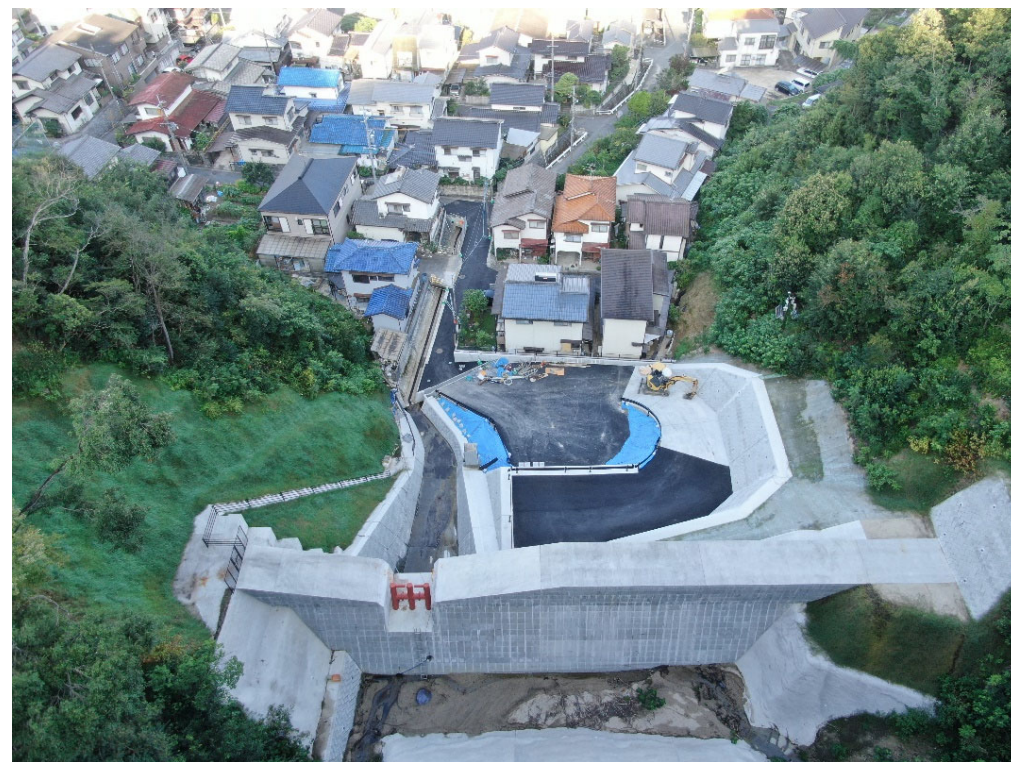
砂防堰堤全景（上流側より）
