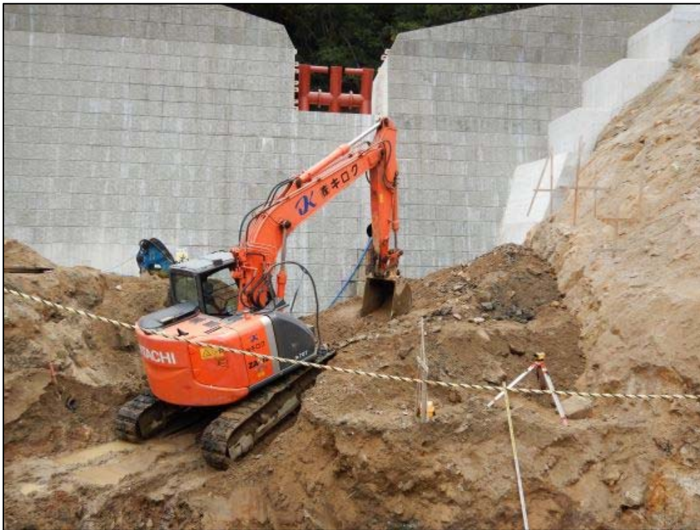
掘削作業状況①
