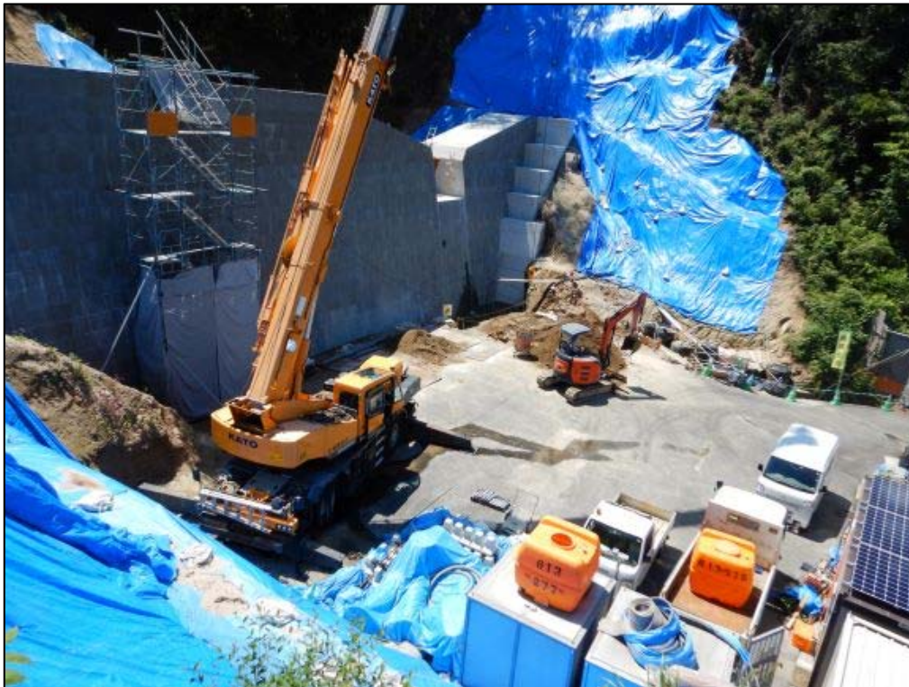
施工状況（下流側より）
