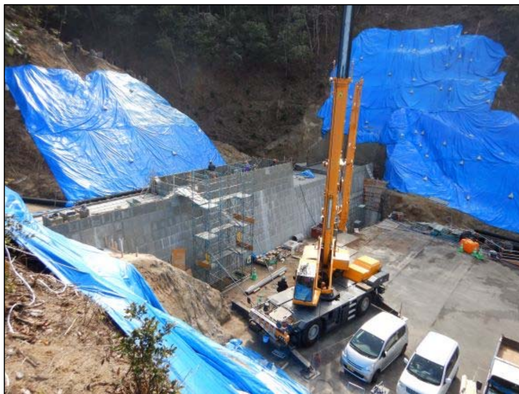
コンクリート打設状況①
