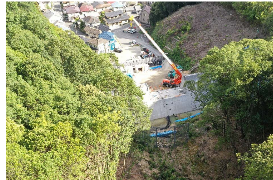
【施工状況（上流側より）】
