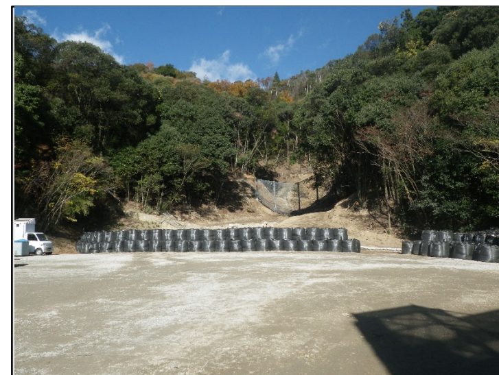
流路工設置状況
