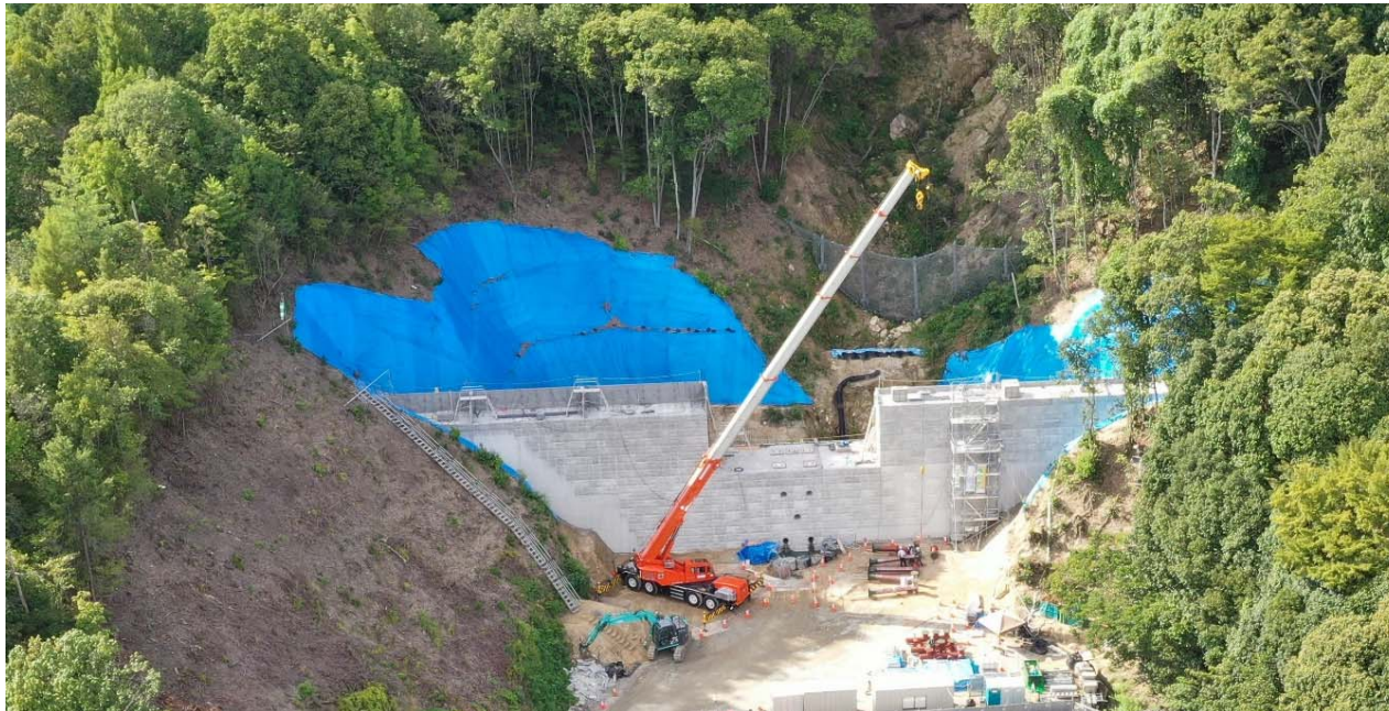
【施工状況（下流側より）】
