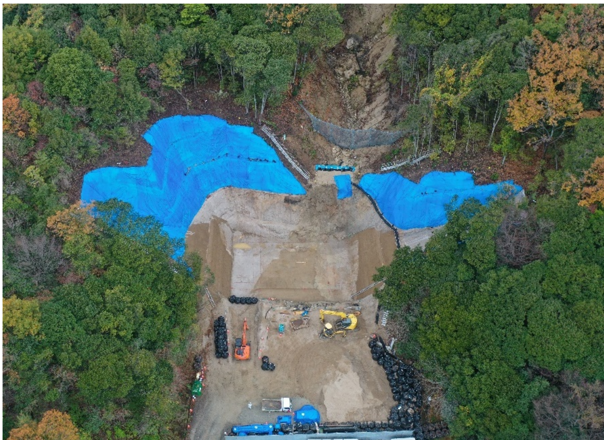
【施工状況（下流側より）】
