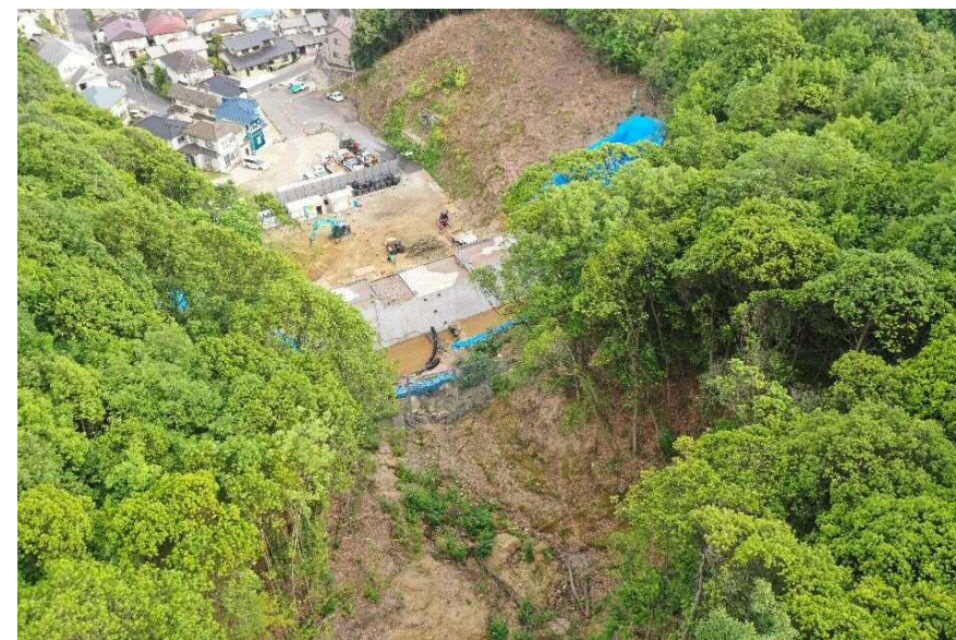
【施工状況（上流側より）】
