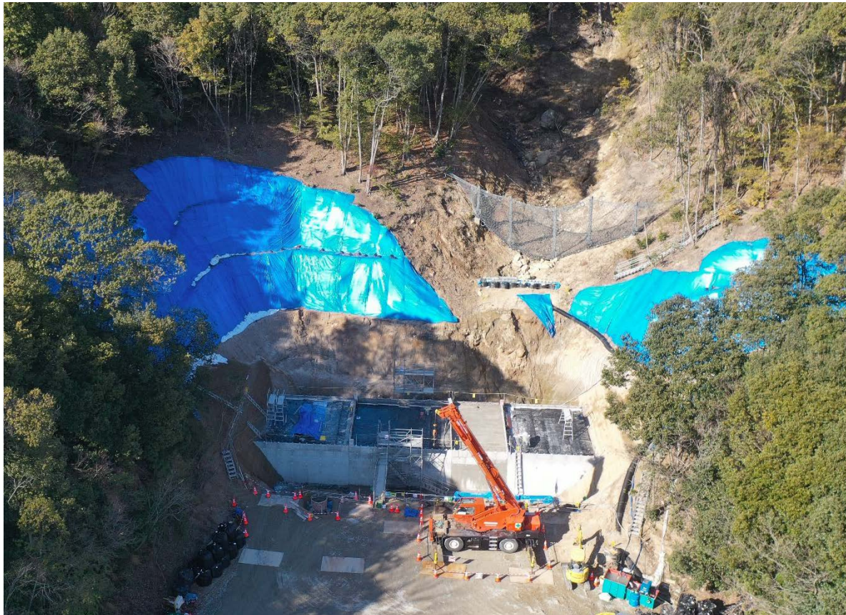
【施工状況（下流側より）】
