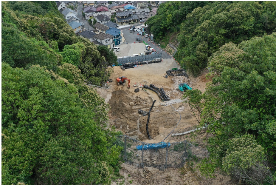
上流側上空より
