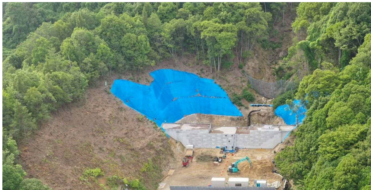
【施工状況（下流側より）】
