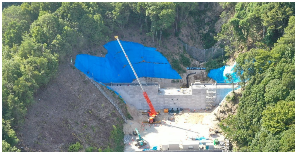
【施工状況（下流側より）】
