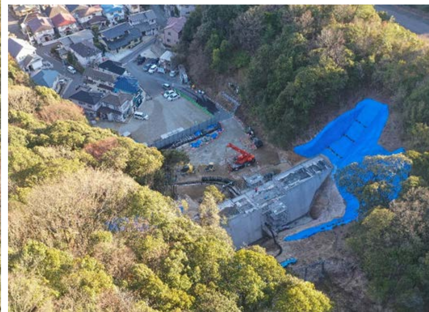
【施工状況（上流側より）】
