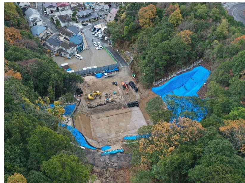
【施工状況（上流側より）】
