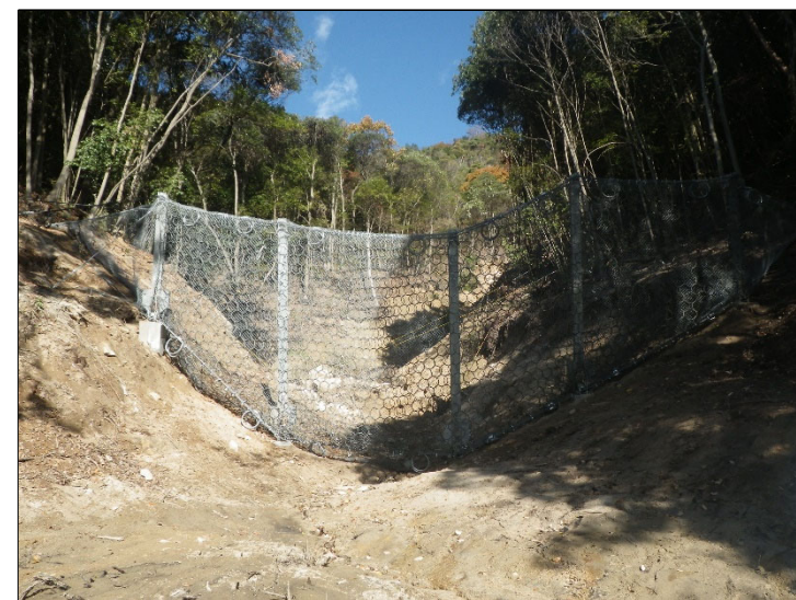
強靱ワイヤーネット設置状況
