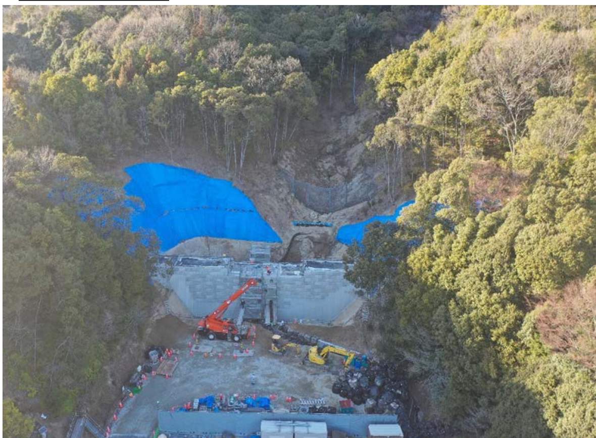
【施工状況（下流側より）】
