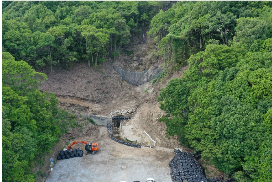
下流側上空より
