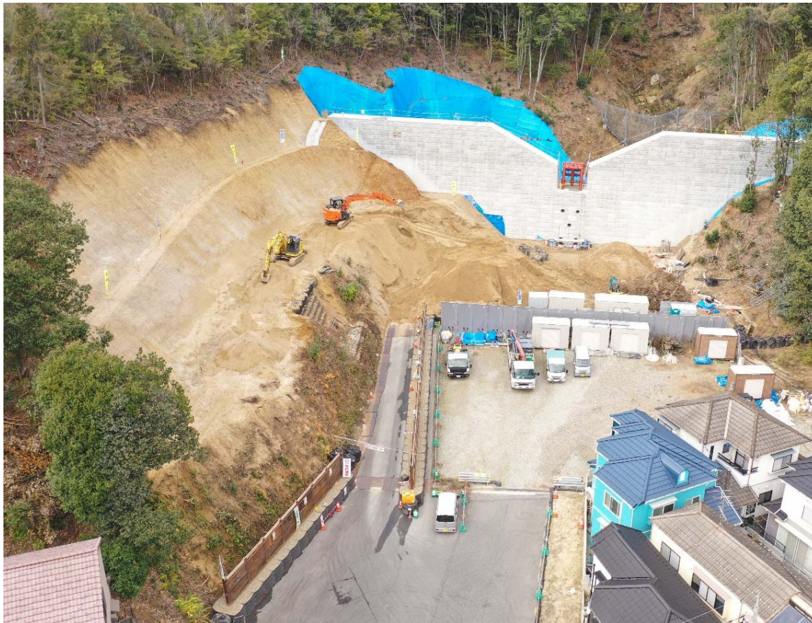
【施工状況（下流側より）】
