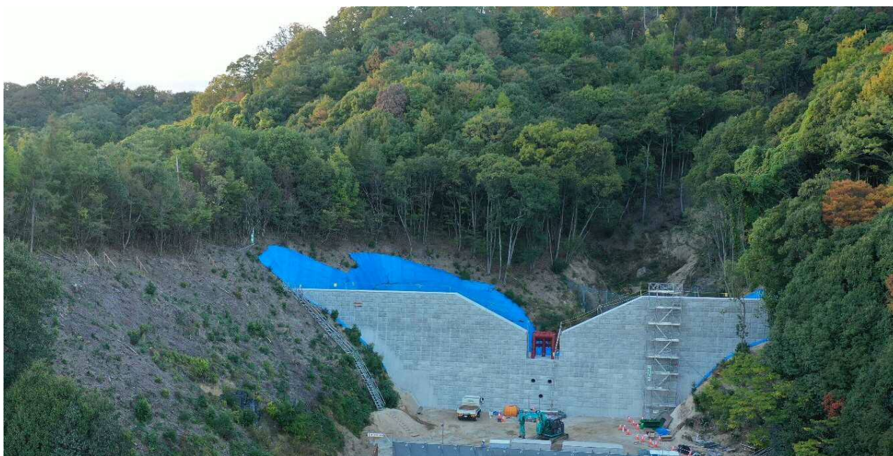
【施工状況（下流側より）】
