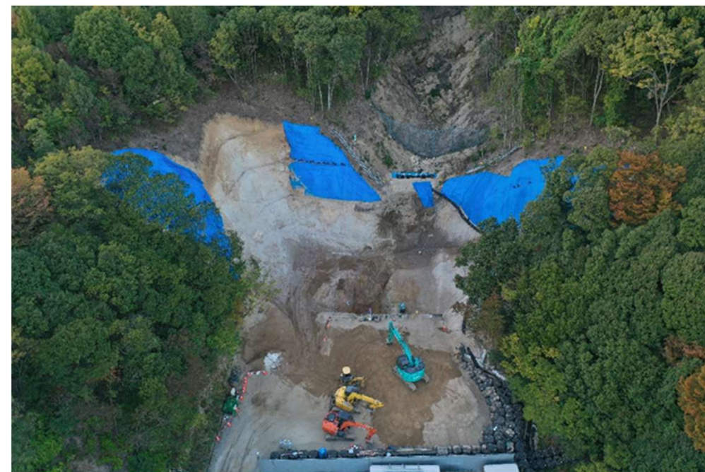
下流側上空より
