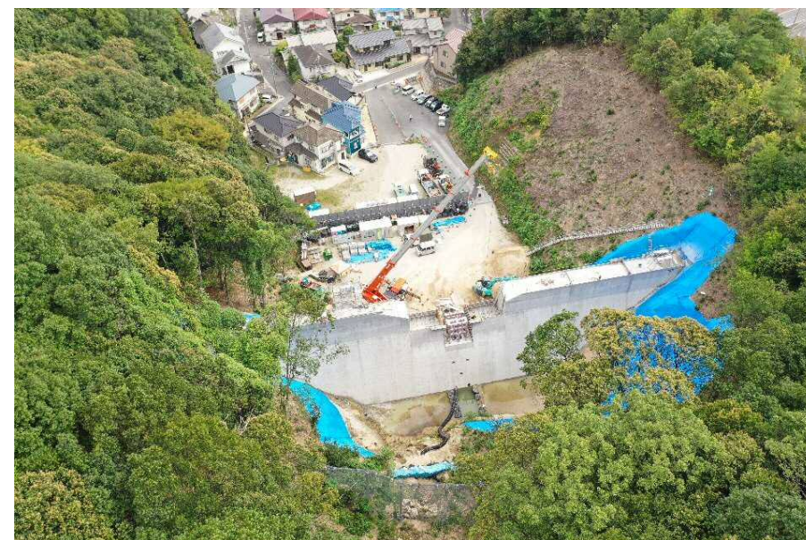
【施工状況（上流側より）】
