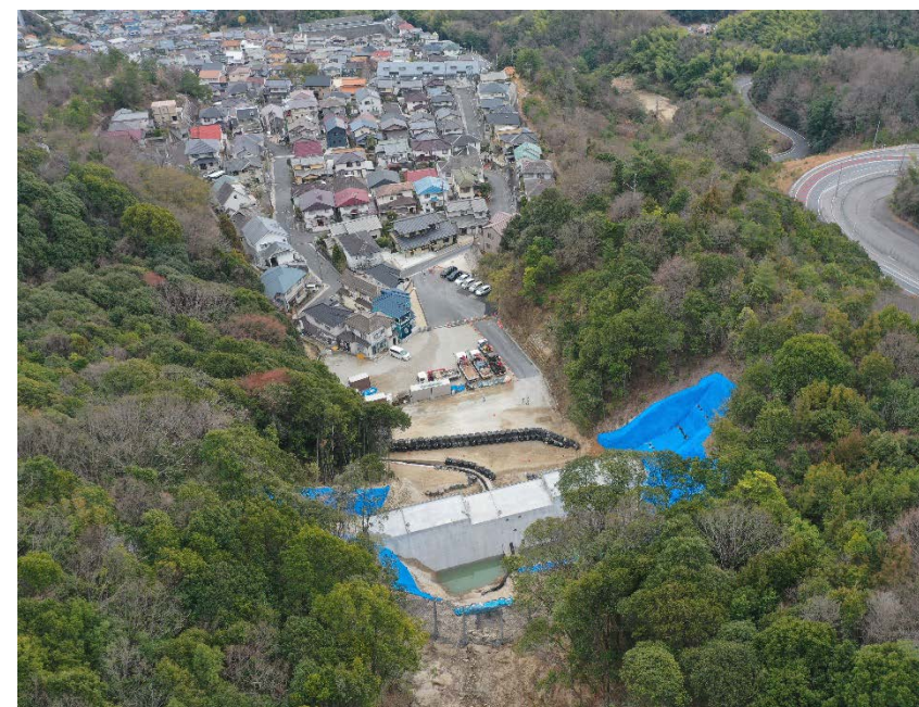
【施工状況（上流側より）】
