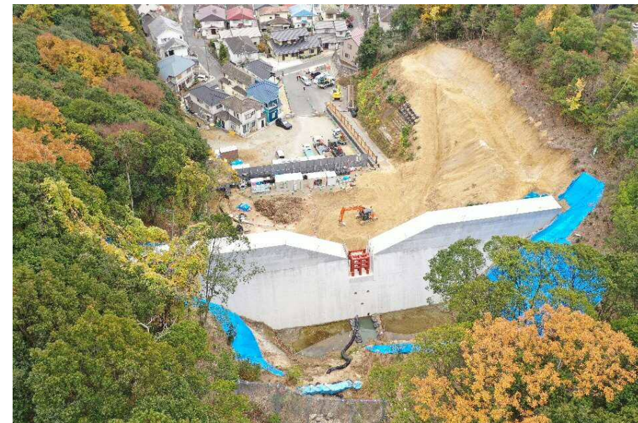
【施工状況（上流側より）】
