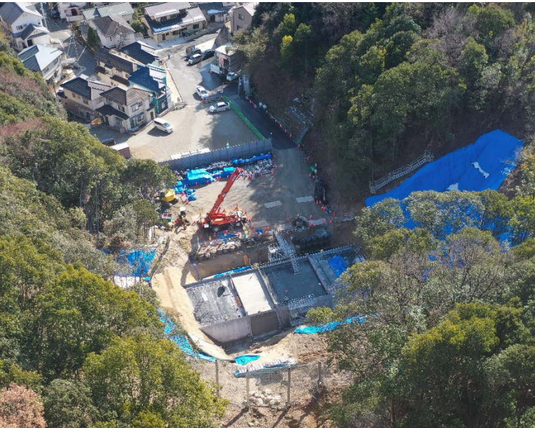
【施工状況（上流側より）】
