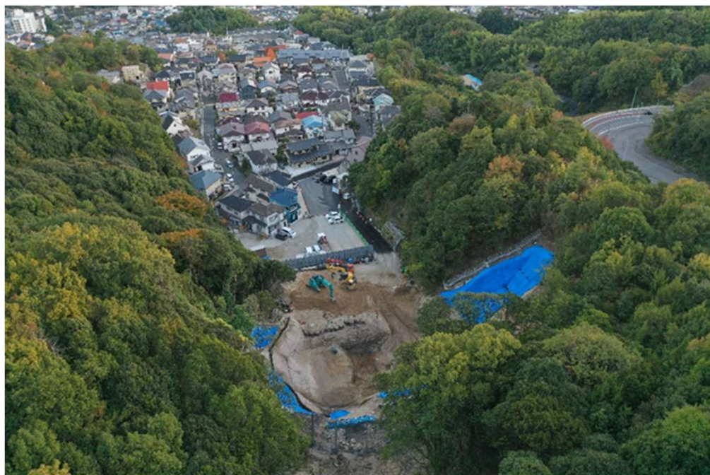
上流側上空より
