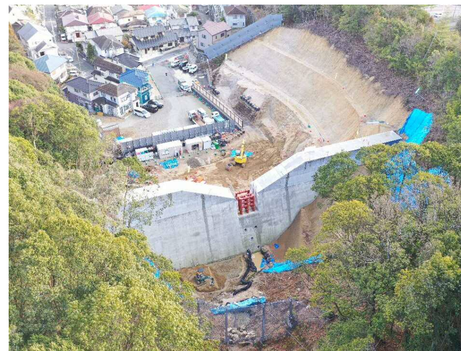
【施工状況（上流側より）】
