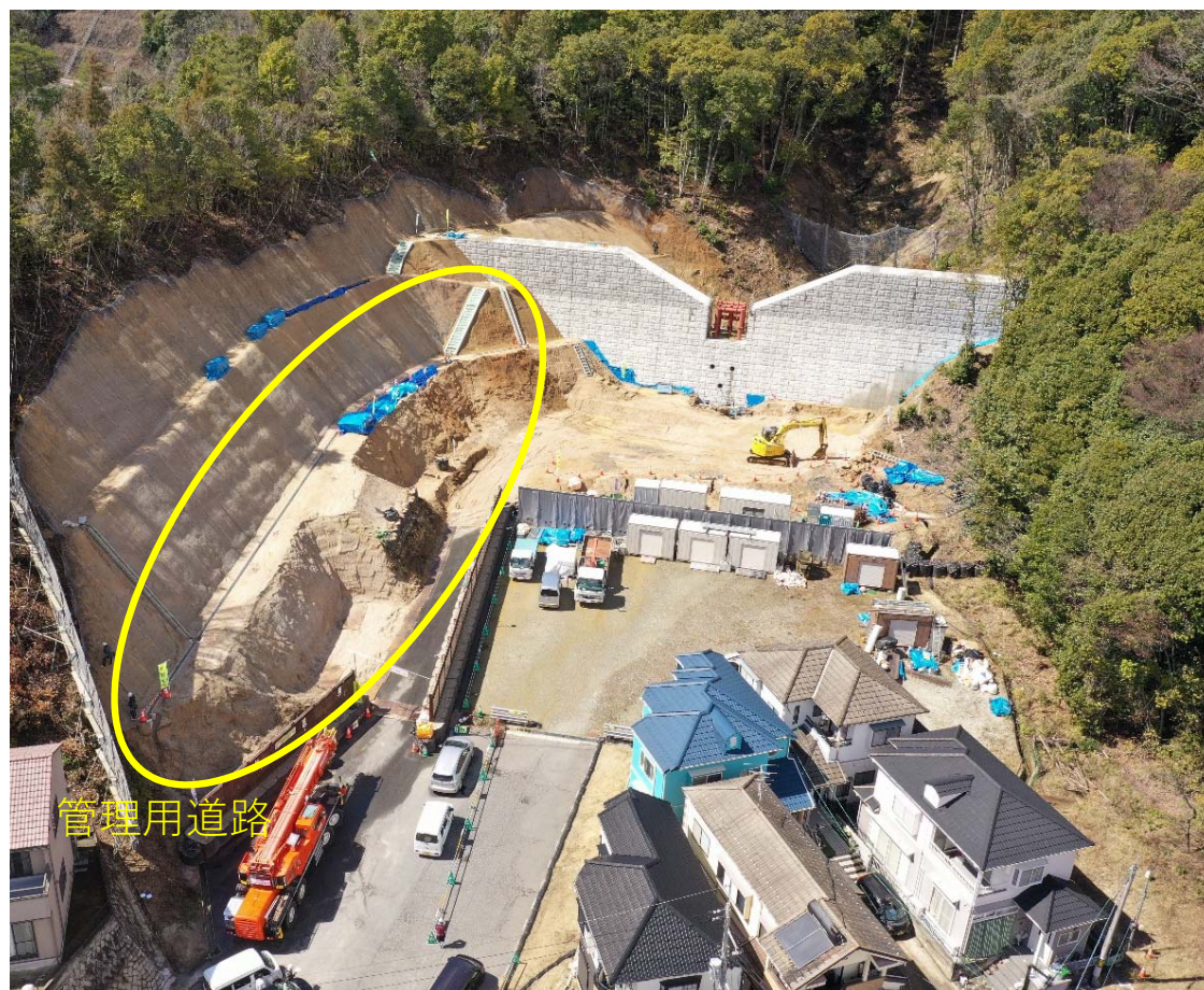
【施工状況（下流側より）】
