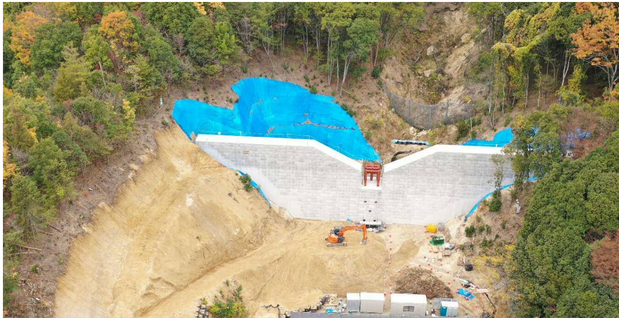
【施工状況（下流側より）】
