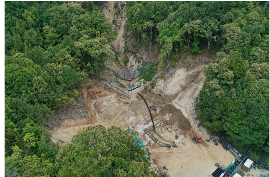
下流側上空より
