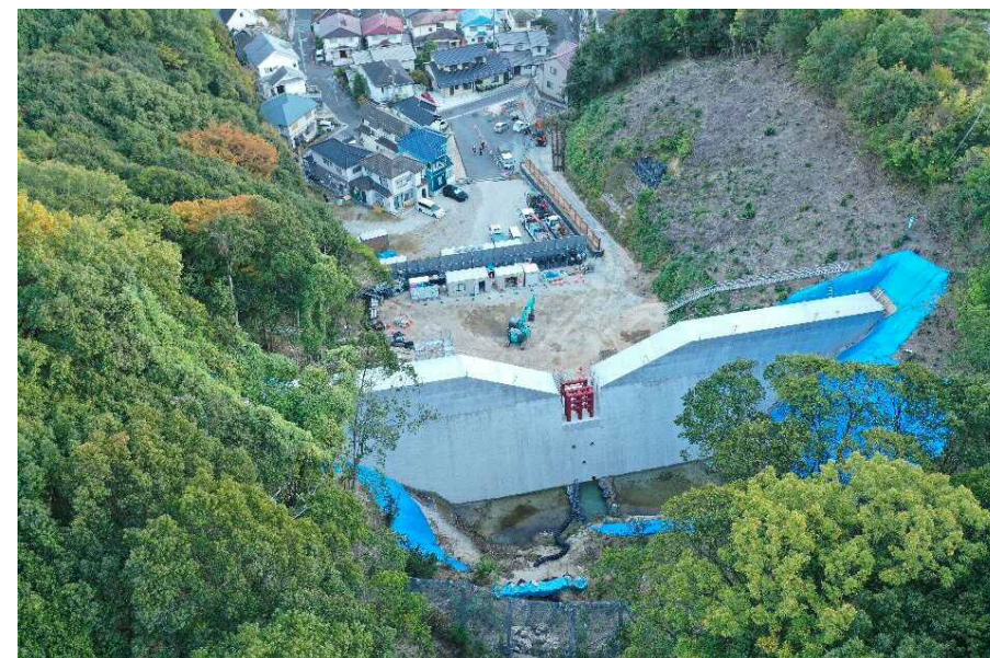
【施工状況（上流側より）】
