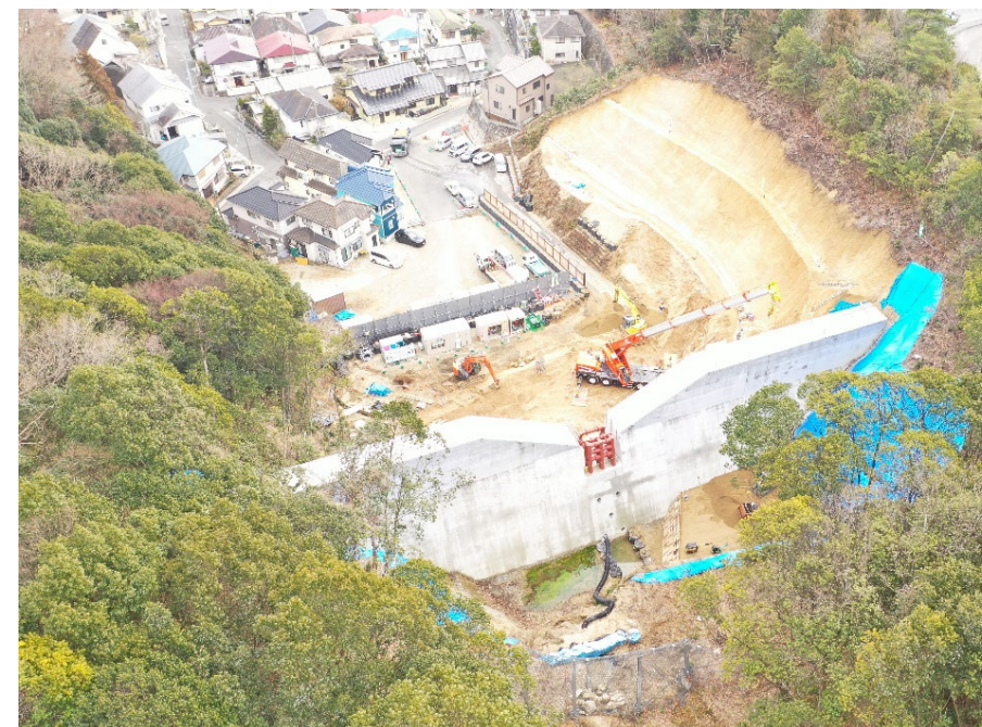
【施工状況（上流側より）】
