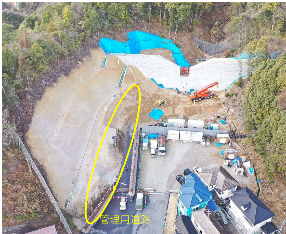
【施工状況（下流側より）】
