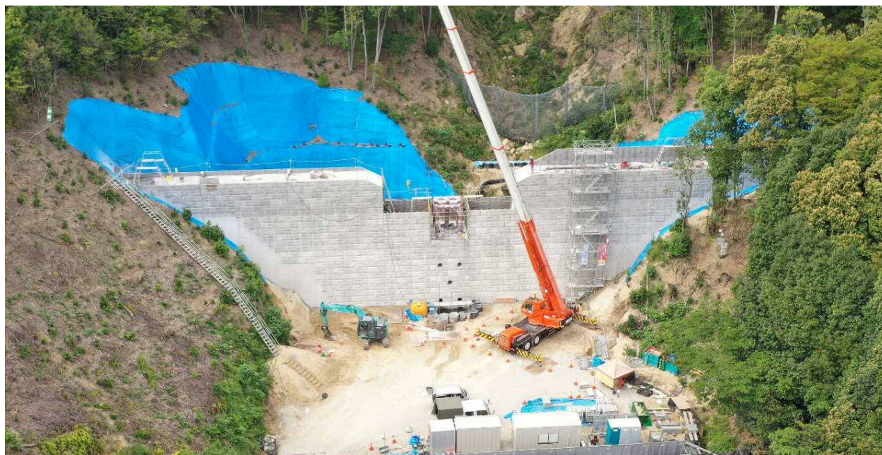
【施工状況（下流側より）】
