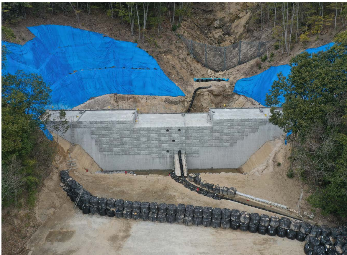
【施工状況（下流側より）】
