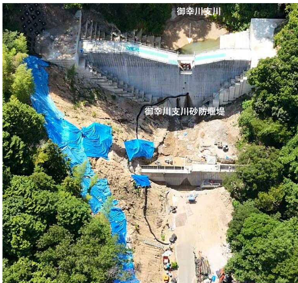
【施工状況（上空より）】
