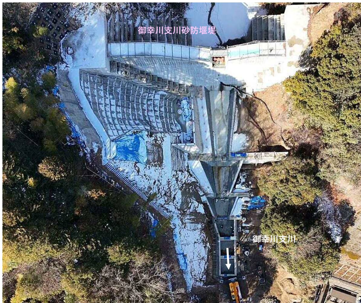
【施工状況（上空より）】
