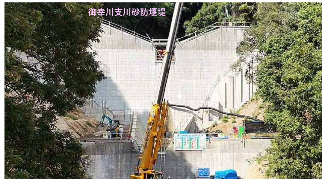
【施工箇所（下流側より）】
