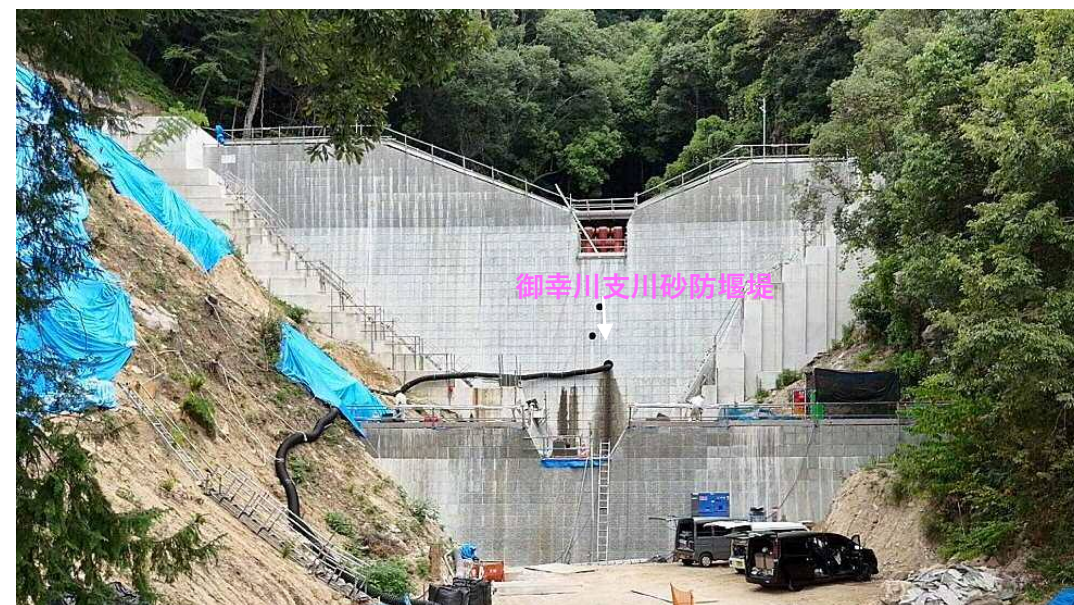
【施工箇所（下流側より）】
