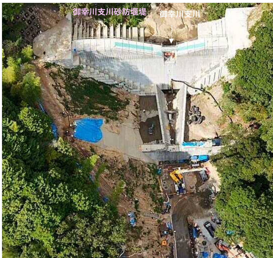
【施工状況（上空より）】
