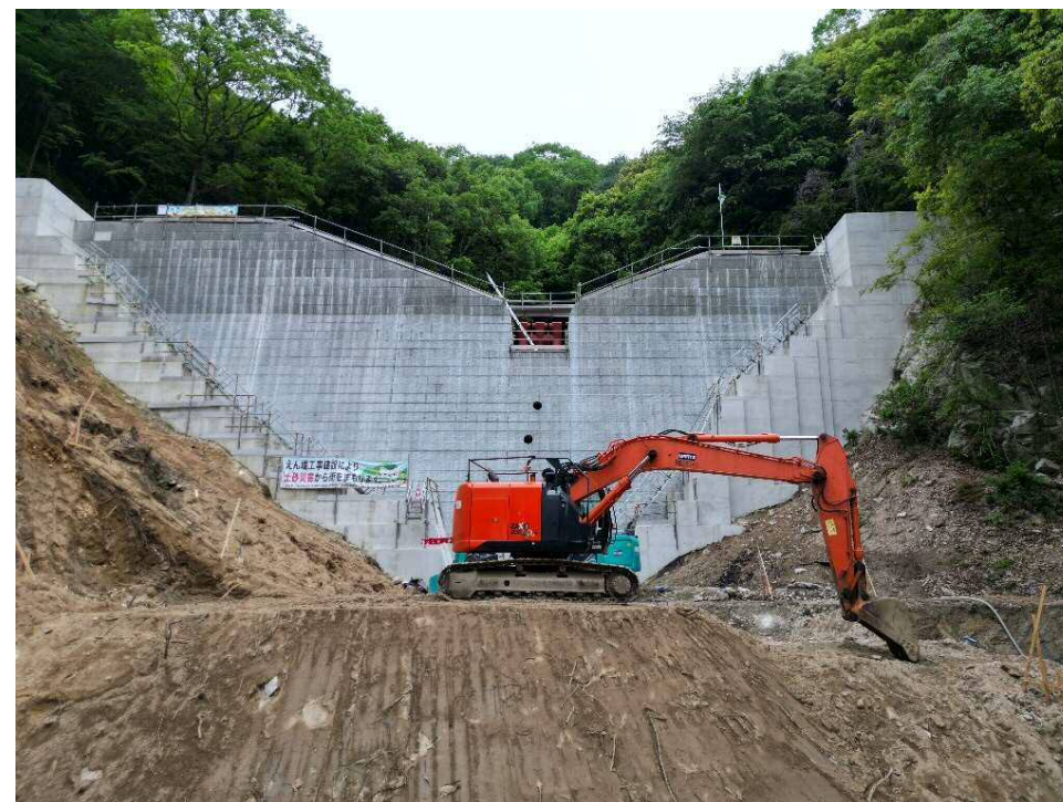
【施工箇所（下流側より）】
