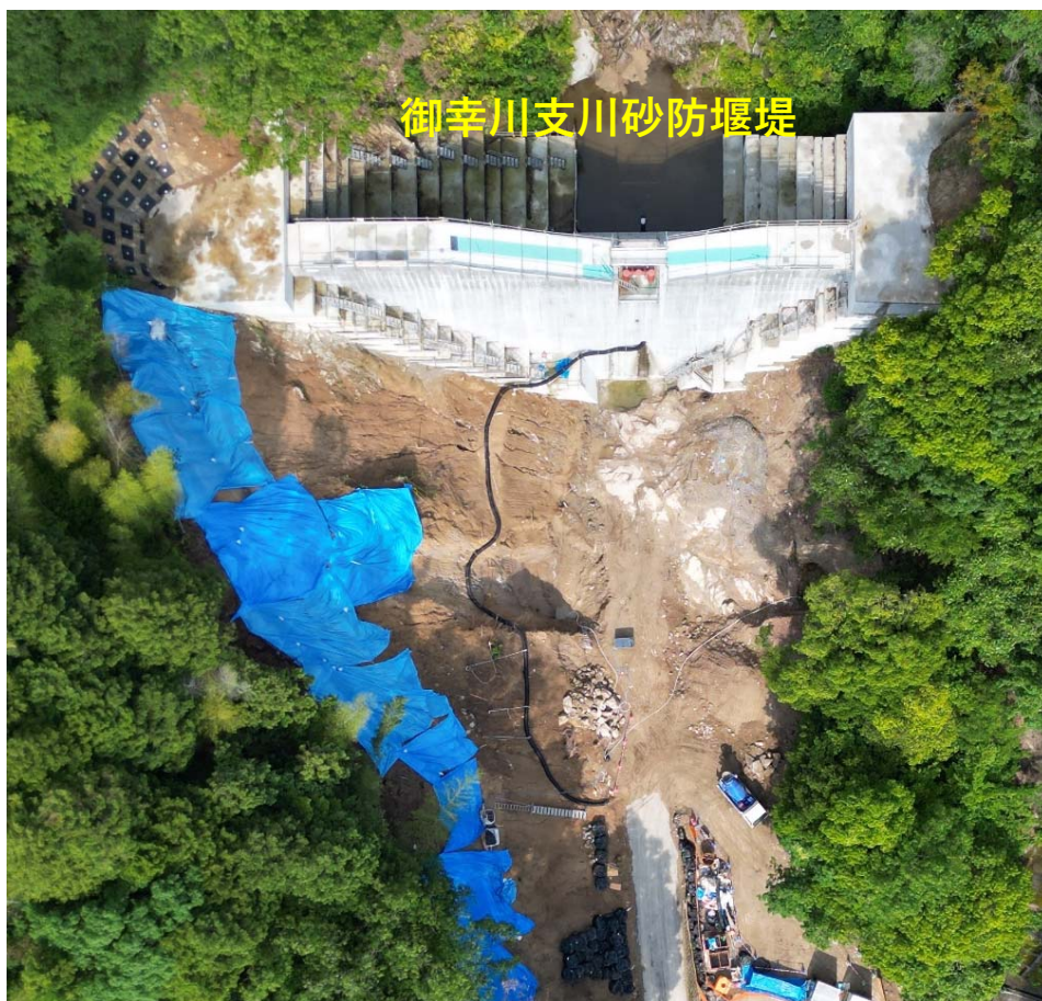
【施工状況（上空より）】
