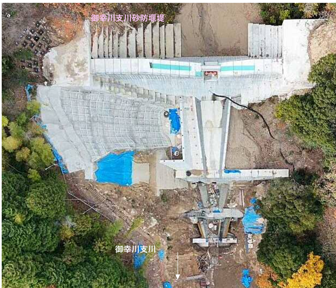
【施工状況（上空より）】
