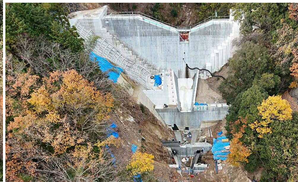
【施工状況（下流上空より）】
