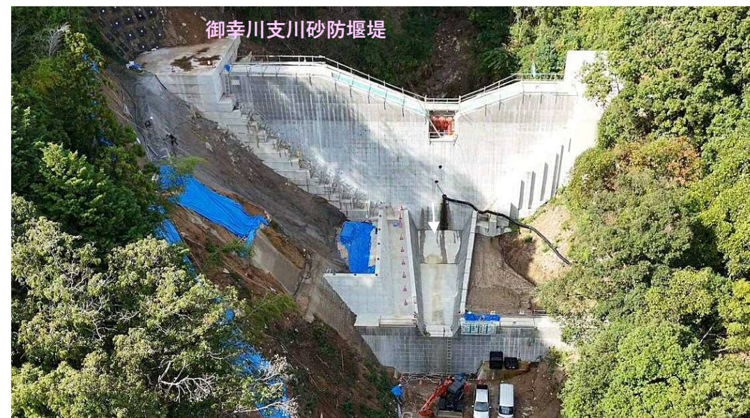
【施工箇所（下流上空より）】
