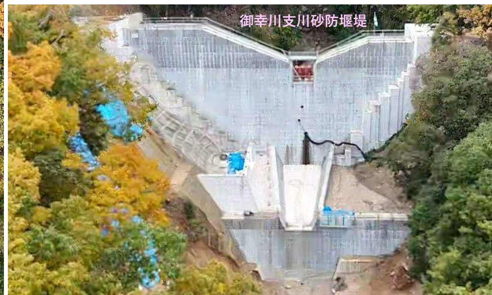
【施工箇所（下流上空より）】
