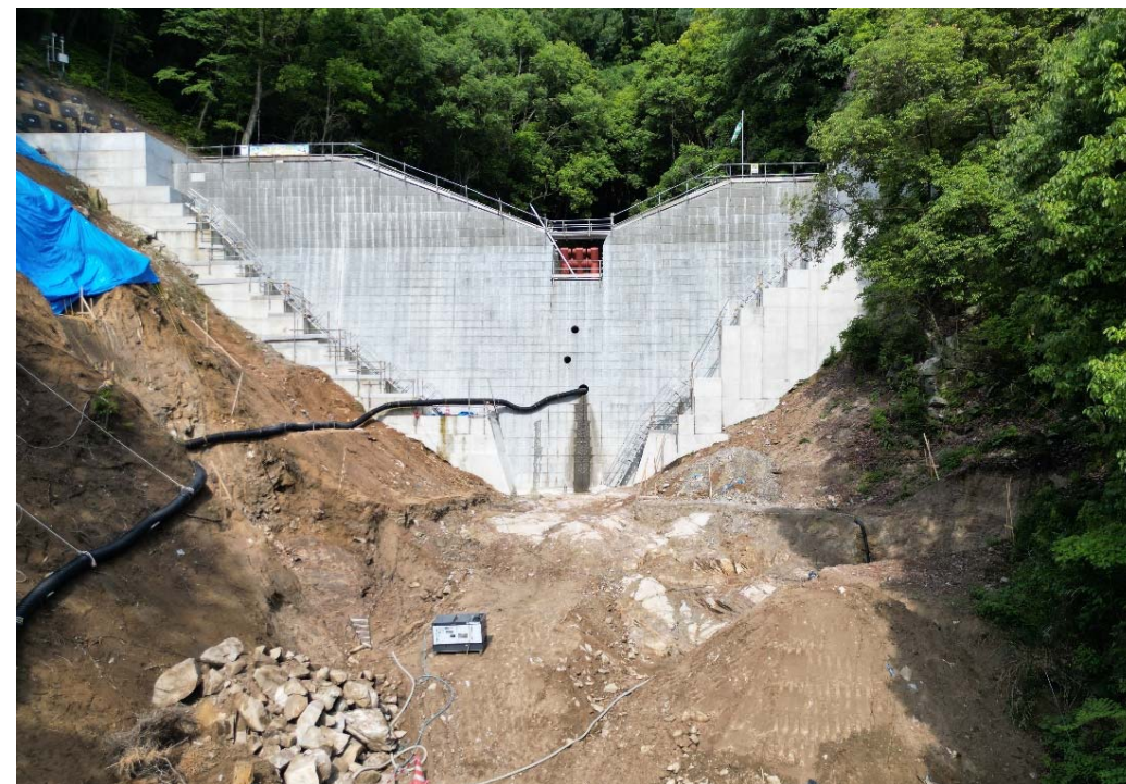
【施工箇所（下流側より）】
