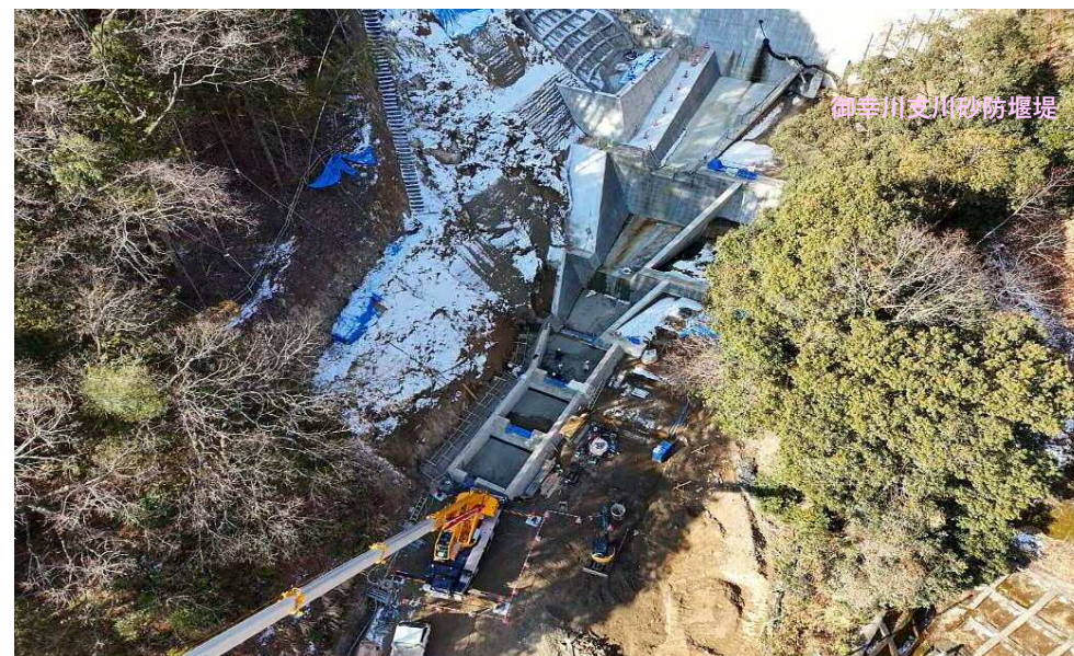
【施工状況（下流上空より）】
