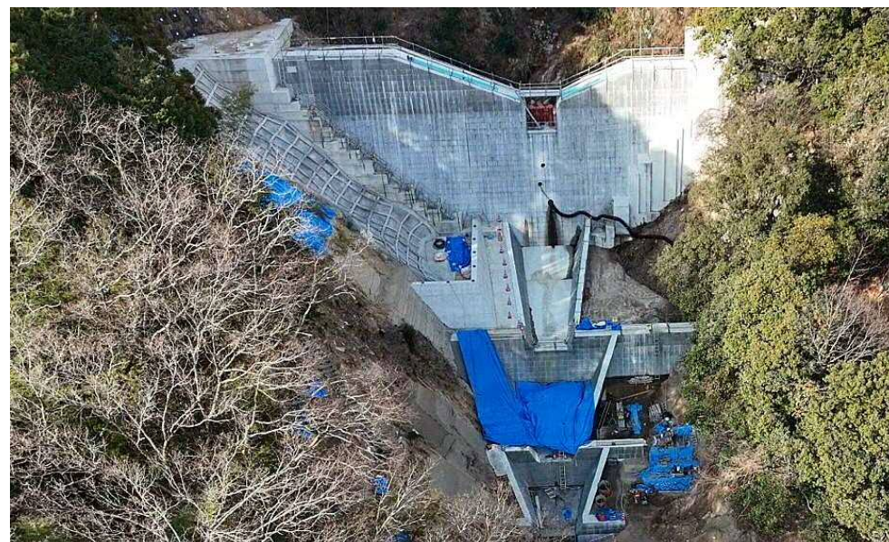
【施工状況（下流上空より）】
