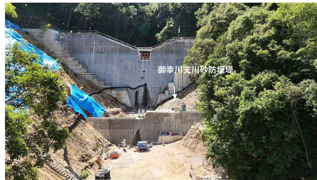
【施工箇所（下流側より）】
