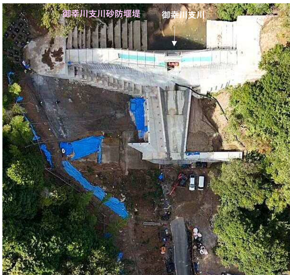
【施工状況（上空より）】
