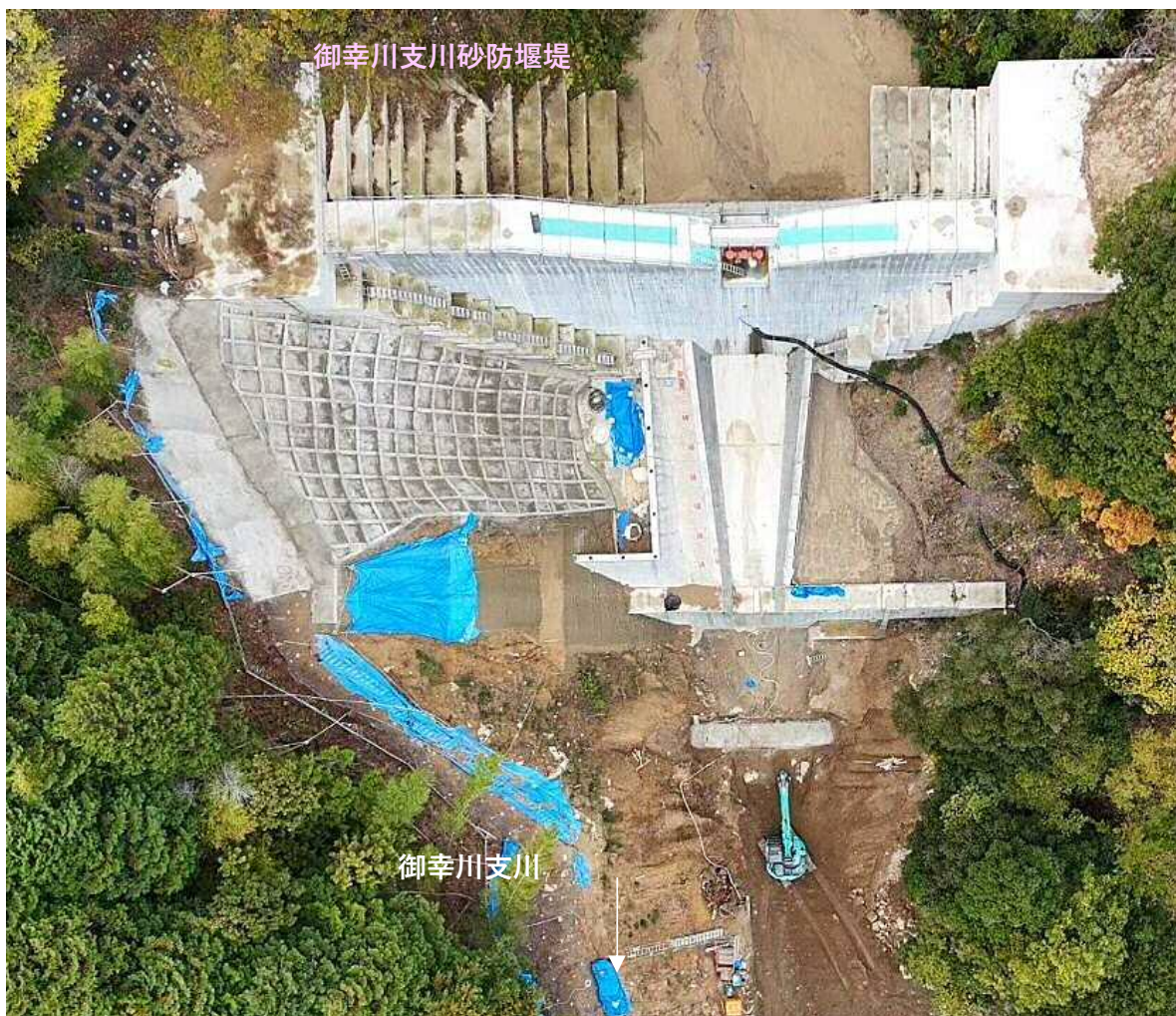
【施工状況（上空より）】
