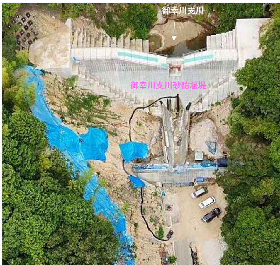
【施工状況（上空より）】
