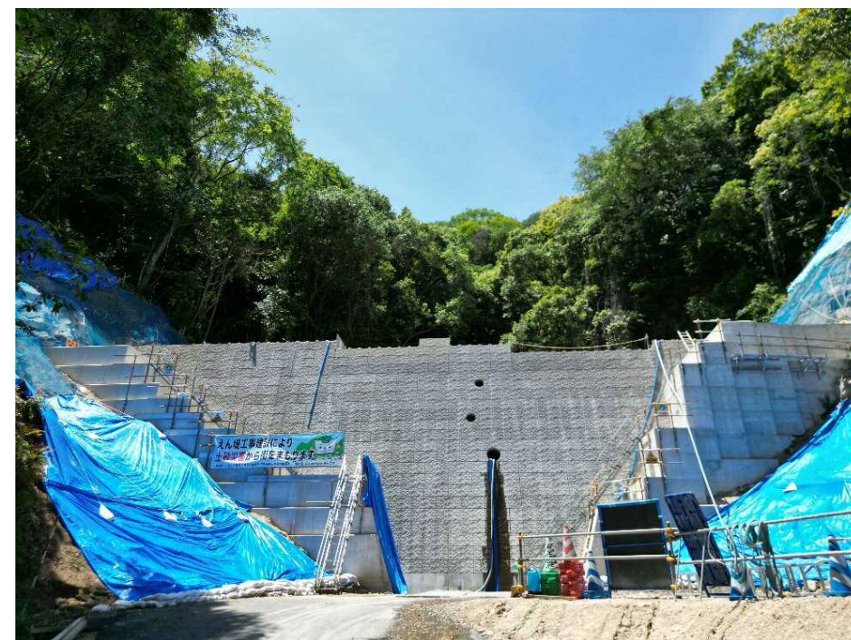
【施工箇所（下流側より）】
