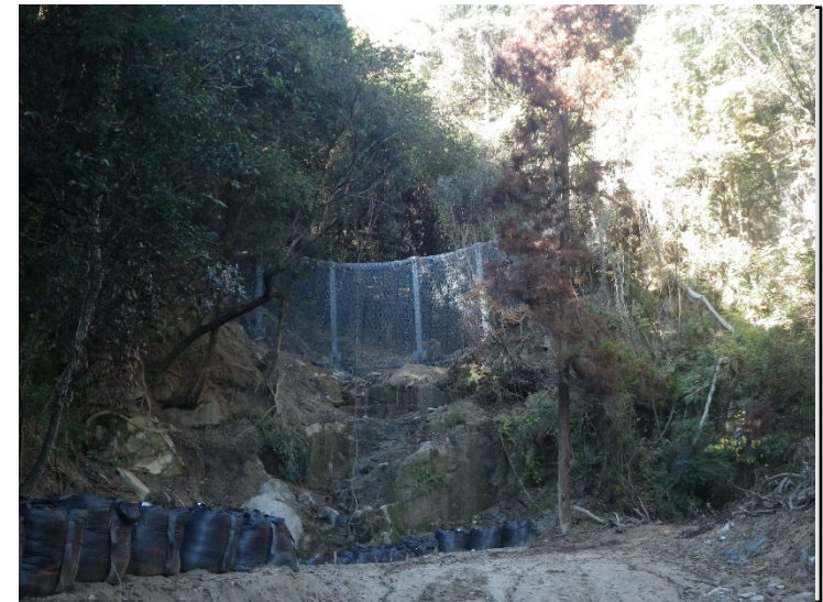
強靱ワイヤーネット設置状況
