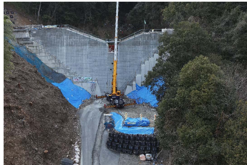
【施工箇所（下流側より）】
