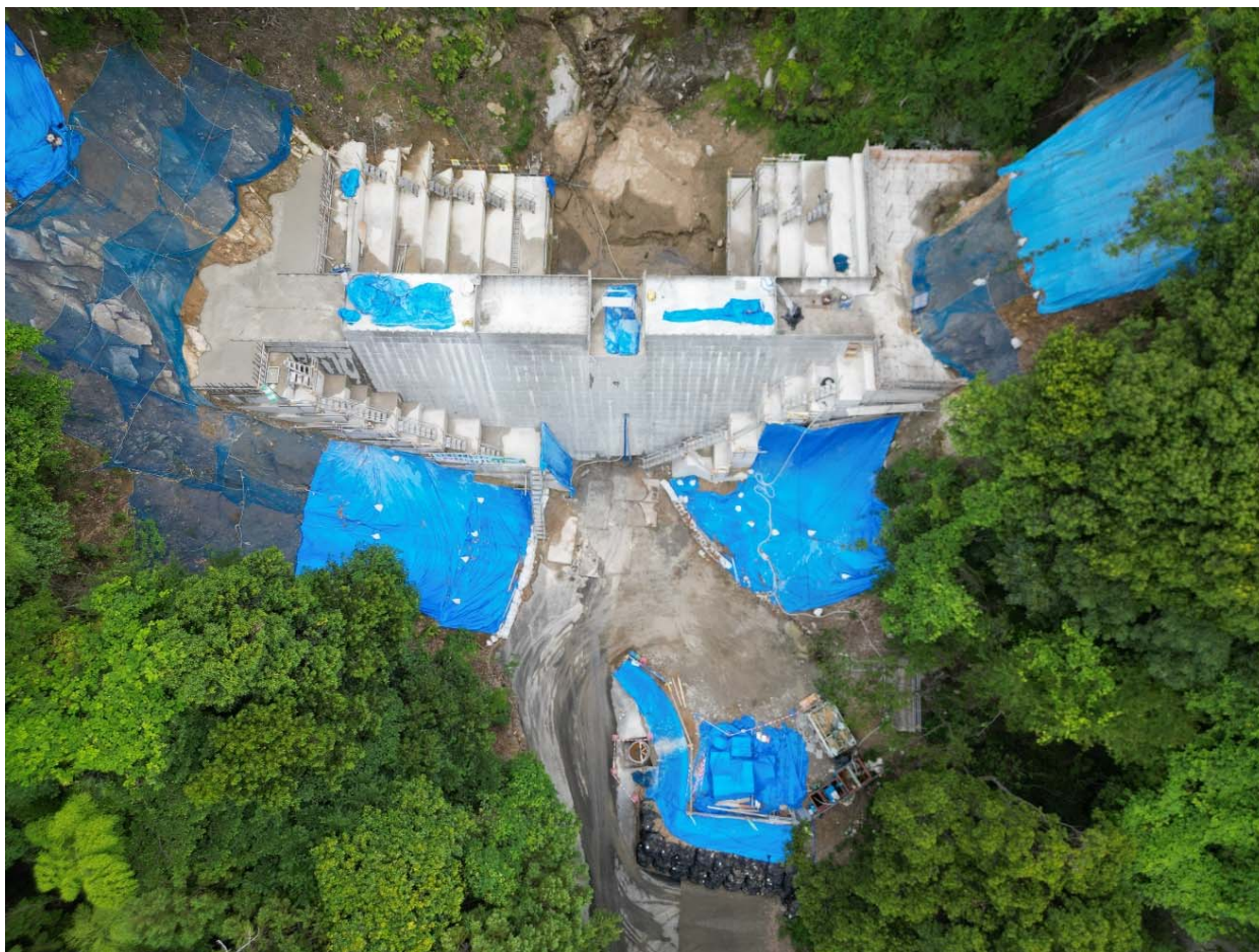
【施工状況（上空より）】
