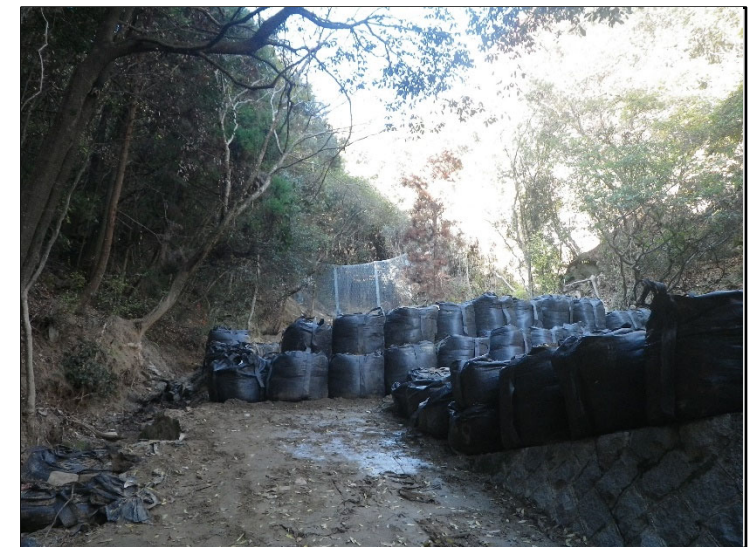
流路工設置状況
