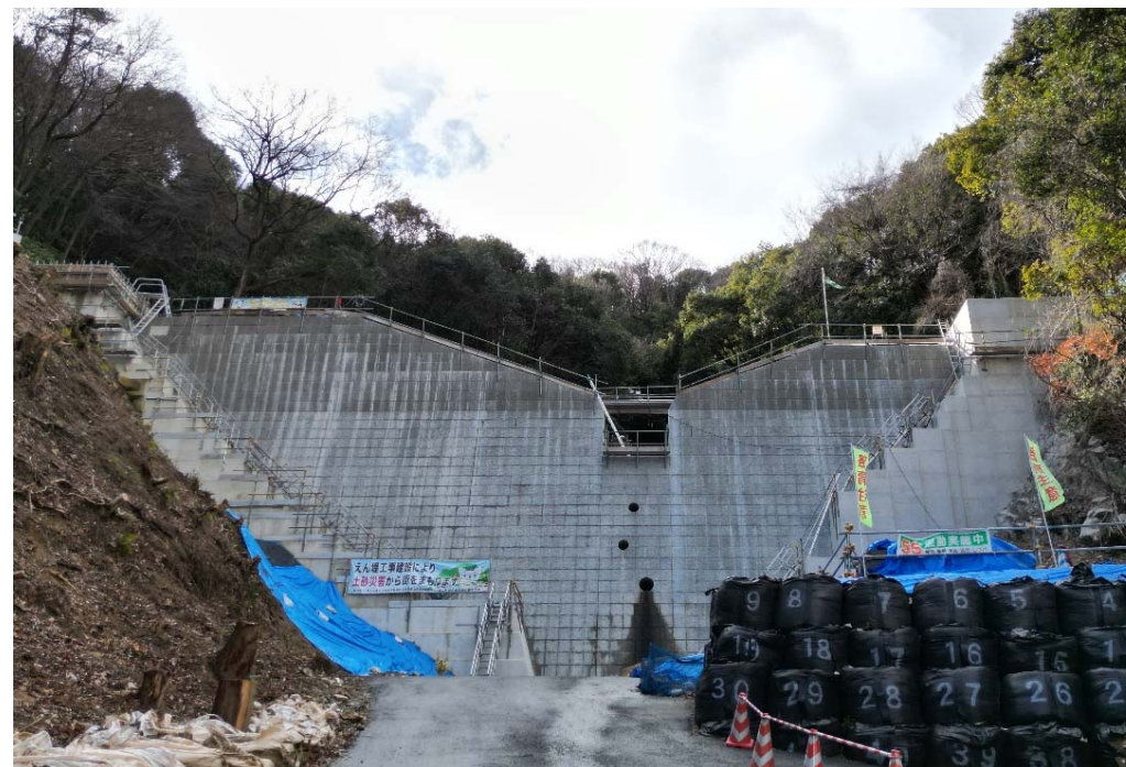
【施工箇所（下流側より）】
