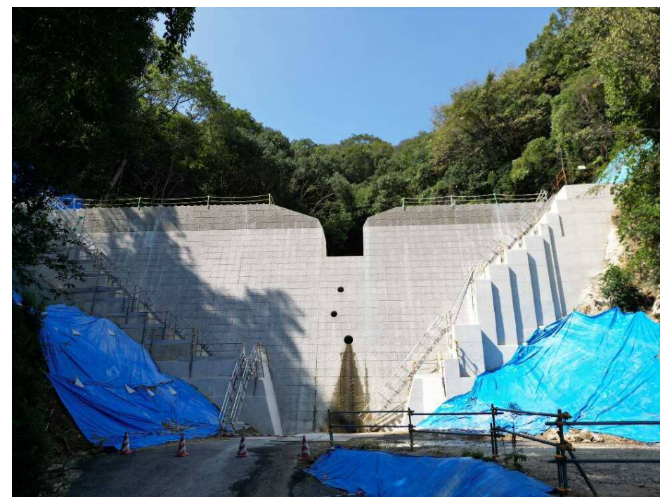
【施工箇所（下流側より）】
