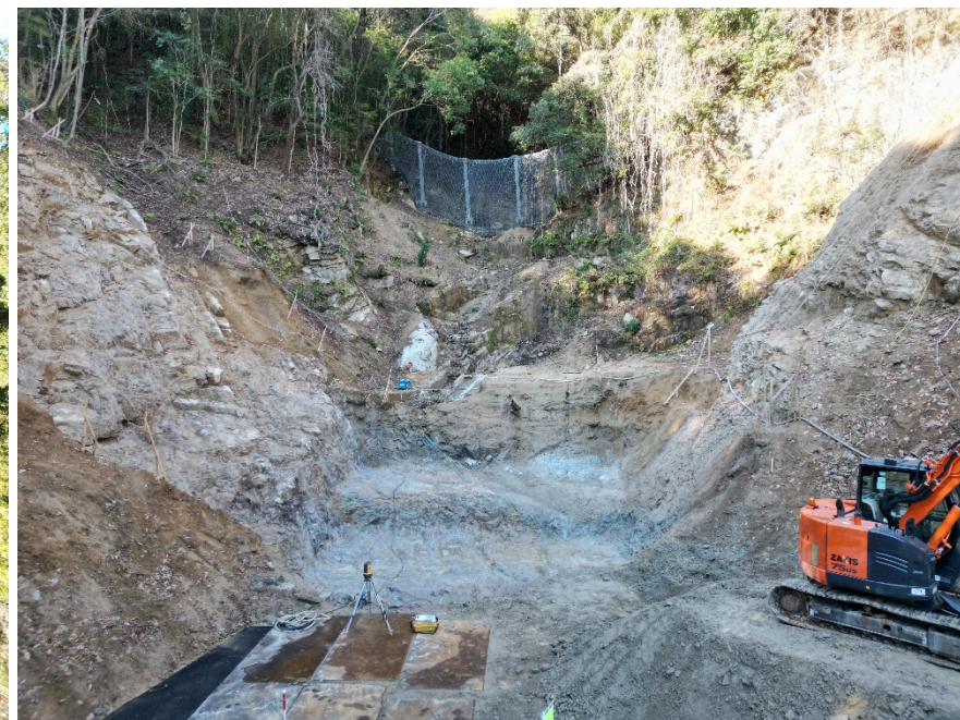
【施工箇所（下流側より）】
