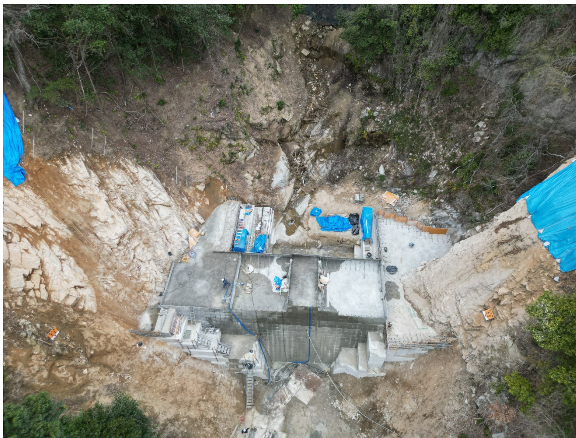
【施工状況（上空より）】
