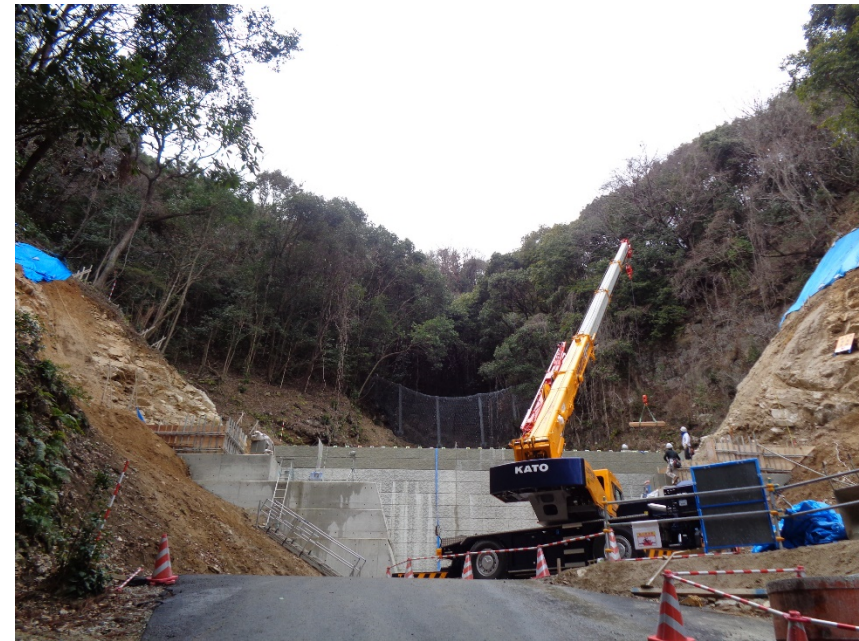
【施工箇所（下流側より）】
