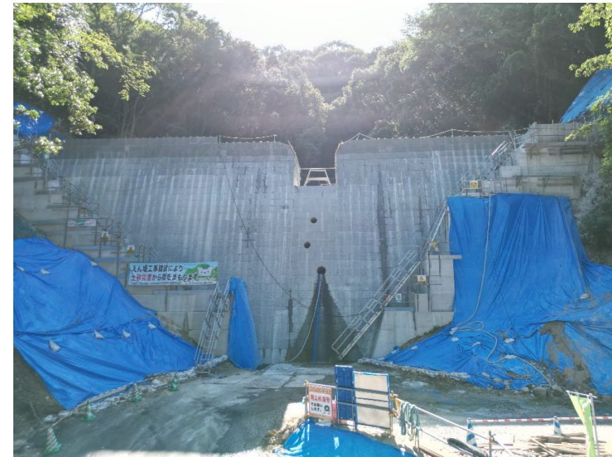
【施工箇所（下流側より）】
