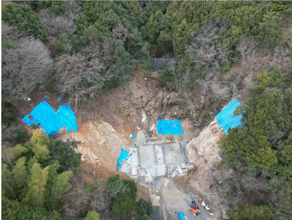
【施工状況（上空より）】
