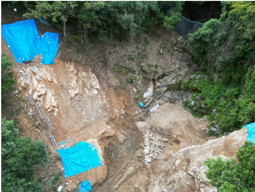
下流側上空より
