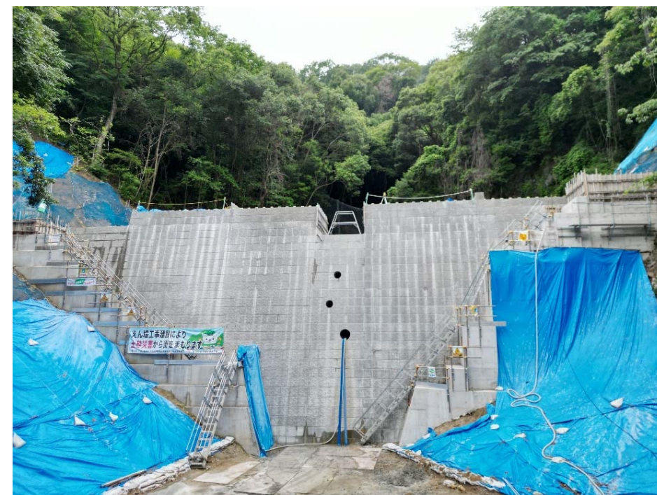
【施工箇所（下流側より）】
