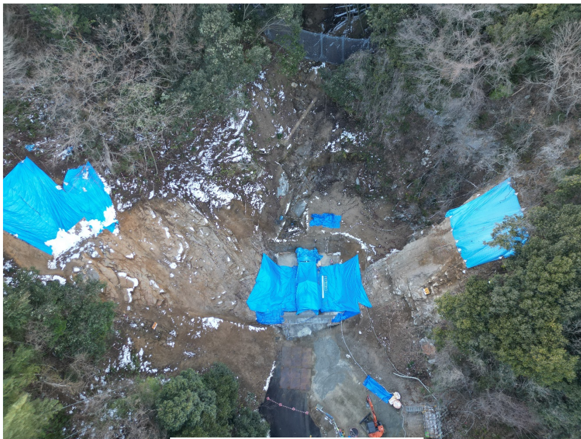
【施工状況（上空より）】
