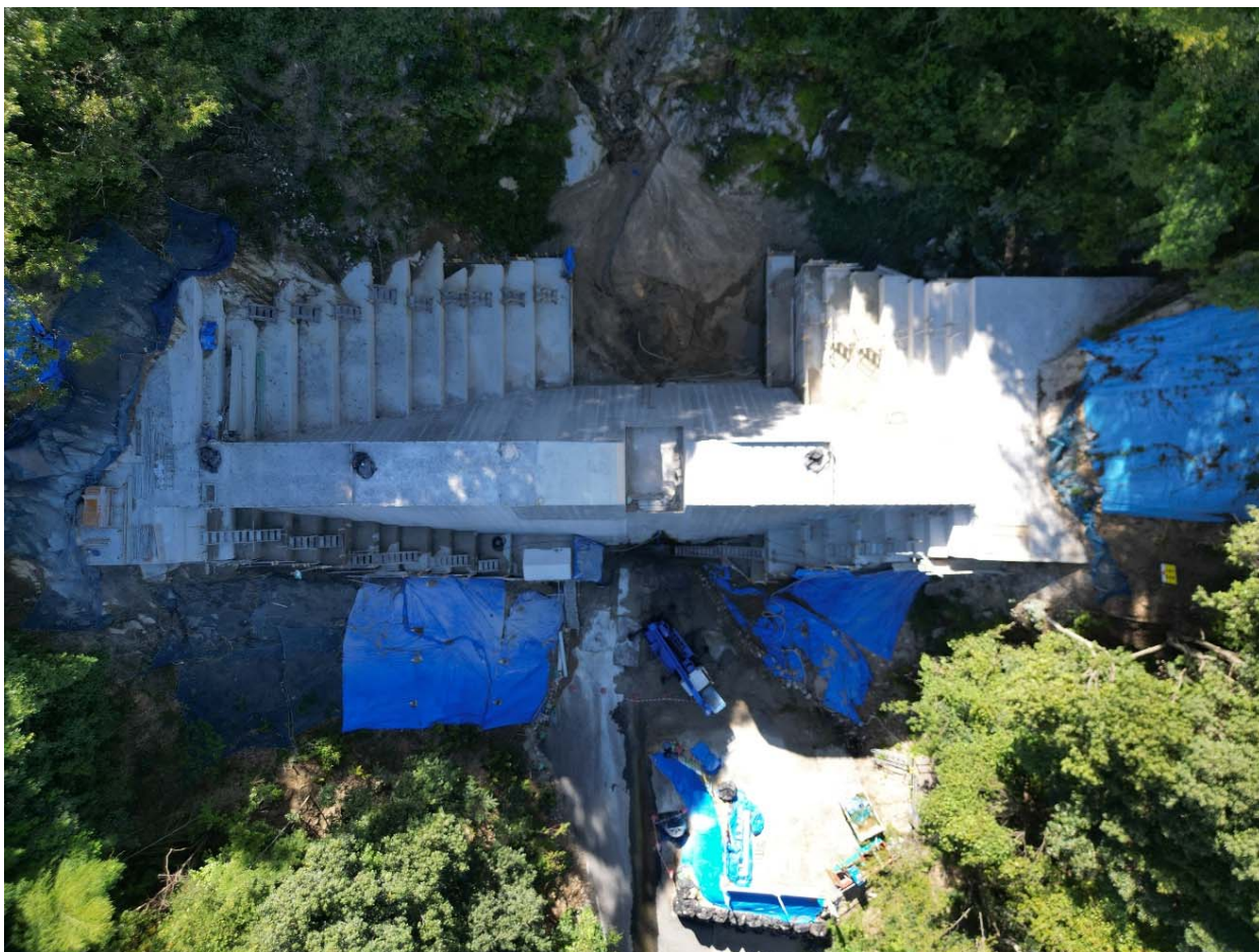
【施工状況（上空より）】
