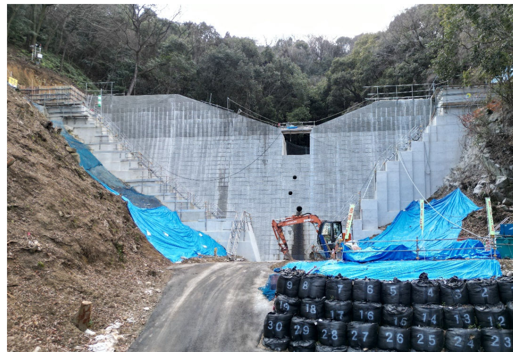
【施工箇所（下流側より）】
