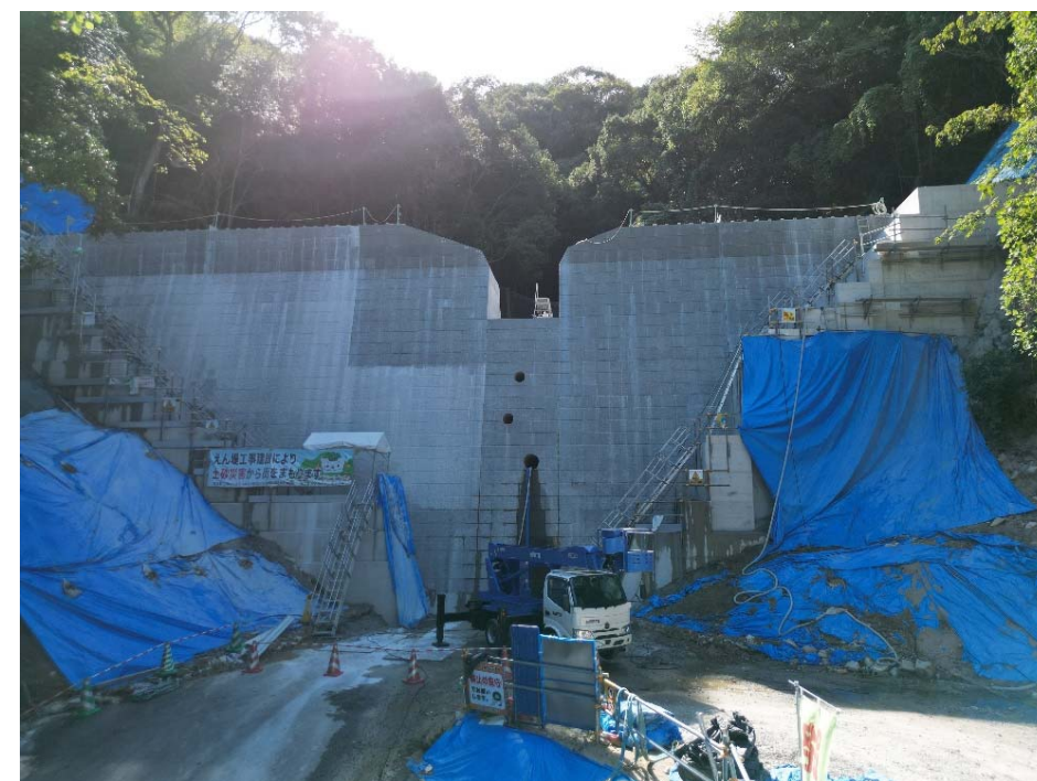
【施工箇所（下流側より）】
