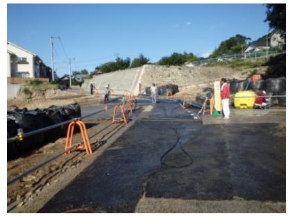
市道の仮復旧状況
