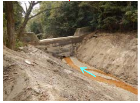
既設堰堤の除石状況
