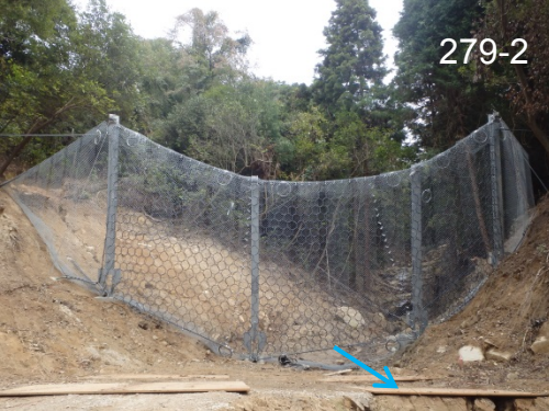
279-2 強靱ワイヤーネット設置状況
