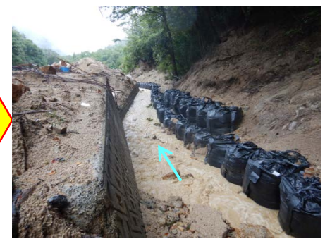
流路工(断面確保)実施状況
