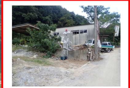
ワイヤーセンサー(警報装置)設置状況
