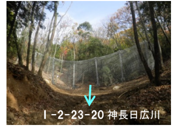
強靱ワイヤーネット設置状況
