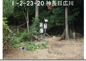
ワイヤーセンサー(警報装置)設置状況
