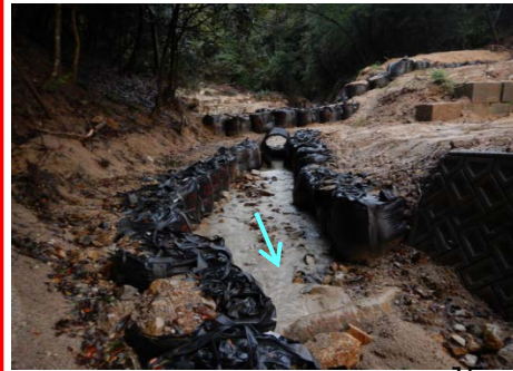
導流工実施状況
