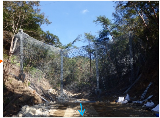
強靱ワイヤーネット設置状況(支川)
