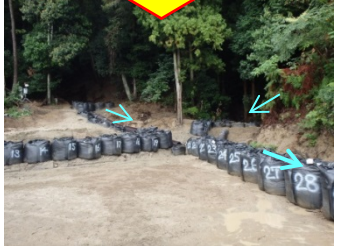
流路工(断面確保)実施状況
