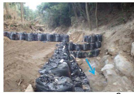
導流工実施状況
