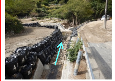
導流工実施状況(広島県施工)
