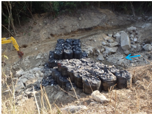
導流工実施状況
