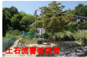
土石流警報装置設置状況
