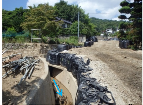
流路工(下流側)実施状況
