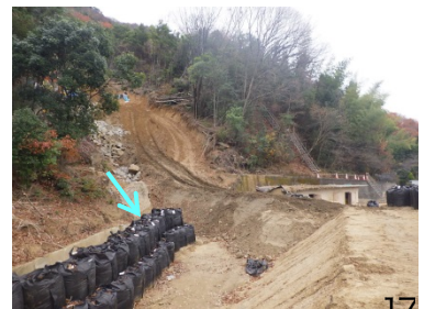
落石緩衝対策・巨石対策実施状況
