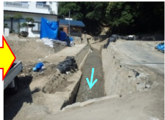
流路工(断面確保)実施状況
