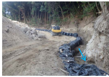
流路工実施状況
