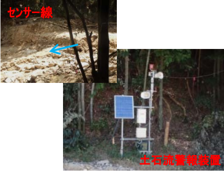
土石流警報装置設置状況
