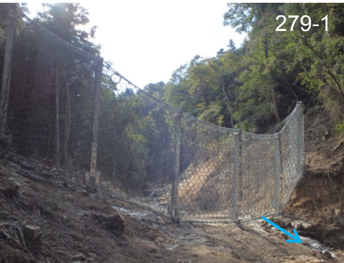
279-1 強靱ワイヤーネット設置状況
