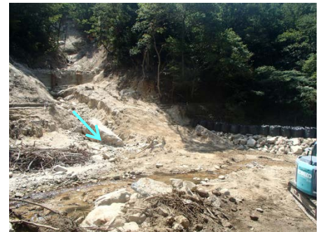
流路工実施状況
