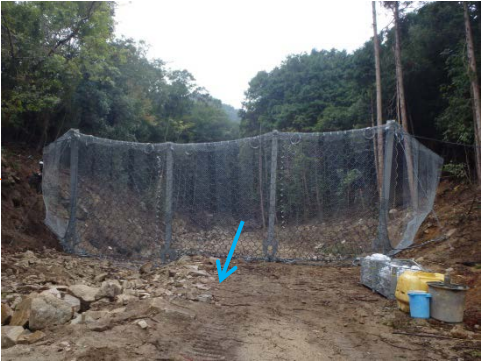
強靱ワイヤーネット設置状況
