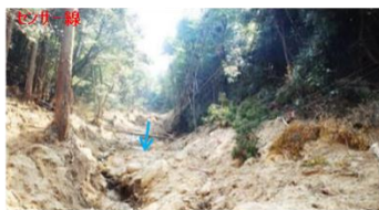
土石流警報装置設置状況
