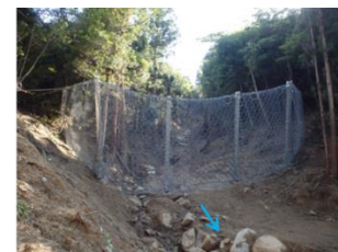
強靱ワイヤーネット設置状況
