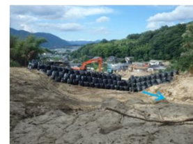
導流工実施状況
