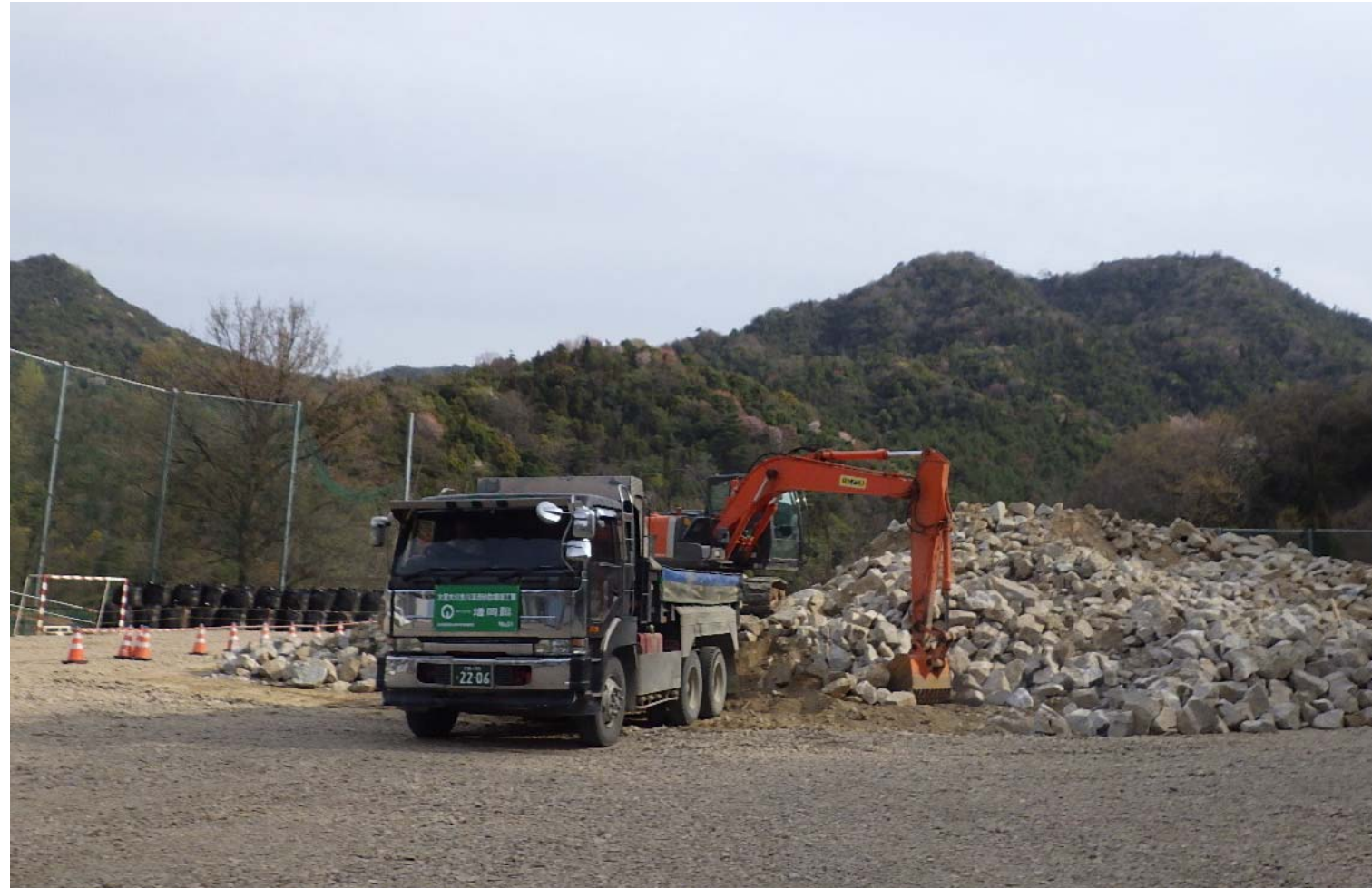
平成31年4月6日から工事用進入路を整備中
