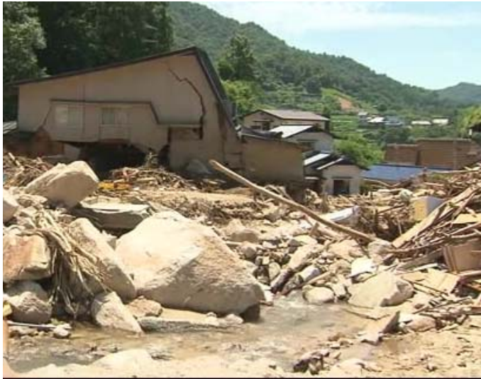
支川の背戸の川での土石流被害
