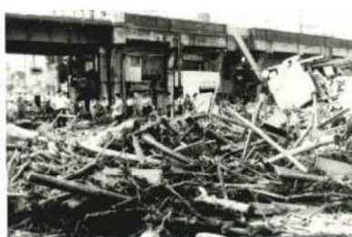
（中央区）ＪＲ高架北側の堆積土砂
