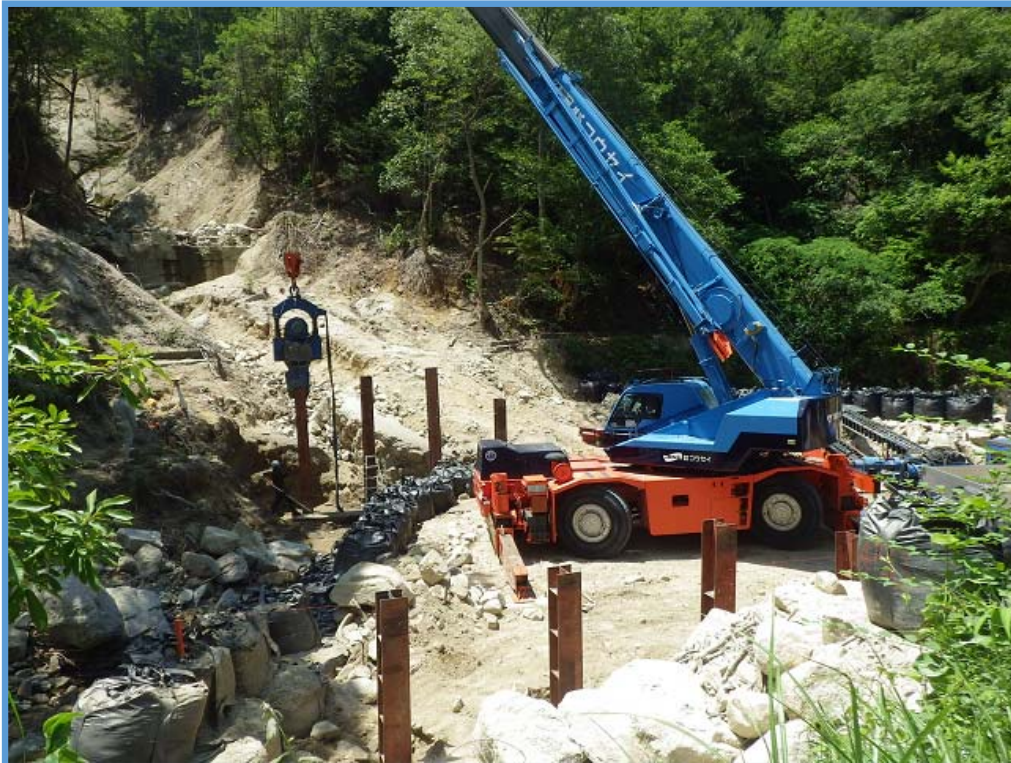
仮橋施工状況 ①
