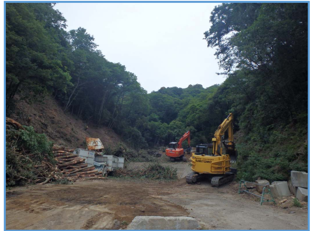
砂防堰堤の樹木伐採状況②
