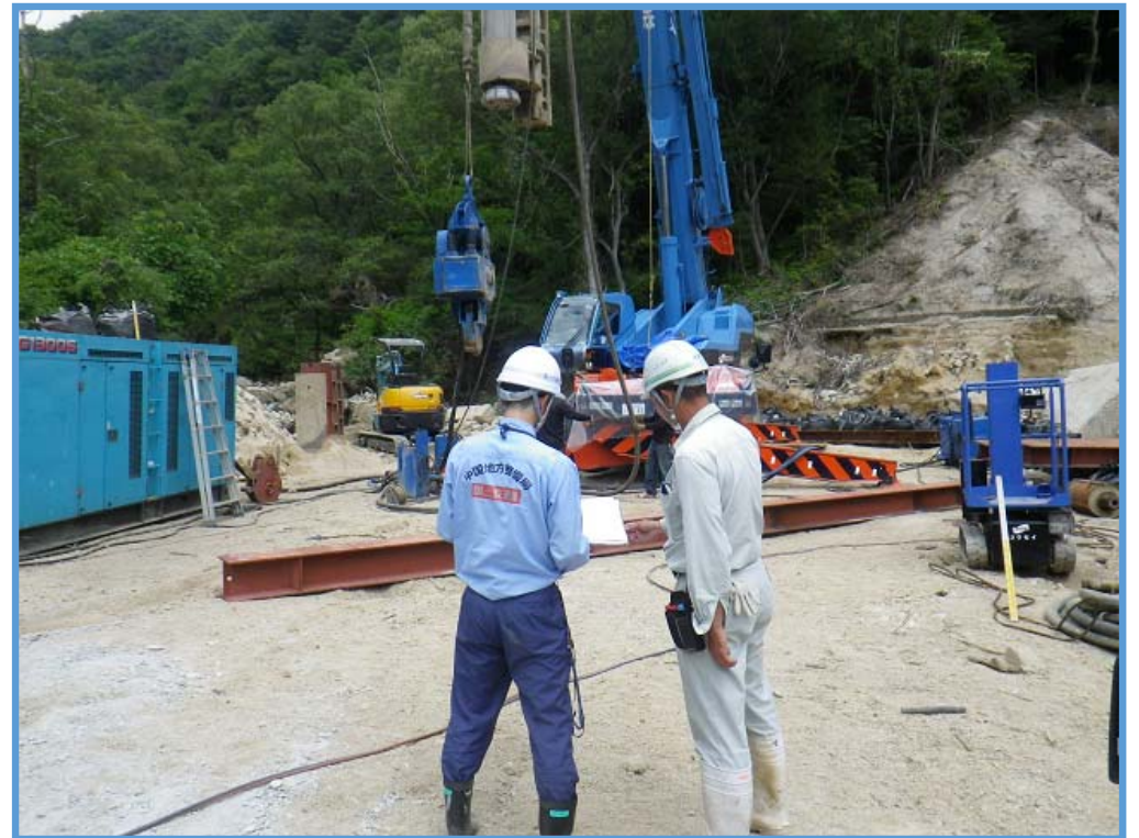
仮橋施工状況 ②
