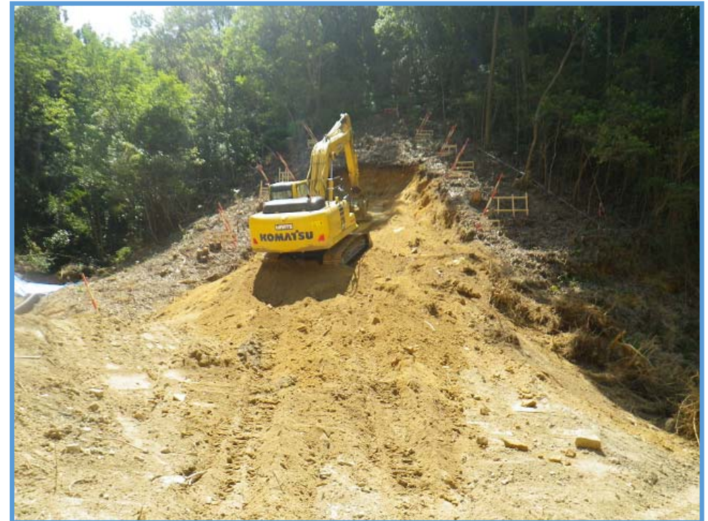
砂防堰堤の本体掘削状況②
