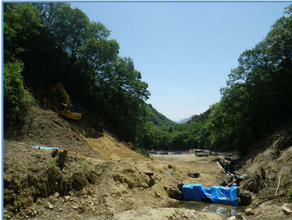
砂防堰堤の本体掘削状況①
