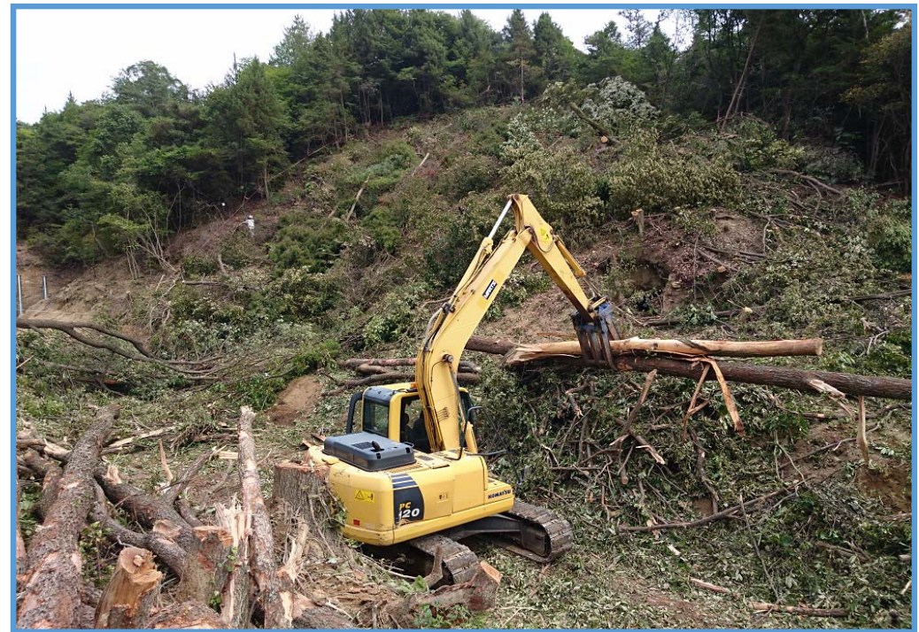
砂防堰堤の樹木伐採状況②
