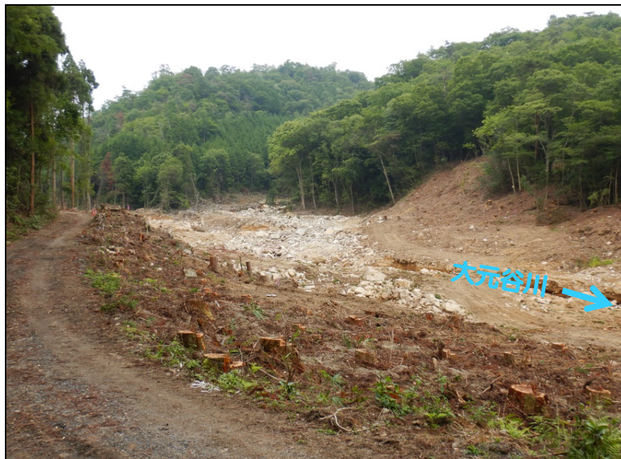
伐木・伐採完了状況（全体）
