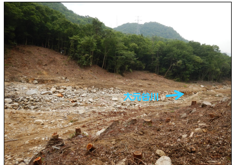
伐木・伐採完了状況（左岸側）
