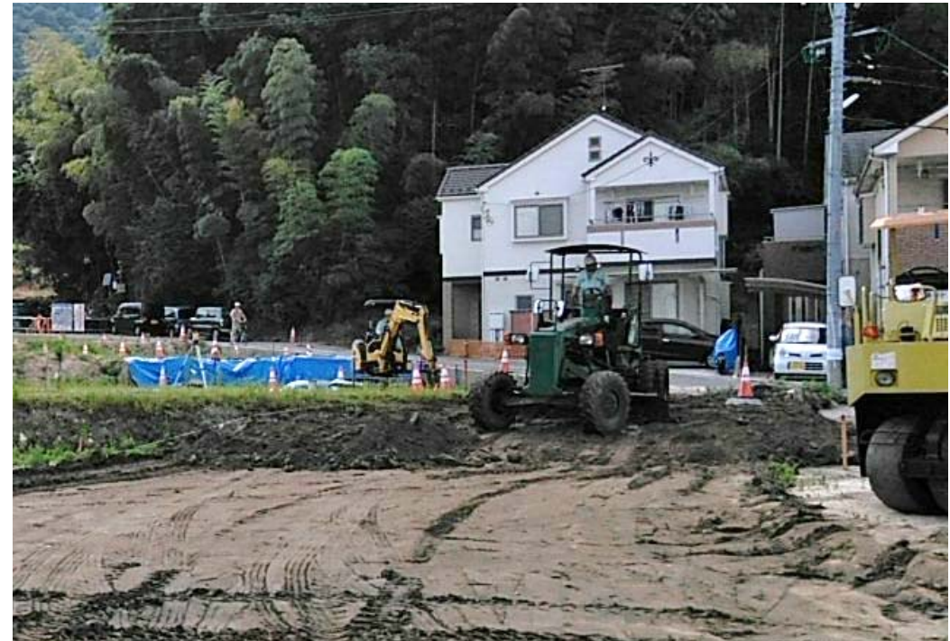
グレーダーによる敷均し
