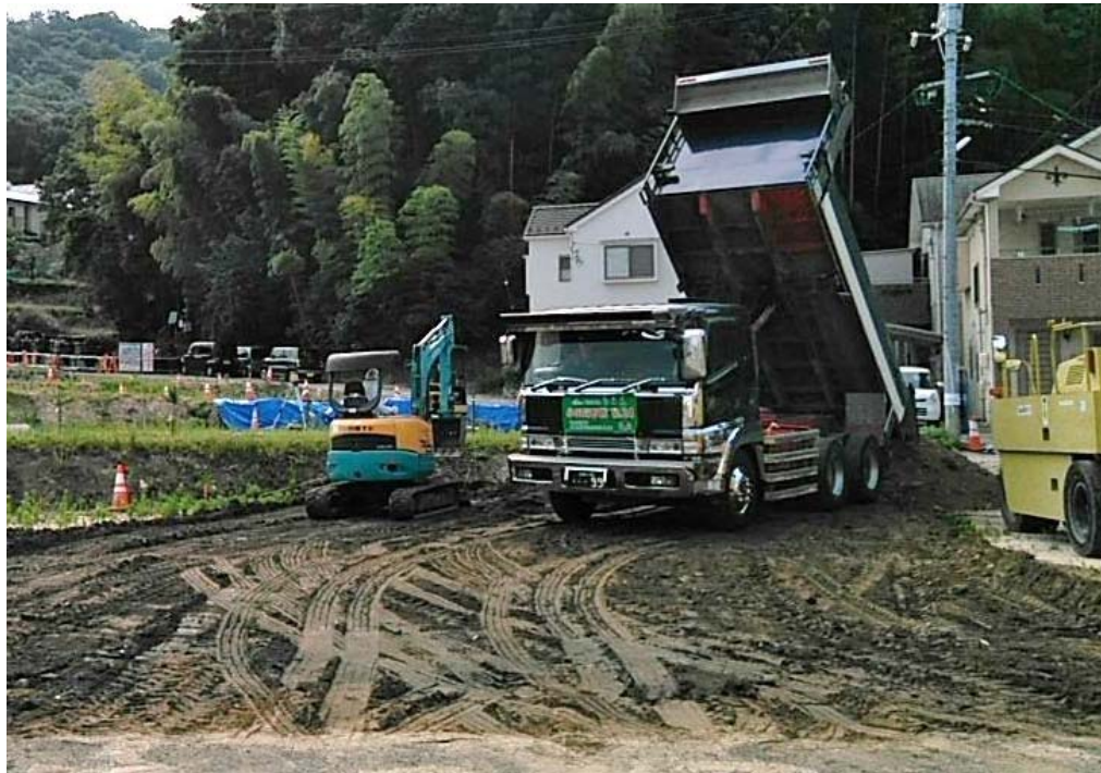
ダンプトラックによる土砂投入
