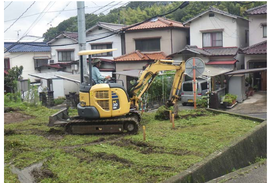
バックホウによる掘削
