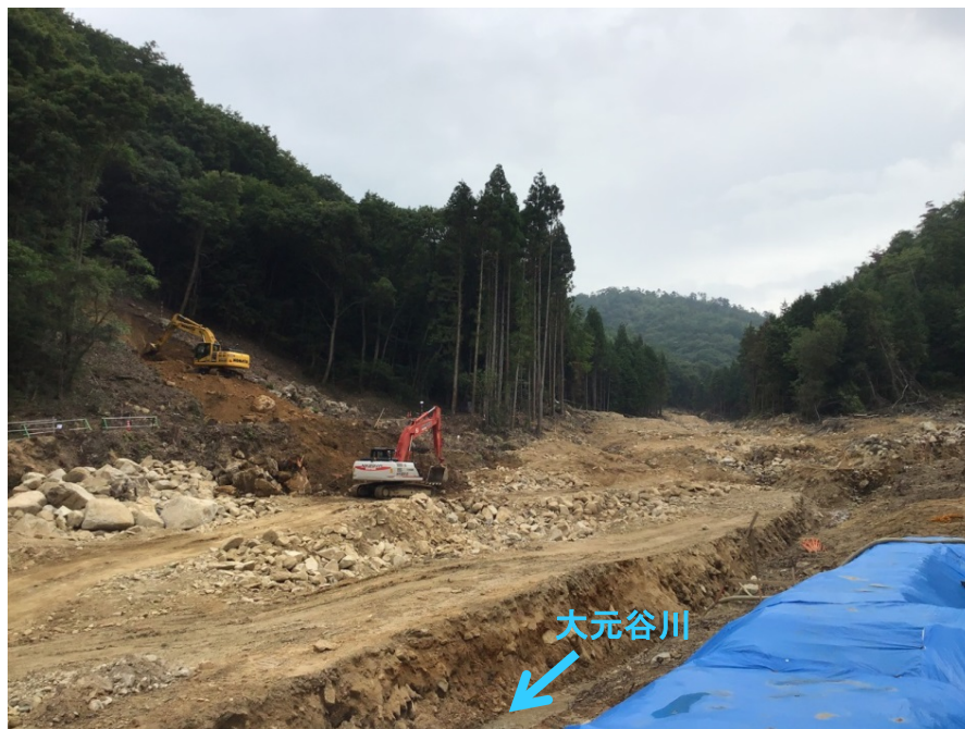
砂防堰堤の本体 実施状況（全体）
