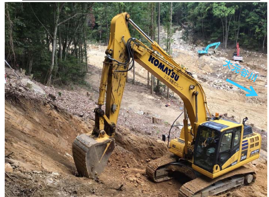
砂防堰堤の本体実施状況（右岸側）
