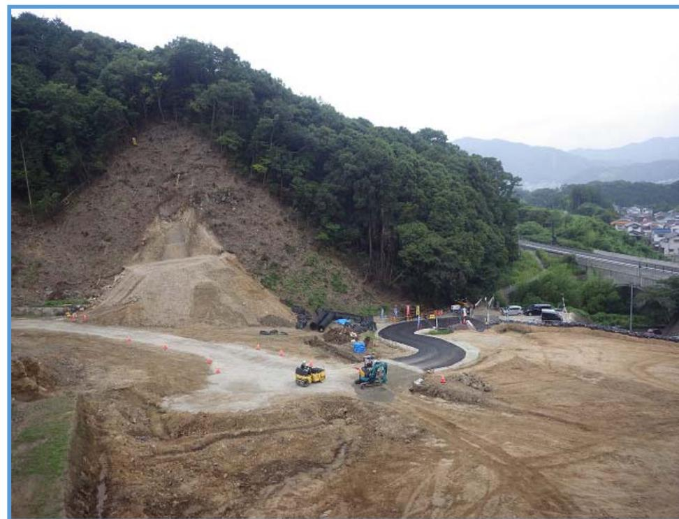
砂防堰堤の本体掘削状況 ②
