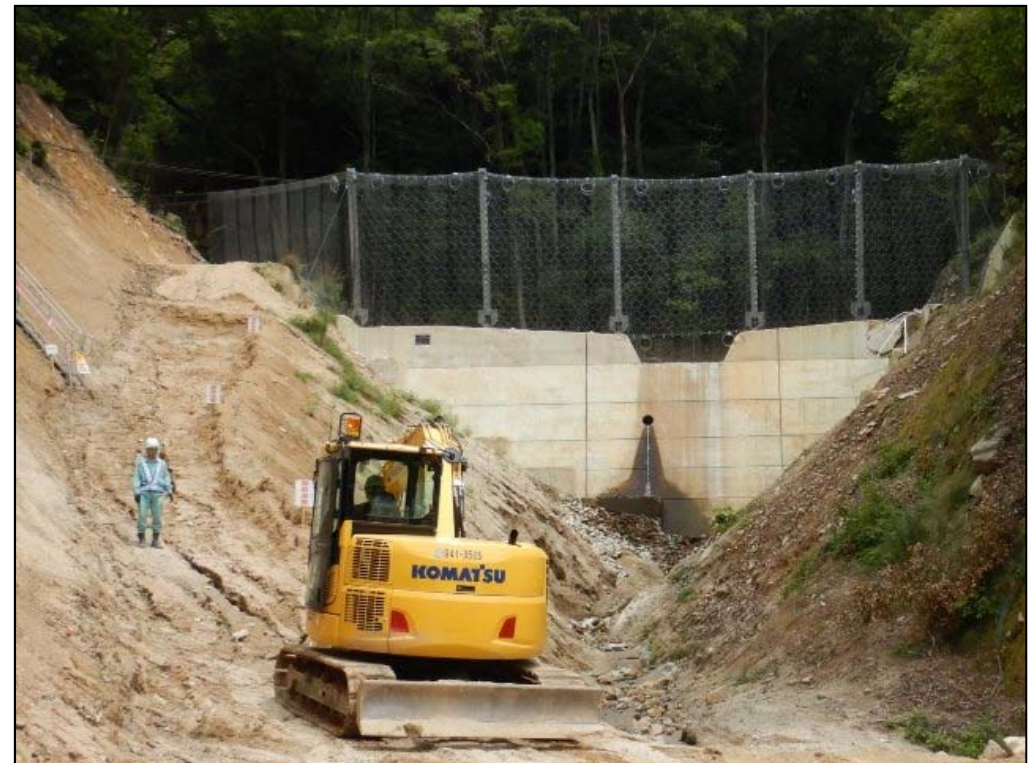
作業ヤード整備状況②
