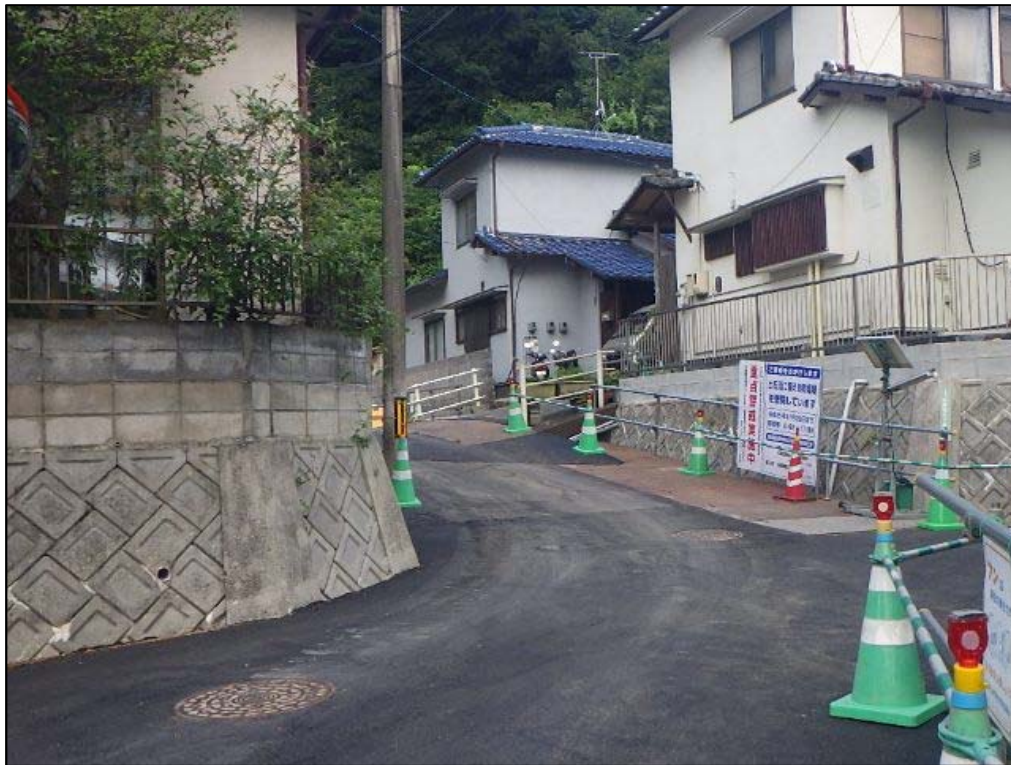
道路拡幅状況
