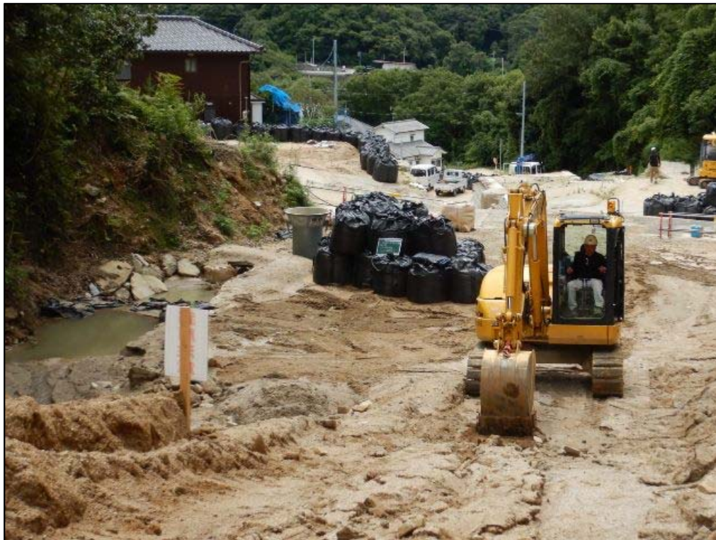
作業ヤード整備状況①
