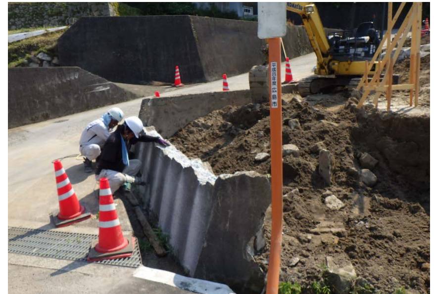
既設構造物取壊し
