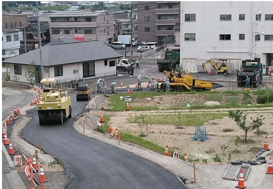
舗装工の施工状況
