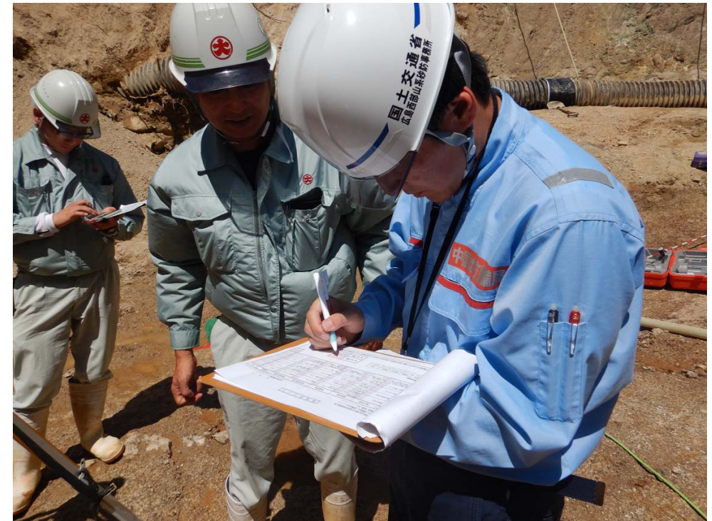
砂防堰堤の本体掘削確認状況
