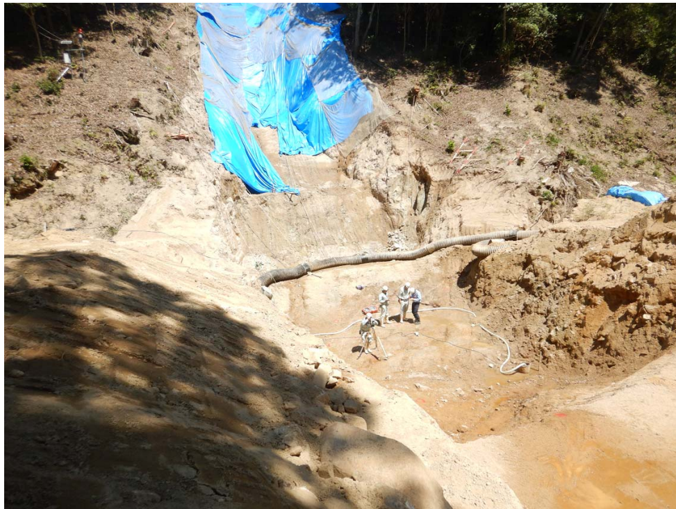
砂防堰堤の本体掘削状況
