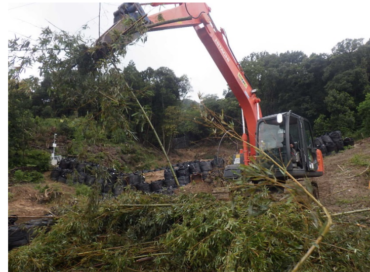
伐採状況 (工事用道路)
