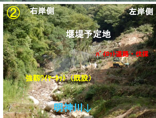
明神川砂防堰堤付近 伐採状況
