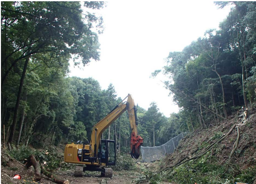
本堤左岸部 伐採着手
