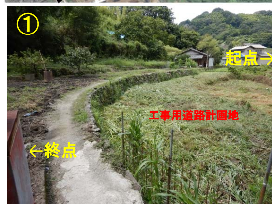
明神川工事用道路 伐採状況
