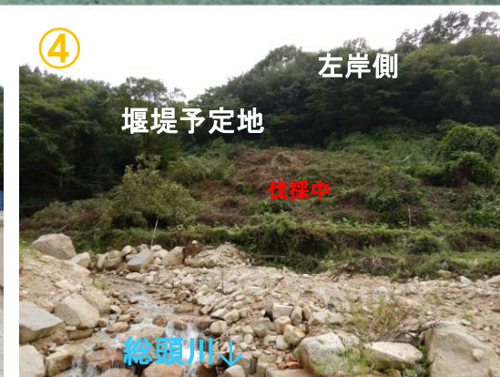
総頭川砂防堰堤付近 伐採状況
