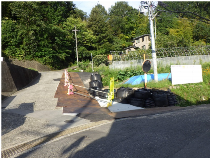
進入路拡幅状況
