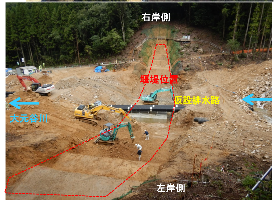
砂防堰堤の本体掘削状況 ②
