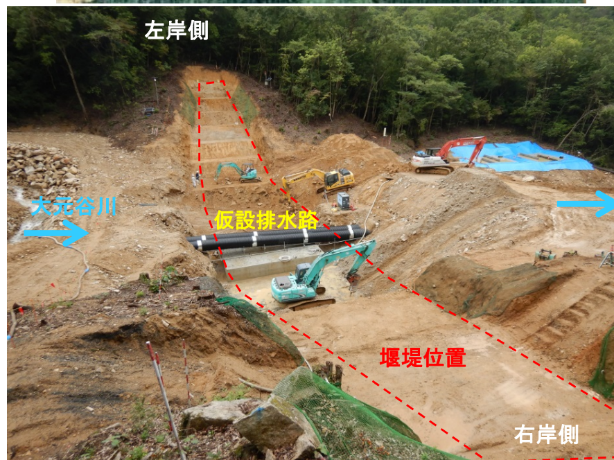
砂防堰堤の本体掘削状況 ①
