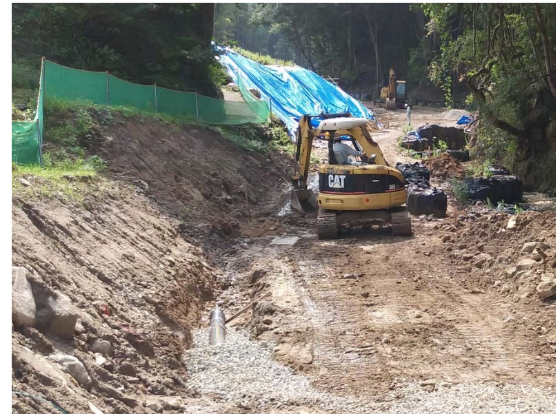
工事用道路施工状況
