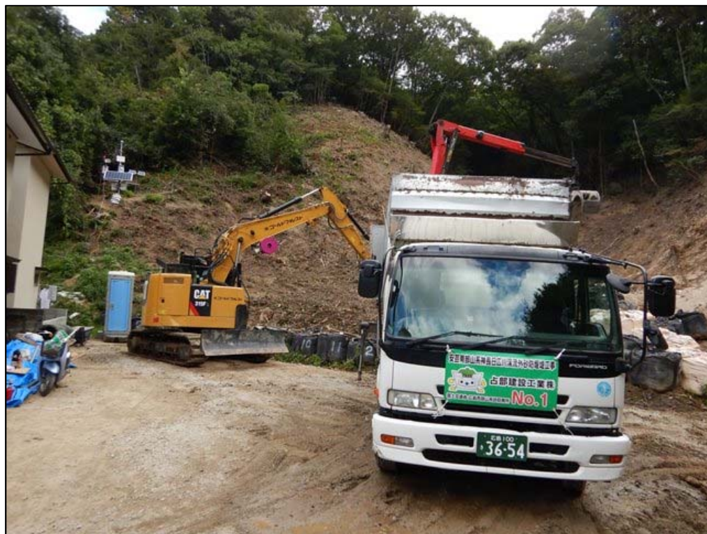
伐採木搬出状況
