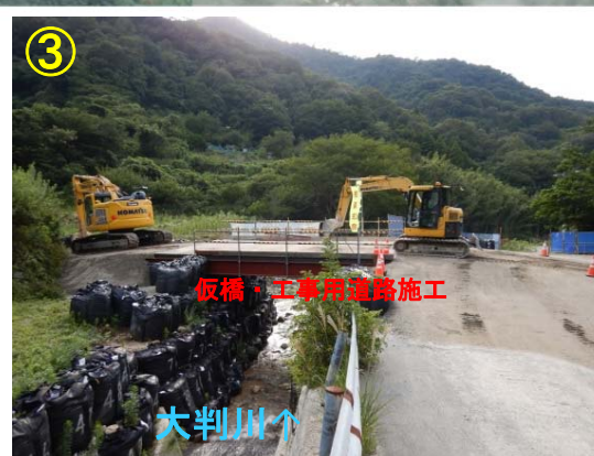
大判川渡河仮橋 設置状況
