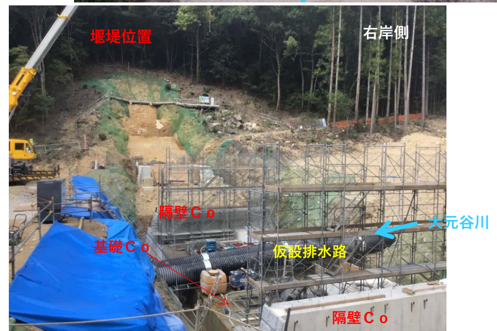
堰堤基礎コンクリート施工②
