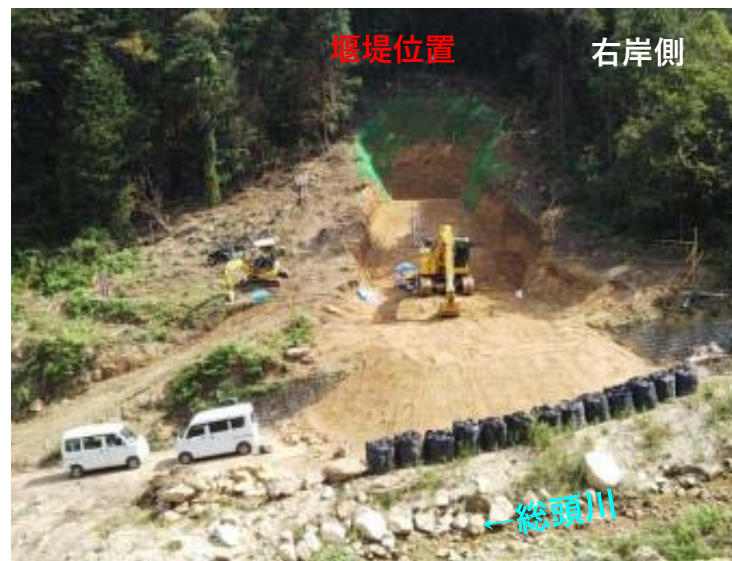
総頭川掘削状況（右岸側）
