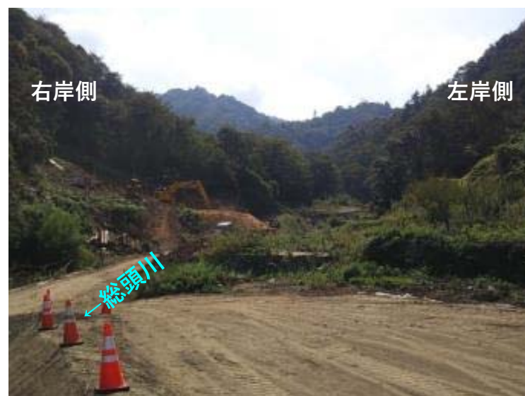
総頭川掘削状況（下流より）
