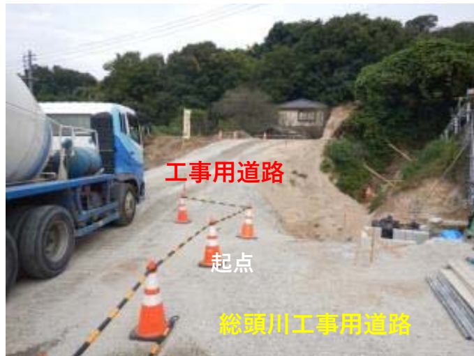
工事用道路起点部
