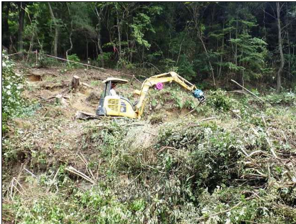
伐採作業状況①
