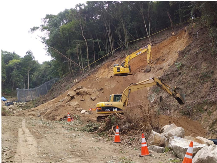
砂防堰堤左岸部 掘削状況
