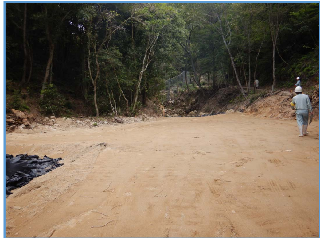
工事道路の整備状況
