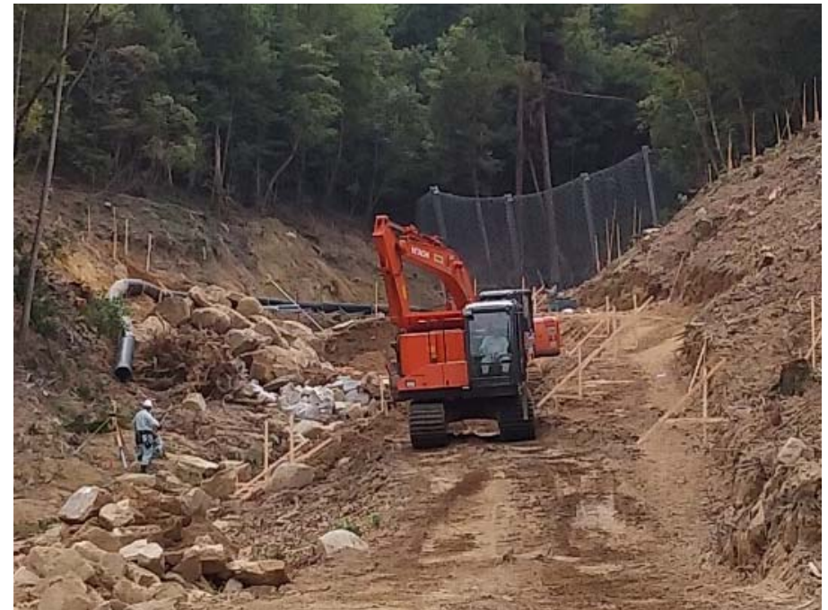
不整地運搬車による掘削残土の搬出
