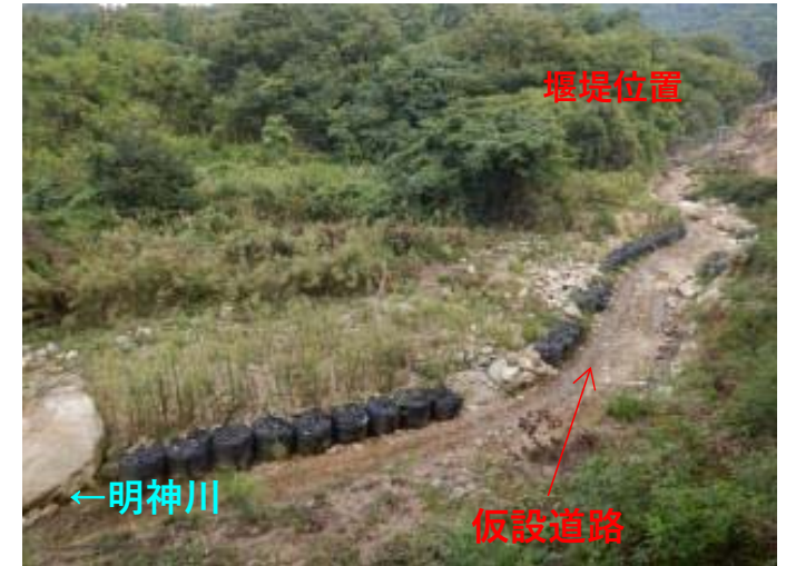
工事用道路（堰堤下流部）
