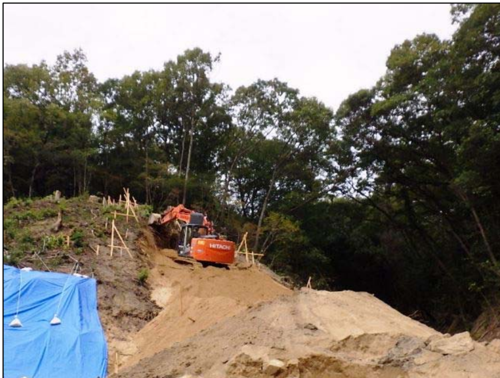
砂防堰堤の掘削状況①
