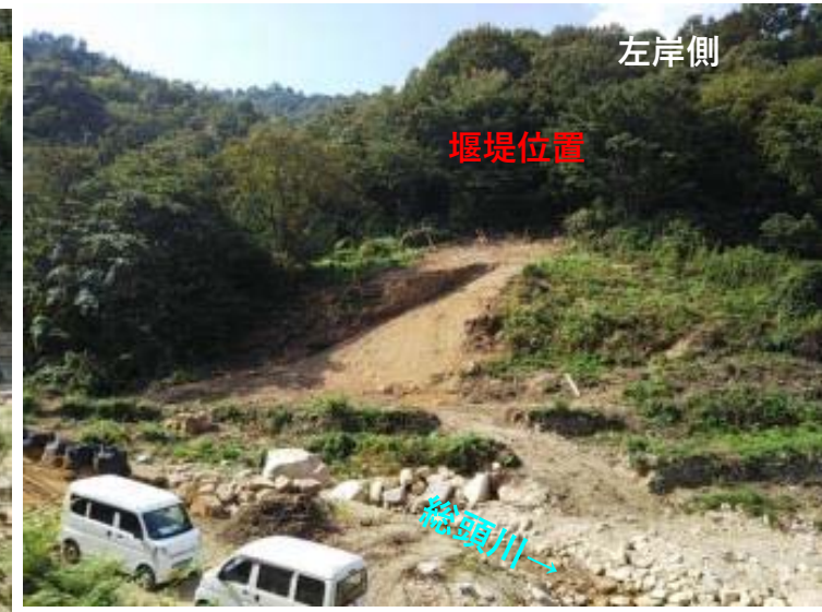
総頭川掘削状況（左岸側）
