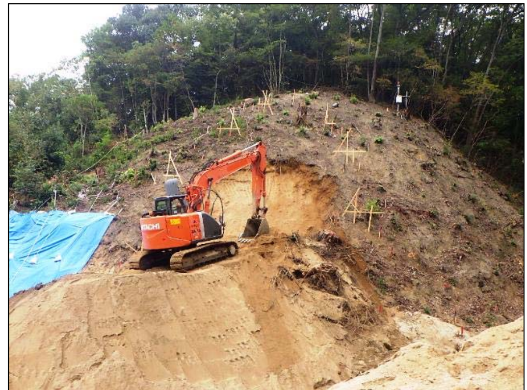
砂防堰堤の掘削状況②
