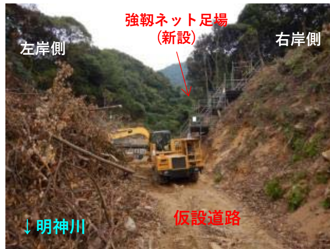
強靱ワイヤーネット施工状況
