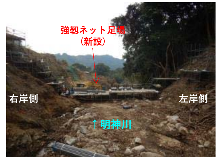
強靱ワイヤーネット仮設足場設置状況
