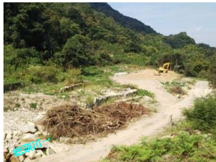
総頭川仮設ヤード施工状況
