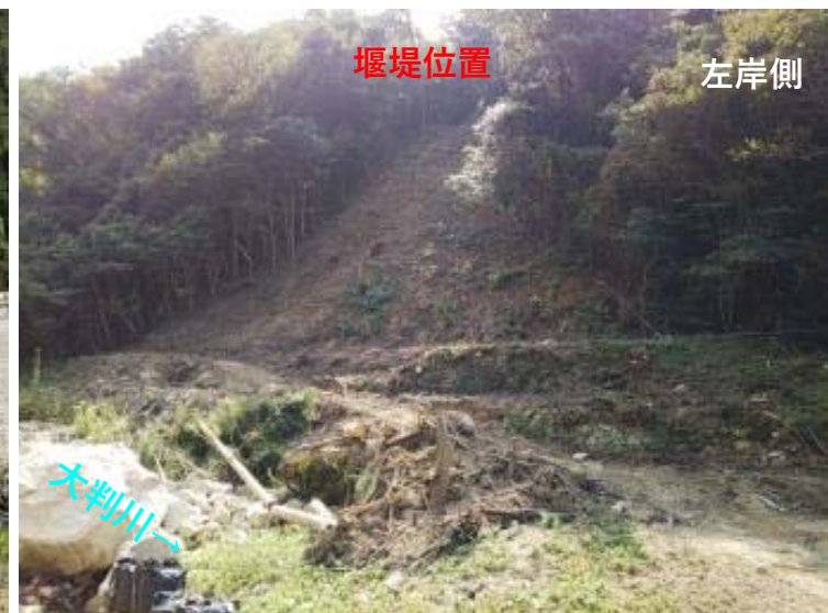
大判川伐採木搬出状況（左岸側）
