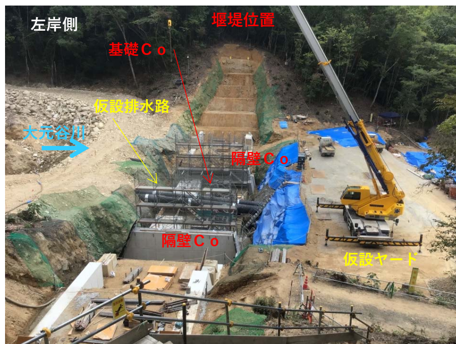
堰堤基礎コンクリート施工①
