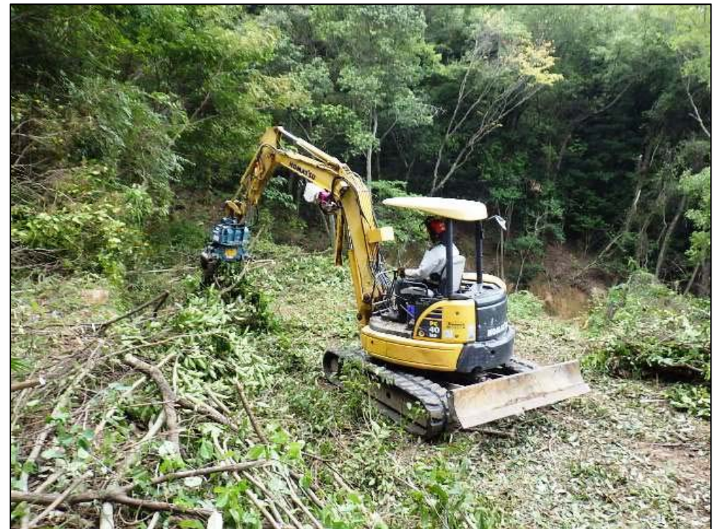
伐採作業状況②
