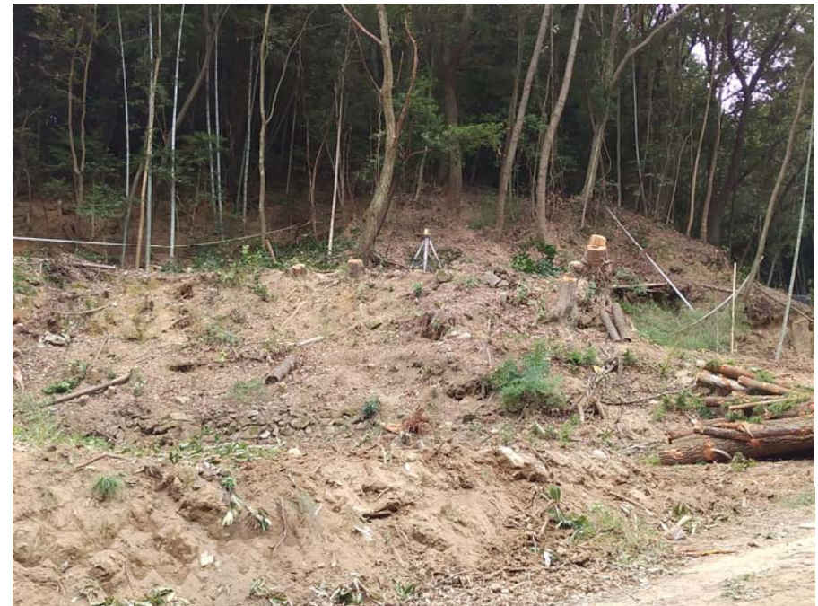
砂防堰堤右岸部 伐採状況
