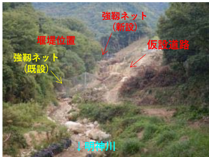
仮設道路（堰堤下流部）
