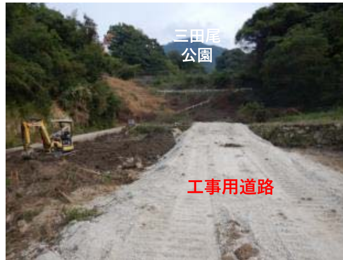
工事用道路（三田尾公園手前）
