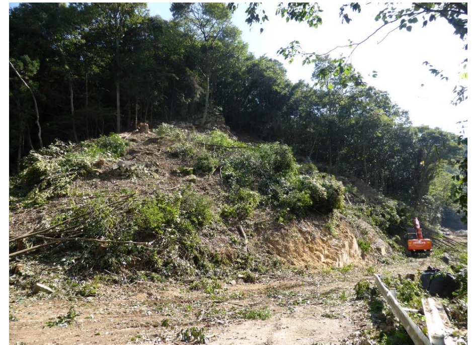
伐採状況（右岸側）
