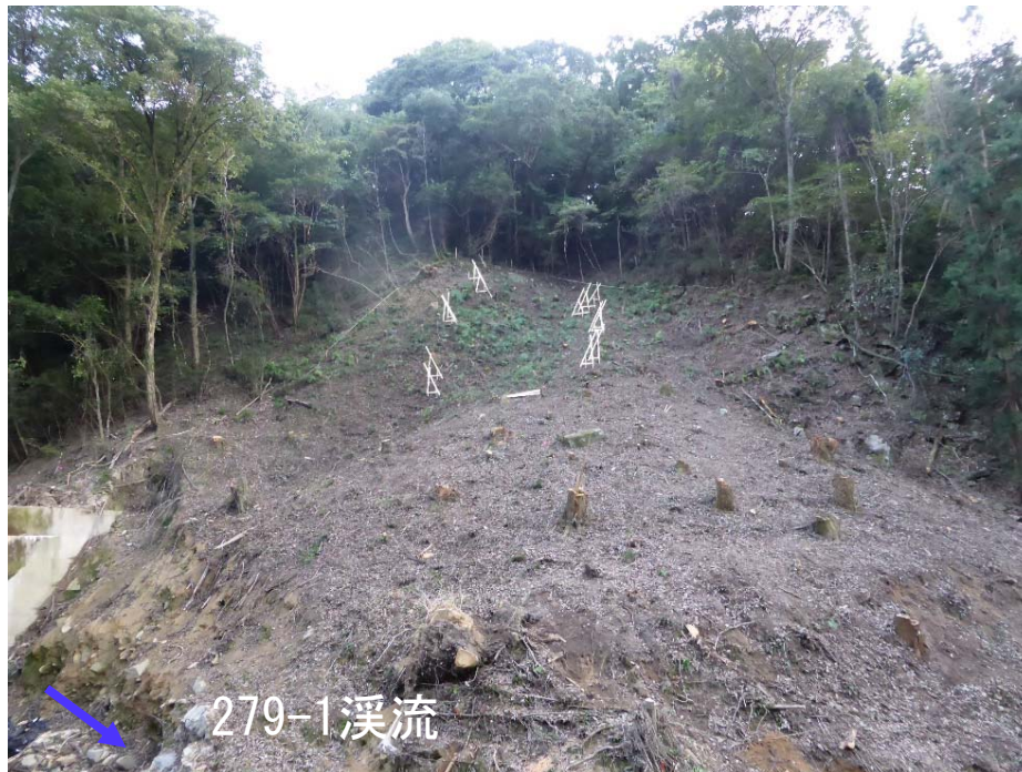
伐採状況（左岸側）
