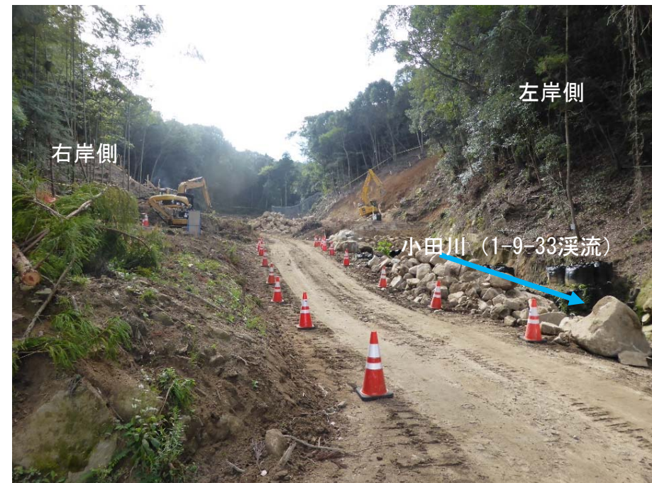
砂防堰堤施工状況（全景）
