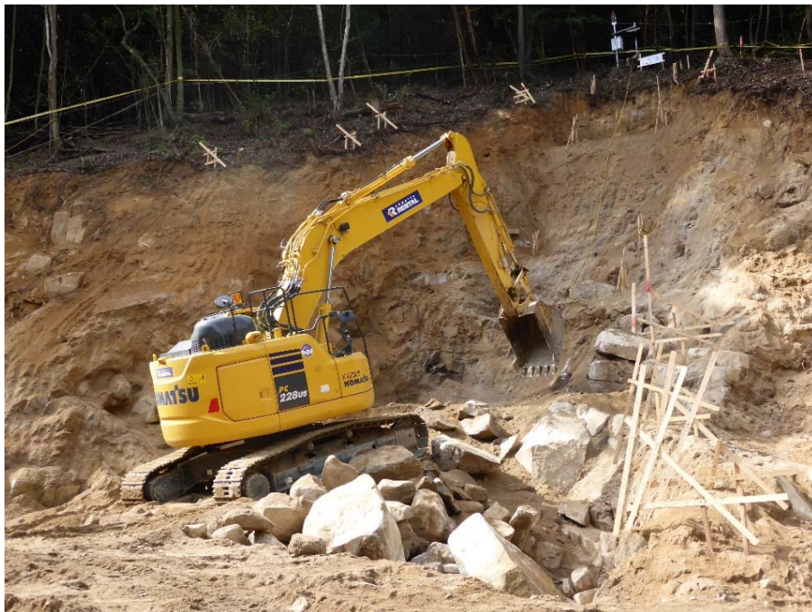
砂防堰堤（左岸側）掘削状況
