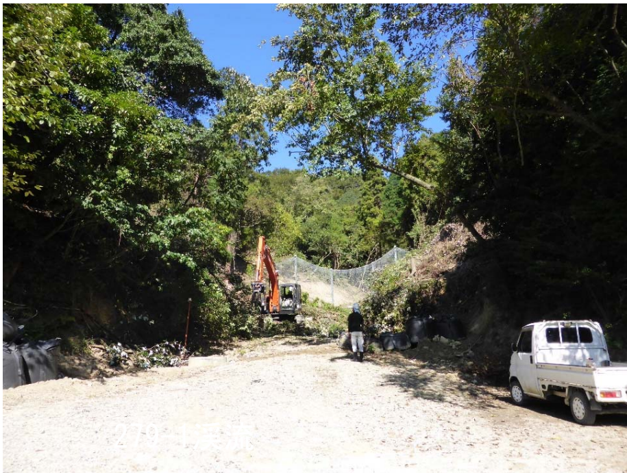
伐採状況 (全景)
