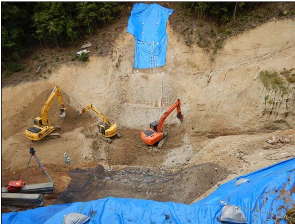
掘削状況①
