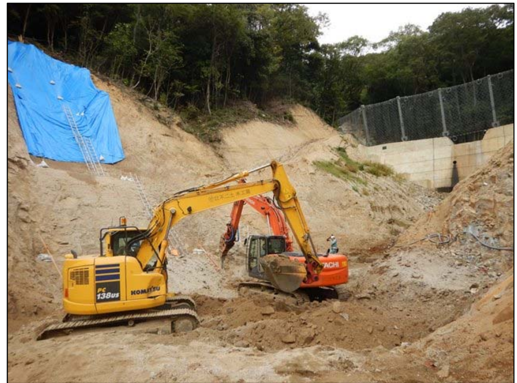
掘削状況②
