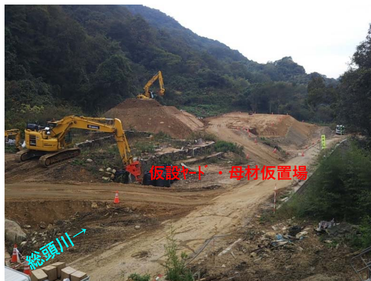
総頭川仮設ヤード施工状況
