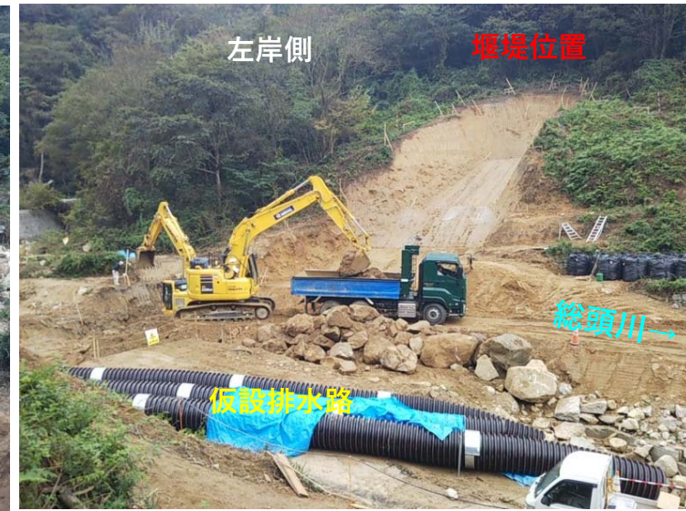
総頭川掘削状況（左岸側）
