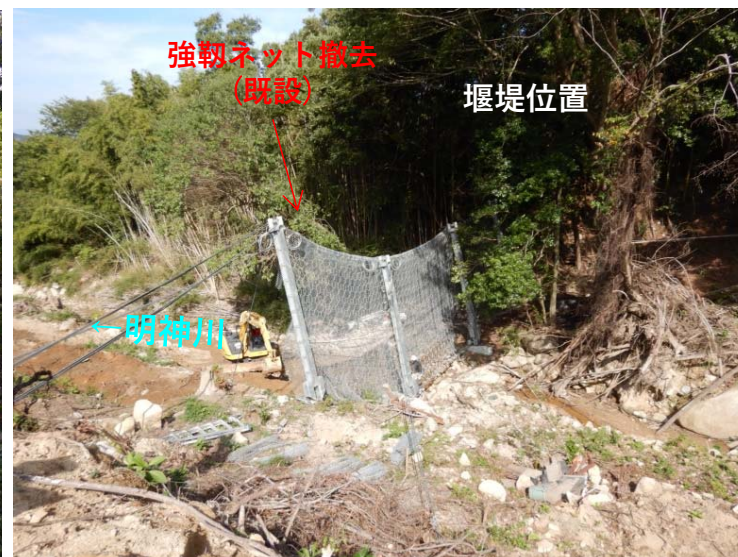
既設強靱ワイヤネット撤去状況
