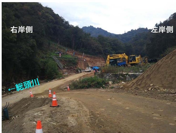
総頭川掘削状況（下流より）
