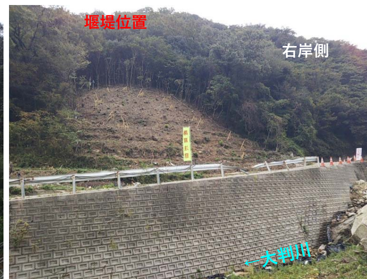
大判川堰堤状況（右岸側）
