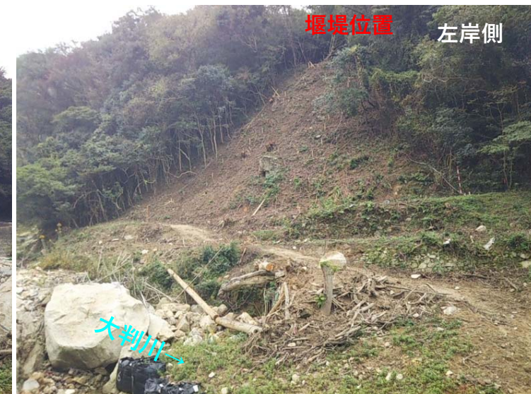
大判川堰堤状況（左岸側）
