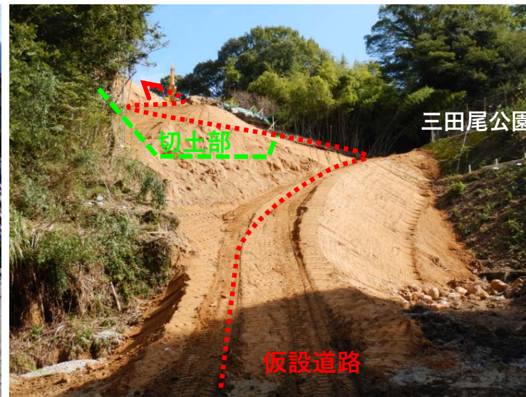
工事用道路（三田尾公園手前）
