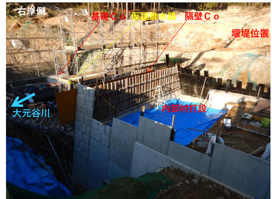
堰堤基礎コンクリート施工 ②
