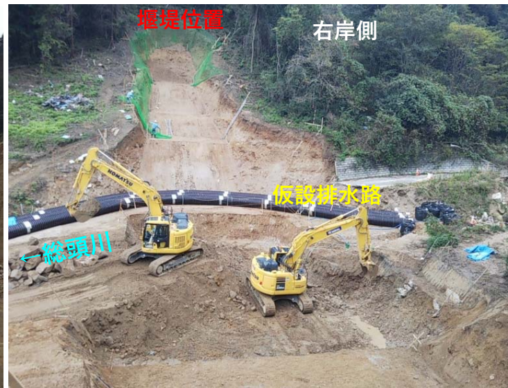
総頭川掘削状況（右岸側）
