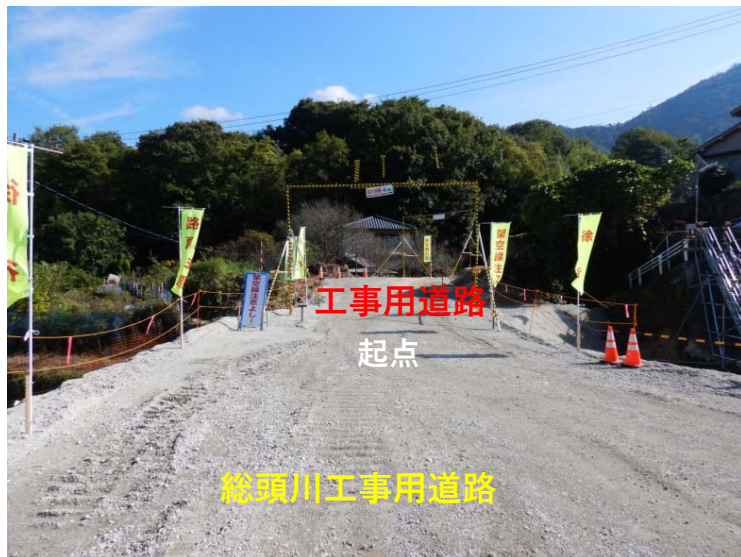
工事用道路起点部
