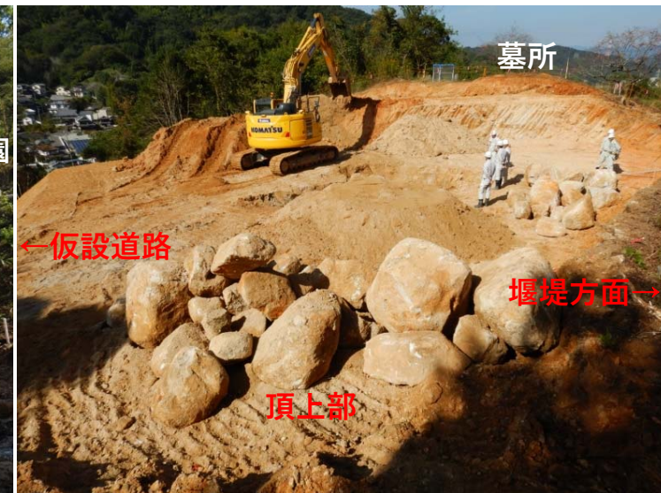
工事用道路（切土状況）
