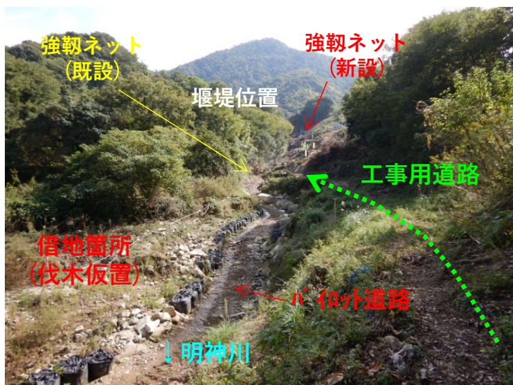
パイロット道路（堰堤下流部）
