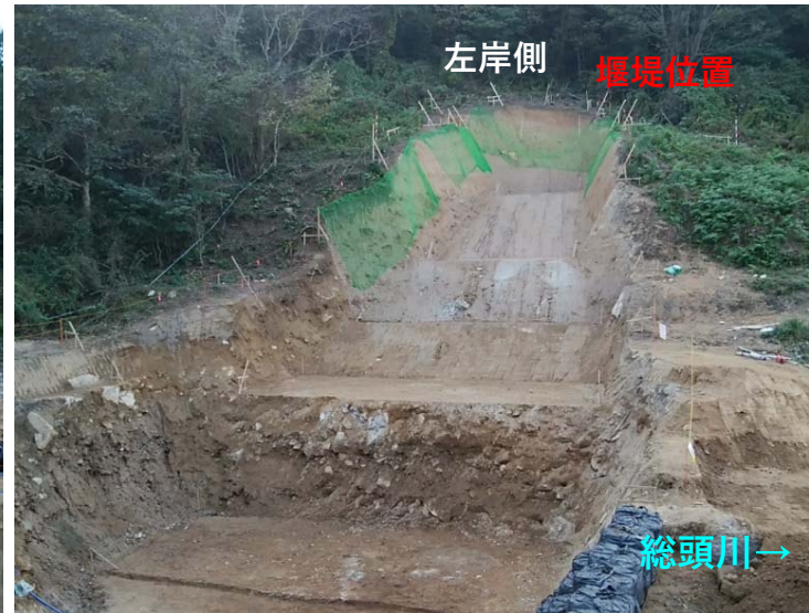
掘削完了（左岸側）
