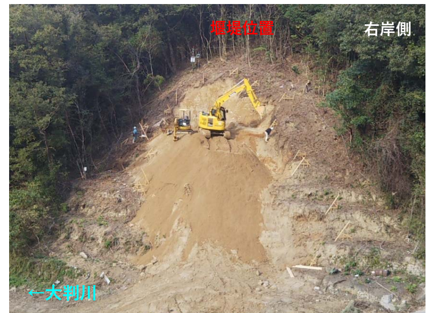
掘削状況（右岸側）
