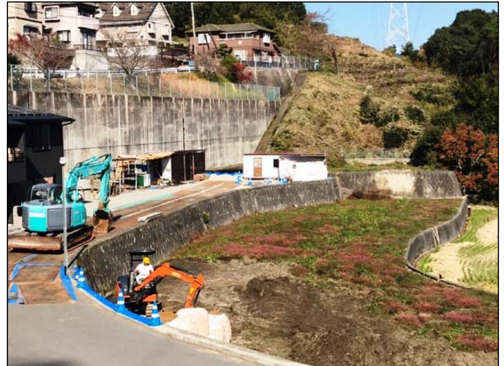
進入路施工状況
