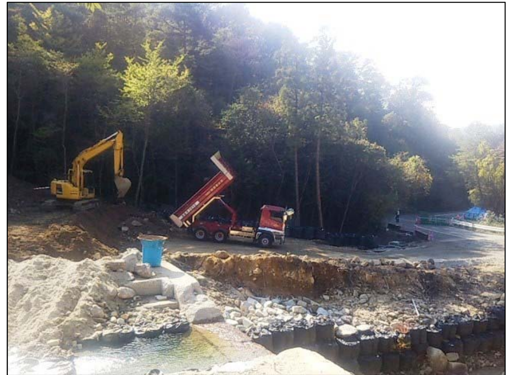
進入路施工状況
