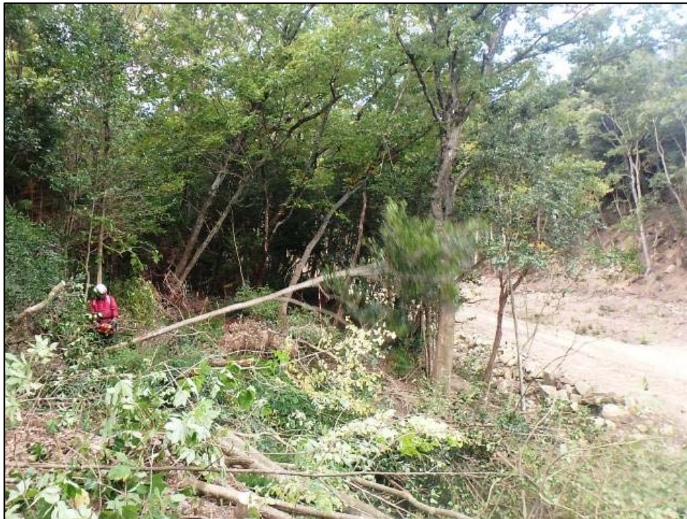
伐採作業状況
