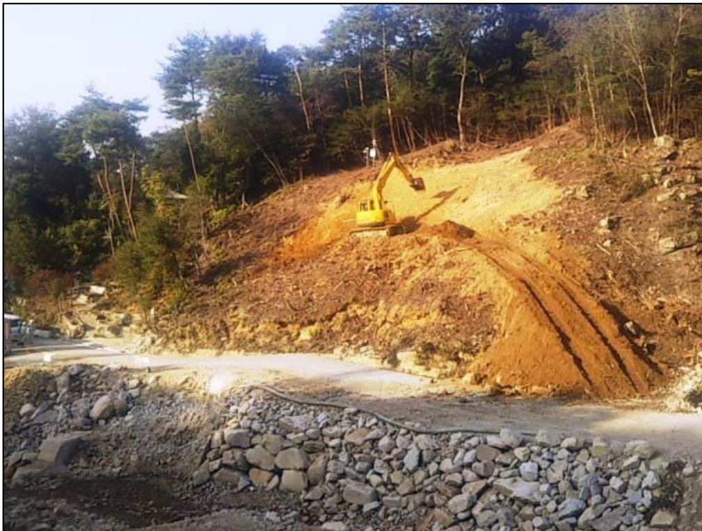
右岸掘削状況
