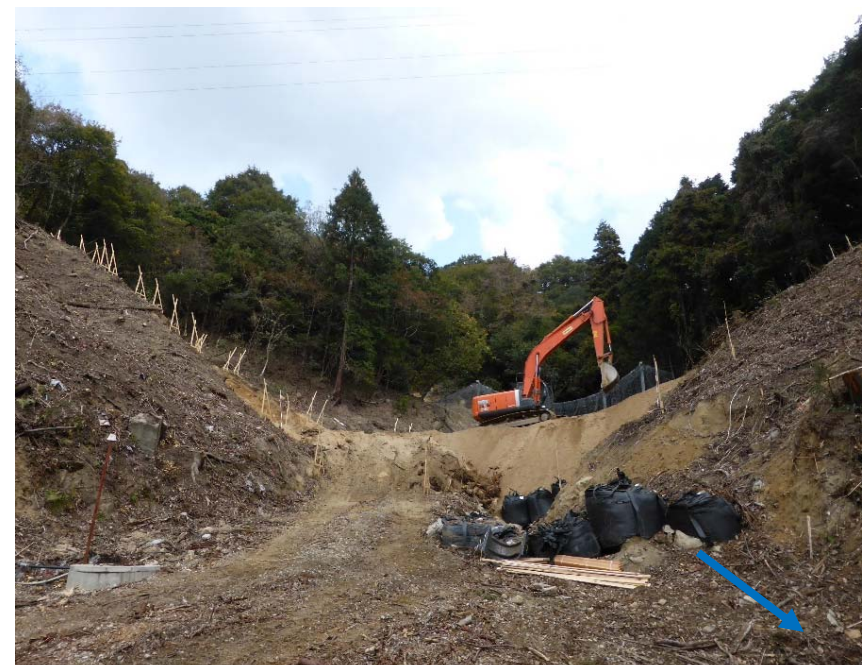
作業ヤード整備
