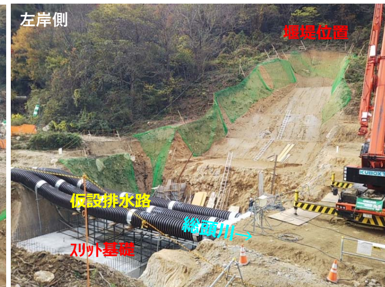
総頭川掘削状況（左岸側）
