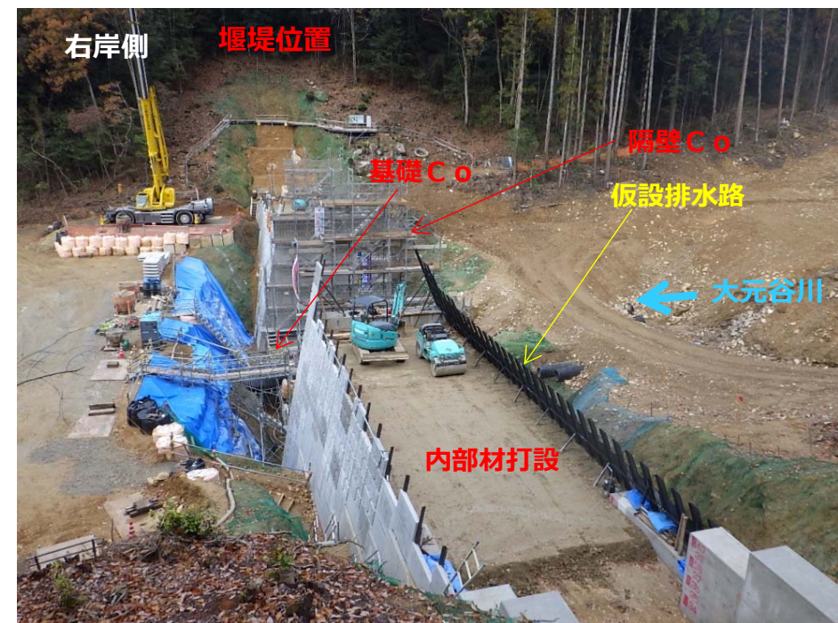
堰堤コンクリート施工②
