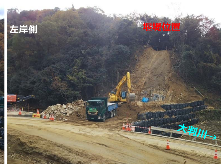
大判川掘削状況（左岸側）
