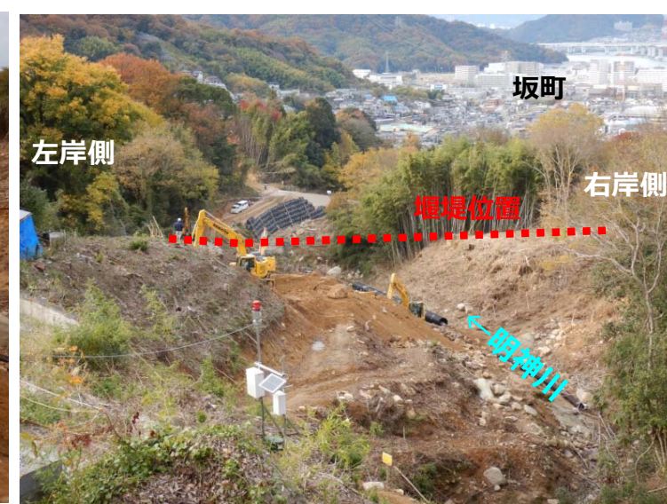
堰堤掘削状況(上流より)
