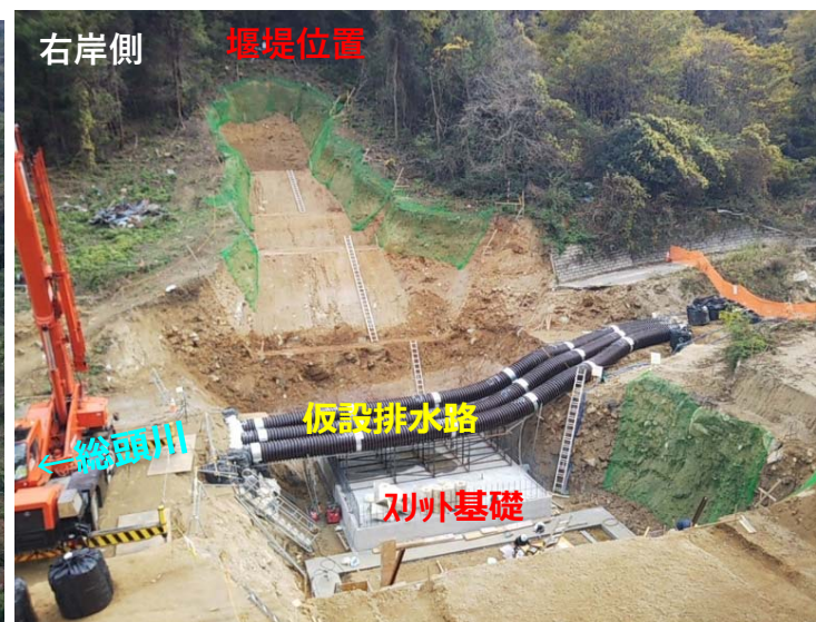
総頭川掘削状況（右岸側）
