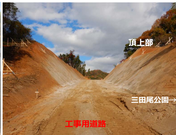
工事用道路（三田尾公園手前）
