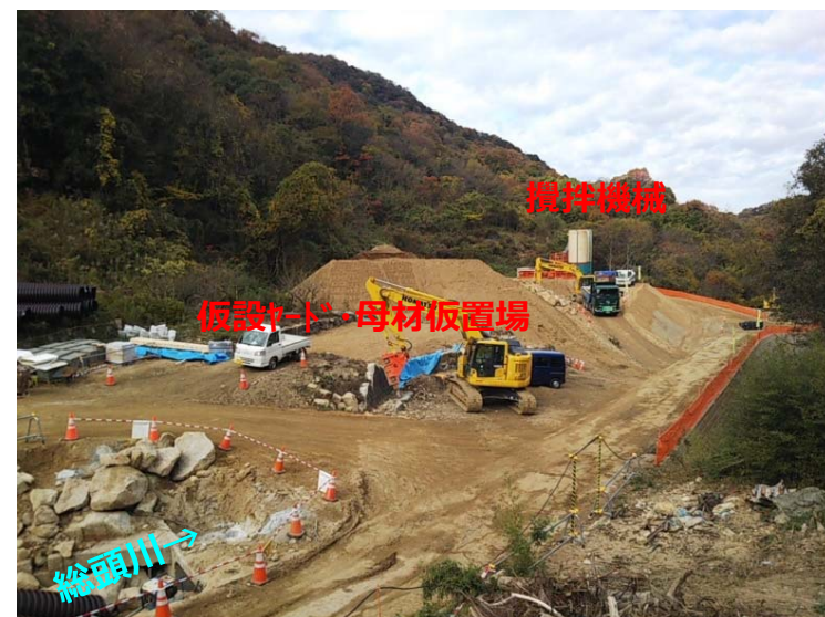
総頭川仮設ヤード施工状況
