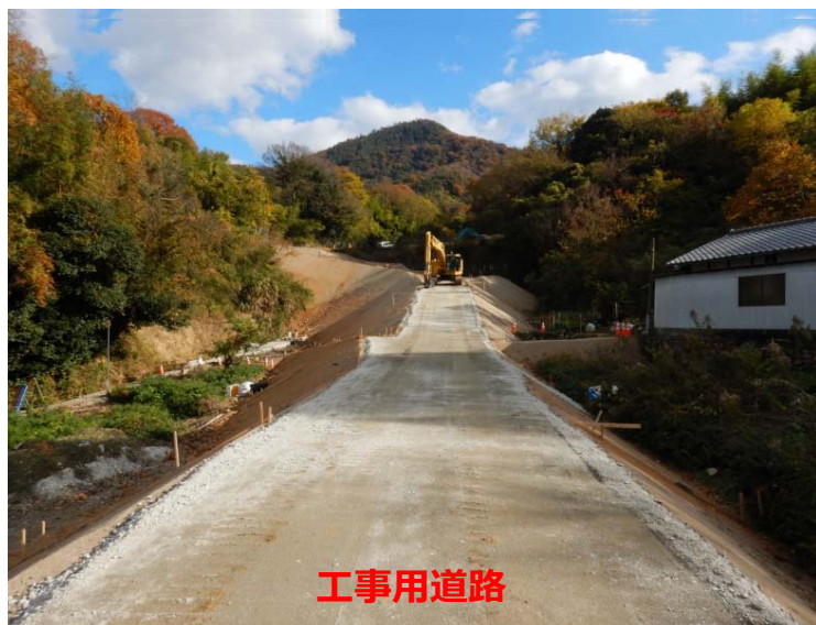
工事用道路起点部
