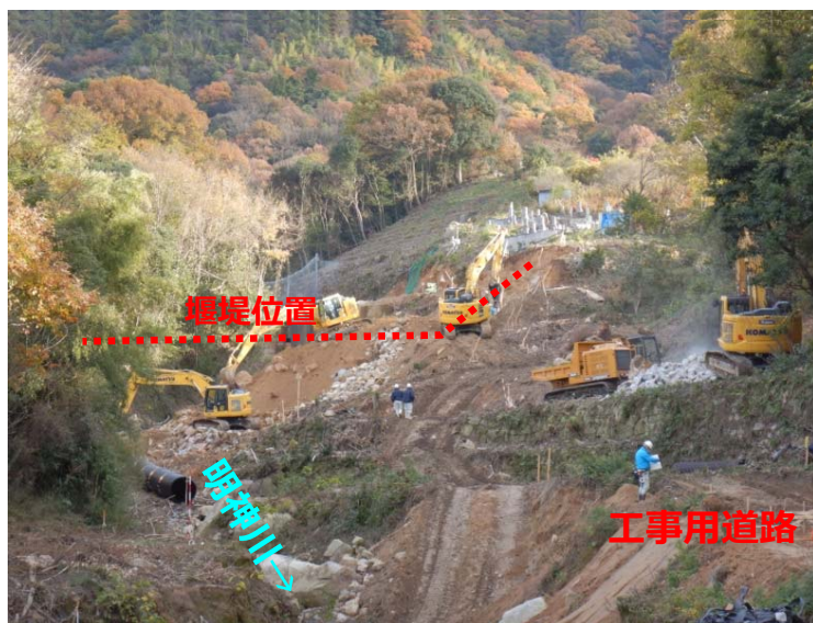
堰堤掘削状況(下流より)
