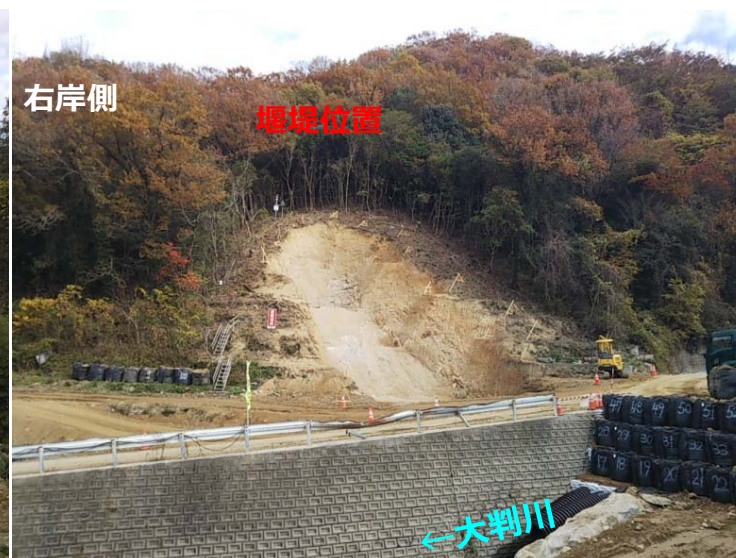
大判川掘削状況（右岸側）
