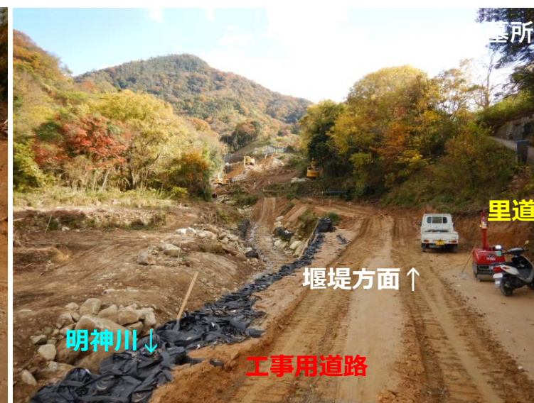
工事用道路（切土状況）
