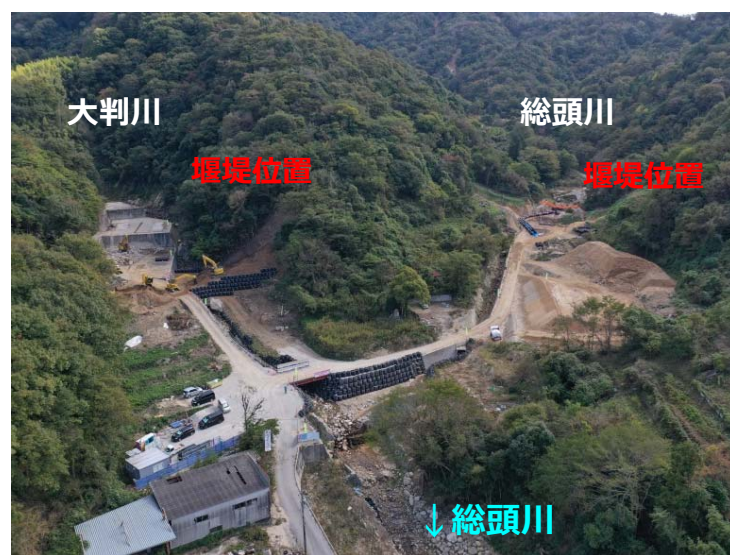
総頭川掘削状況（下流より）
