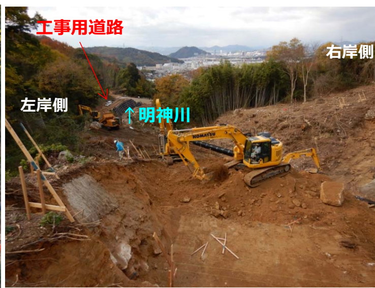
堰堤左岸掘削状況
