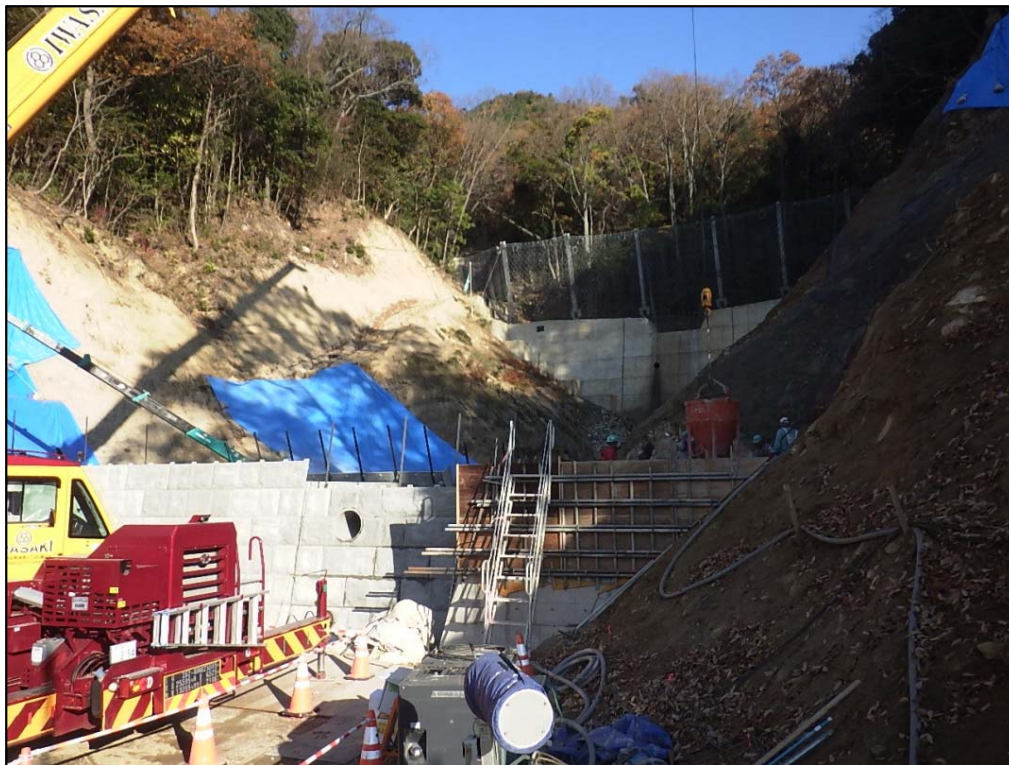
コンクリート打設状況①
