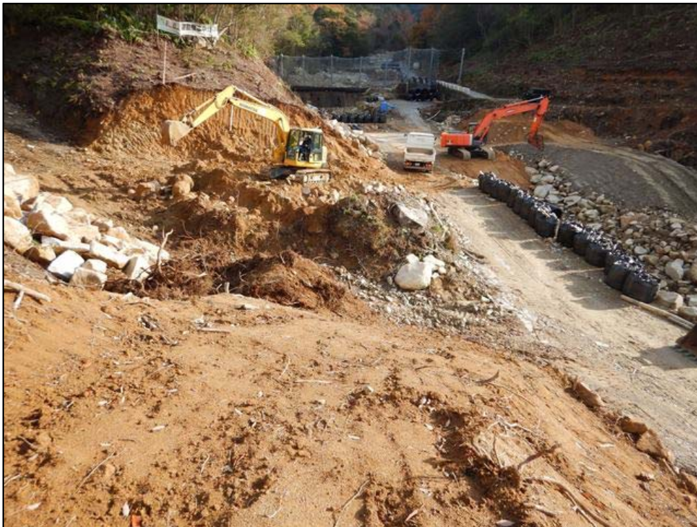
施工状況①
