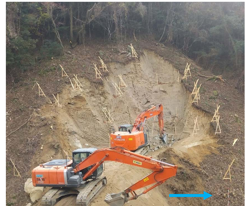
左岸側掘削状況
