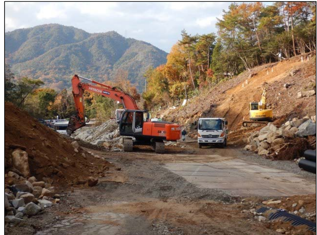
施工状況②
