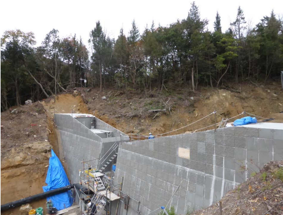
打設前状況 (12月5日)
