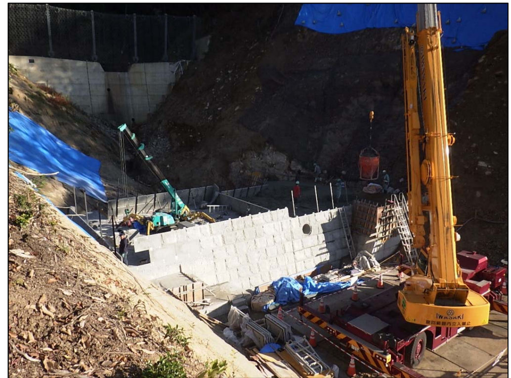
コンクリート打設状況②
