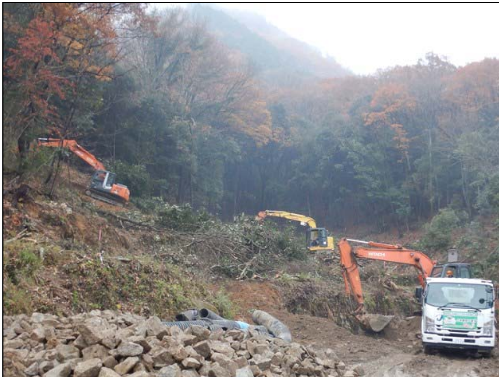
砂防堰堤箇所施工状況
