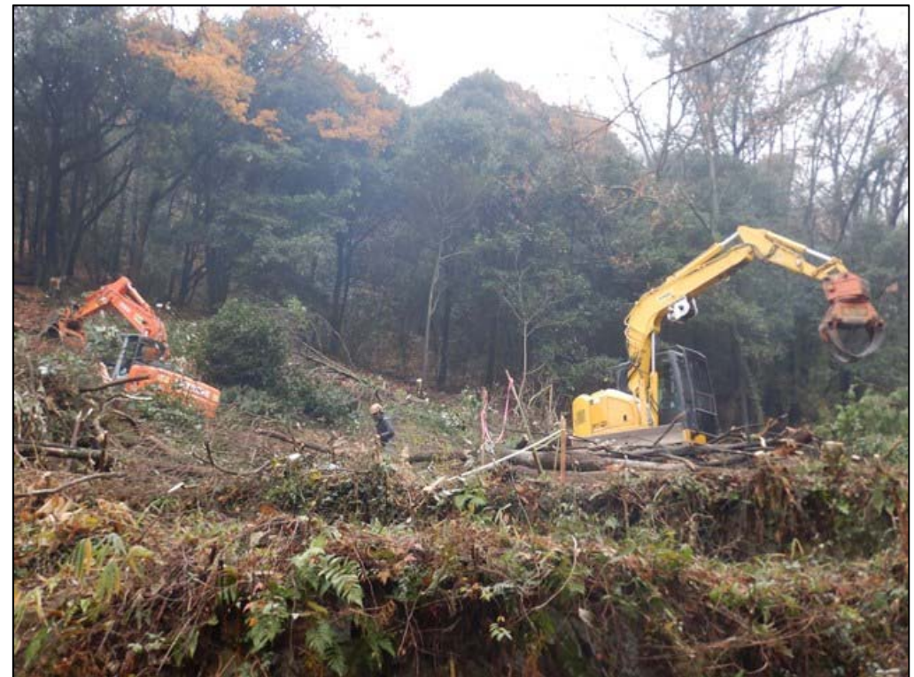
伐採作業状況
