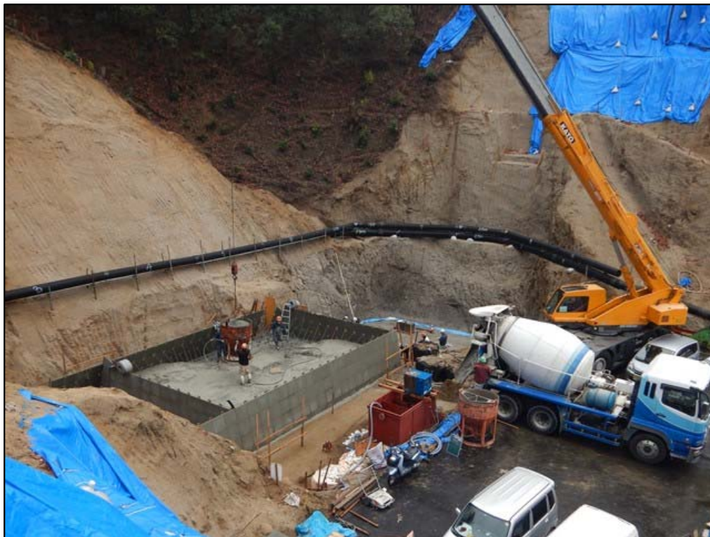
コンクリート打設状況①
