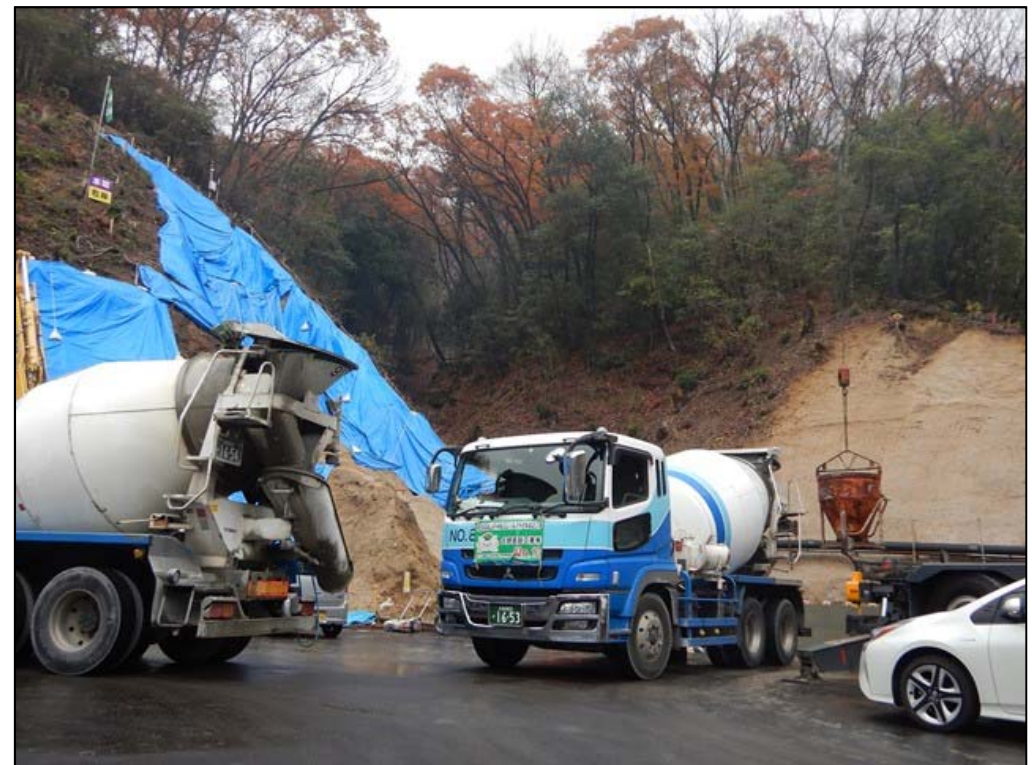
コンクリート打設状況②
