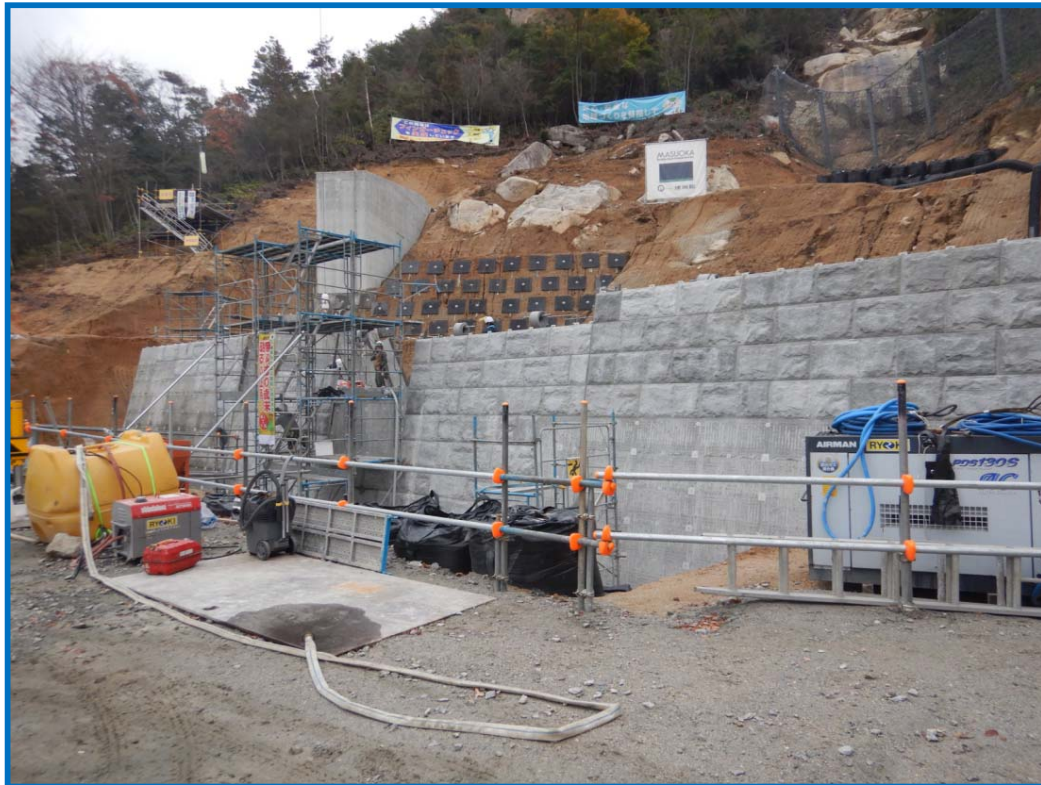
砂防堰堤のコンクリート打設状況
