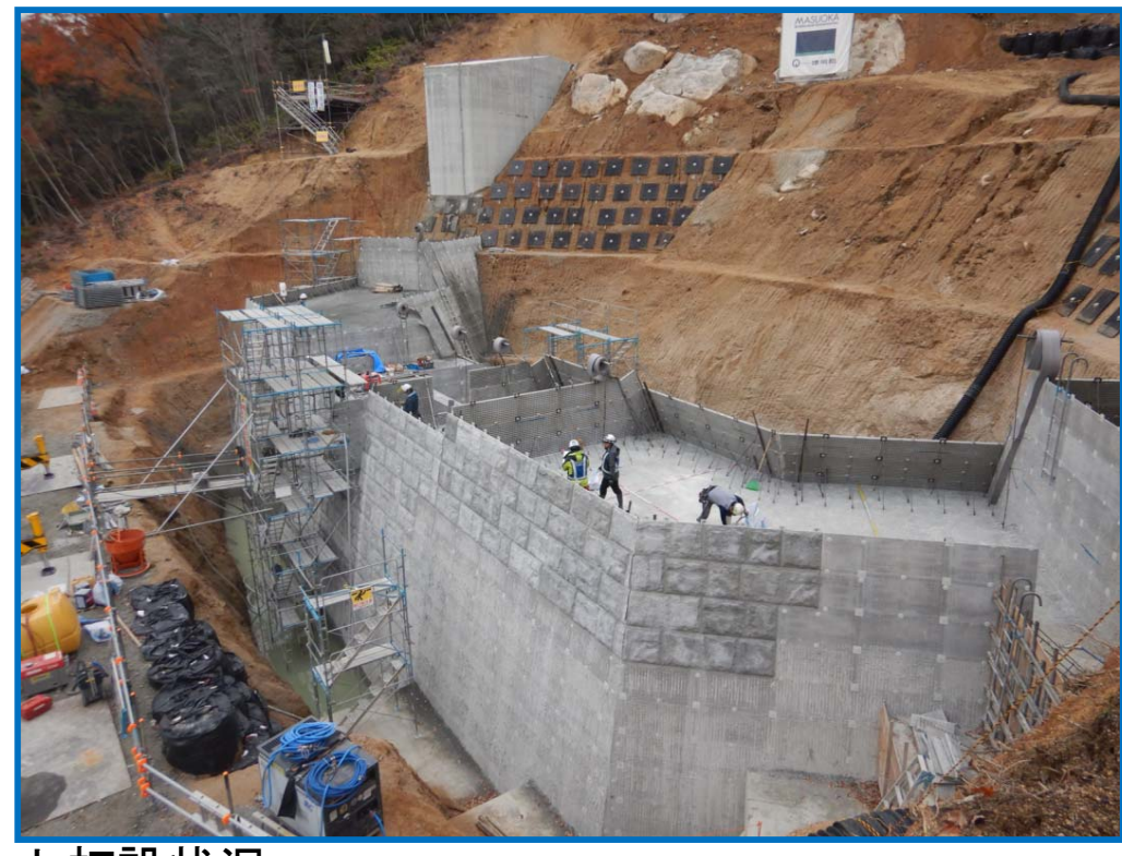
砂防堰堤のコンクリート打設状況
