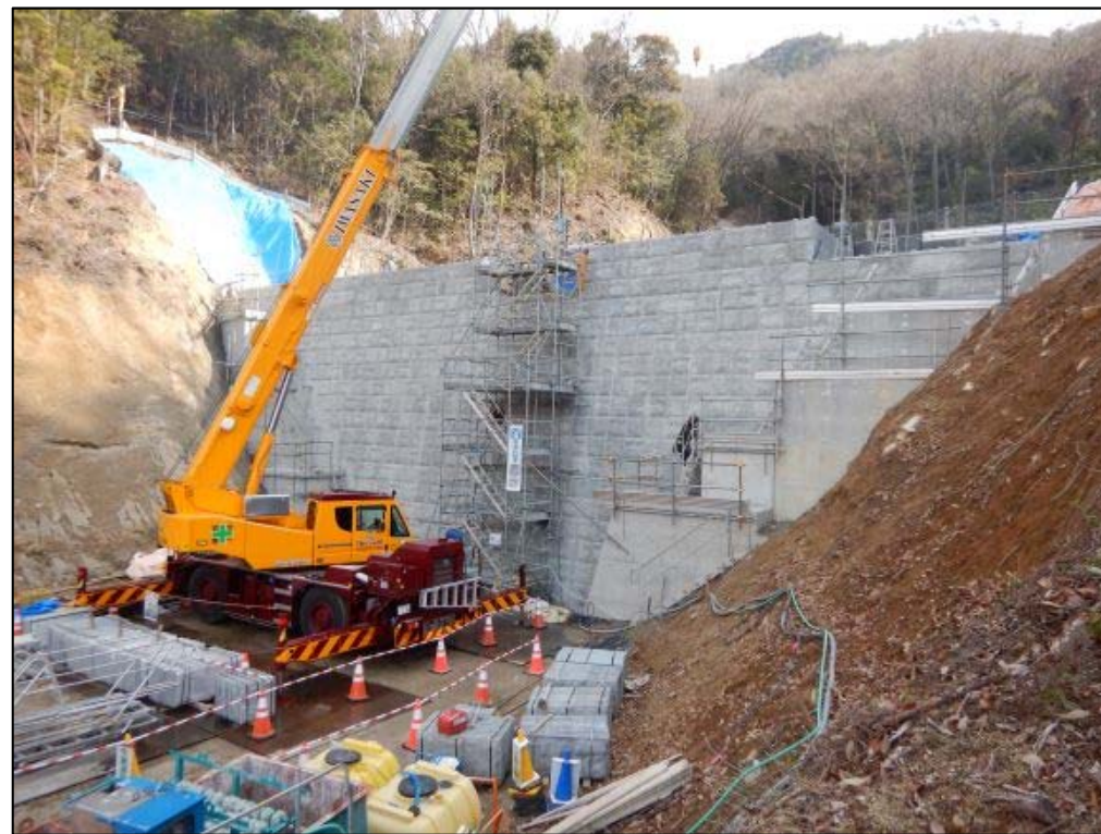
コンクリート打設状況②
