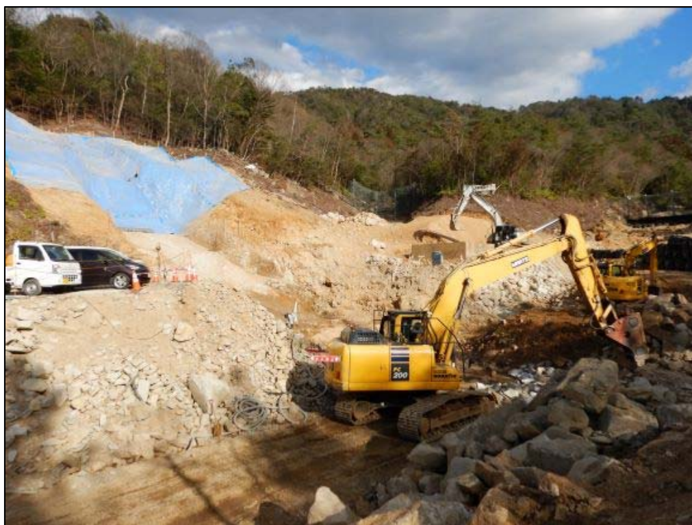
施工状況①
