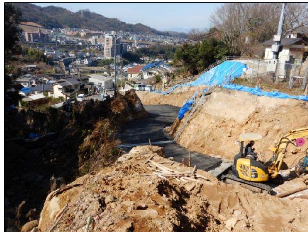
施工状況②
