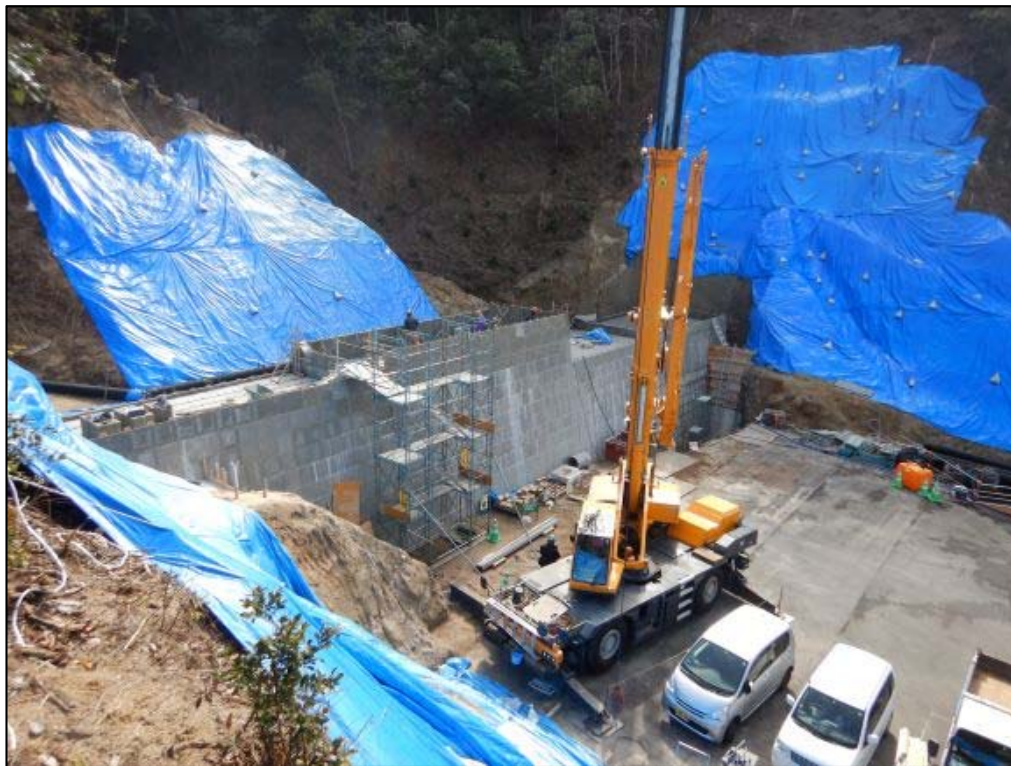
コンクリート打設状況①
