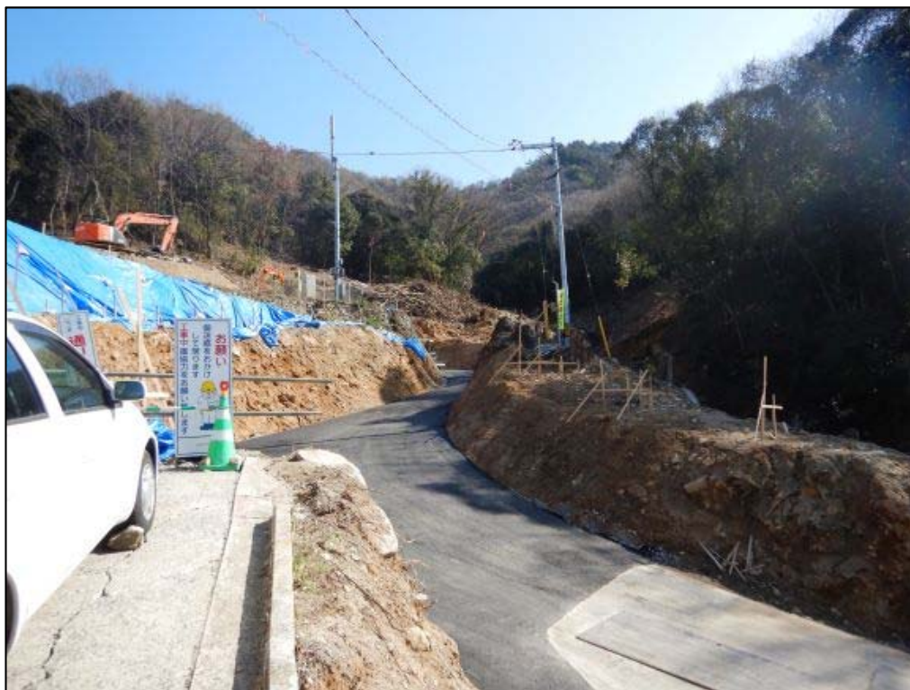
施工状況①
