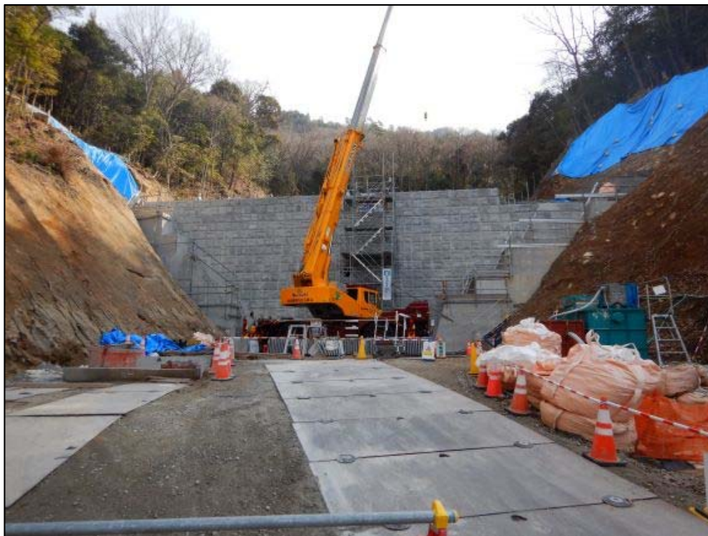
コンクリート打設状況①
