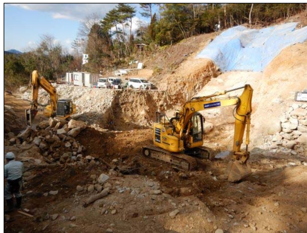
施工状況②
