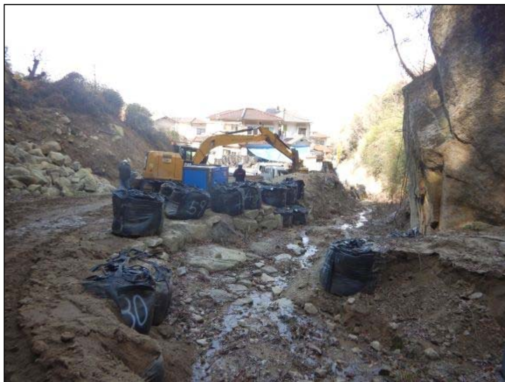
作業状況①
