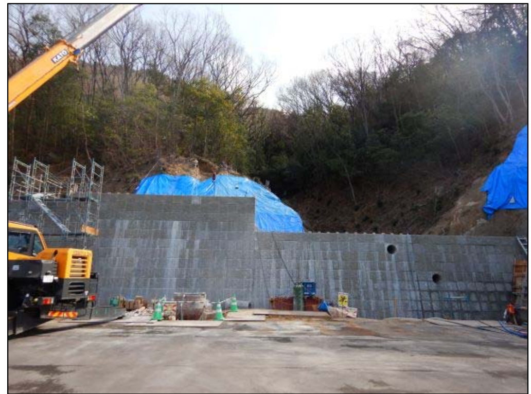
コンクリート打設状況②
