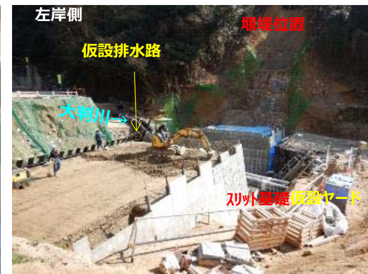
大判川打設状況（左岸側）
