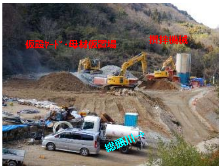
総頭川仮設ヤード施工状況
