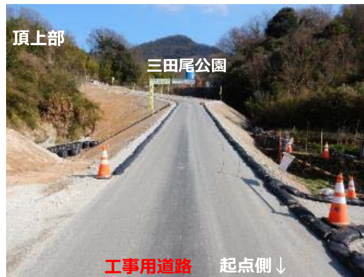
工事用道路（三田尾公園手前）
