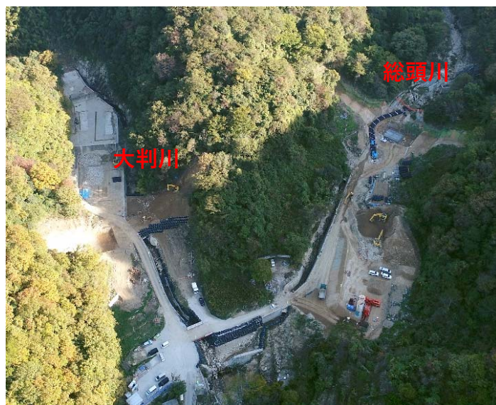
総頭川掘削状況（下流より）
