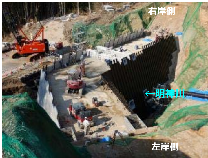
堰堤打設状況(左岸側より)
