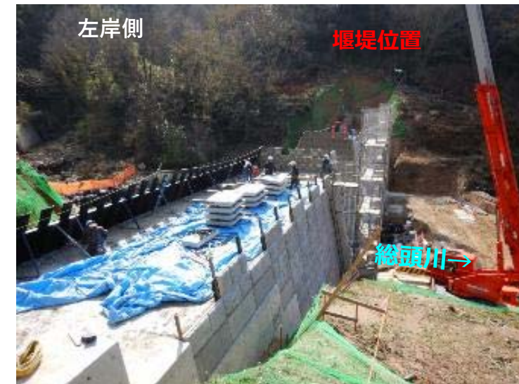
総頭川打設状況（左岸側）
