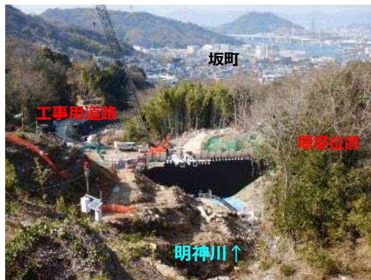
堰堤打設状況(上流より)
