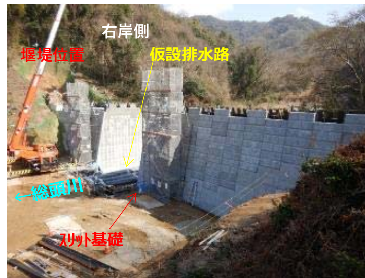
総頭川打設状況（右岸側）
