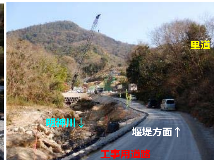
工事用道路（堰堤下流）
