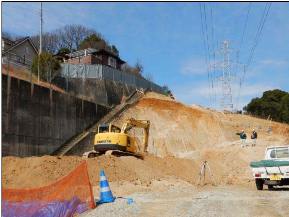
施工状況①
