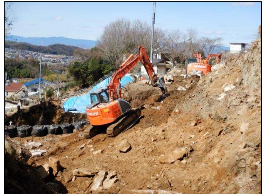
施工状況②
