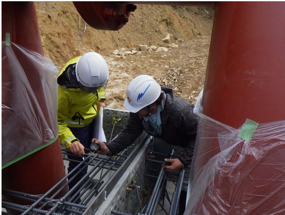
打設前確認 (2月18日)
