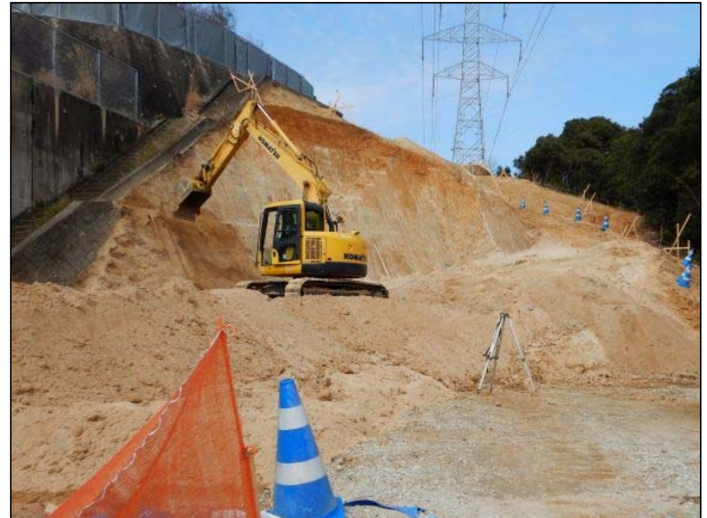
施工状況②
