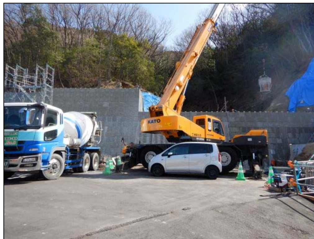
コンクリート打設状況②
