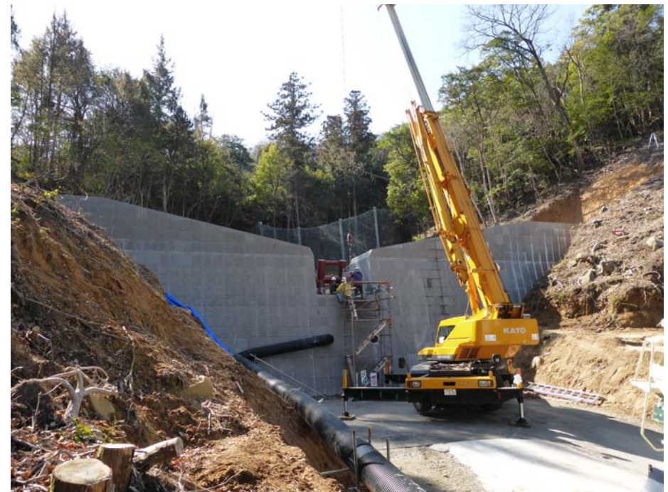
打設状況 (2月19日)
