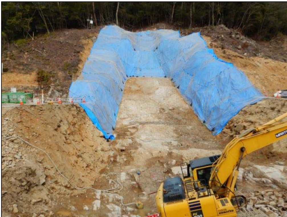
施工状況①
