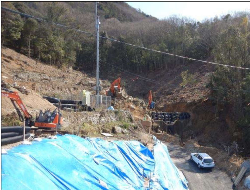
施工状況①
