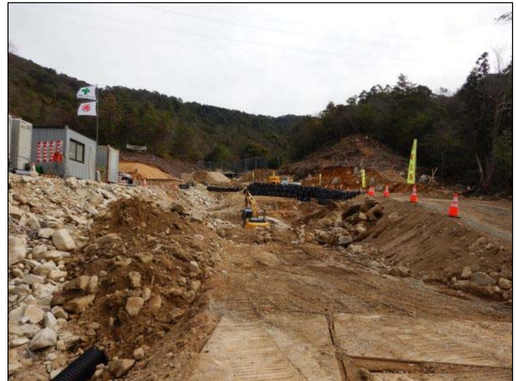
施工状況②
