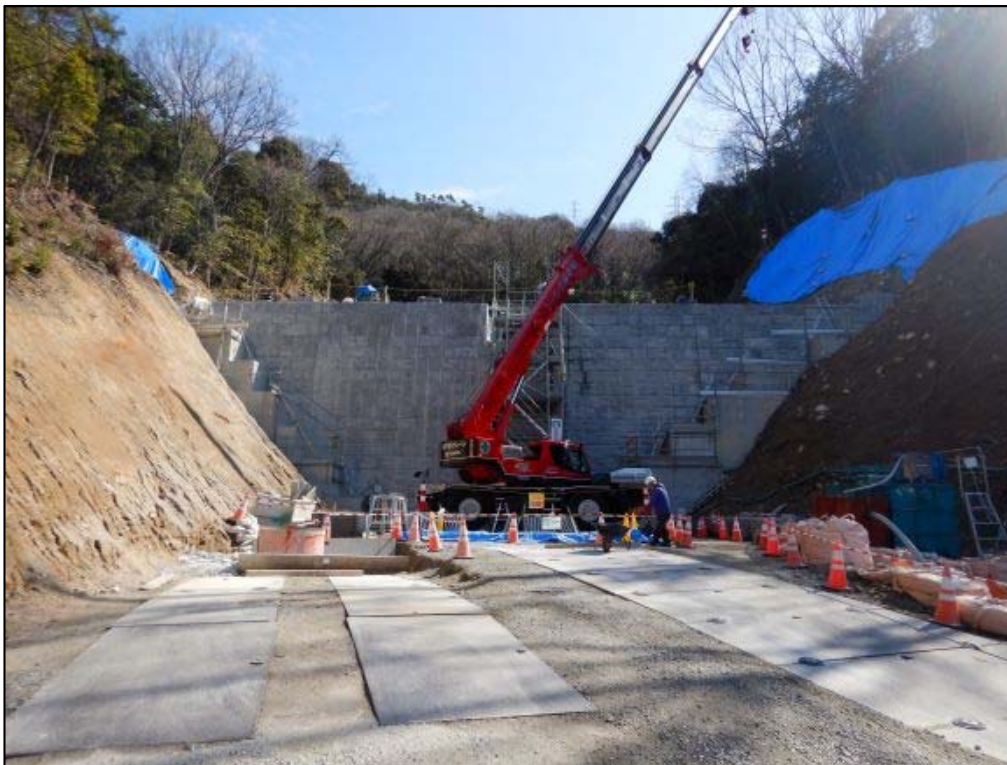
コンクリート打設状況①
