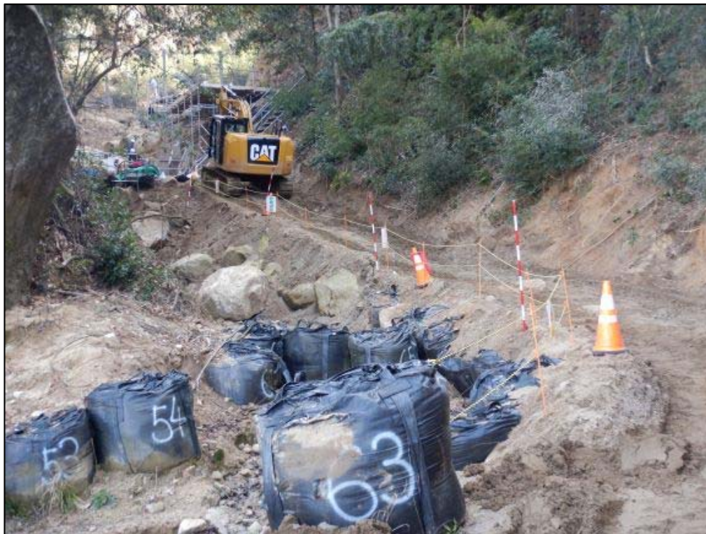
作業状況①
