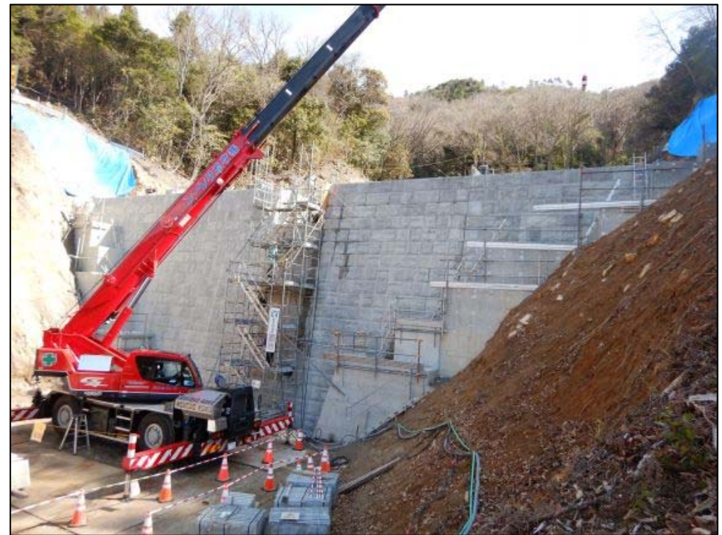
コンクリート打設状況②
