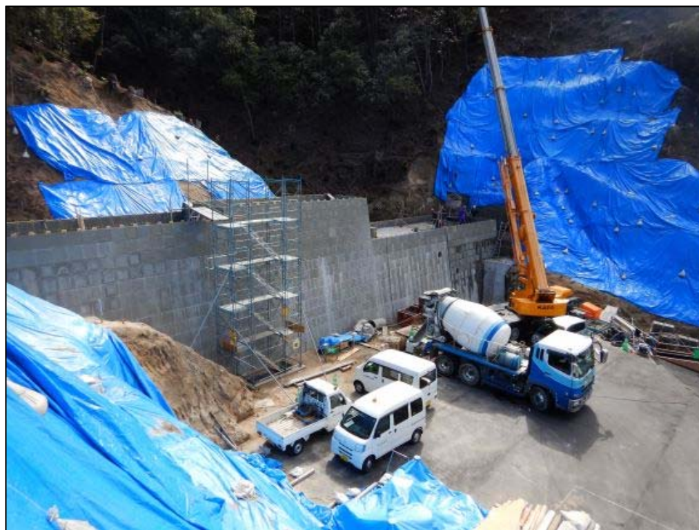
コンクリート打設状況①
