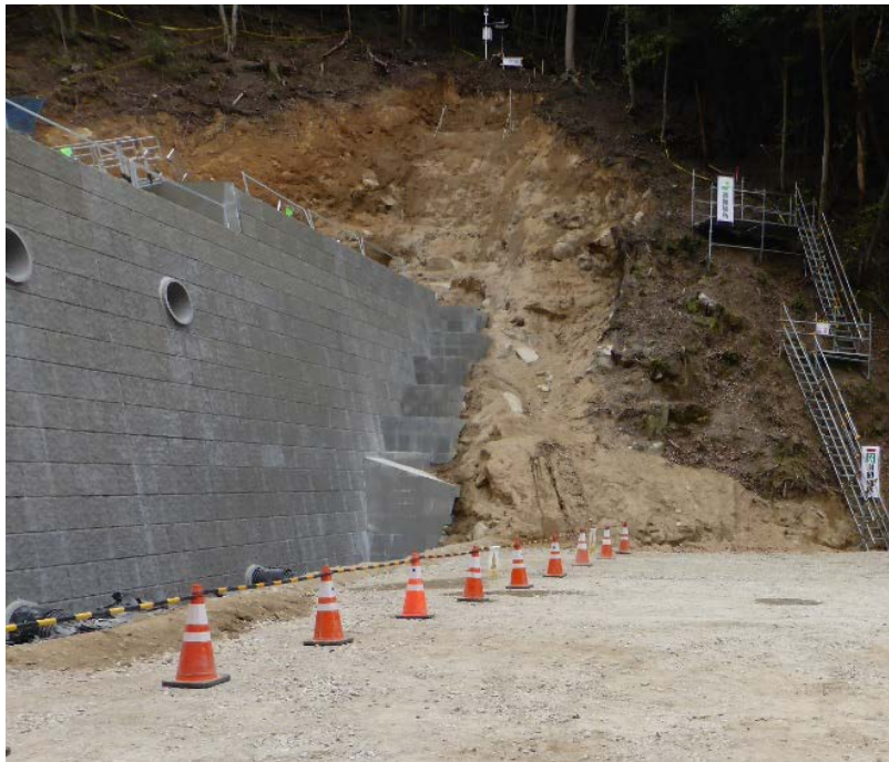
下流側より（近景）
