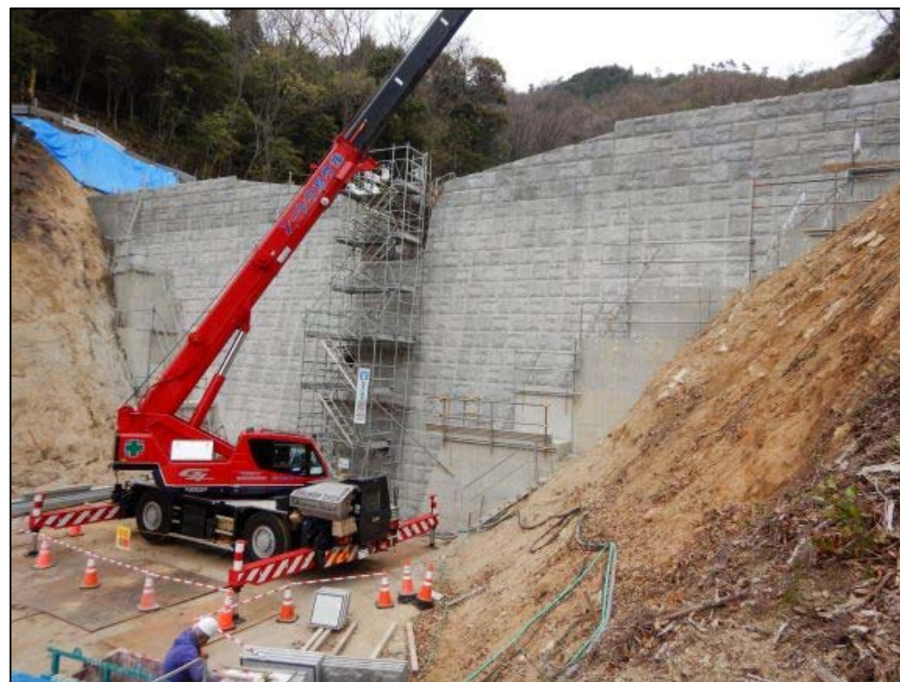
コンクリート打設状況②
