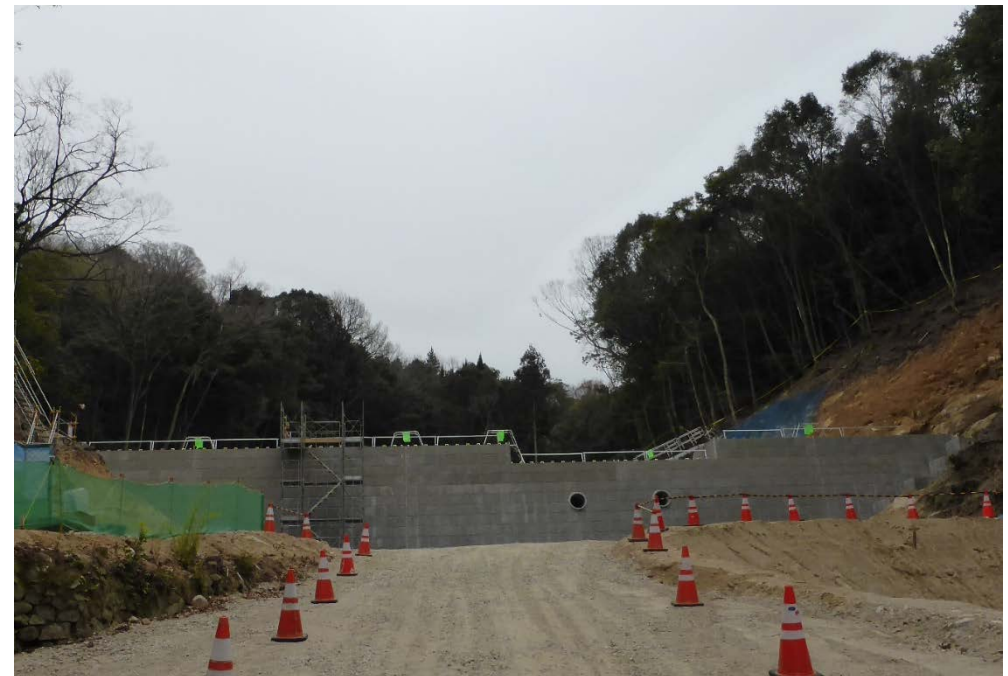
下流側より（全景）
