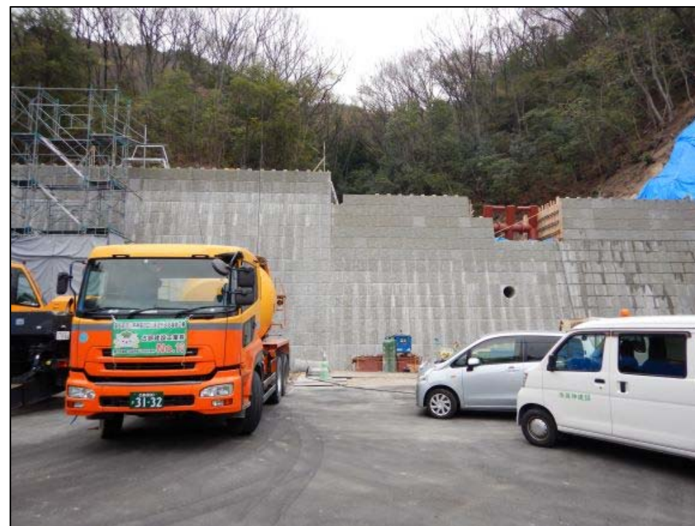
コンクリート打設状況②
