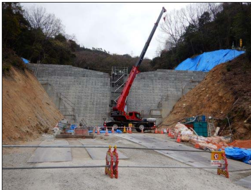
コンクリート打設状況①
