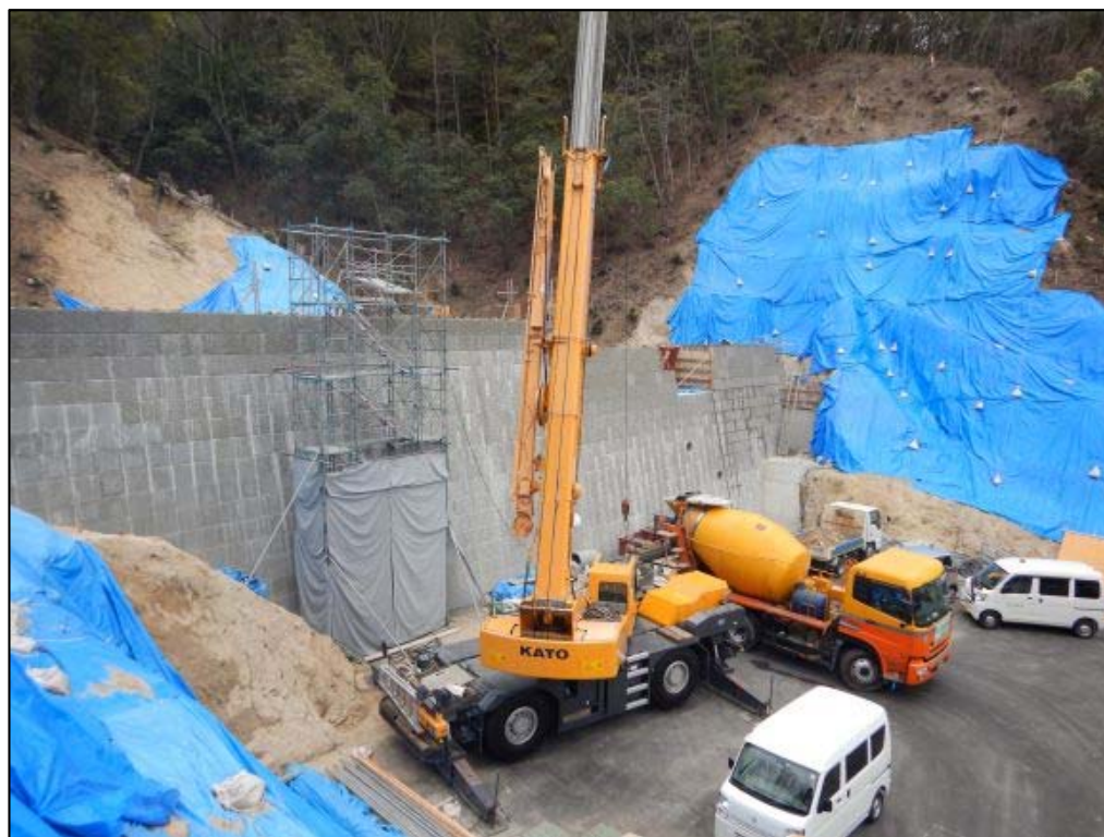
コンクリート打設状況①
