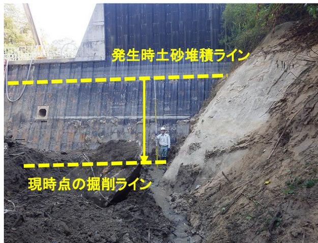
【掘削状況(発生時から4m掘削)】
