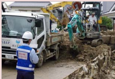
道路の堆積土砂撤去状況
