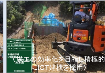
〈短期・集中作業として残存型 〆杭を採用〉
