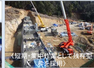
〈ソイルセメントに改良し砂防 堰堤内部材に採用〉
