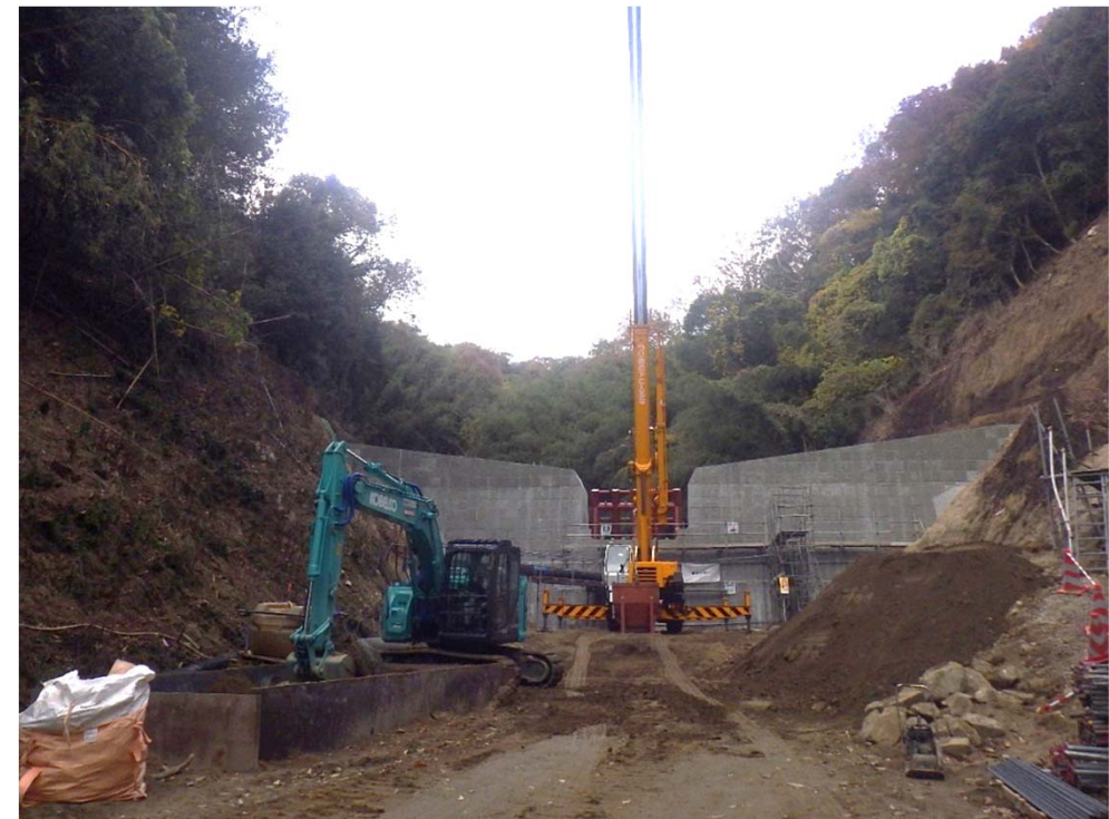
【砂防堰堤工施工状況】
