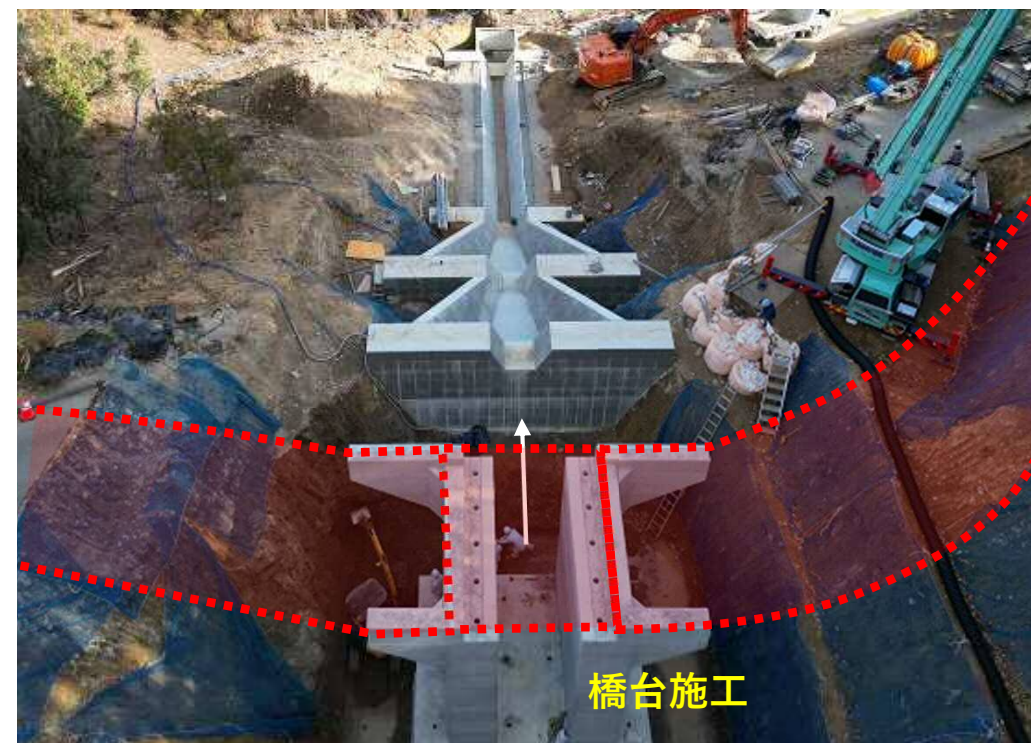
【管理用道路（橋梁）の施工状況】
