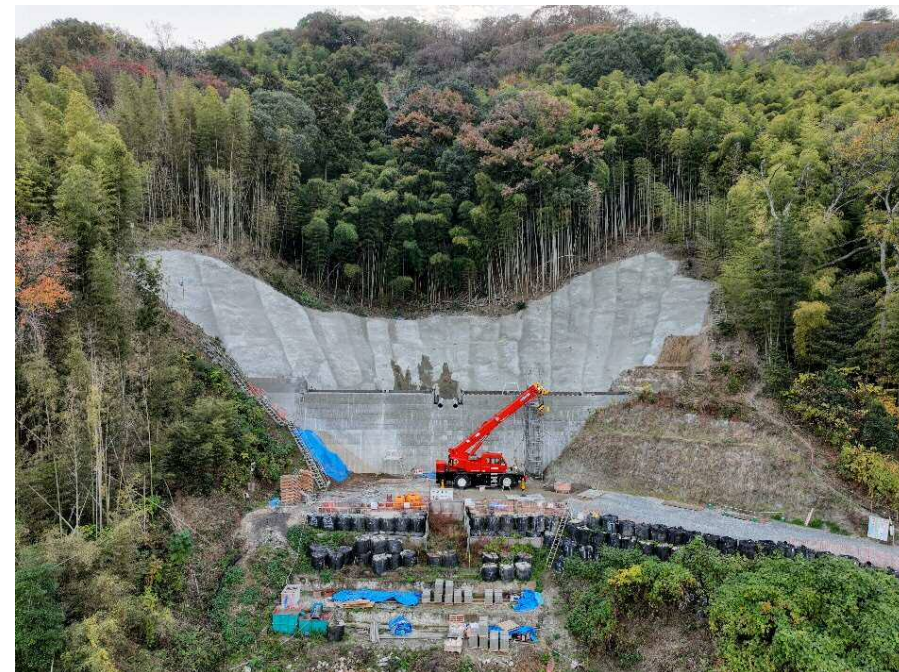
【施工状況（下流側より）】
