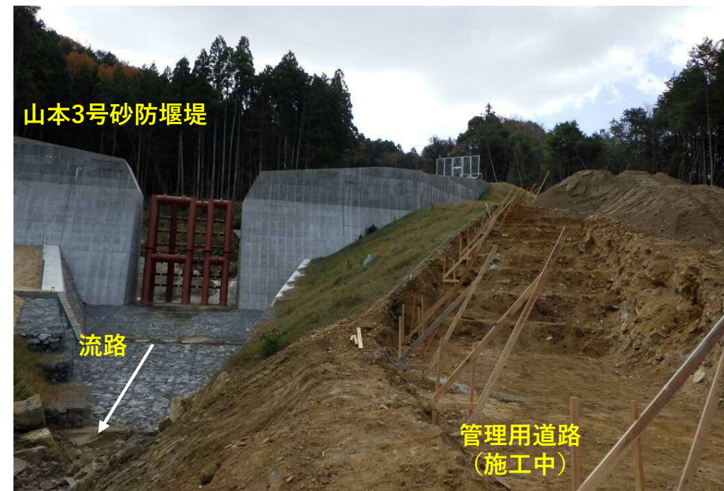
【施工状況（管理用道路）】
