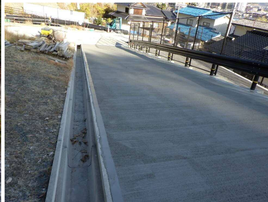
【施工状況（管理用道路：コンクリート舗装）】
