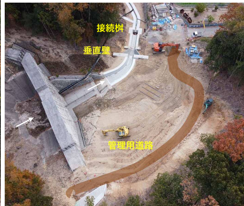
【流路 施工状況】
