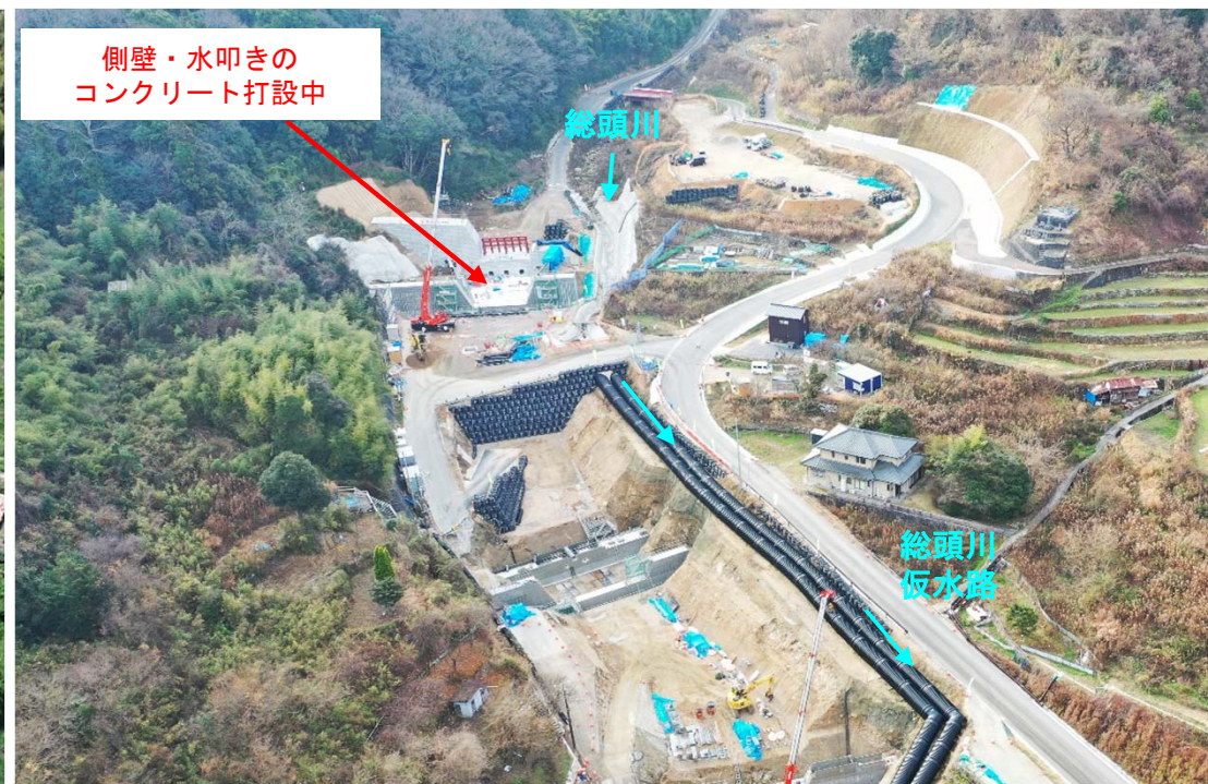
【施工状況（下流から上流を望む）（R5. 12月末時点）】
