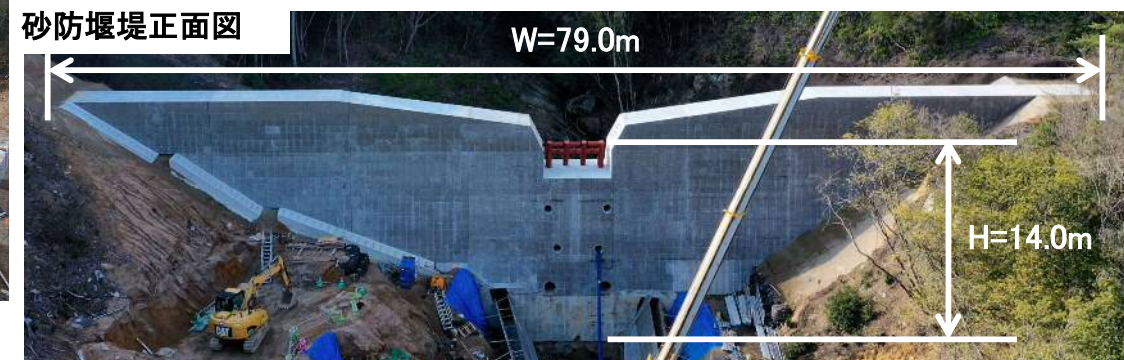
【砂防堰堤施工状況】
