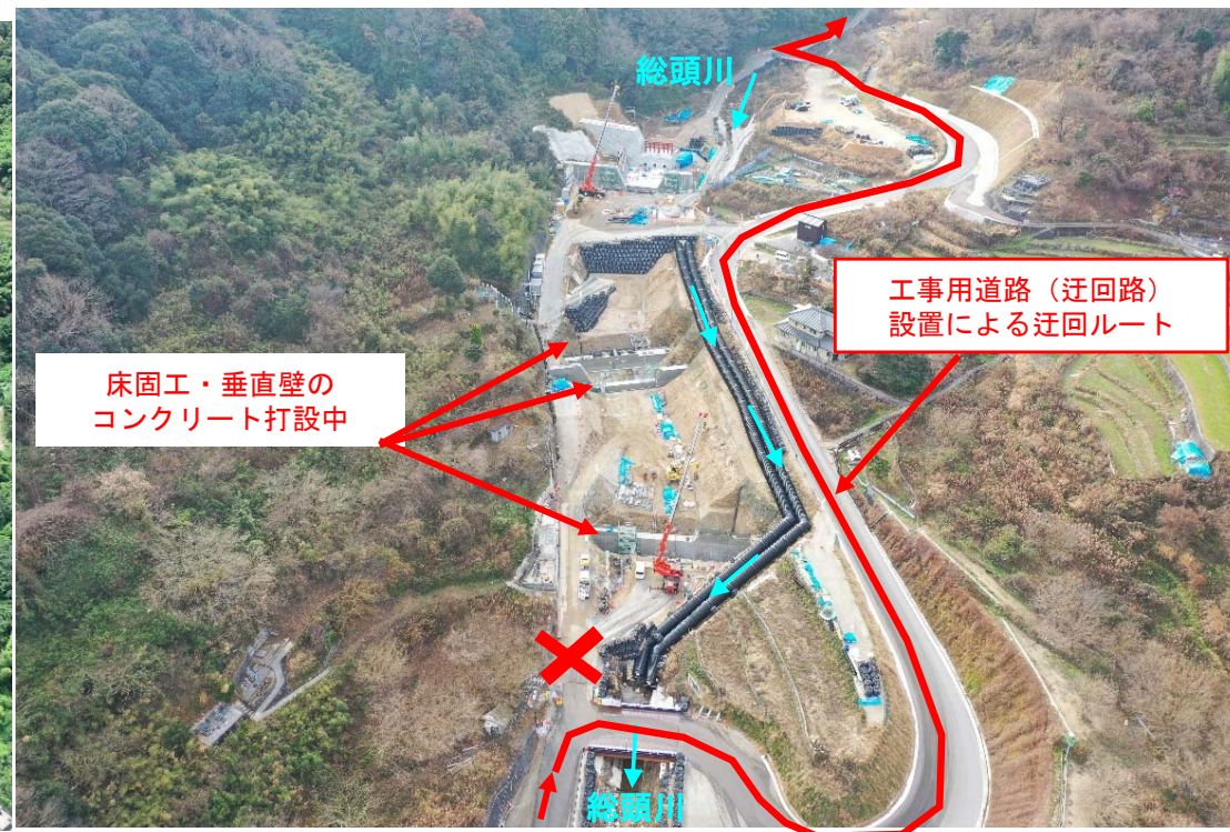
【施工状況（下流から上流を望む）（R5. 12月末時点）】
