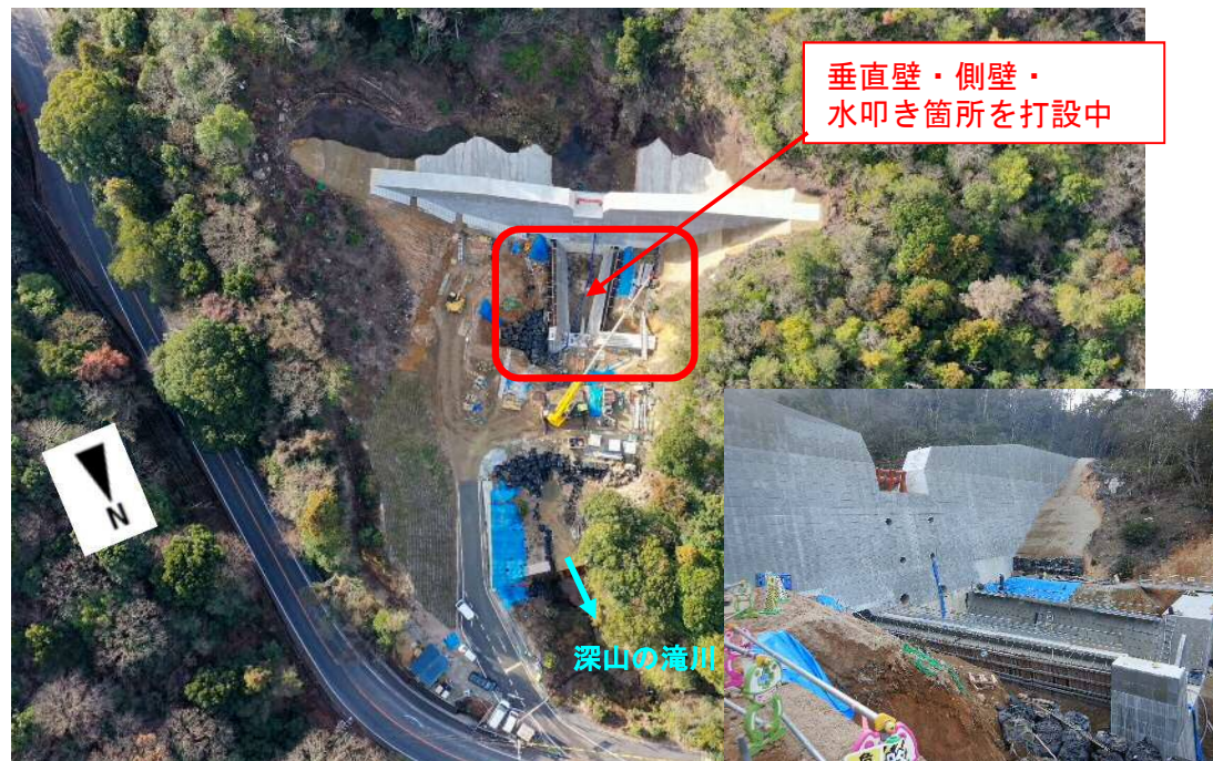
【深山の滝川溪流下流の施工状況】
