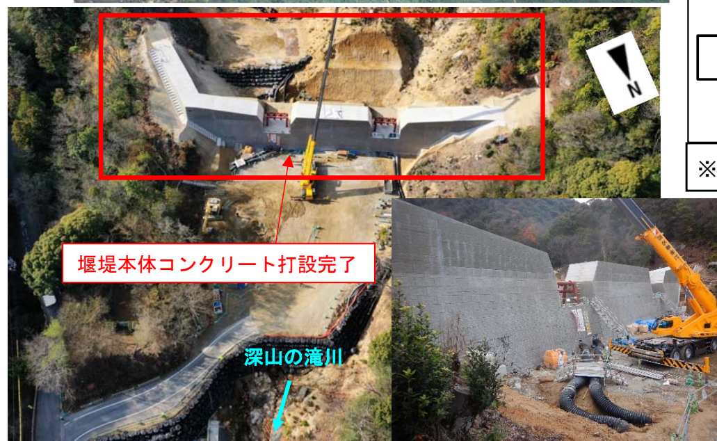
【深山の滝川溪流上流の施工状況】
