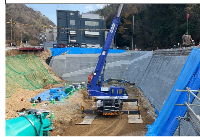
コンクリート打設状況
