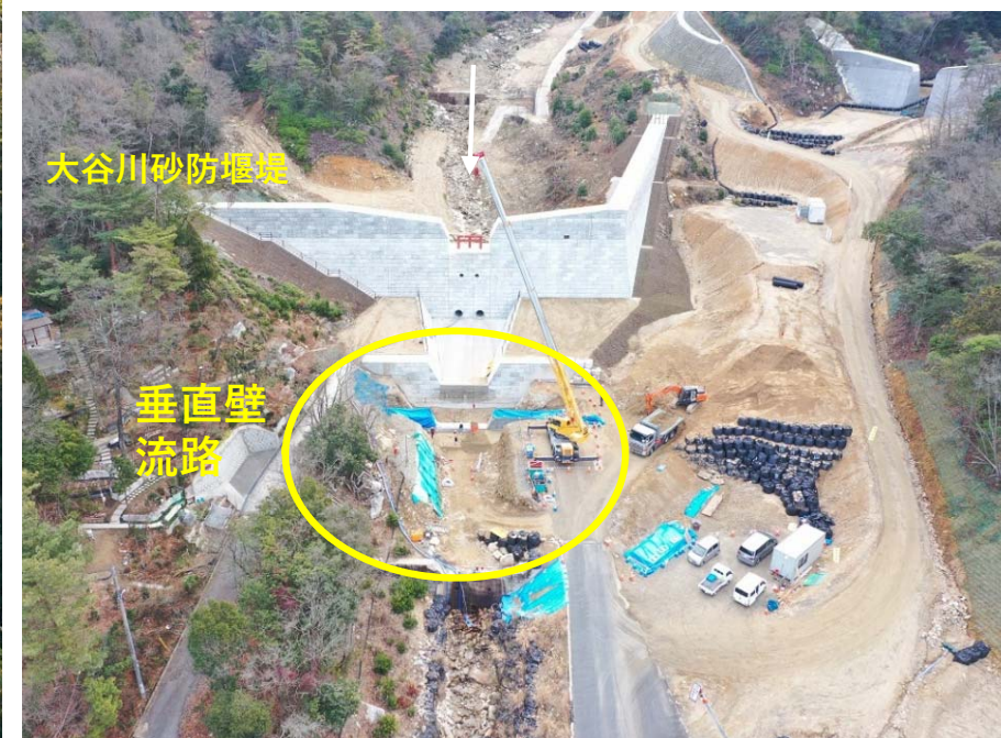
【大谷川砂防堰堤・流路 施工状況】
