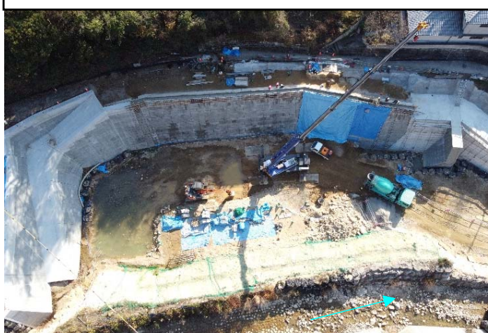
大型ブロック積み (左岸側)
