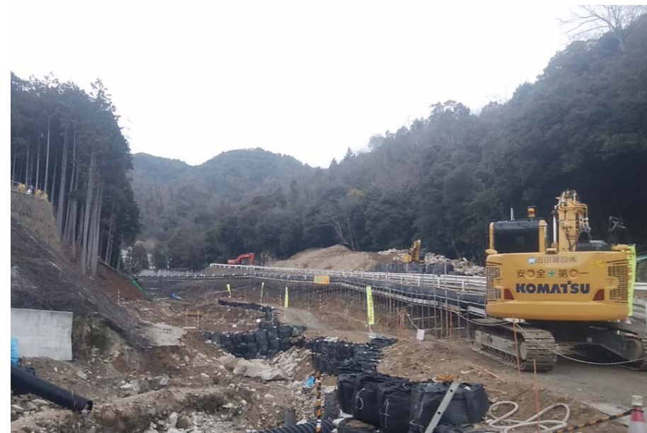
【流路工箇所掘削状況】
