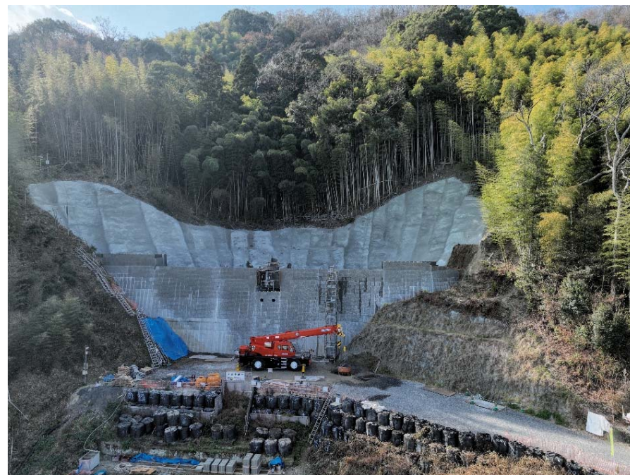
【施工状況（下流側より）】
