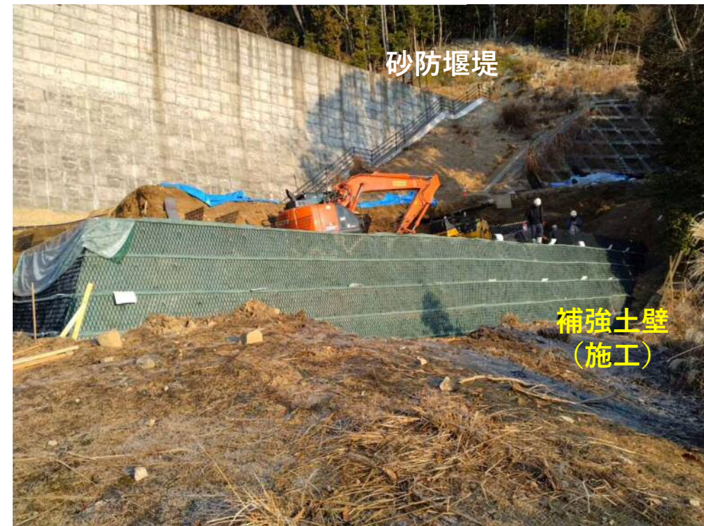
【管理用道路（補強土壁）の施工状況】
