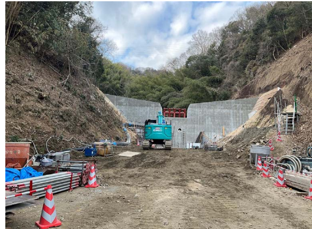
【砂防堰堤施工状況】
