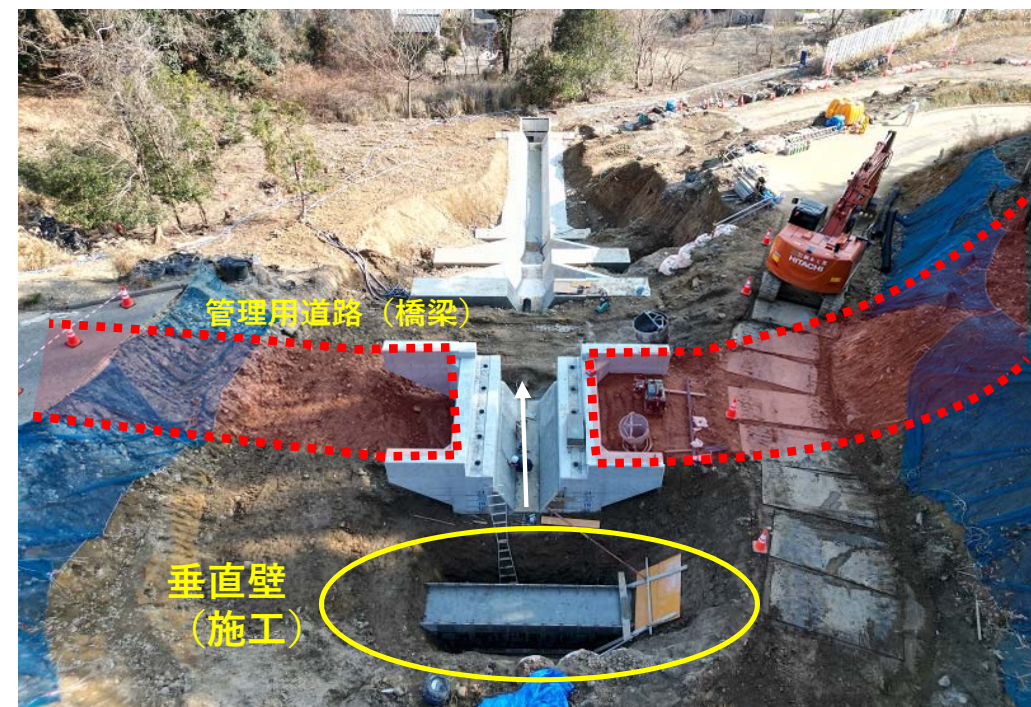
【流路（垂直壁）の施工状況】
