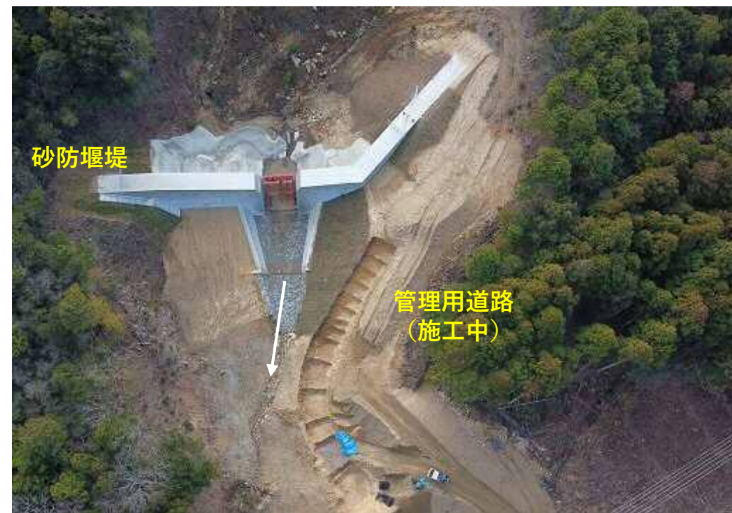
【施工状況（管理用道路）】
