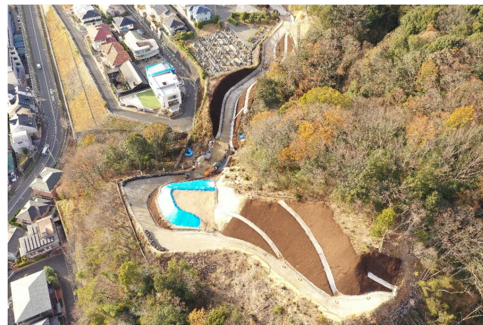
【 施工箇所状況】
